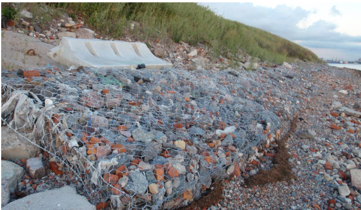
Рис. 4.1.55. Габионы в тыловой части техногенного пляжа, примыкающего к свалке. Т.н. 10-В-03, фото 2010 г.
