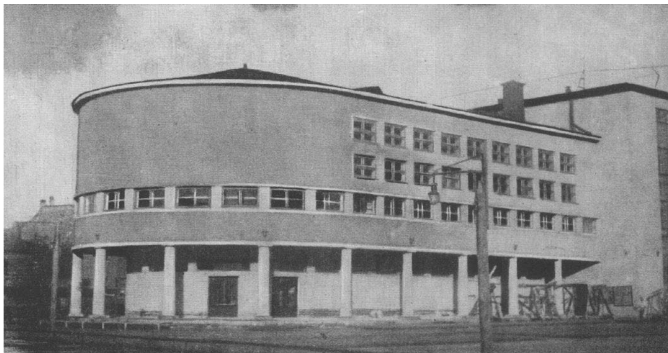
Илл. 8. Фрагмент фасада здания Технической школы, 1930-е гг.
