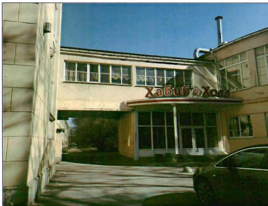
4. Фрагмент лицевого фасада, переход между корпусами.
