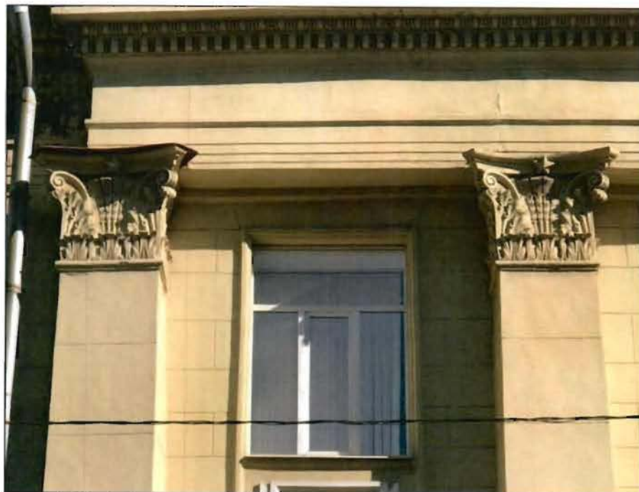
2. Фрагмент лицевого фасада. Пилоны с капителями композитного ордера.
