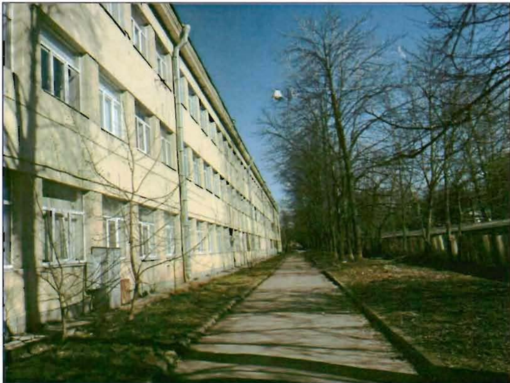
8. Фрагмент южного фасада основного объема здания.
