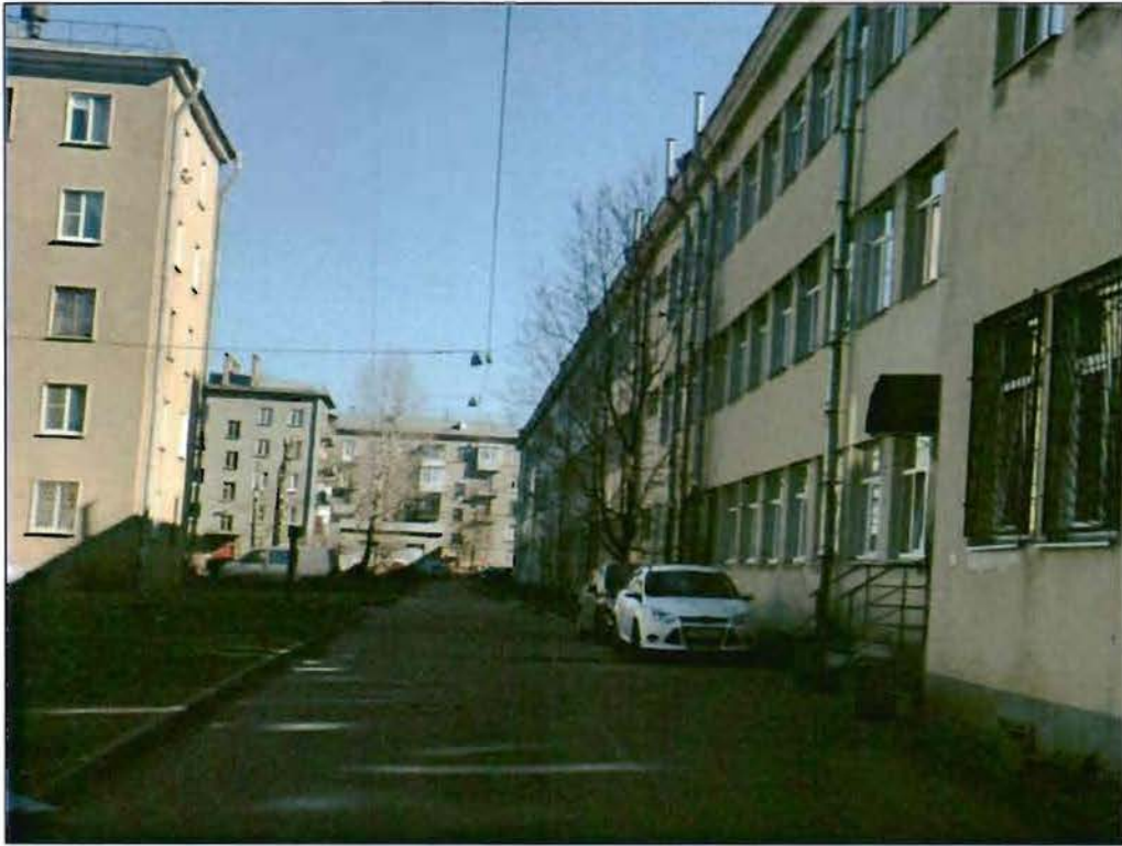
9. Фрагмент северного фасада основного объема здания.
