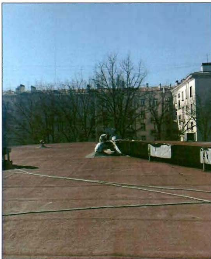
17. Фрагмент наплавляемой кровли цилиндрического объема здания.
