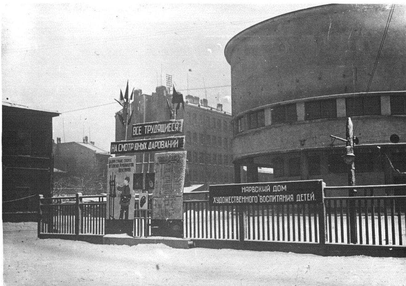
Илл. 7. Фрагмент фасада здания Технической школы, 1930-е гг.
