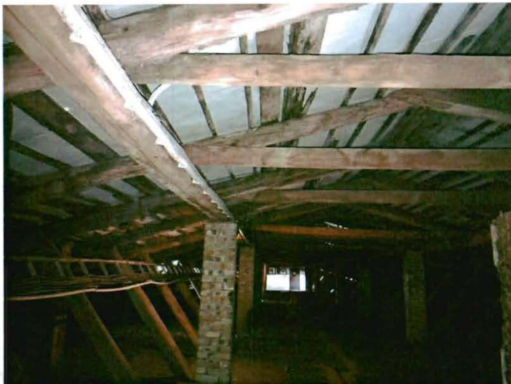
11. Стропильная система основного корпуса.
