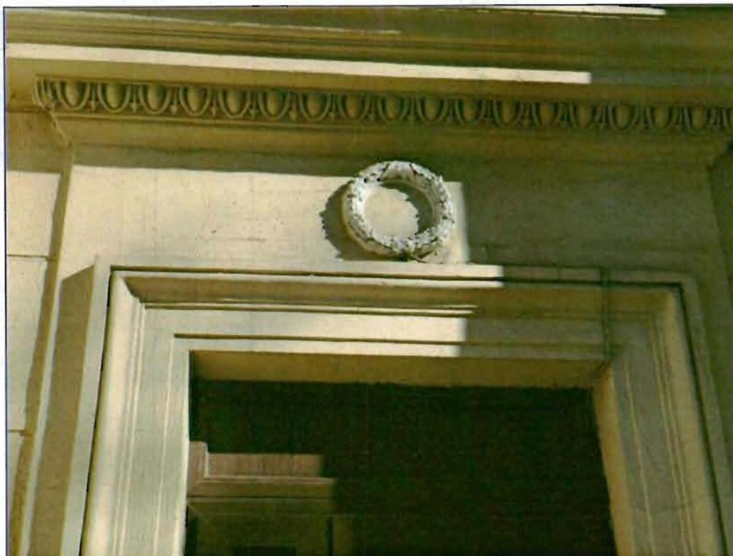
3. Фрагмент лицевого фасада. Лепной веночек над входом.
