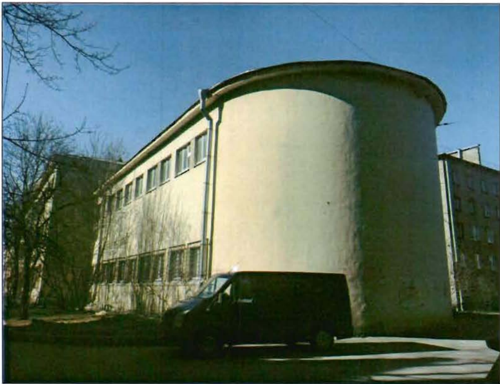
10. Вид на восточный фасад.
