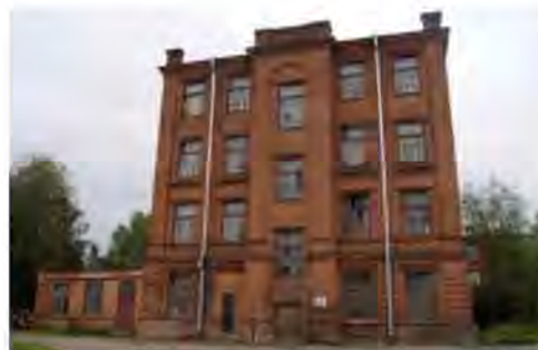
Северо-западный (торцевой) фасад
