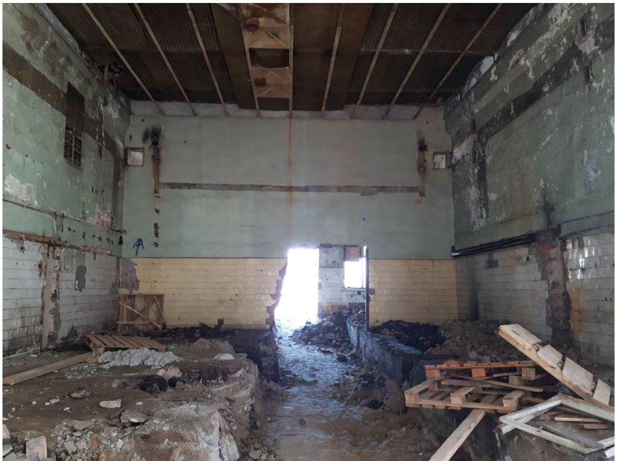
Фото 25. Вид из точки 25. Восточный зал первого этажа
