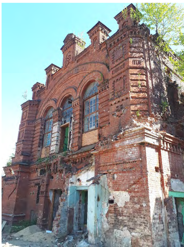
Фото 13. Вид из точки 13 на фрагмент Северного фасада
