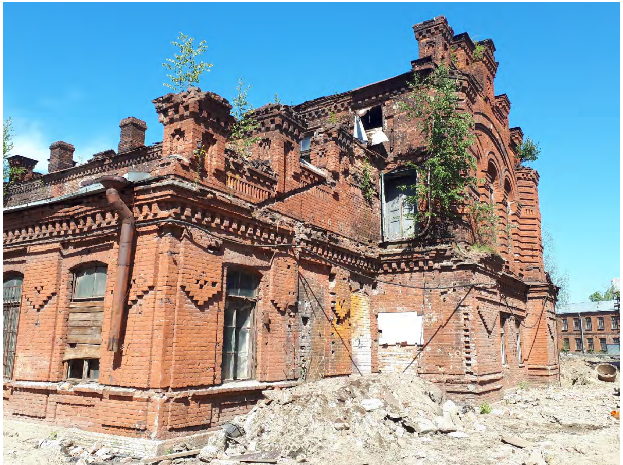
Фото 5. Вид из точки 5 на фрагмент Западного и Южного фасадов
