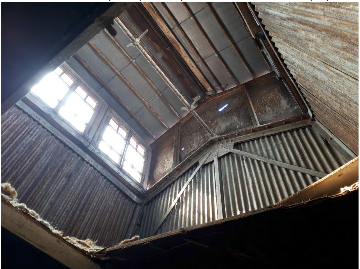
Фото 37. Вид из точки 37. Фермы покрытия центральной части здания со световым фонарем
