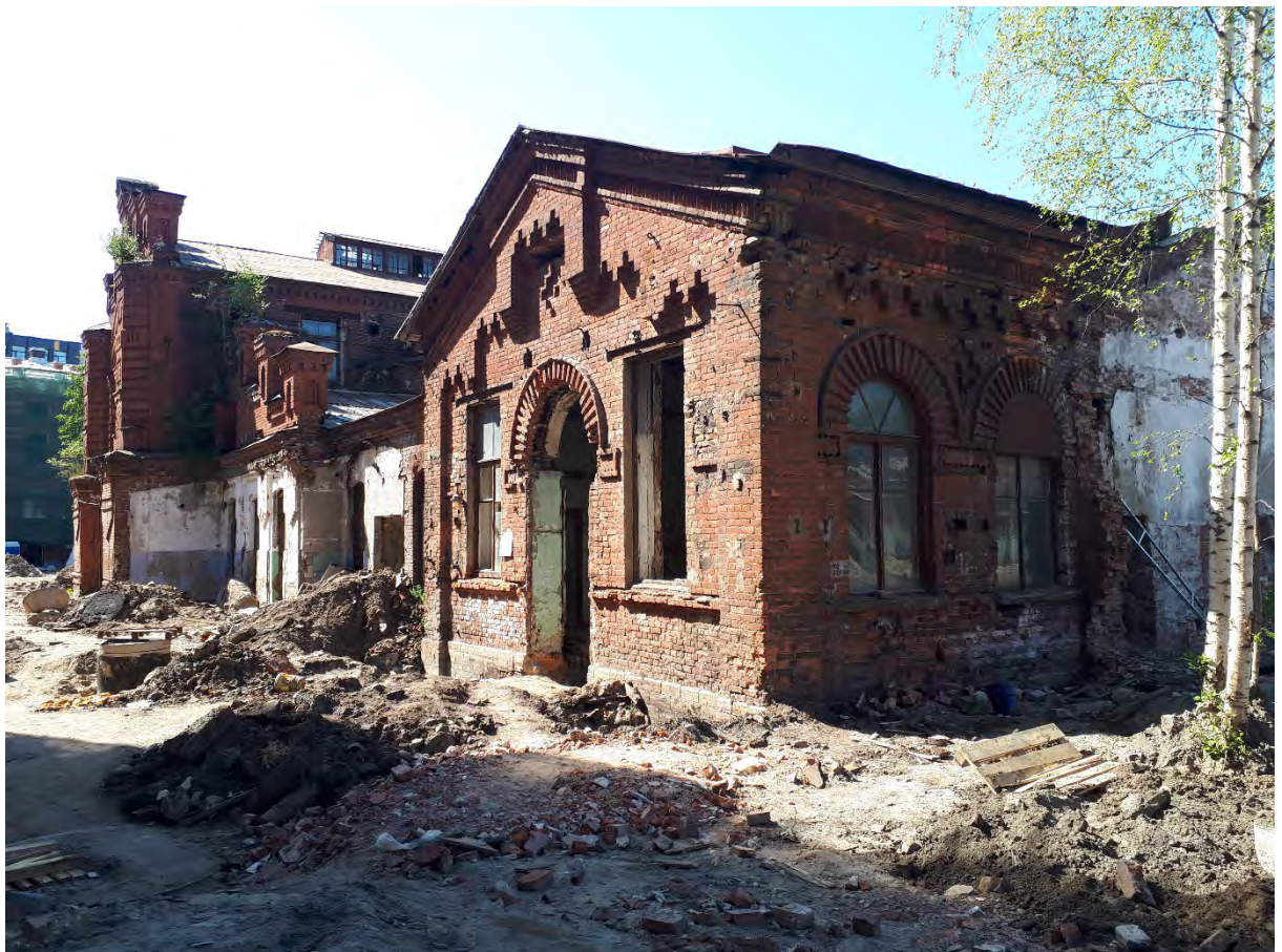
Фото 10. Вид из точки 10 на фрагмент Южного и Восточного фасадов
