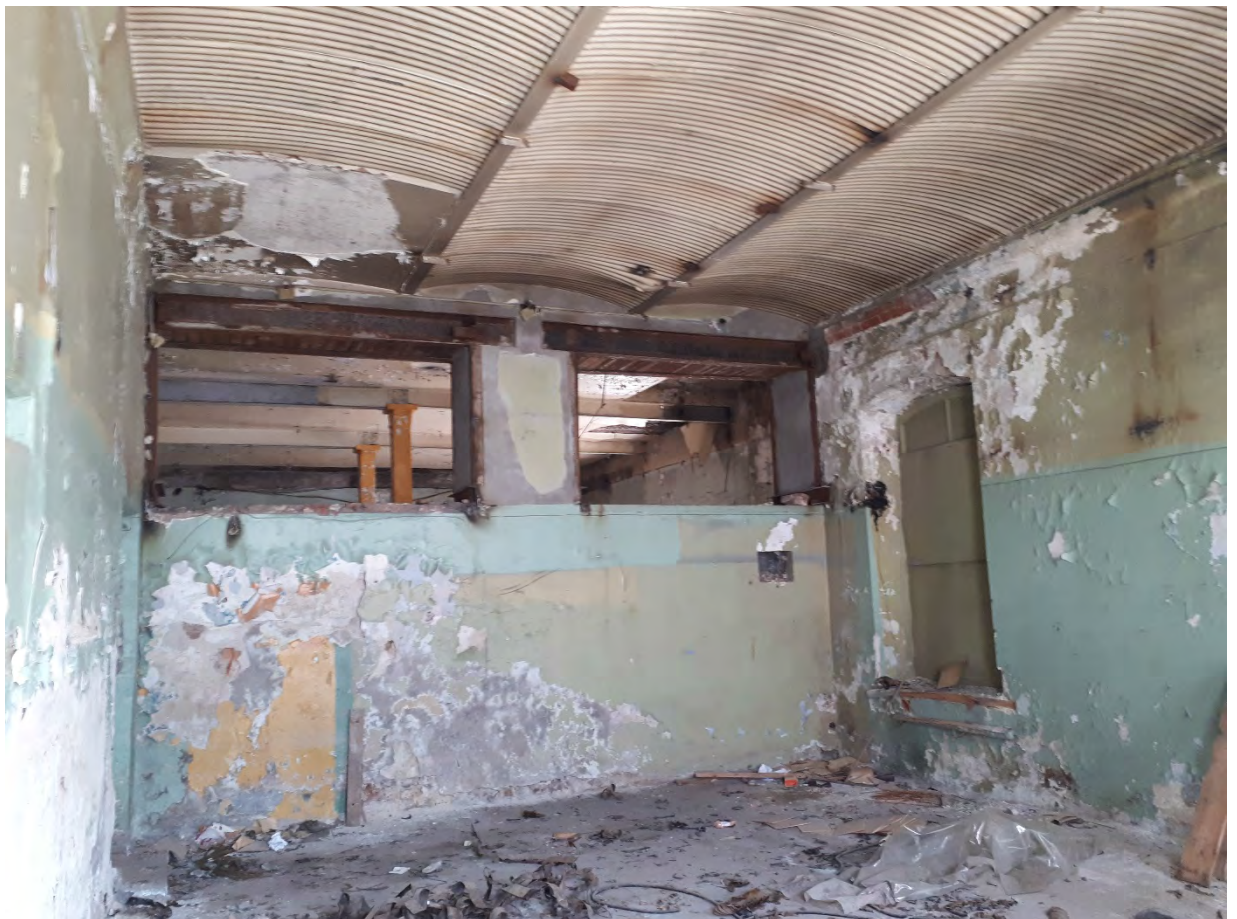
Фото 23. Вид из точки 23. Юго-Западный зал первого этажа
