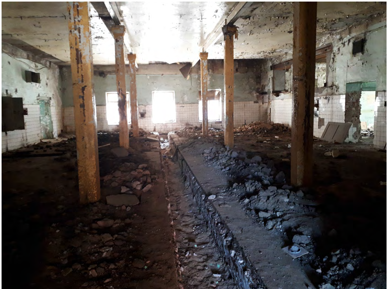
Фото 18. Вид из точки 18. Центральный зал первого этажа
