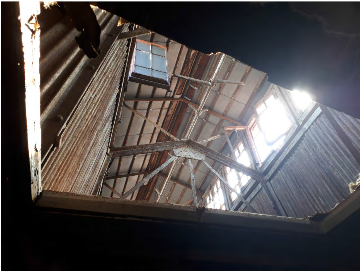
Фото 36. Вид из точки 36. Фермы покрытия центральной части здания со световым фонарем
