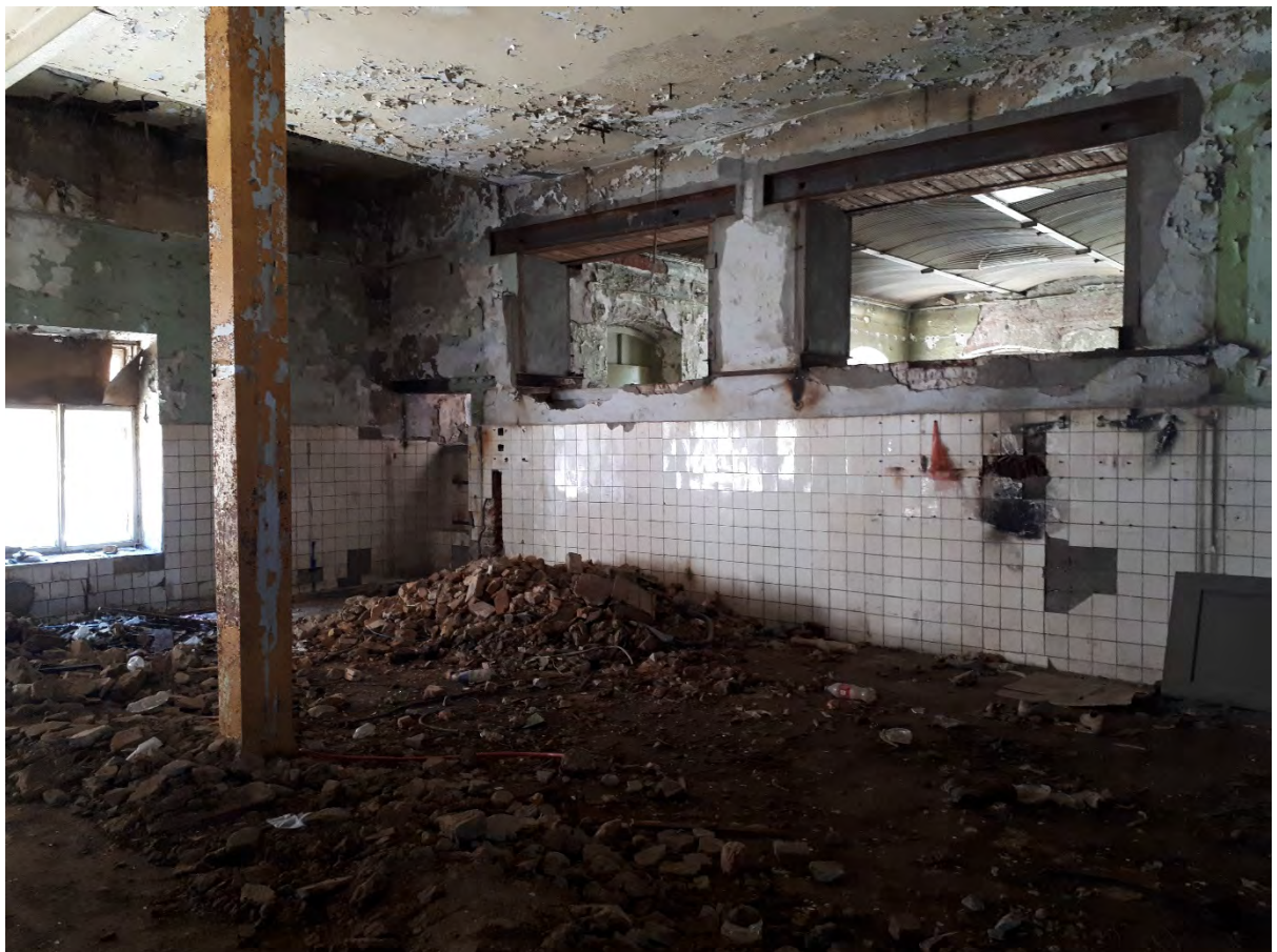
Фото 20. Вид из точки 20. Фрагмент центрального зала первого этажа
