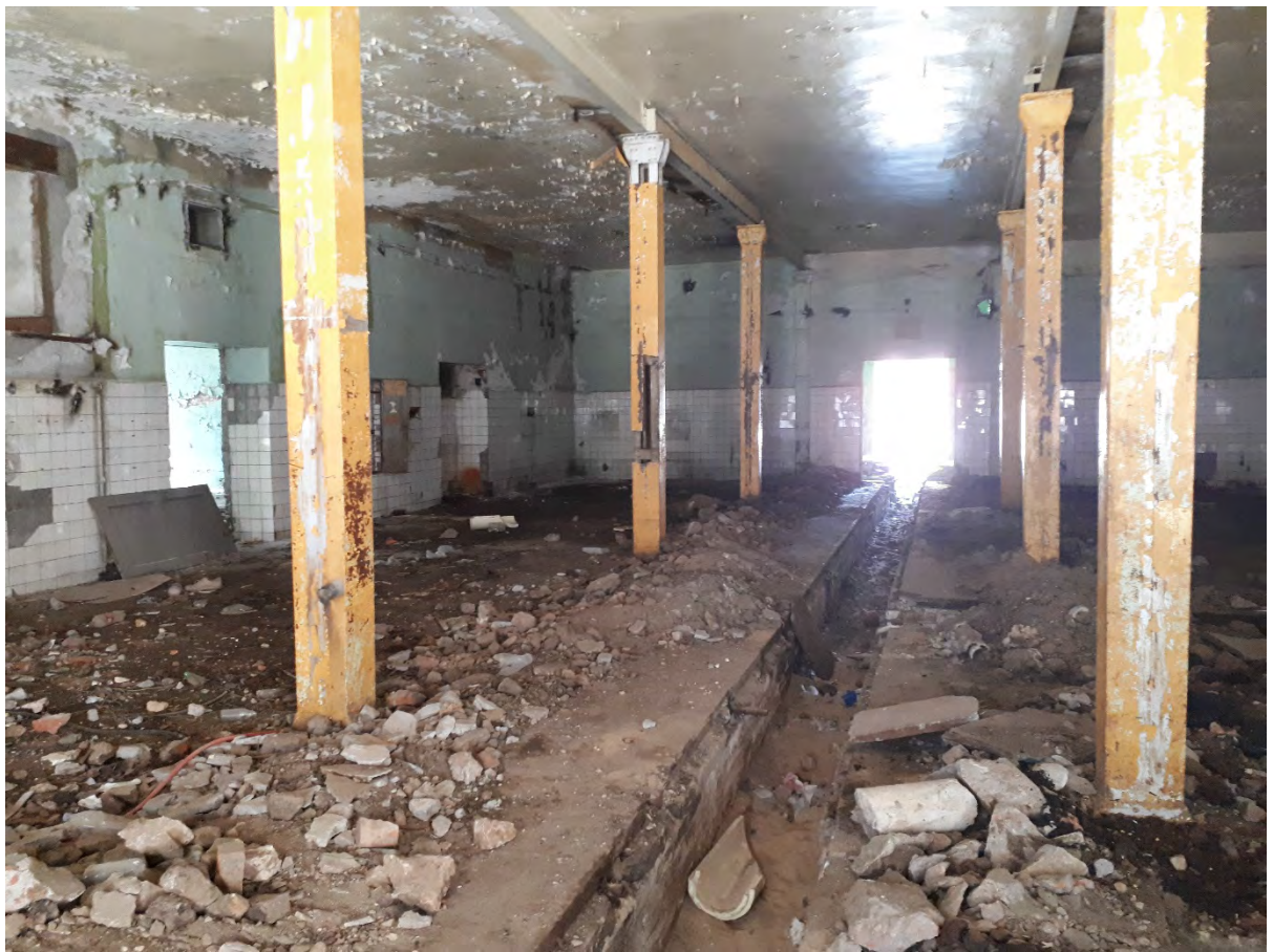
Фото 19. Вид из точки 19. Центральный зал первого этажа
