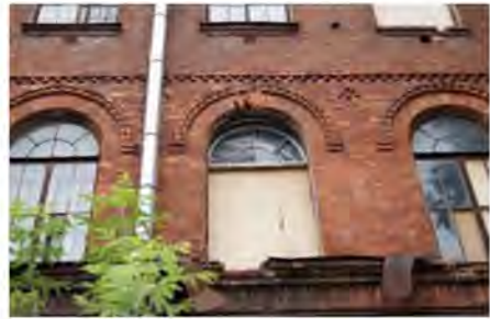
юго-восточный фасад (дворовый)
