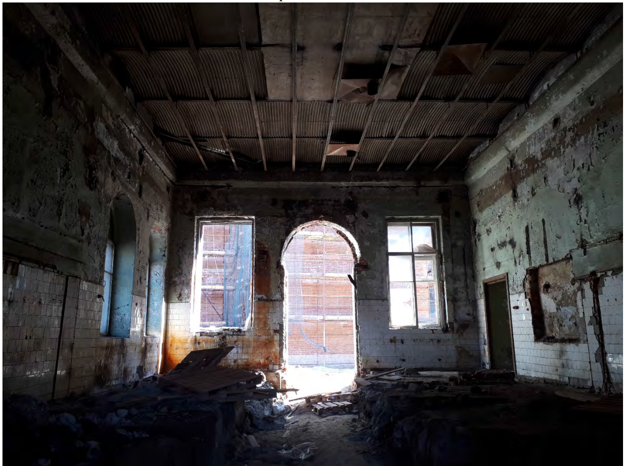
Фото 26. Вид из точки 26. Восточный зал первого этажа
