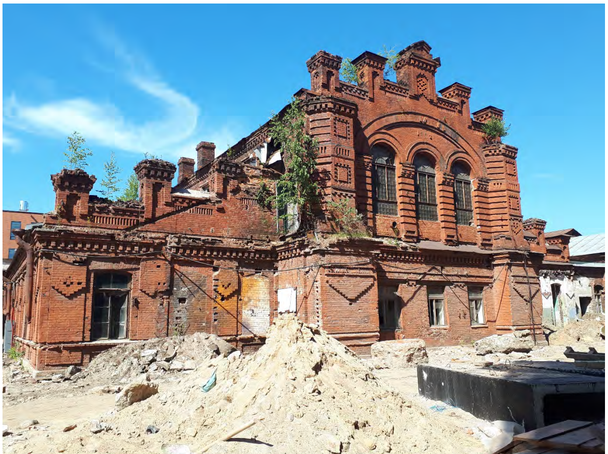
Фото 6. Вид из точки 6 на Южный фасад
