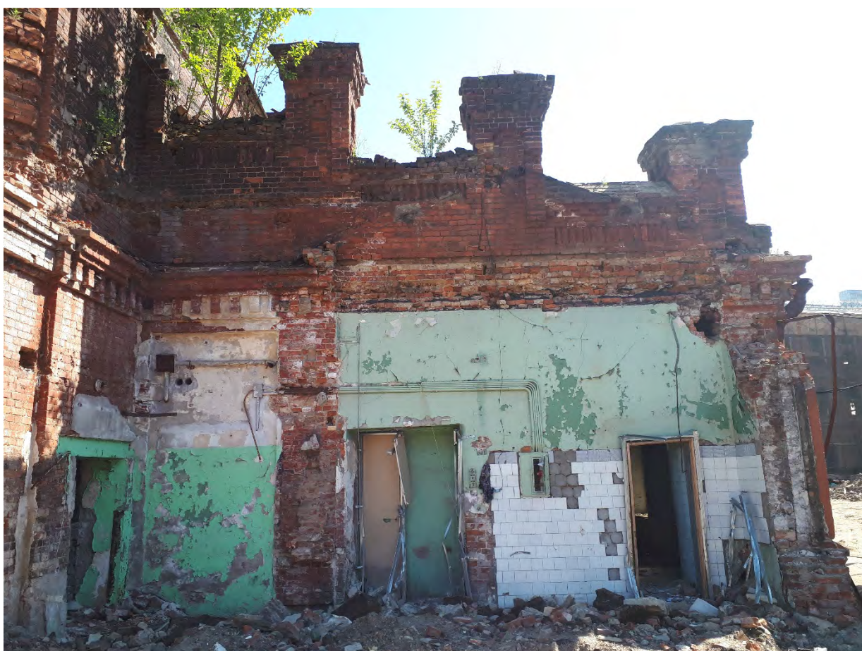
Фото 15. Вид из точки 15 на фрагмент Северного фасада
