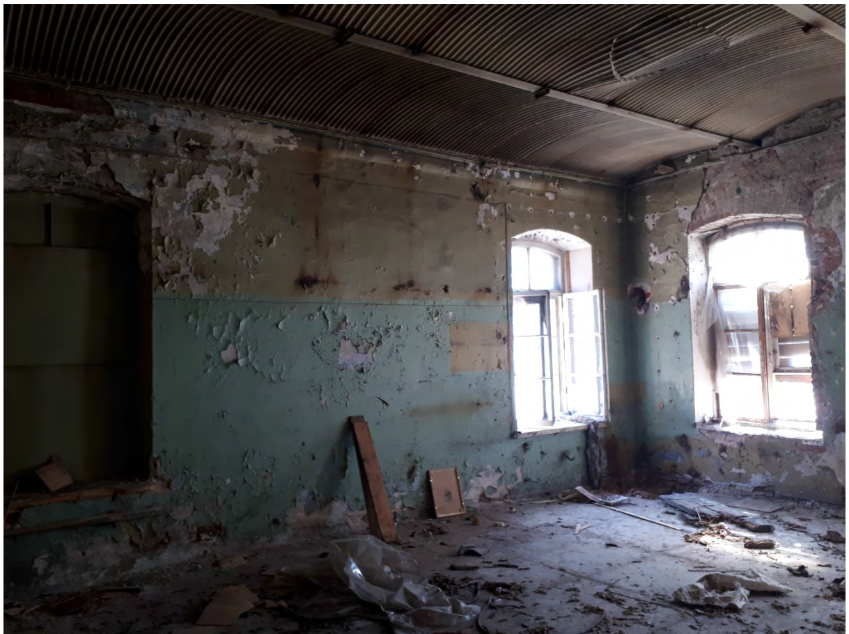
Фото 22. Вид из точки 22. Юго-Западный зал первого этажа
