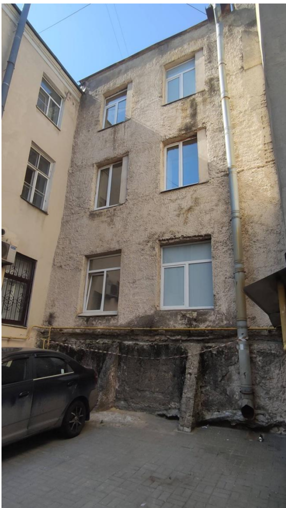
Фото 11. Фрагмент дворового фасада выявленного объекта культурного наследия «Дом Р.В. Риттера»
