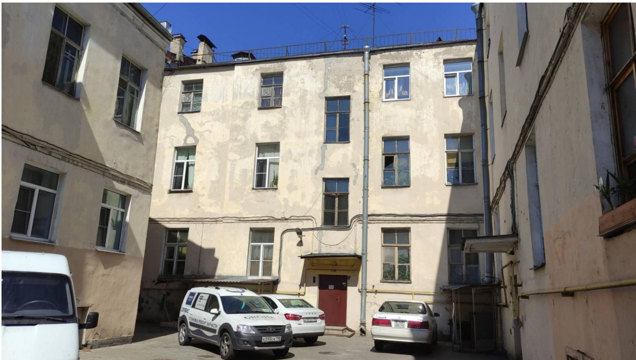
Фото 14. Фрагмент дворового фасада выявленного объекта культурного наследия «Дом Р.В. Риттера»
