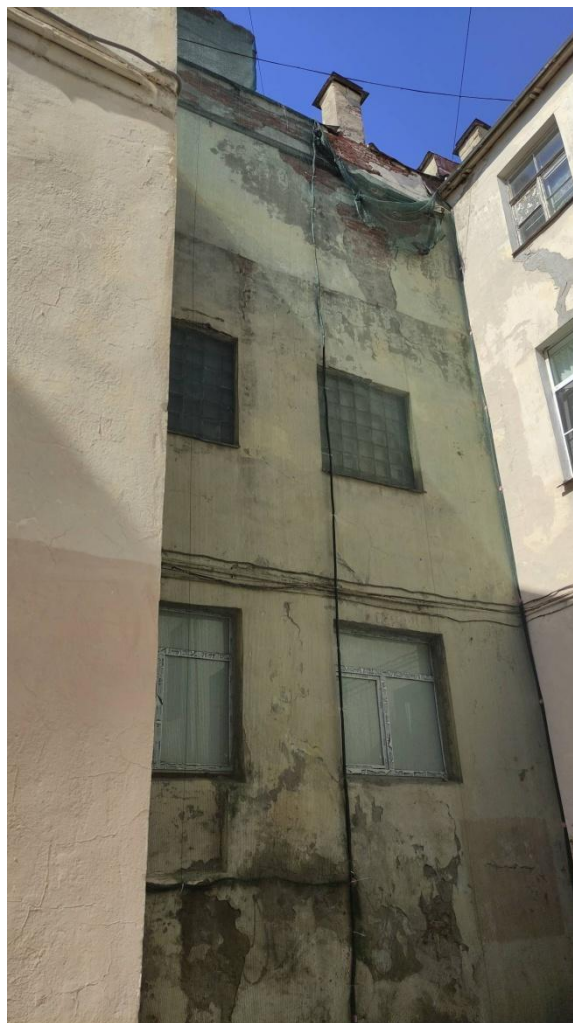
Фото 12. Фрагмент дворового фасада выявленного объекта культурного наследия «Дом Р.В. Риттера»
