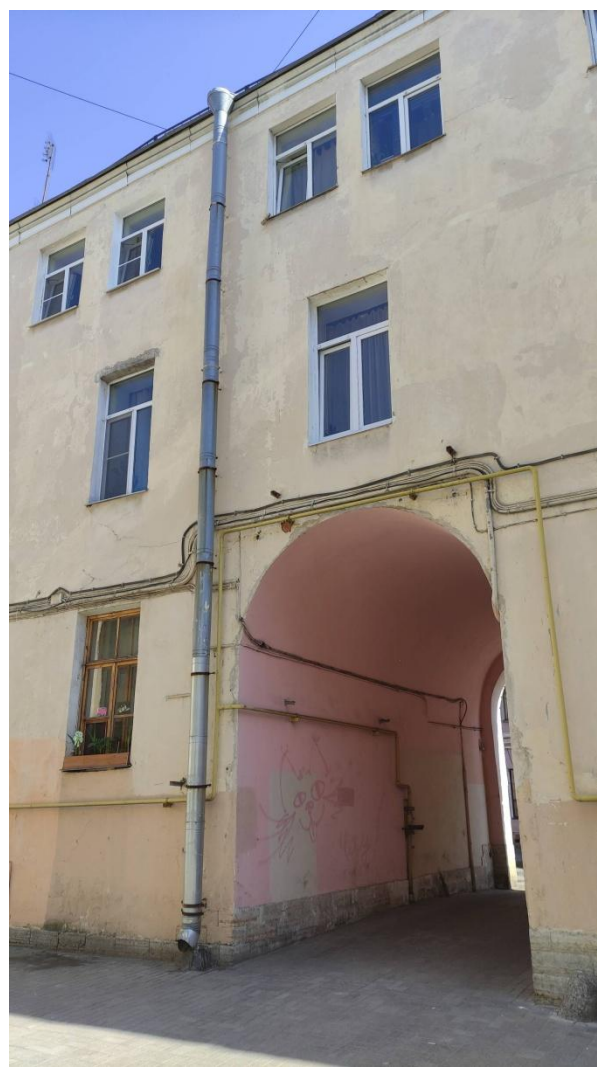
Фото 10. Воротный проезд выявленного объекта культурного наследия «Дом Р.В. Риттера»
