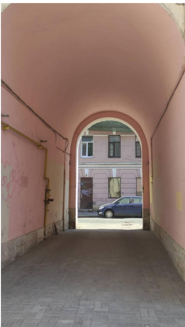
Фото 9. Воротный проезд выявленного объекта культурного наследия «Дом Р.В. Риттера»
