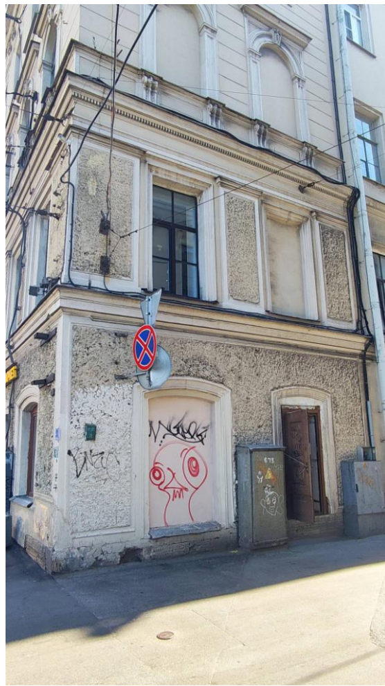
Фото 4. Фрагмент фасада объекта культурного наследия регионального значения «Дом, в котором жил в 1909-1915 гг. Маковский Константин Егорович»
