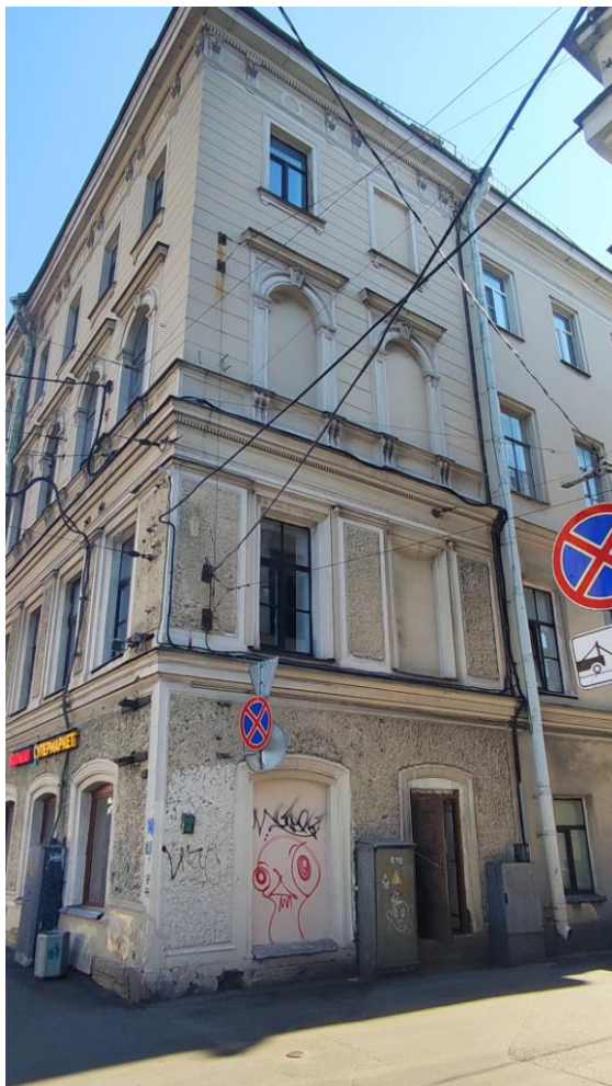
Фото 3. Фрагмент фасада объекта культурного наследия регионального значения «Дом, в котором жил в 1909-1915 гг. Маковский Константин Егорович»
