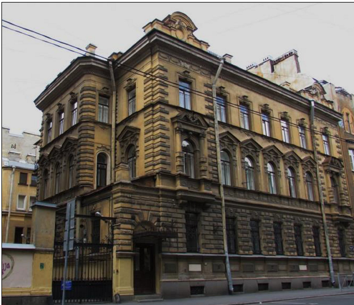
2. Вид здания с юго-западной стороны. Дата съемки: 19 октября 2020 г. Фотограф: В. П. Орлов.
