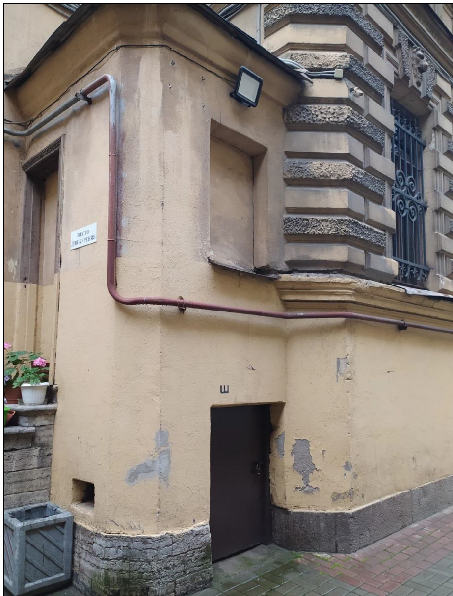
26. Фрагмент дворового фасада лицевого дома в уровне подвала и первого этажа. Дата съемки: 19 октября 2020 г. Фотограф: В. П. Орлов.
