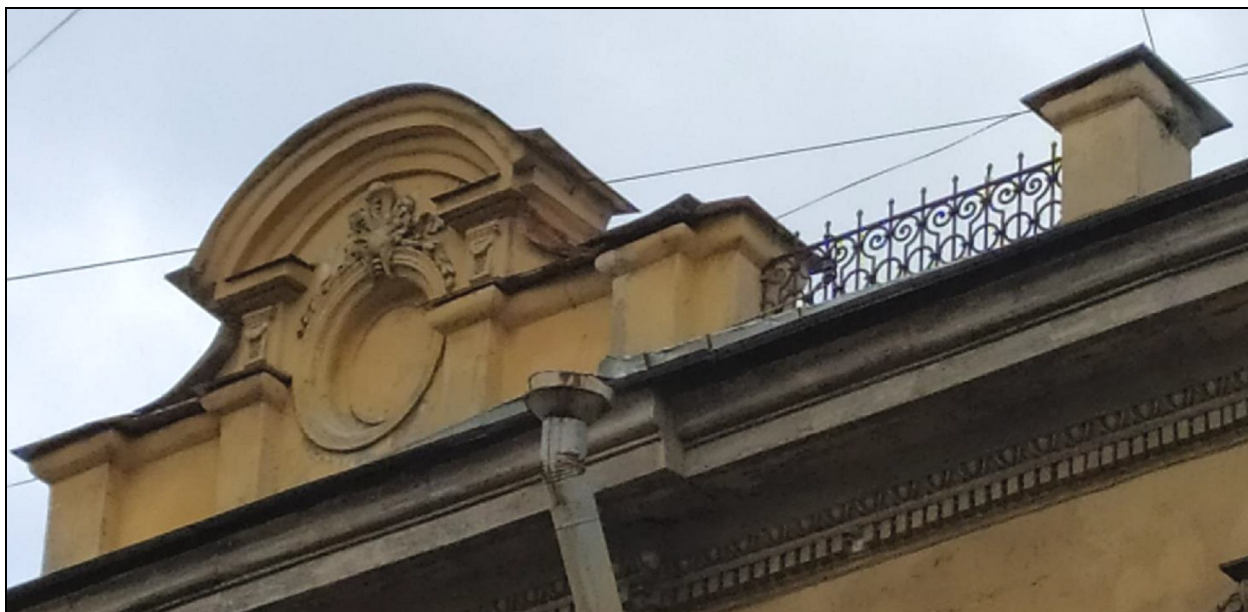
17. Аттик и кованая металлическая парапетная решетка над левым ризалитом лицевого фасада по Виленскому переулку. Дата съемки: 19 октября 2020 г. Фотограф: В. П. Орлов.
