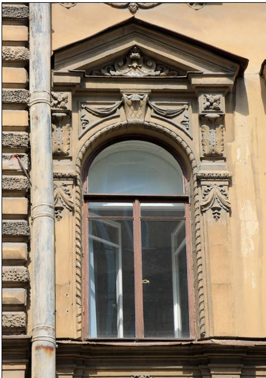
10. Оформление оконного проема второго этажа лицевого фасада по Виленскому переулку. Дата съемки: 19 октября 2020 г. Фотограф: В. П. Орлов.
