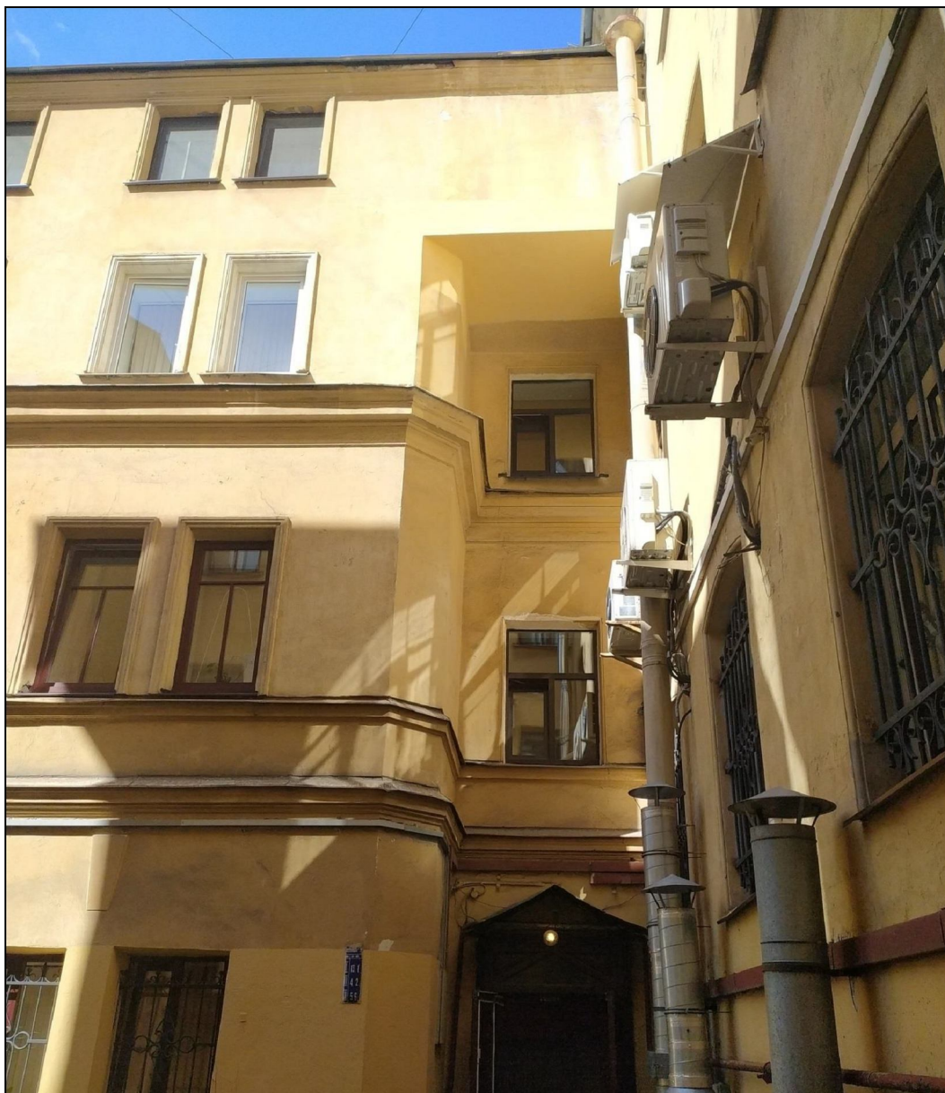
28. Фрагмент дворового фасада флигеля. Дата съемки: 19 октября 2020 г. Фотограф: В. П. Орлов.
