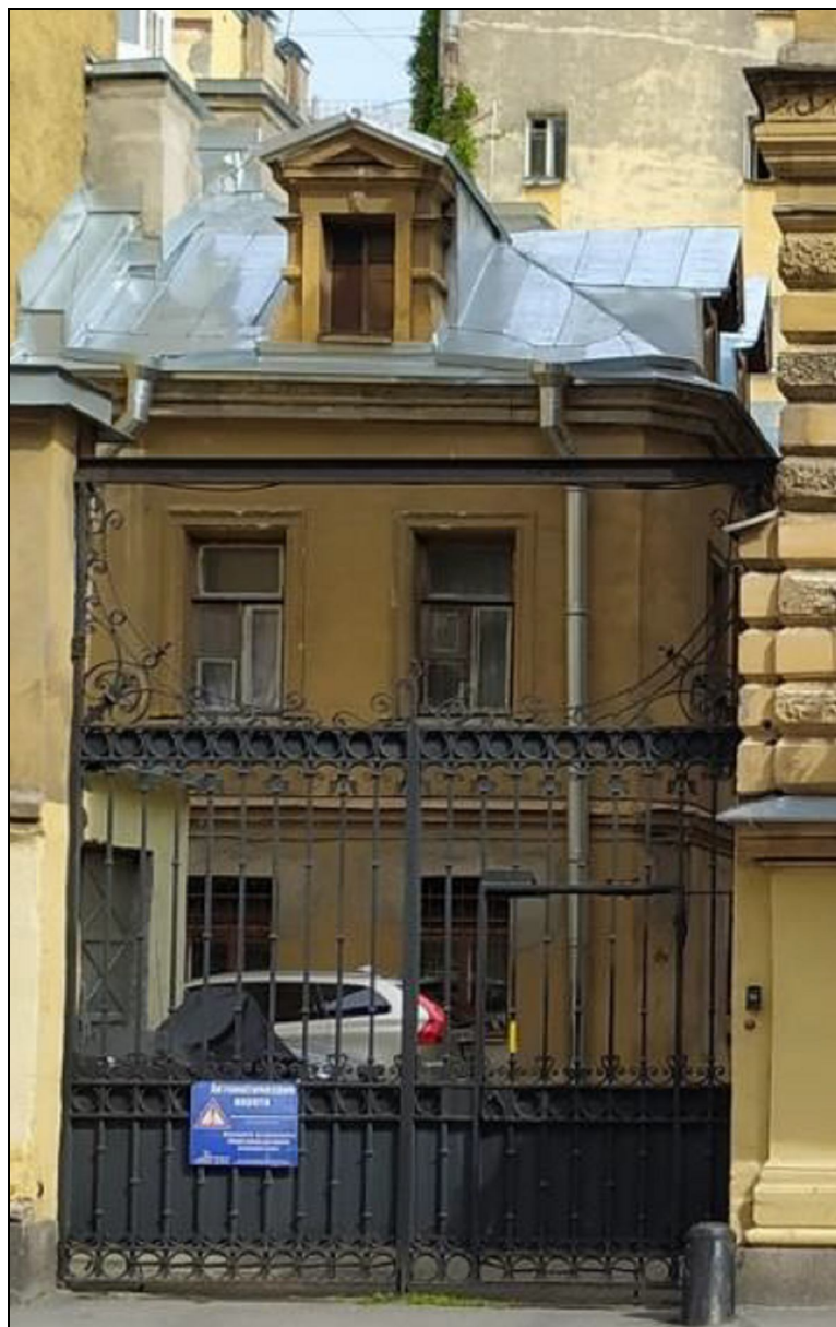
23. Вид на южный фасад западного дворового корпуса. Дата съемки: 19 октября 2020 г. Фотограф: В. П. Орлов.
