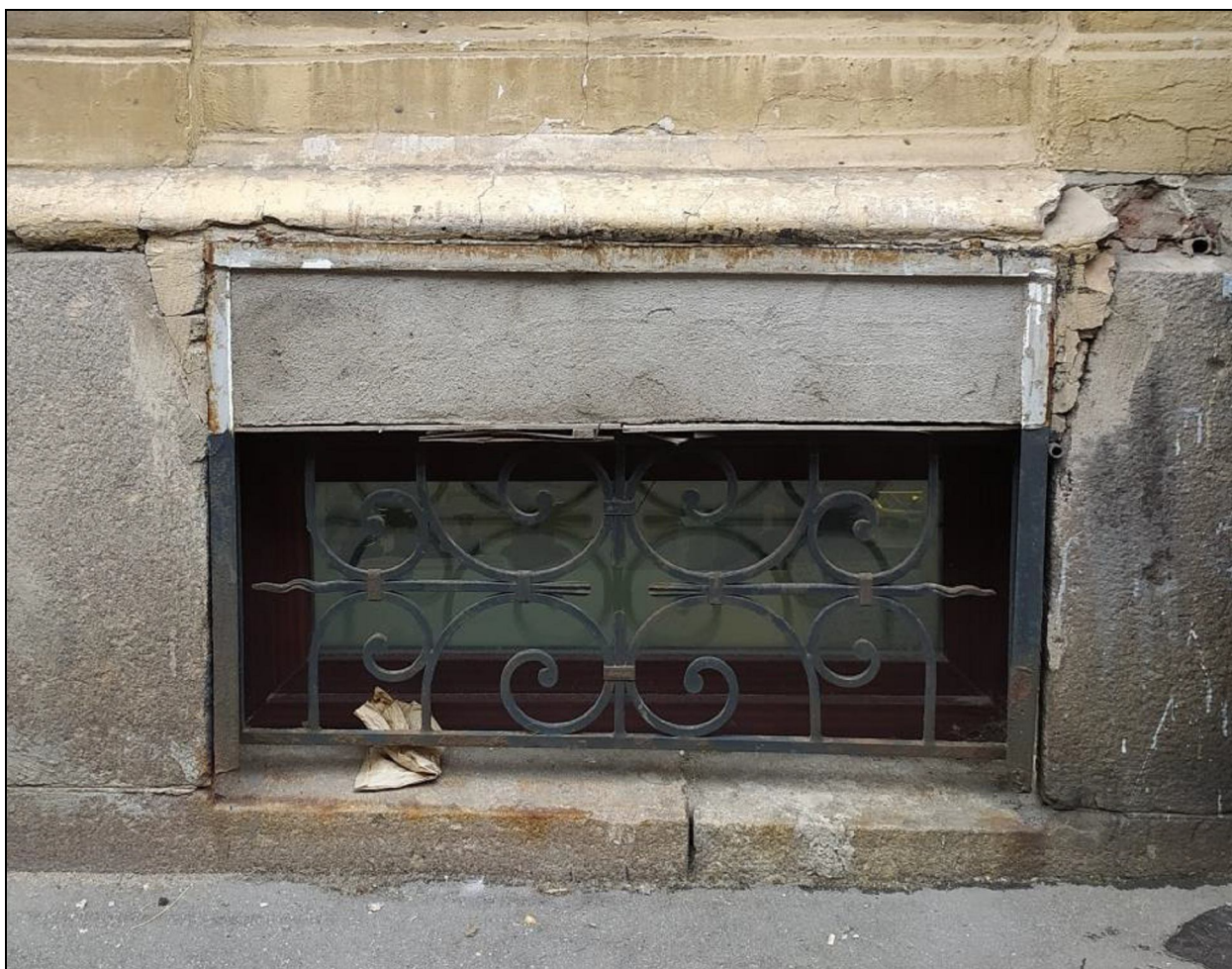
4. Гранитный цоколь и окно подвала лицевого фасада по Виленскому переулку. Дата съемки: 19 октября 2020 г. Фотограф: В. П. Орлов.
