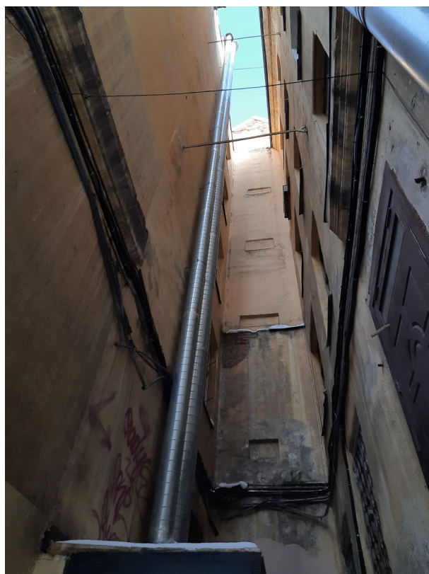
6. Фрагмент дворового фасада выявленного объекта культурного наследия «Дом Р.К. Сан-Галли»
