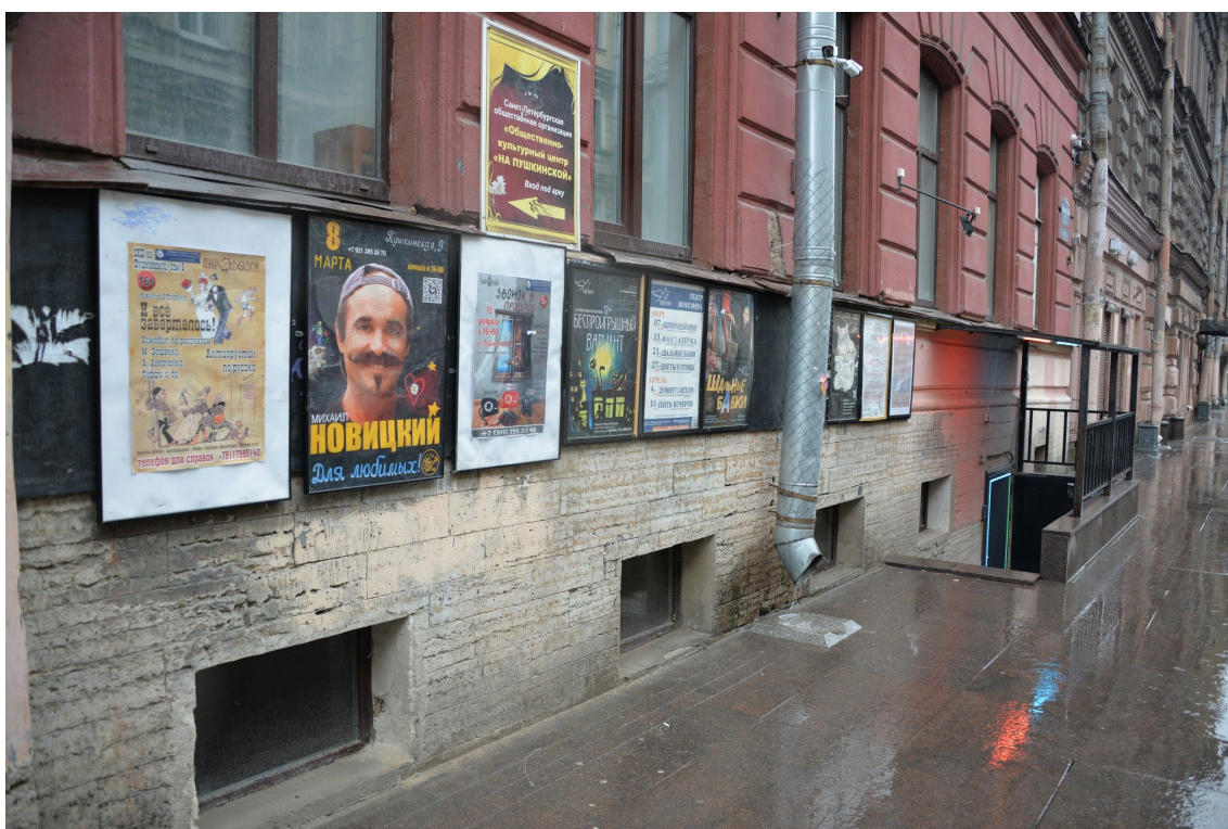
4. Фрагмент лицевого фасада выявленного объекта культурного наследия «Дом Р.К. Сан-Галли»
