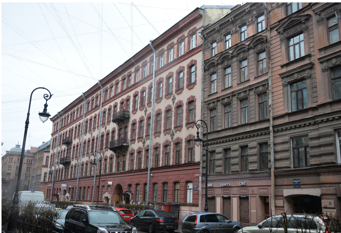
2. Лицевой фасад выявленного объекта культурного наследия «Дом Р.К. Сан-Галли»
