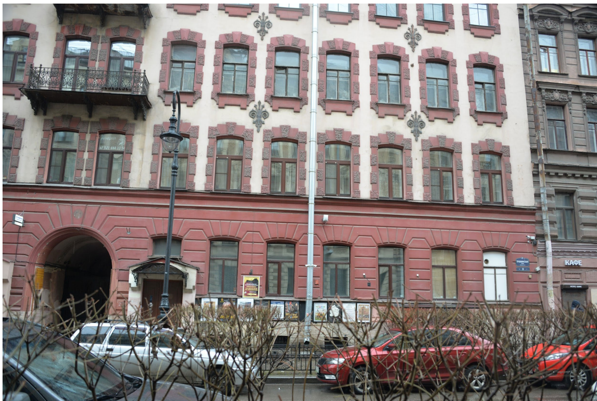
5. Фрагмент лицевого фасада выявленного объекта культурного наследия «Дом Р.К. Сан-Галли»
