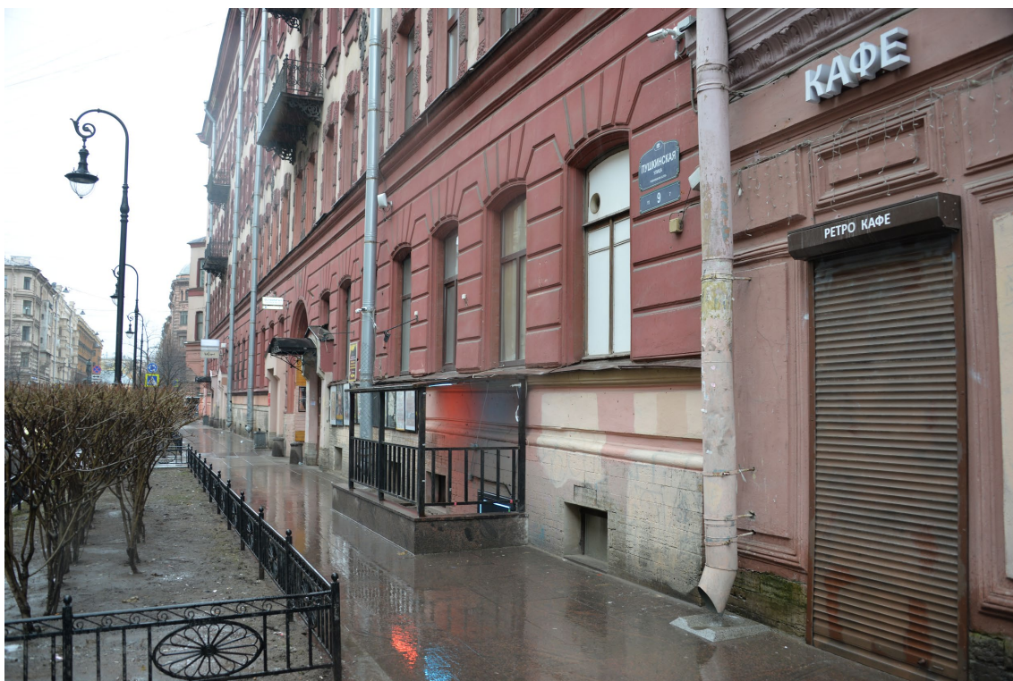
3. Фрагмент лицевого фасада выявленного объекта культурного наследия «Дом Р.К. Сан-Галли»
