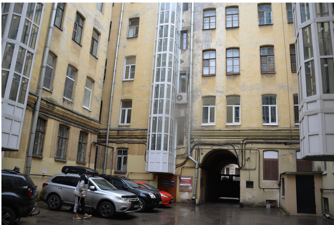
6. Фрагмент дворового фасада выявленного объекта культурного наследия «Дом Р.К. Сан-Галли»
