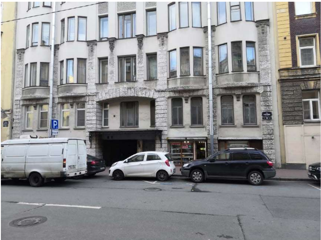
10. Выявленный объект культурного наследия «Дом Э.Э. Аригольда» (Санкт-Петербург, ул. Рылеева, д. 23, лит. А). Фрагмент лицевого фасада.
