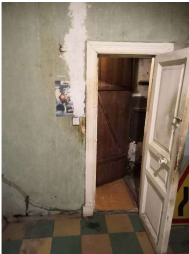
6. Выявленный объект культурного наследия «Дом Э.Э. Аригольда» (Санкт-Петербург, ул. Рылеева, д. 23, лит. А). Квартира 1 (помещение 1/10,1)
