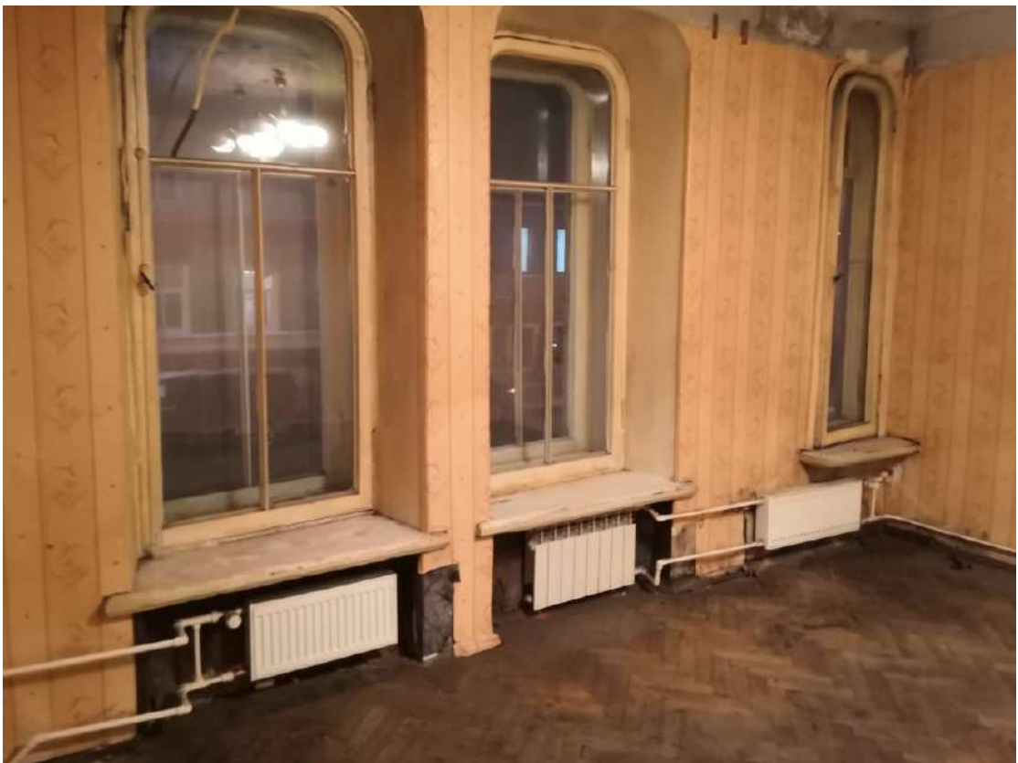
2. Выявленный объект культурного наследия «Дом Э.Э. Аригольда» (Санкт-Петербург, ул. Рылеева, д. 23, лит. А). Квартира 1 (помещение 7/22,3)
