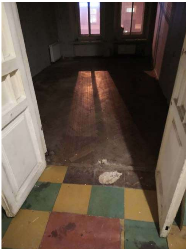
8. Выявленный объект культурного наследия «Дом Э.Э. Аригольда» (Санкт-Петербург, ул. Рылеева, д. 23, лит. А). Квартира 1 (помещение 6/17,6)
