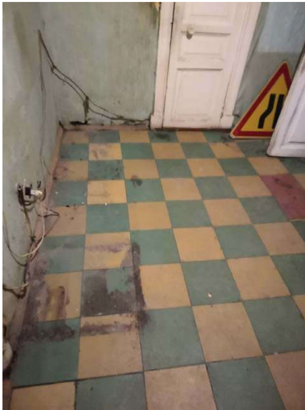
9. Выявленный объект культурного наследия «Дом Э.Э. Аригольда» (Санкт-Петербург, ул. Рылеева, д. 23, лит. А). Квартира 1 (помещение 2/24,2)
