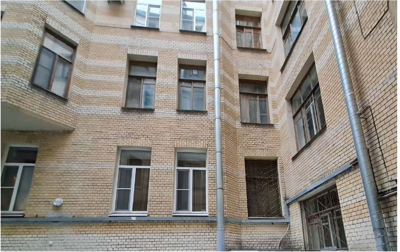
11. Выявленный объект культурного наследия «Дом Э.Э. Аригольда» (Санкт-Петербург, ул. Рылеева, д. 23, лит. А). Фрагмент дворового фасада.
