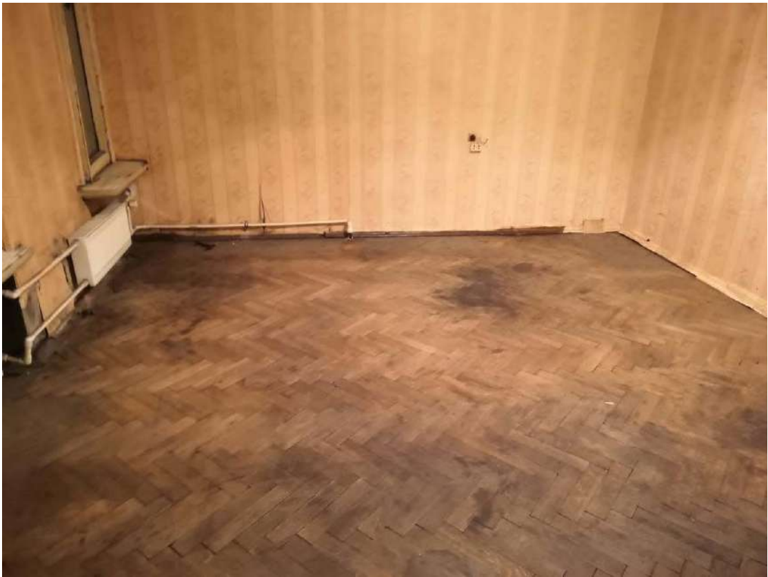
3. Выявленный объект культурного наследия «Дом Э.Э. Аригольда» (Санкт-Петербург, ул. Рылеева, д. 23, лит. А). Квартира 1 (помещение 7/22,3)
