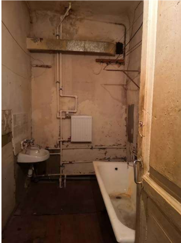
5. Выявленный объект культурного наследия «Дом Э.Э. Аригольда» (Санкт-Петербург, ул. Рылеева, д. 23, лит. А). Квартира 1 (помещение ванной)
