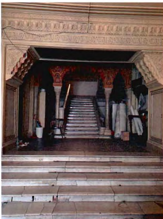
7. Лестница с Литейного пр. в кв. 12. Фрагмент.
