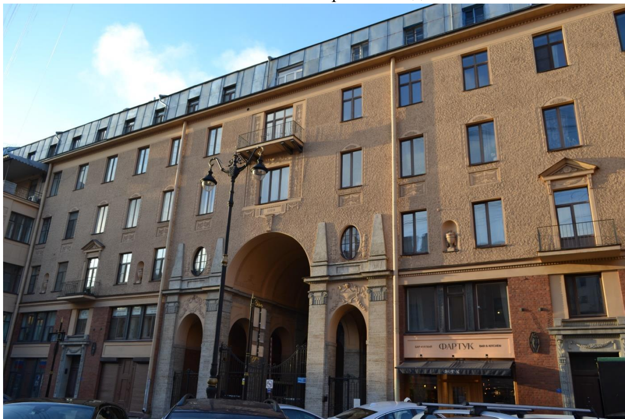
Фото 1. Лицевой фасад по ул. Рубинштейна. Вид с северо-востока.
