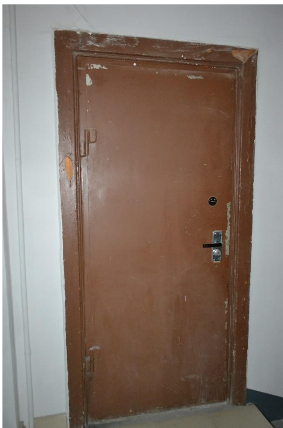
Фото 36. Вид на общий тамбур при входе в квартиру с «черной» лестницы.
