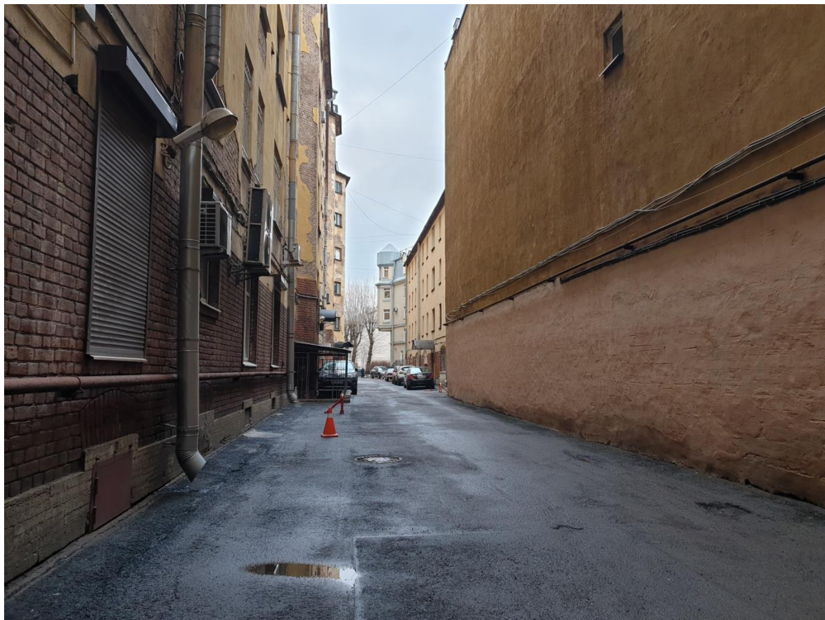
Фото 9. Пространство южного «черного» двора. Вид с северо-запада.
