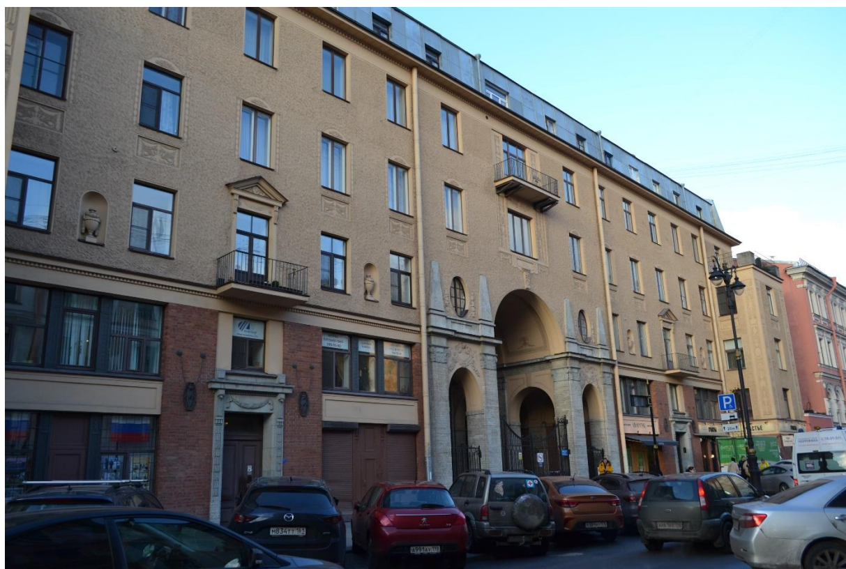
Фото 2. Фрагмент лицевого фасада по ул. Рубинштейна. Вид с юго-востока.
