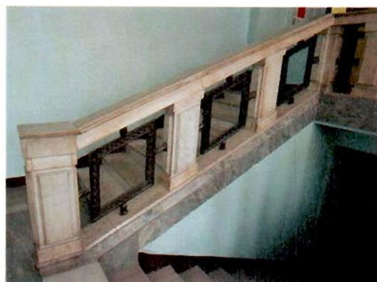
лестница (Л-10) – местоположение (литера А6), габариты, конфигурация, конструкция (по металлическим косоурам), тип (средистенная);
