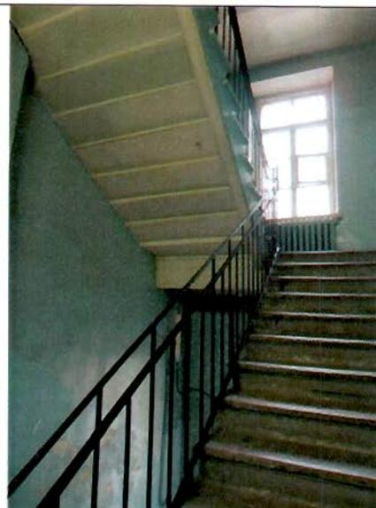
служебная лестница (Л-11) – местоположение (литера А5), габариты, конфигурация, конструкция (по металлическим косоурам), тип (трехмаршевая); материал ступеней (лещадная плита);
