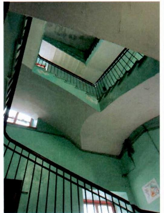
служебная лестница (Л-18) – местоположение (литера А2), габариты, конфигурация, конструкция (по металлическим косоурам), тип (двухмаршевая); материал ступеней (лещадная плита);
