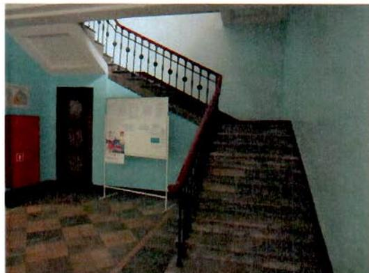
металлическое ограждение лестничных маршей – габариты, конфигурация (в виде вертикальных стоек, в средней части декорированных чередующимися элементами – растительного и геометрического характера, в верхней части завершающиеся композицией из акантовых листьев);
