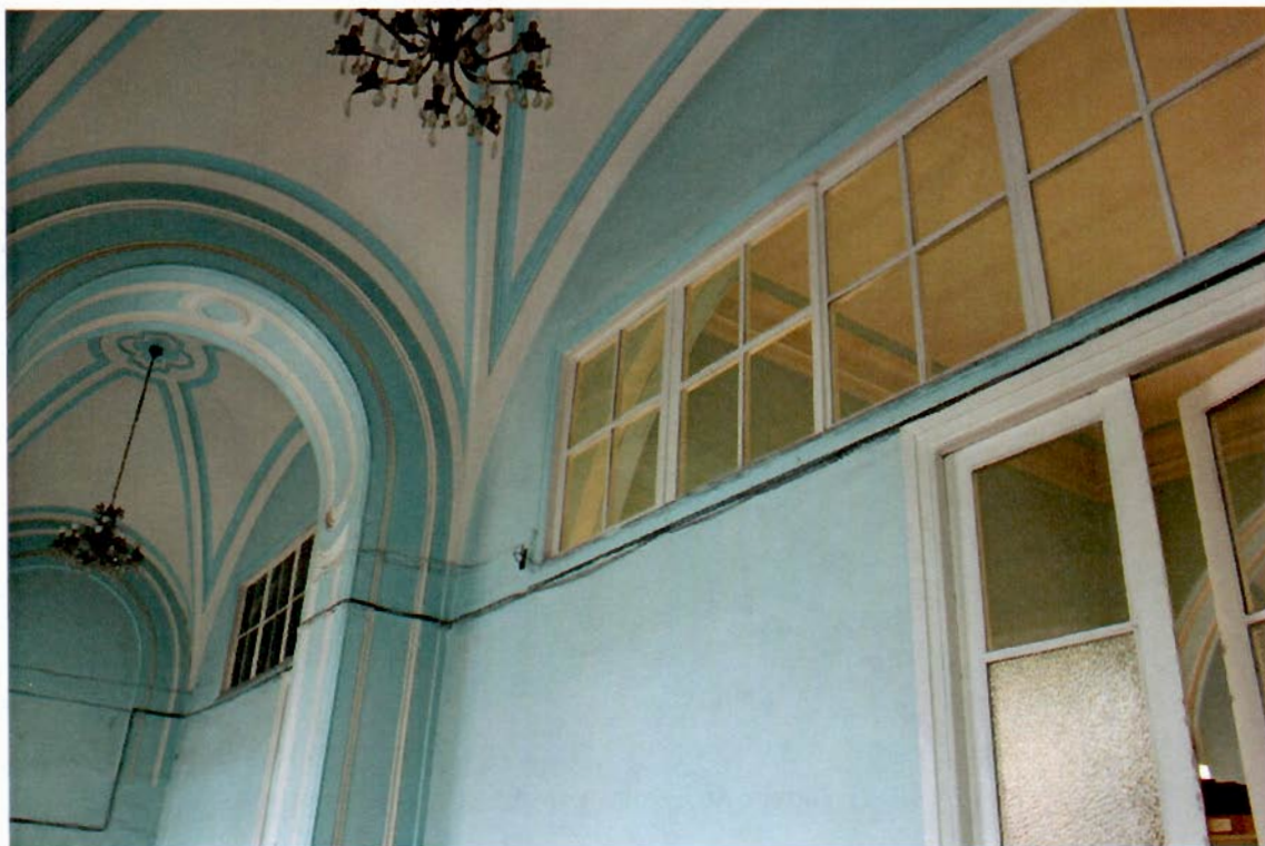
Фото №23. Литера А1. Пом. 35Н(4,7,9,10,11).
