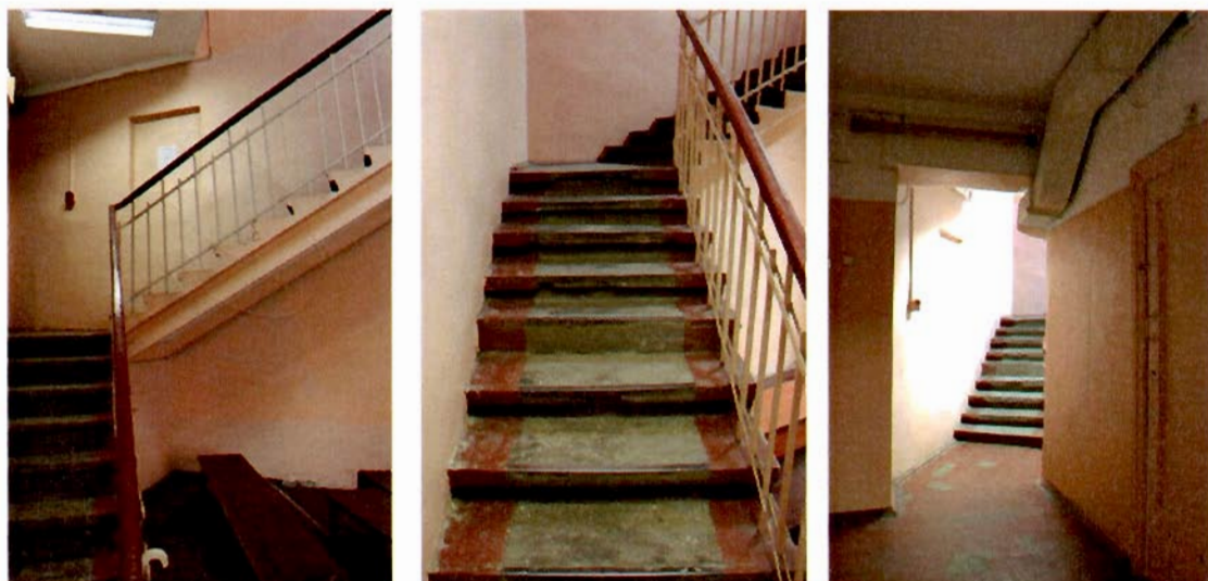
Фото №55, 56, 57. Литера А1. Служебные лестничные клетки.
