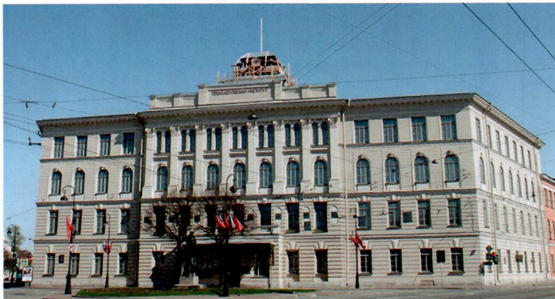
Фото №1. Центральный лицевой фасад Литеры А1 со стороны Технологической пл.
