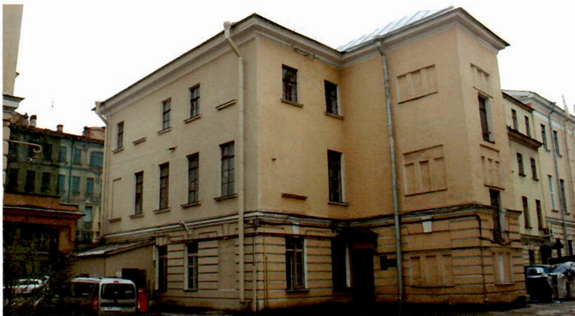
Фото №32. Дворовые фасады Литеры А2.
