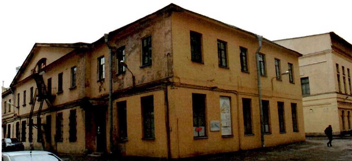
Фото №38. Внутренний двор. Западный и северный фасады Литеры А 3-4.
