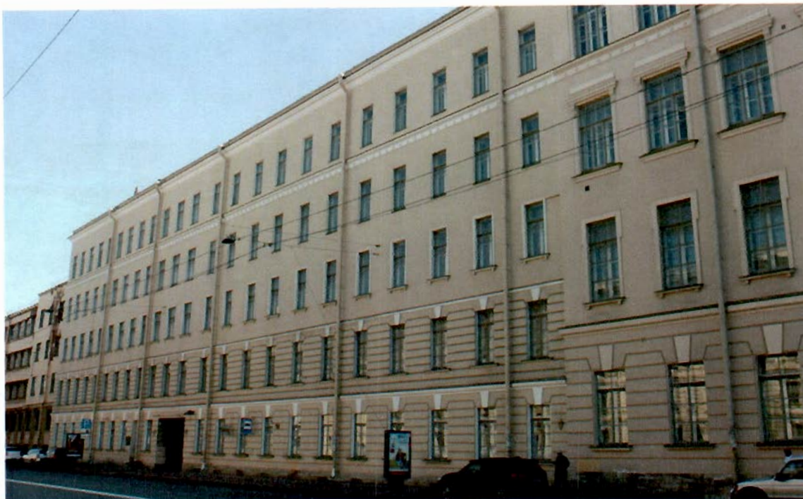
Фото №5. Лицевой фасад Литеры А6 по Московскому пр.
