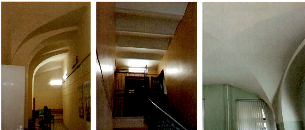
Фото №45, 46, 47. Литера А3-4. Межэтажные сводчатые перекрытия.
