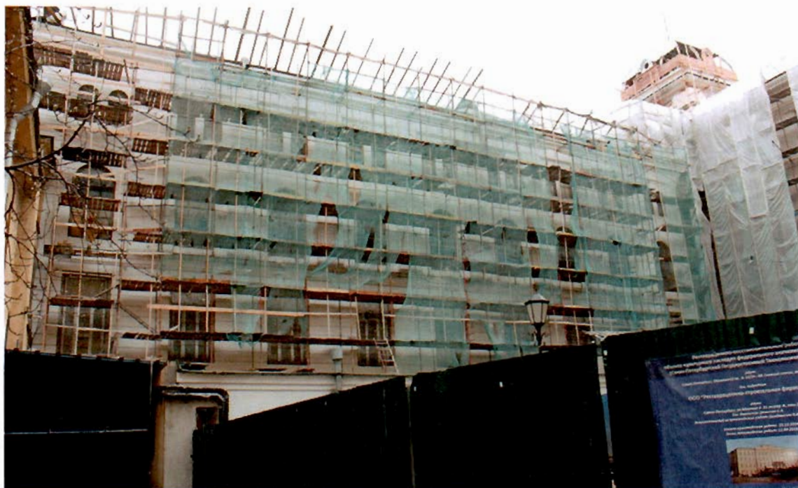
Фото №22. Дворовый фасад Литеры А1.
