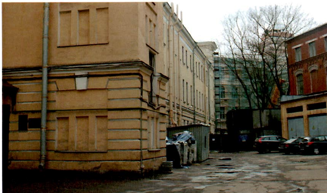
Фото №37. Внутренний двор. Вид на Литеры А1, А2 и А5.
