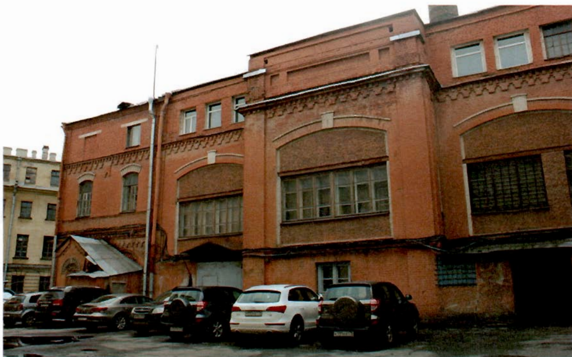
Фото №51. Внутренний двор. Северо-восточный фасад Литеры А 5.
