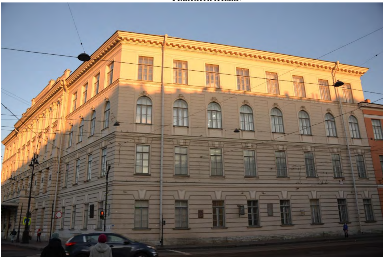
4. Фасад по Загородному проспекту объекта культурного наследия федерального значения «Институт Технологический»
