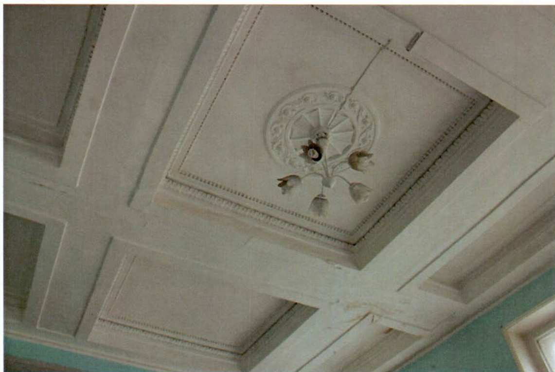
Фото №15. Литера А6. Парадный вестибюль (Л-10).
