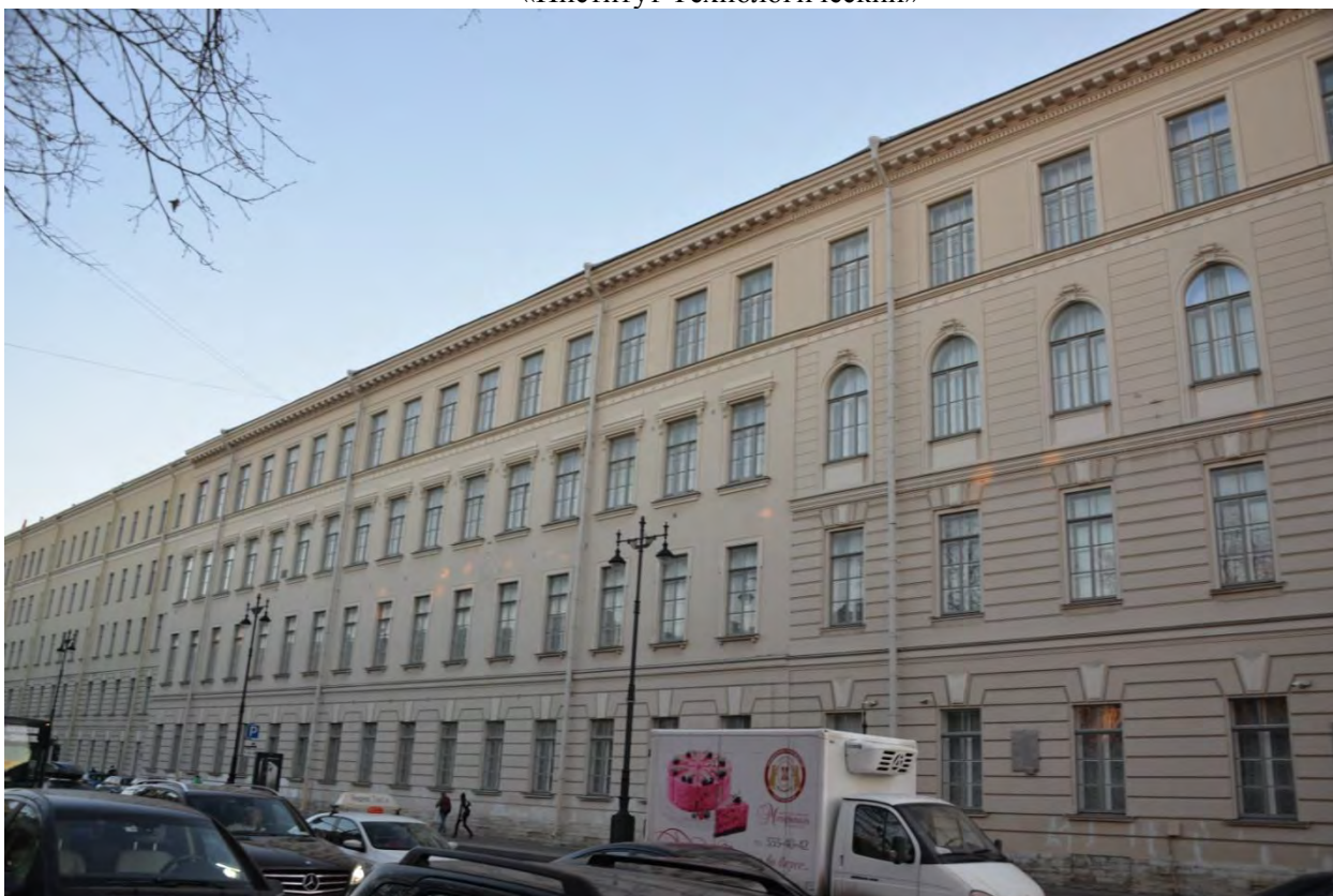
10. Фасад по Загородному проспекту объекта культурного наследия федерального значения «Институт Технологический»
