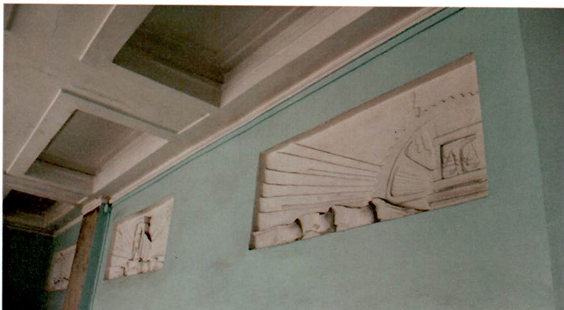
Фото №16. Литера А6. Парадный вестибюль (Л-10).
