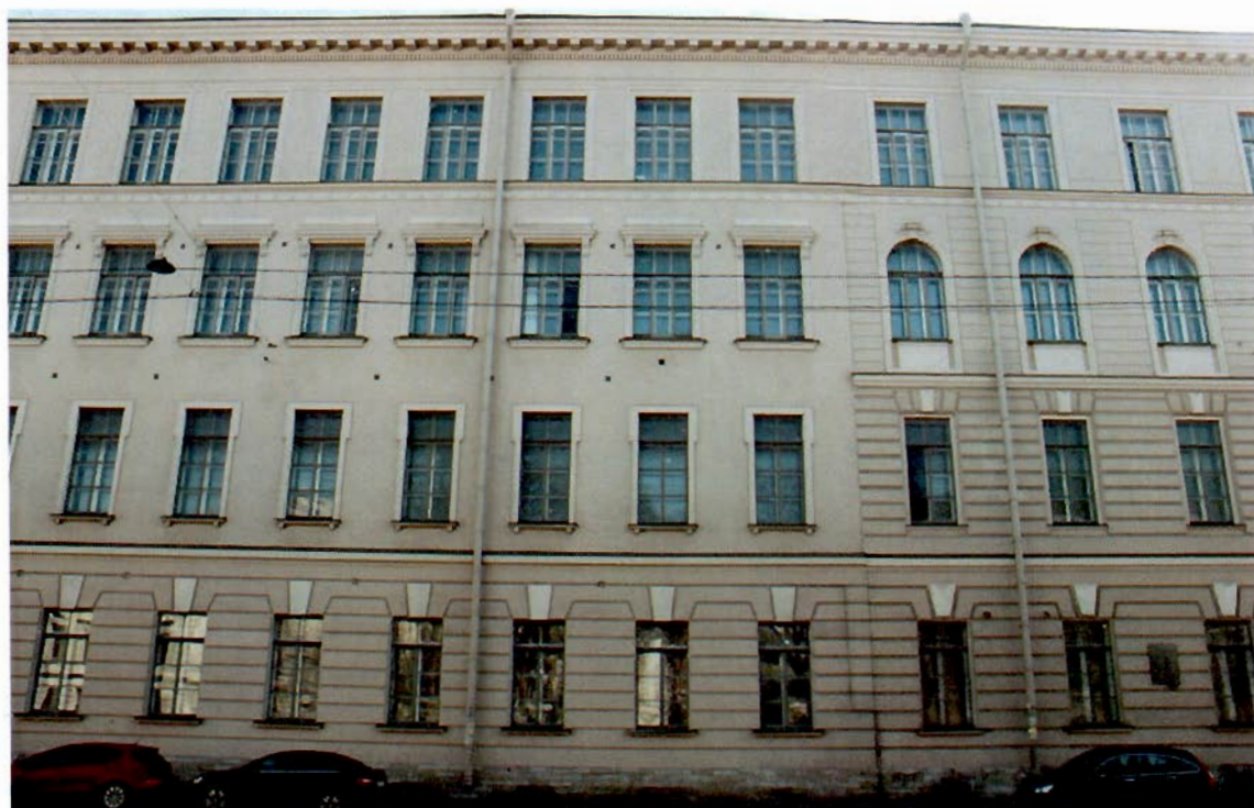
Фото №4. Фрагмент лицевого фасада четырехэтажного корпуса Литеры А1 по Московскому пр.
