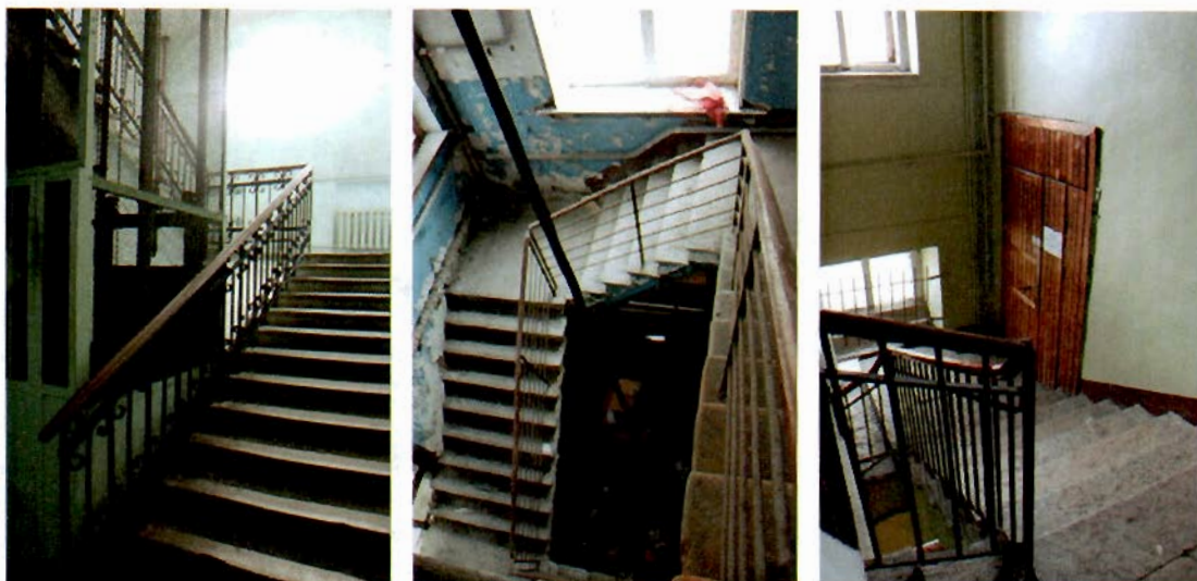
Фото №8, 9, 10. Литера А6. Служебные лестничные клетки.
