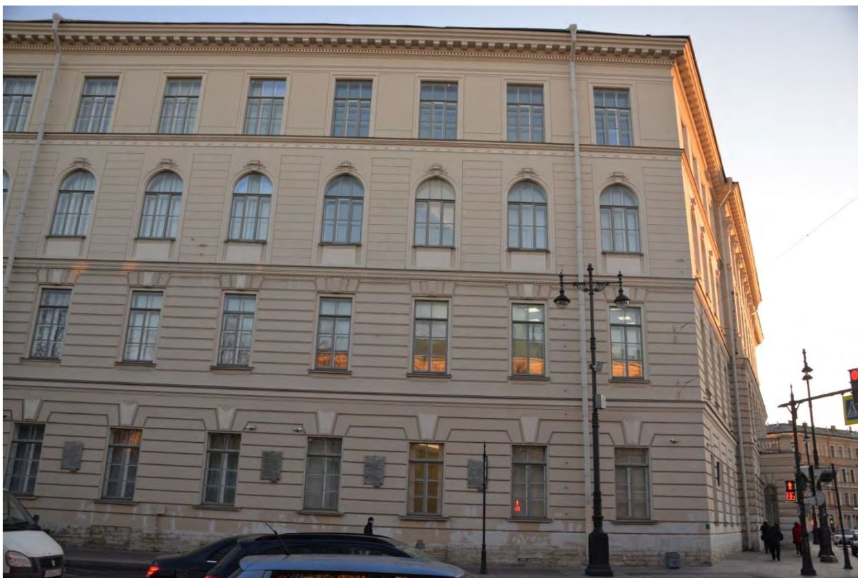
9. Фасад по Загородному проспекту объекта культурного наследия федерального значения «Институт Технологический»
