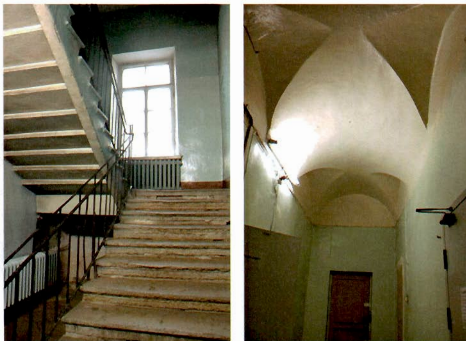
Фото №35, 36. Литера А2. Служебная лестничная клетка и межэтажное сводчатое перекрытие.
