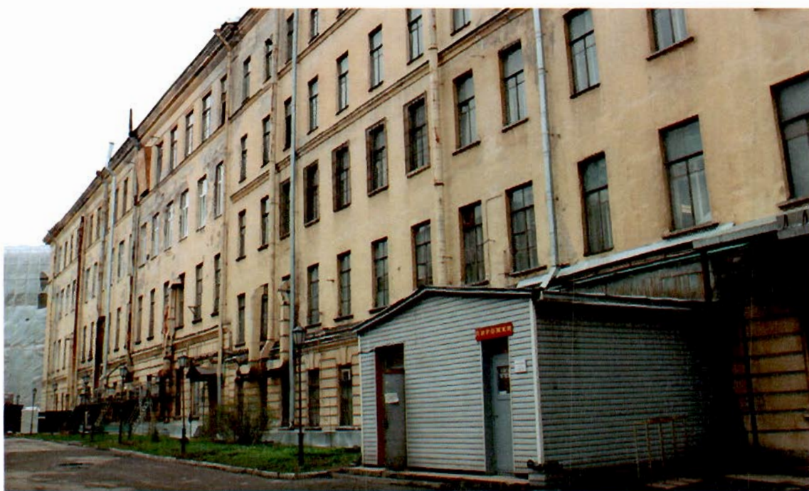
Фото №6. Дворовые фасады Литер А1 и А6.
