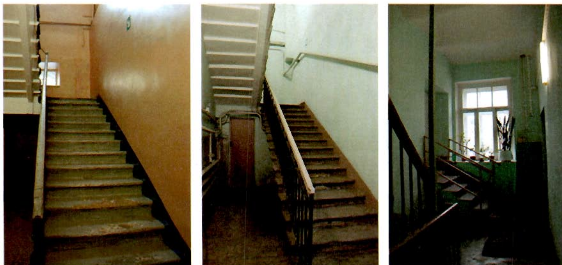
Фото №48, 49, 50. Литера А3-4. Служебные лестничные клетки.
