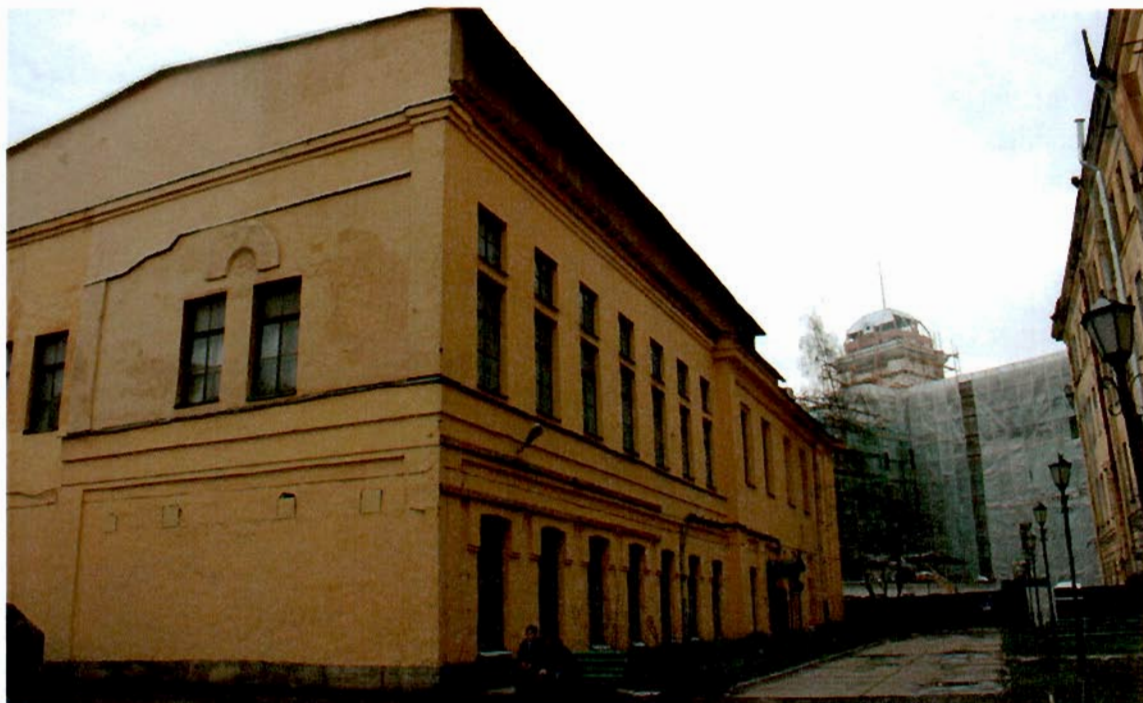
Фото №54. Дворовые фасады Литеры А1.
