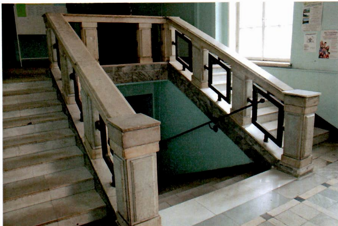
Фото №14. Литера А6. Парадный вестибюль (Л-10).
