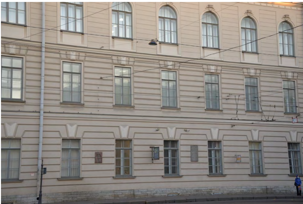
5. Фрагмент фасада по Загородному проспекту объекта культурного наследия федерального значения «Институт Технологический»
