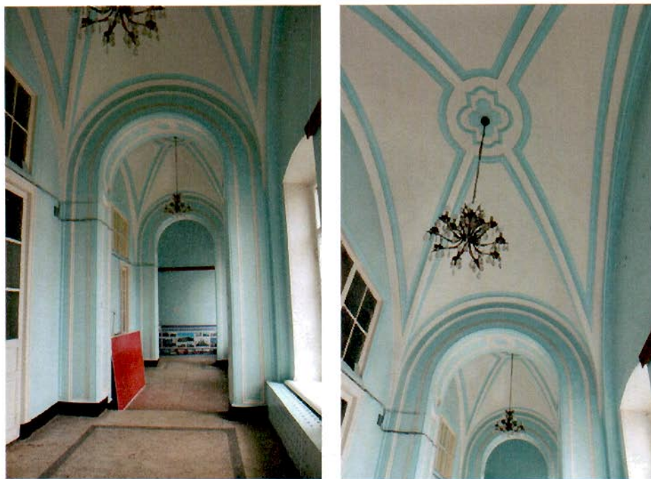
Фото №24, 25. Литера А1. Пом. 35Н(4,7,9,10,11).
