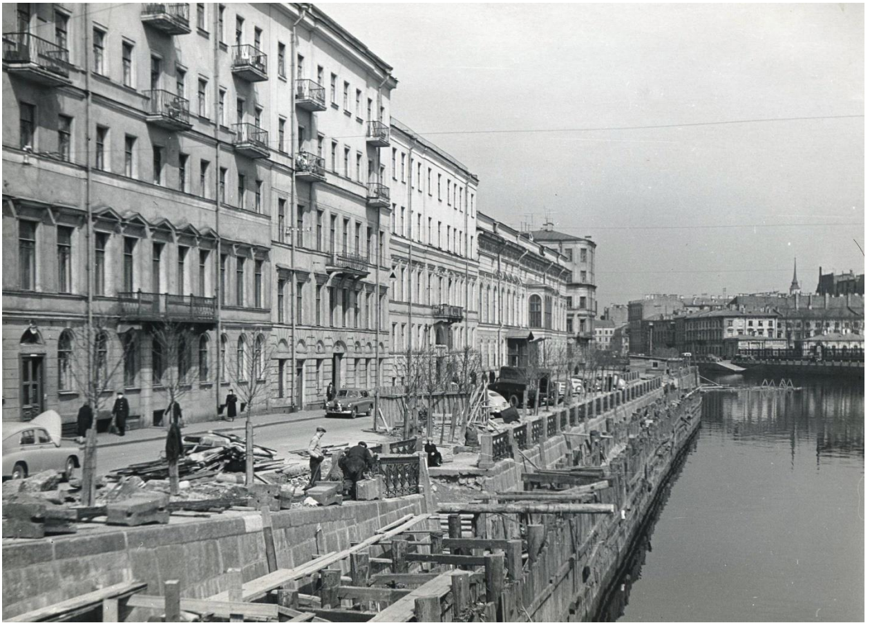
Илл. 13. Ремонт набережной реки Фонтанки, 1955 г. Электронный портал pastvu.com .
