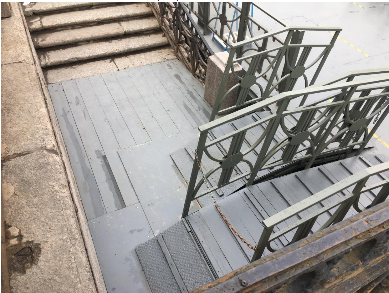
Фото 8. Вид на нижнюю площадку спуска с установленными трапами.
