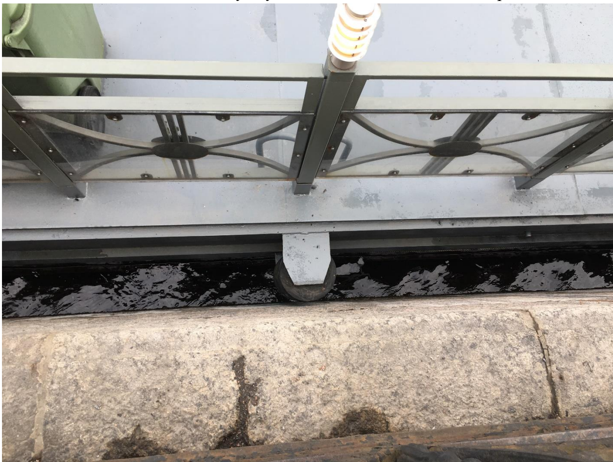
Фото 10. Резиновый кранец на борту понтона.
