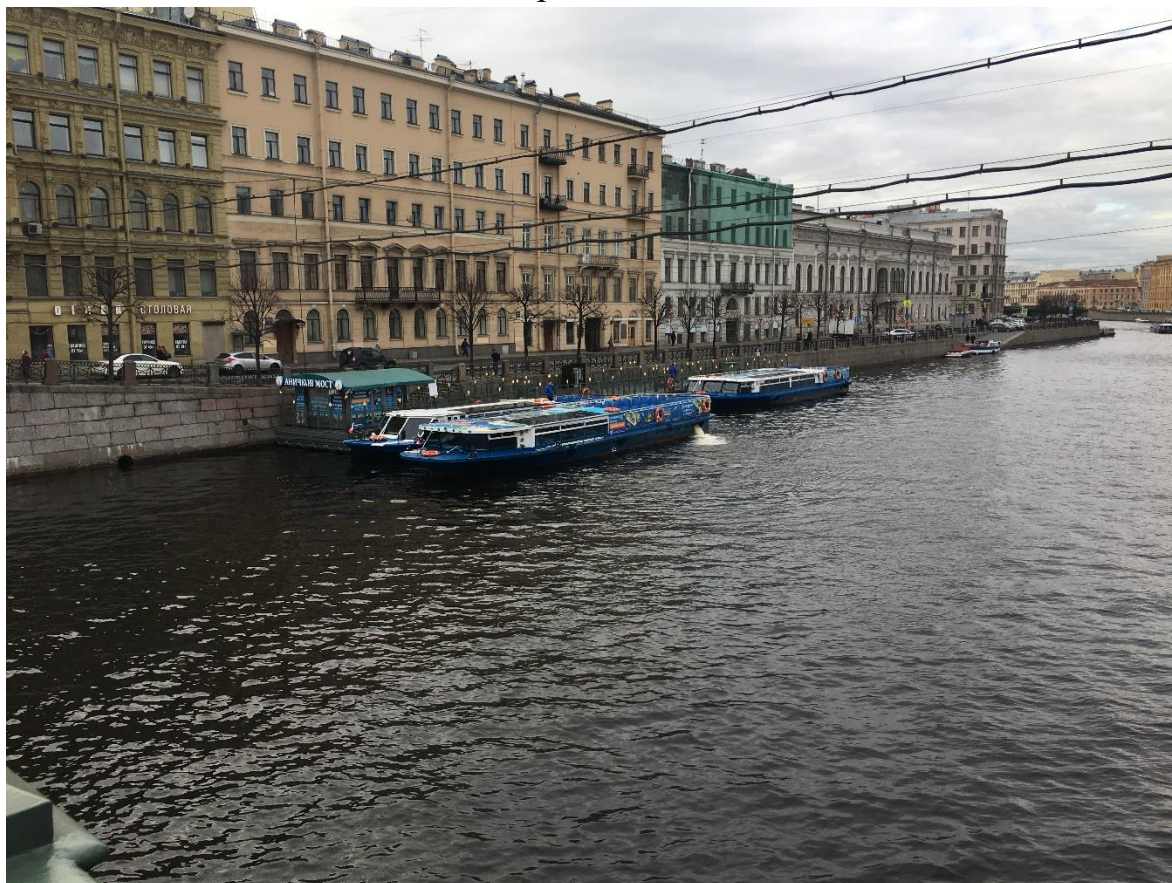
Фото 4. Общий вид спуска у дома № 27 и 3-х понтонов с павильоном, вид с восточной части Аничкова моста.
