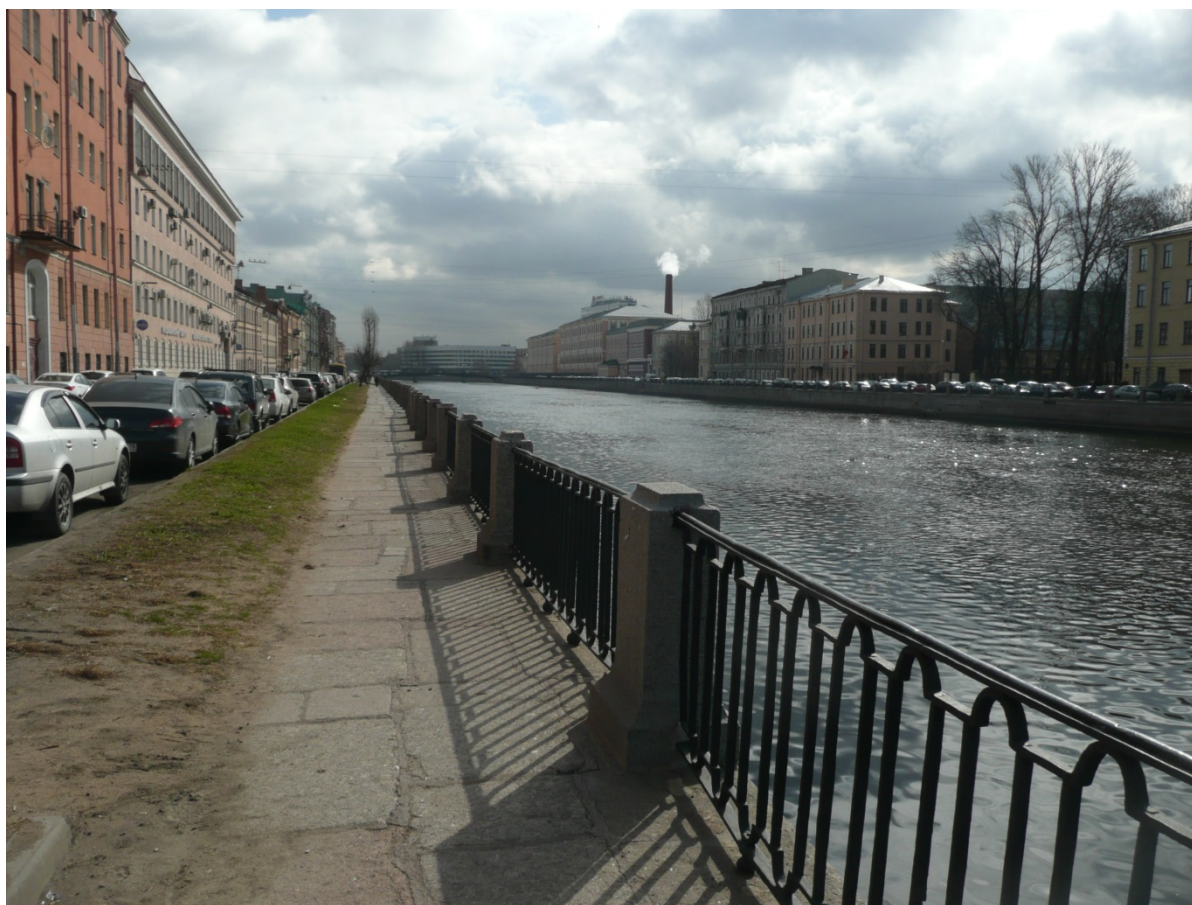
Фото 23-24. Общий вид ограждения правого берега набережной р. Фонтанки.
