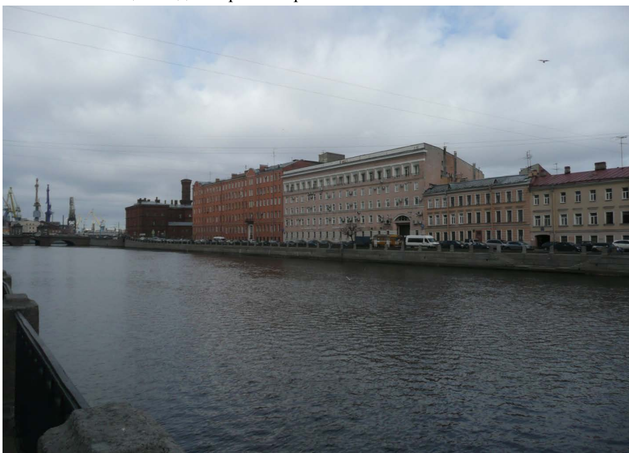
Фото 2. Участок набережной р. Фонтанки (правый берег). Общий вид.
