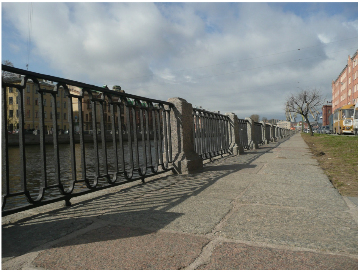
Фото 30. Фрагмент ограждения и тротуара набережной (напротив дом № 195).
