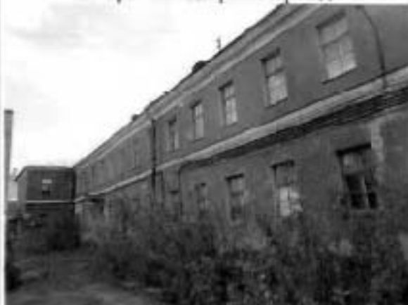
32. Фрагмент дворового фасада.
