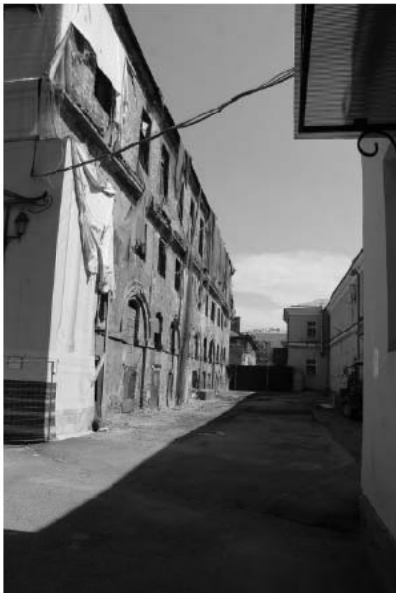
12. Рассматриваемое здание по адресу г. Санкт-Петербург, Садовая ул., д. 26, литера Р Объект культурного наследия федерального значения «Службы (три корпуса)» входящий в состав ансамбля «Дворец Воронцова М.И. (Пажеский корпус)» по адресу: г. Санкт-Петербург, Садовая ул., д. 26, литера А Вид с северо-запада Дата съемки: 27 мая 2021 г.
