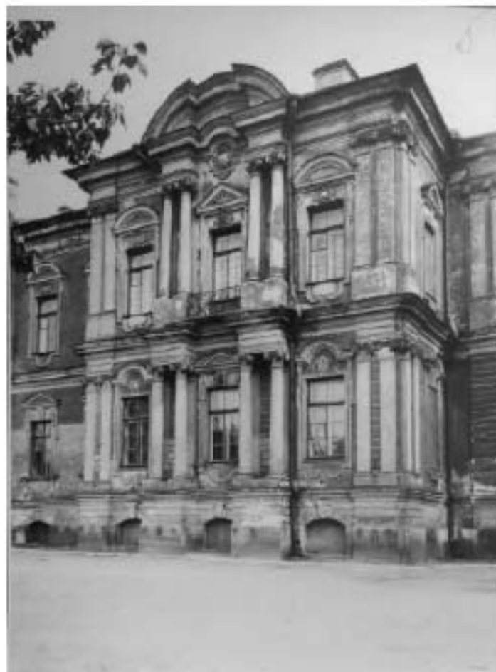
38. Воронцовский дворец. Фрагмент главного фасада. 1950-е гг. Источник: Архив КГИОП
