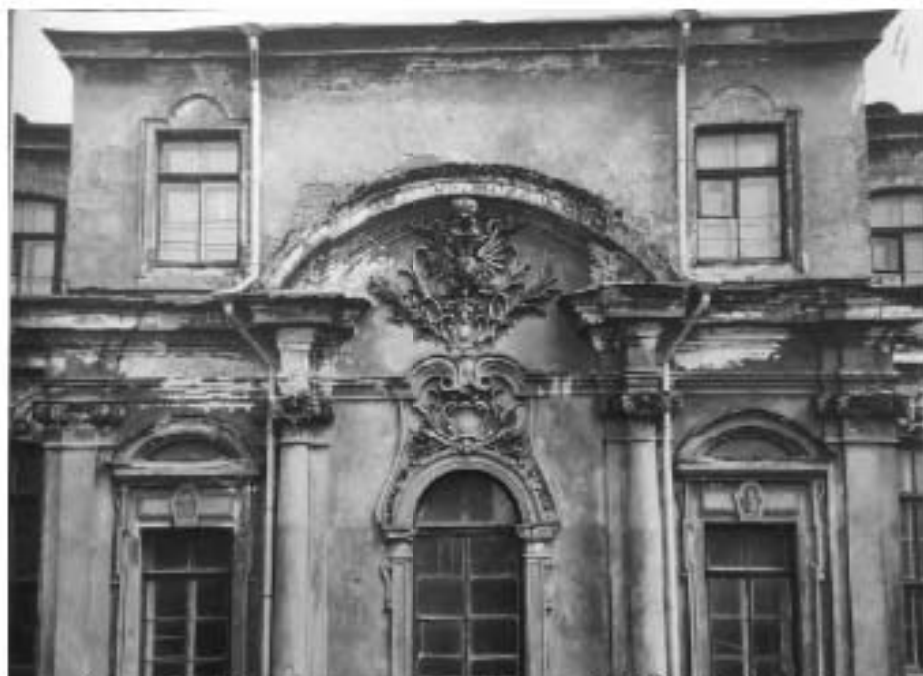
39. Воронцовский дворец. Фрагмент бокового фасада. 1950-е гг. Источник: Архив КГИОП
