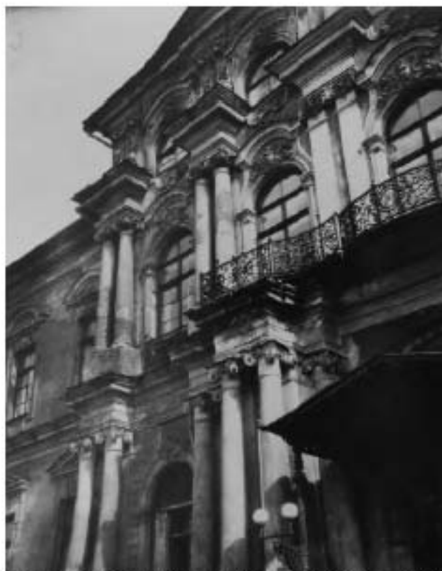
37. Воронцовский дворец. Фрагмент главного фасада. 1950-е гг. Источник: Архив КГИОП
