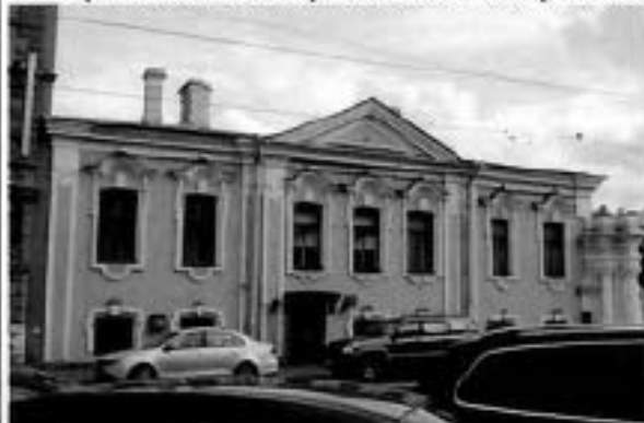
35. Фрагмент лицевого фасада восточного флигеля.
