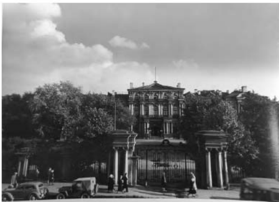
36. Бывший Воронцовский дворец. Фрагмент фасада. 1950-е гг. Источник: Архив КГИОП
