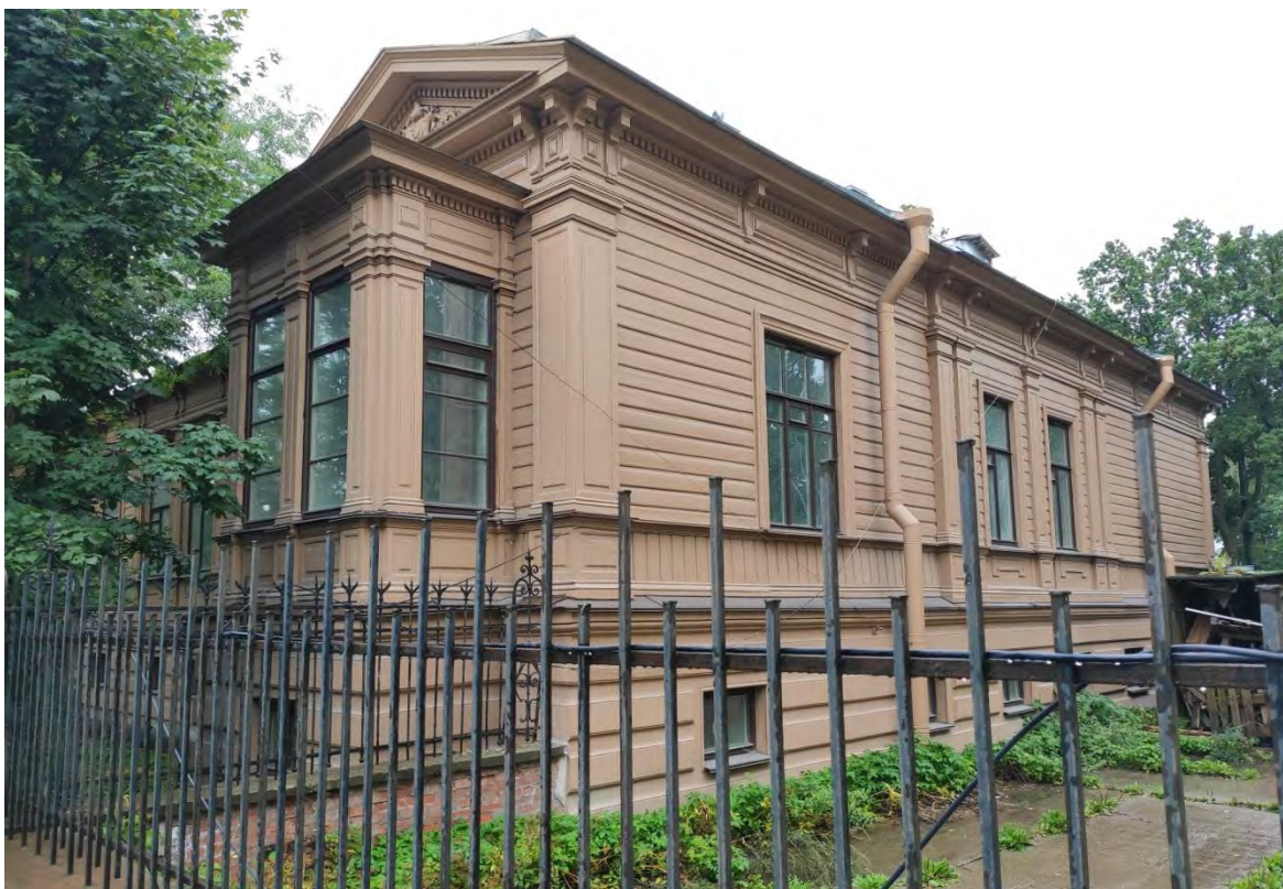
Фото 5. Вид на западный фасад особняка В.И. Гота.
