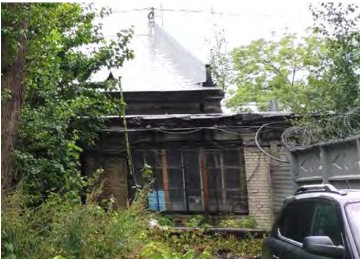
Фото 11. Вид на позднюю пристройку к канатному корпусу со складом.
