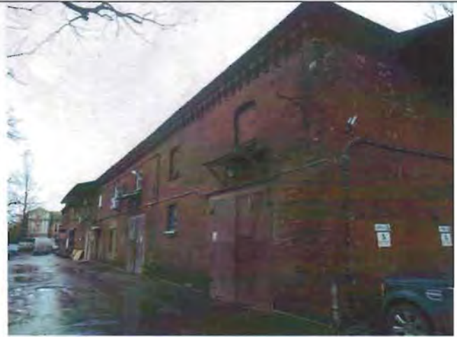
Юго-восточный фасад канатного склада
