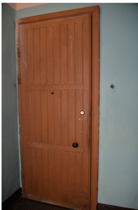
4. Входная дверь в квартиру №34
