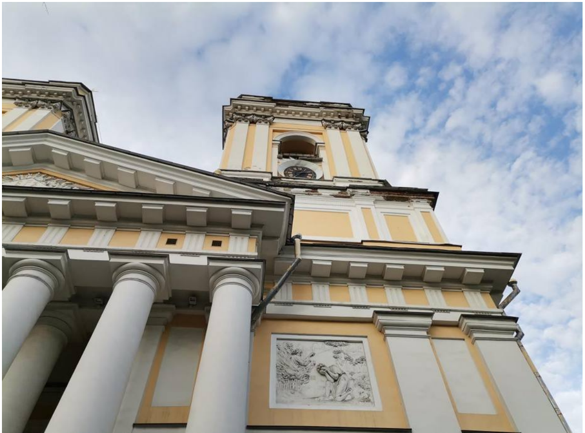
Фото 48. ОКН федерального значения «Собор Троицкий с двумя соединительными корпусами». Западный фасад. Фрагмент. Съёмка 28.04.2021 г.
