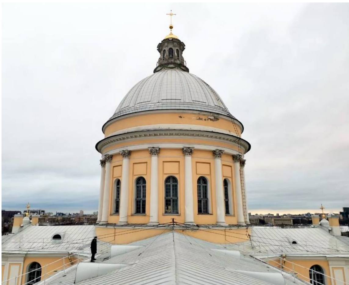
Фото 49. ОКН федерального значения «Собор Троицкий с двумя соединительными корпусами». Купол. Общий вид. Съёмка 28.04.2021 г.
