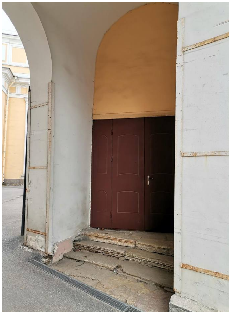
Фото 06. ОКН федерального значения «Собор Троицкий с двумя соединительными корпусами». Южный соединительный корпус. Фрагмент. Съёмка 28.04.2021 г.
