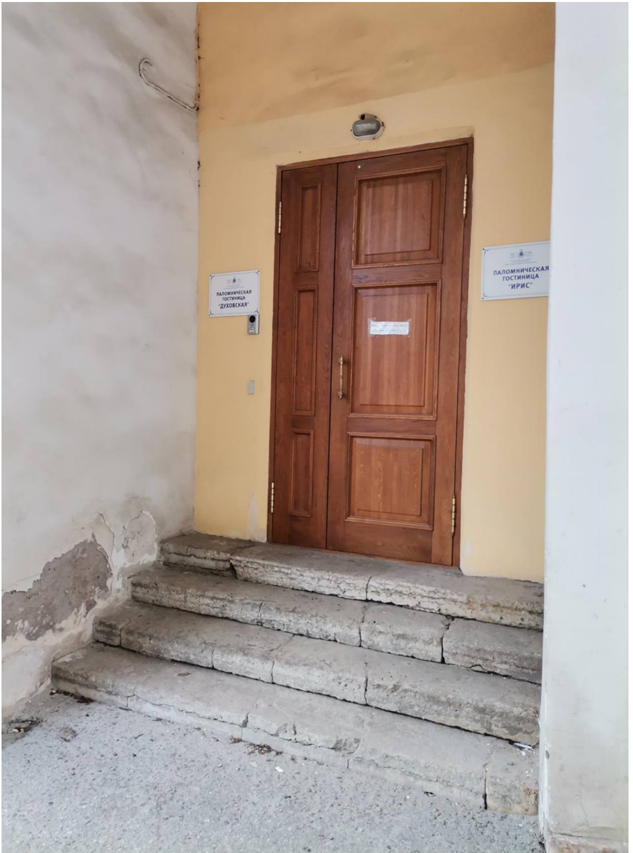
Фото 33. ОКН федерального значения «Собор Троицкий с двумя соединительными корпусами». Северный соединительный корпус. Фрагмент. Съёмка 28.04.2021 г.
