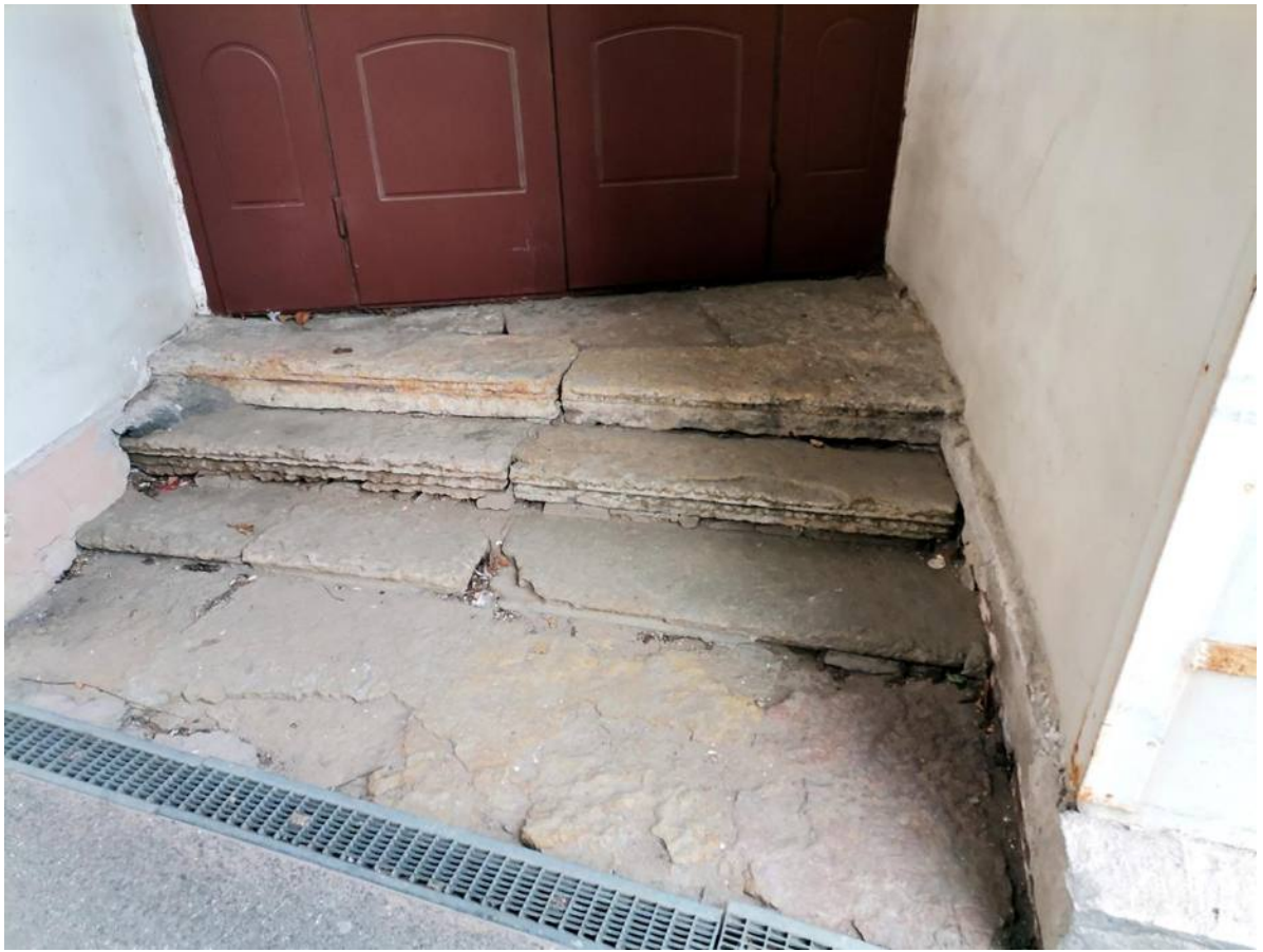
Фото 07. ОКН федерального значения «Собор Троицкий с двумя соединительными корпусами». Южный соединительный корпус. Фрагмент. Съёмка 28.04.2021 г.
