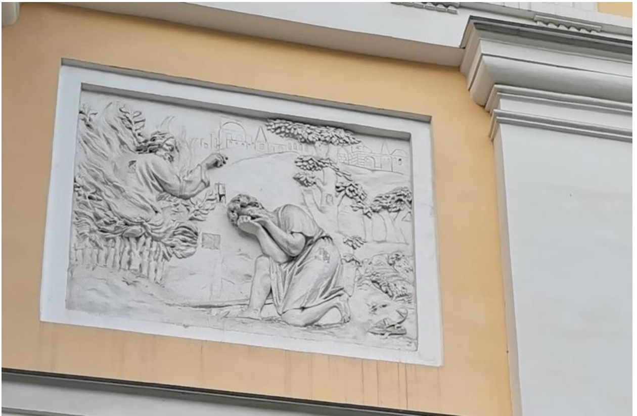
Фото 42. ОКН федерального значения «Собор Троицкий с двумя соединительными корпусами». Западный фасад. Фрагмент. Горельеф «Явление Бога Моисею в купине». Съемка 28.04.2021 г.
