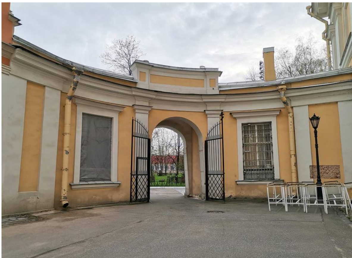
Фото 09. ОКН федерального значения «Собор Троицкий с двумя соединительными корпусами». Южный соединительный корпус. Фрагмент. Съёмка 28.04.2021 г.
