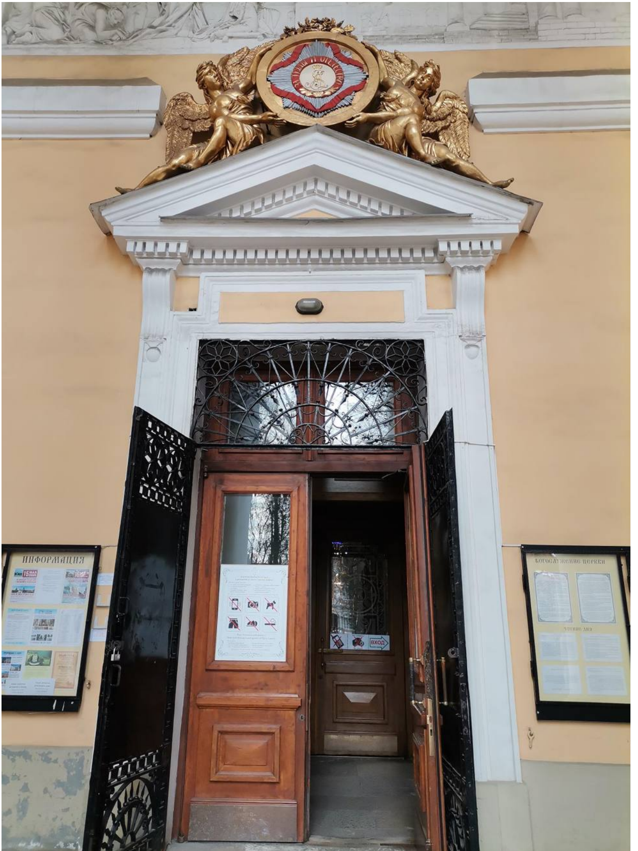
Фото 45. ОКН федерального значения «Собор Троицкий с двумя соединительными корпусами». Западный фасад. Фрагмент. Оформление входного проёма. Съёмка 28.04.2021 г.
