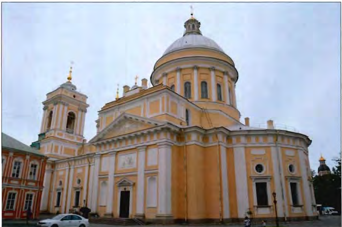
2. Общий вид с юго-востока.
