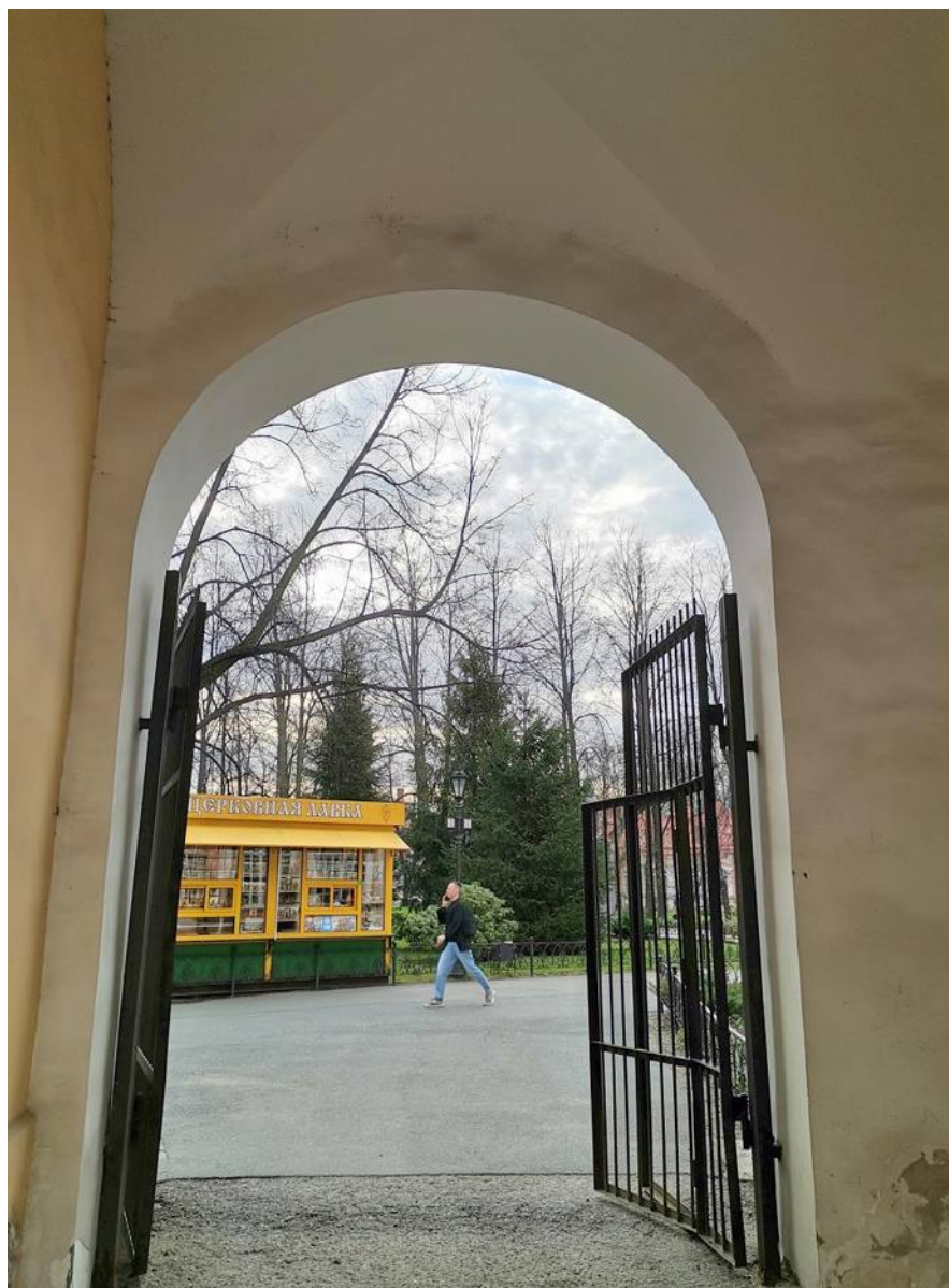
Фото 34. ОКН федерального значения «Собор Троицкий с двумя соединительными корпусами». Северный соединительный корпус. Фрагмент. Съёмка 28.04.2021 г.
