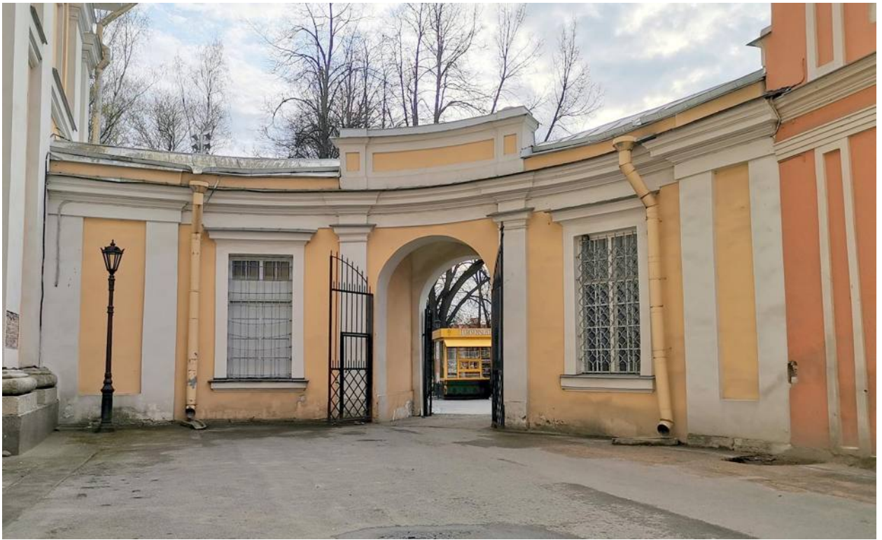
Фото 31. ОКН федерального значения «Собор Троицкий с двумя соединительными корпусами». Северный соединительный корпус. Общий вид. Съёмка 28.04.2021 г.
