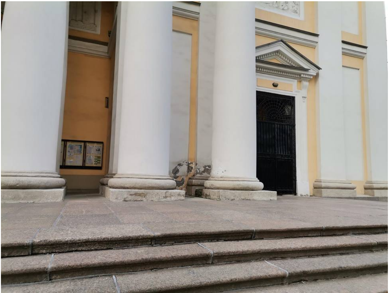
Фото 40. ОКН федерального значения «Собор Троицкий с двумя соединительными корпусами». Западный фасад. Фрагмент. Съёмка 28.04.2021 г.
