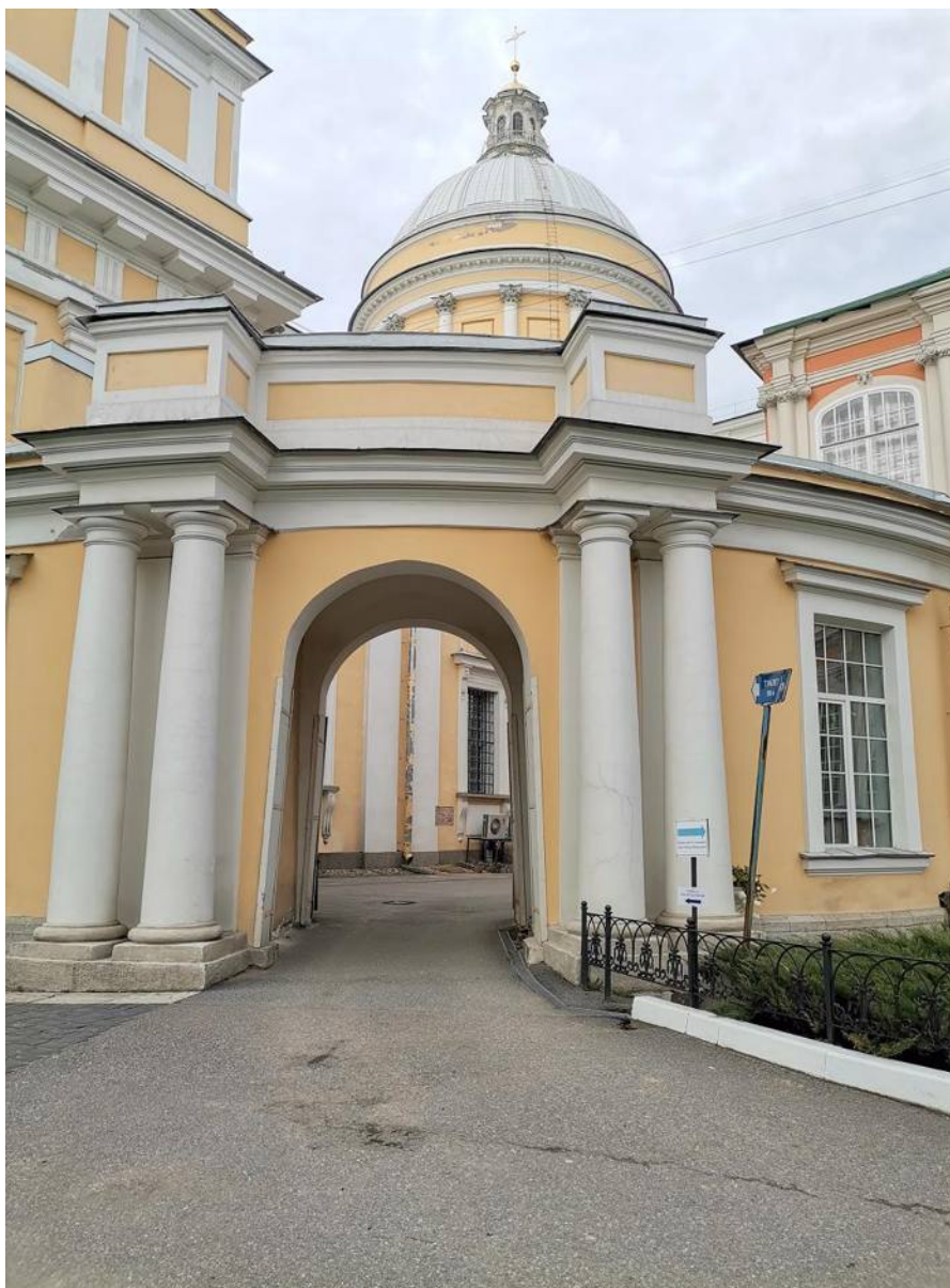
Фото 05. ОКН федерального значения «Собор Троицкий с двумя соединительными корпусами». Южный соединительный корпус. Фрагмент. Съёмка 28.04.2021 г.
