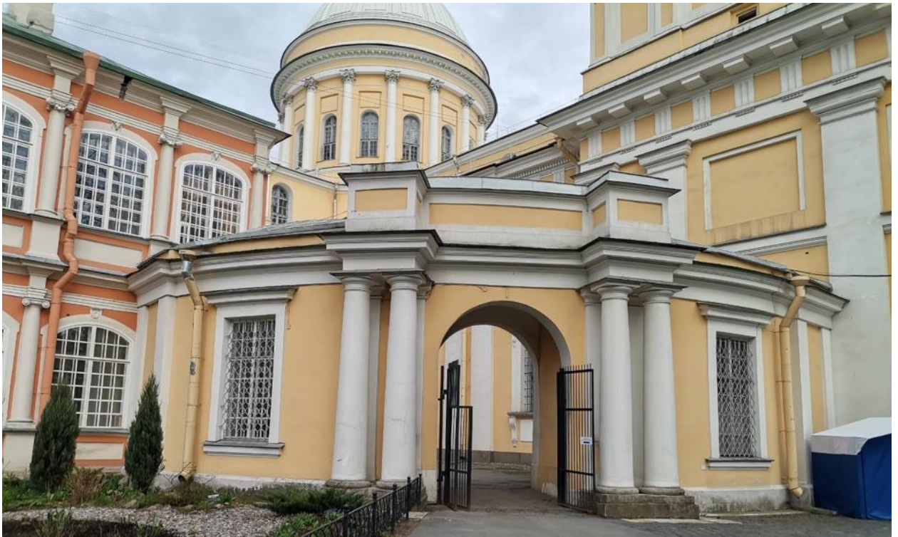
Фото 35. ОКН федерального значения «Собор Троицкий с двумя соединительными корпусами». Северный соединительный корпус. Общий вид. Съёмка 28.04.2021 г.
