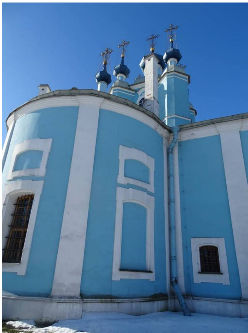
Илл. 23. Фрагмент восточного фасада Собора. Съемка 05.02.21 г. Трушковский В.Э.
