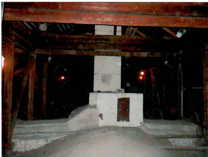
32. «Собор». Стропильная система. Фрагмент.
