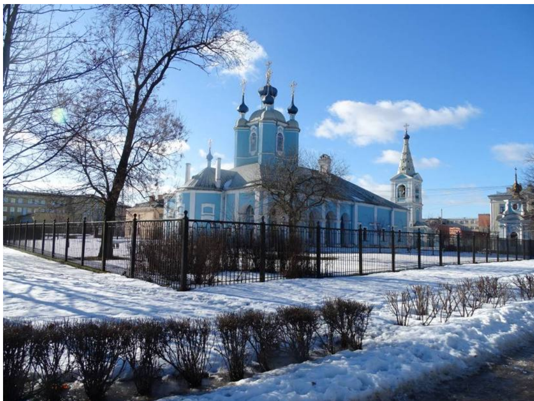
Илл. 03. Вид на северный фасад Собора. Съемка 05.02.21 г. Трушковский В.Э.
