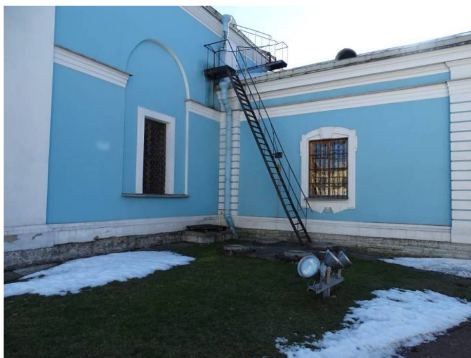
Илл. 24. Фрагмент западного и северного фасадов Собора. Съемка 05.02.21 г. Трушковский В.Э.
