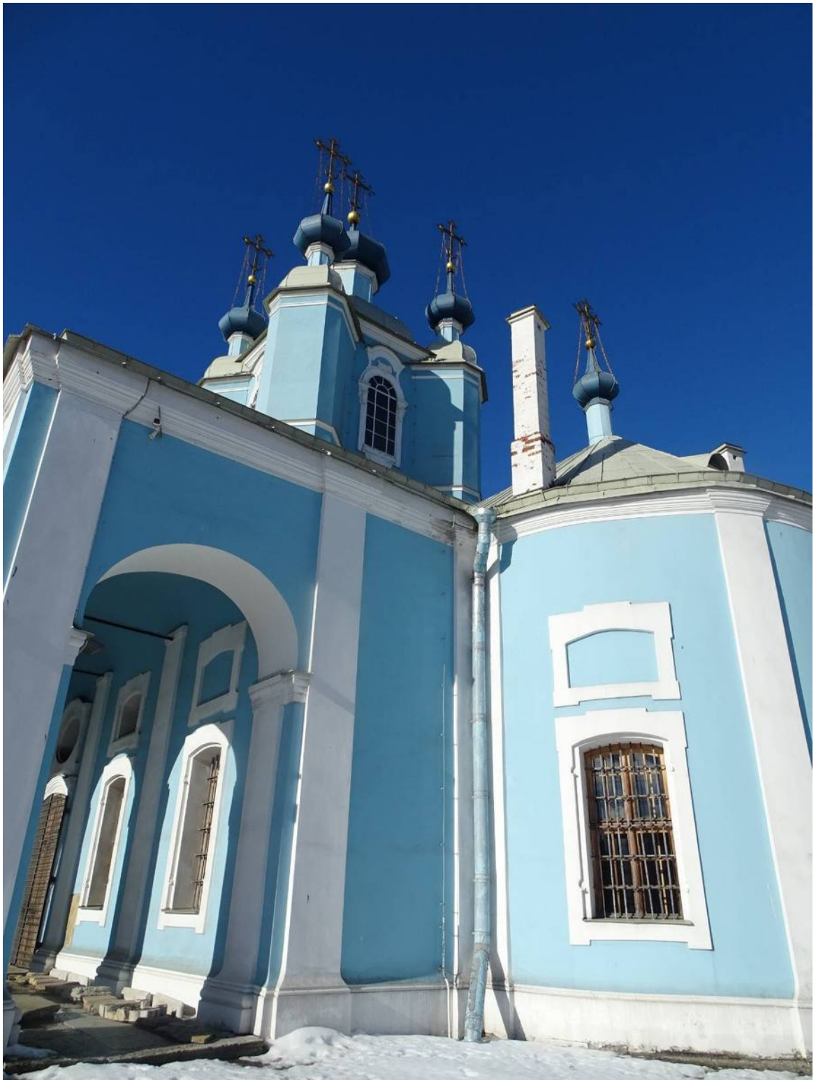
Илл. 22. Фрагмент восточного фасада Собора. Съемка 05.02.21 г. Трушковский В.Э.
