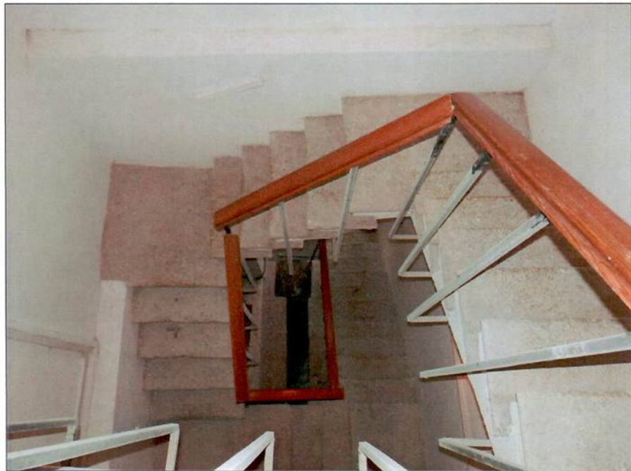
3. «Колокольня». Лестница в уровне первого яруса.
