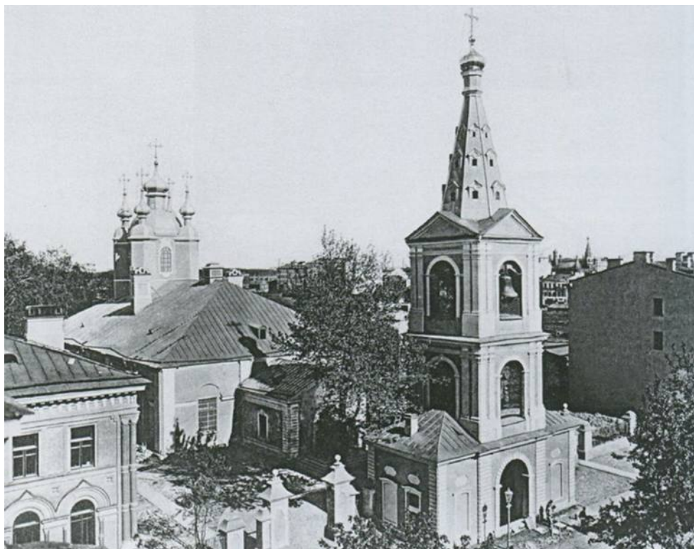
28. Вид колокольни после реставрации 1909 года. Колокола по-прежнему в арках. // https://www.mishanita.ru/2015/12/04/26562/
