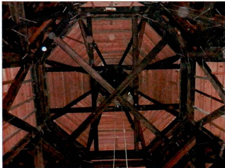
31. «Собор». Стропильная система. Фрагмент.
