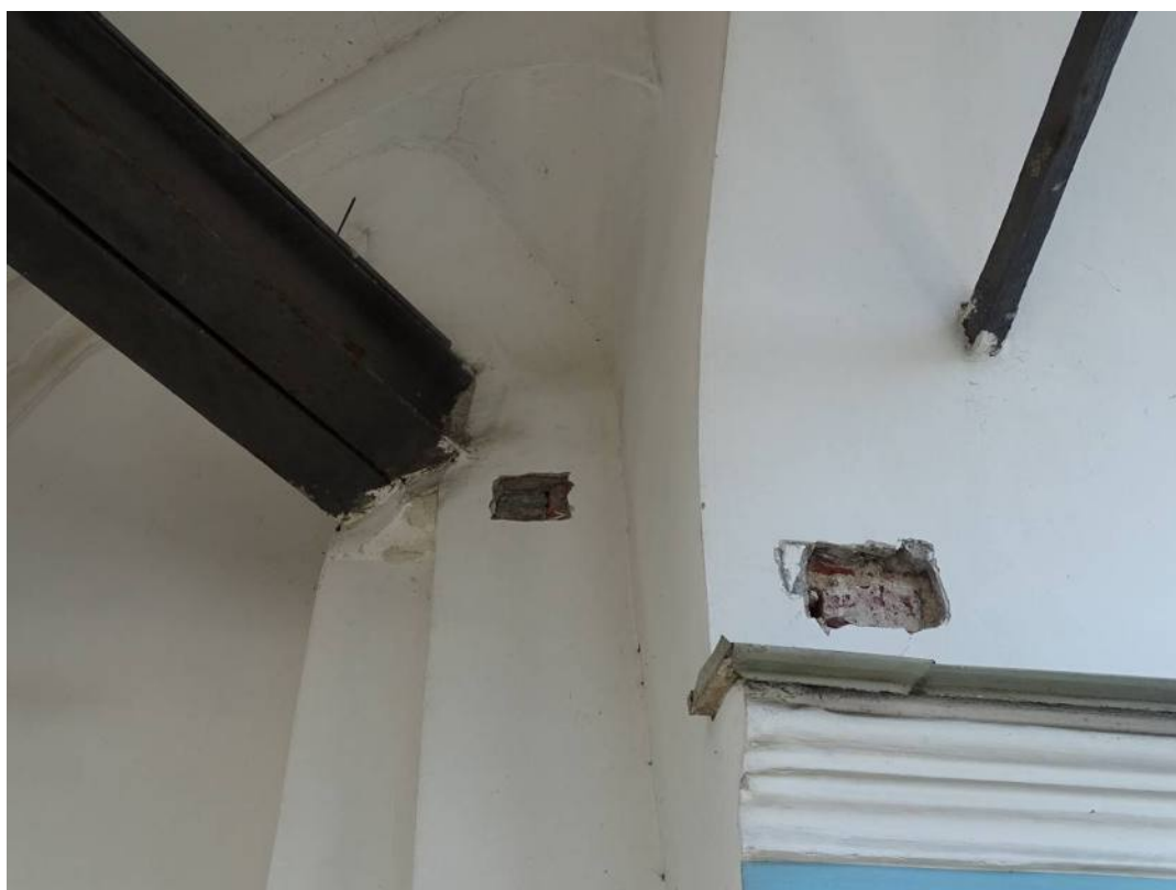
Илл. 29. Место опирания балок для подвешивания колоколов. Съёмка 05.02.21 г. Трушковский В.Э.
