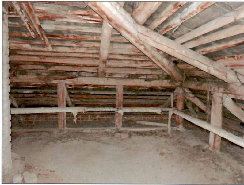
49. «Юбилейный домик». Стропильная система.
