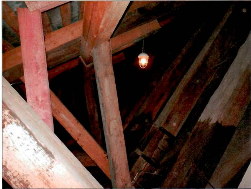
30. «Собор». Стропильная система. Фрагмент.
