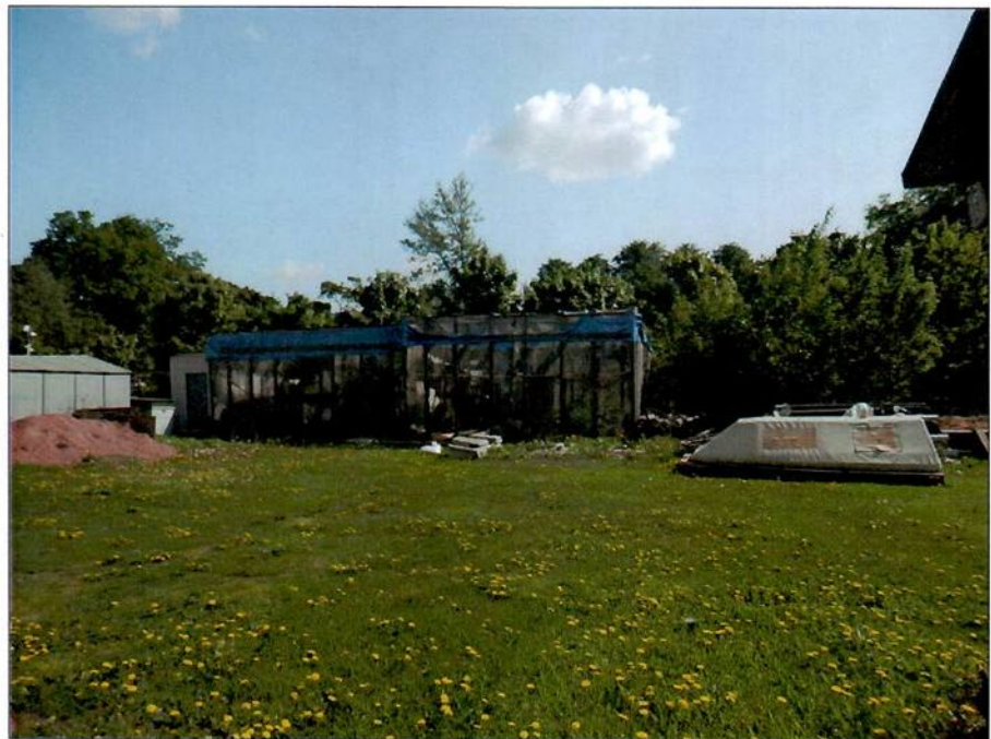
20. Территория объекта культурного наследия восточнее «Юбилейного домика».
