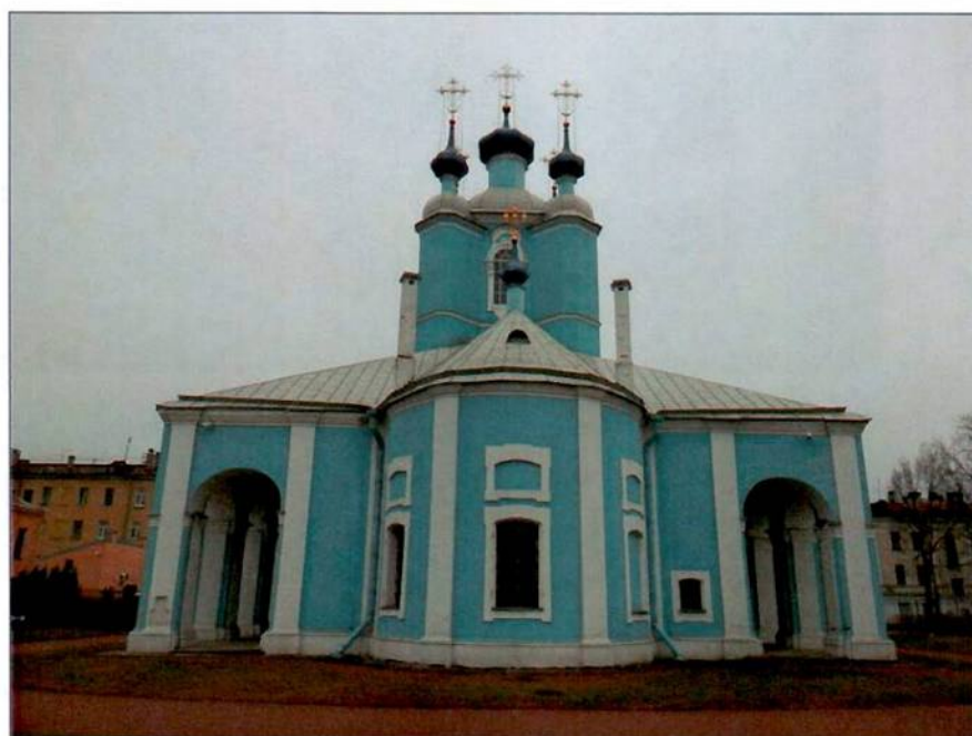
23. «Собор». Восточный фасад.
