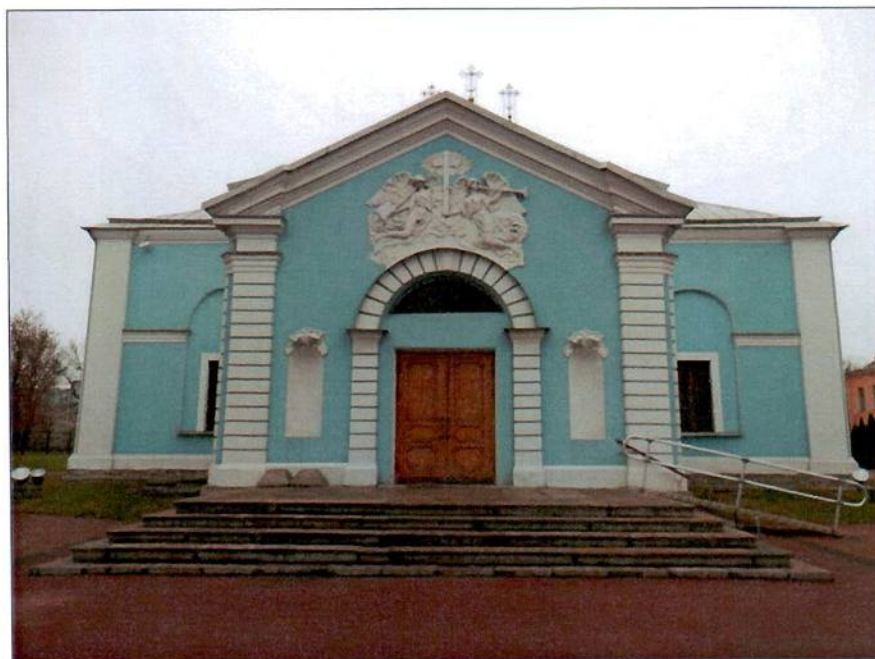
25. «Собор». Западный фасад. Притвор.
