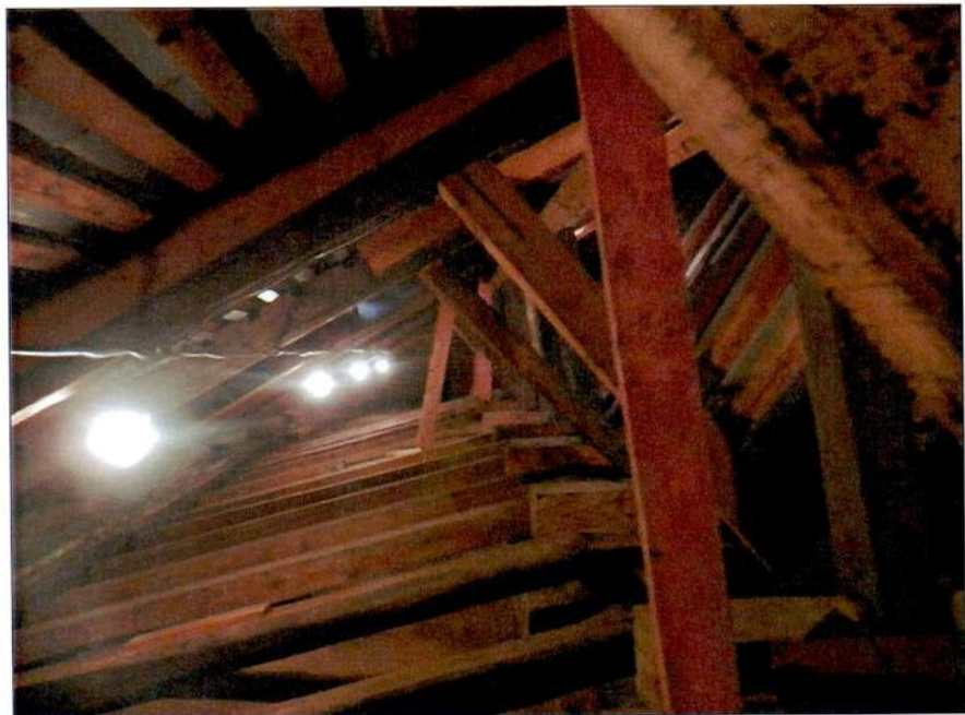
29. «Собор». Стропильная система. Фрагмент.
