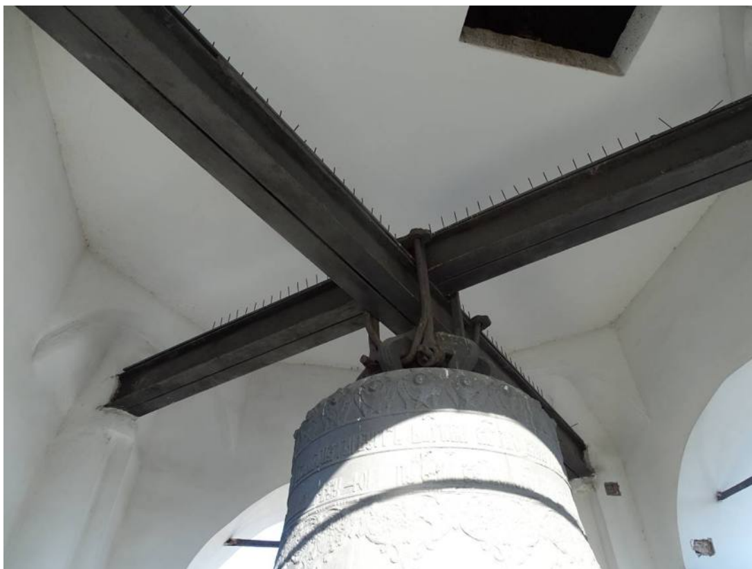
Илл. 30. Места опирания балок для подвешивания колоколов. Съемка 05.02.21 г. Трушковский В.Э.
