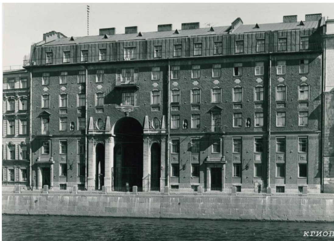
43. Фасад Толстовского дома по набережной Фонтанки. Фото А.Григорьева из архива КГИОП. 1971г.
