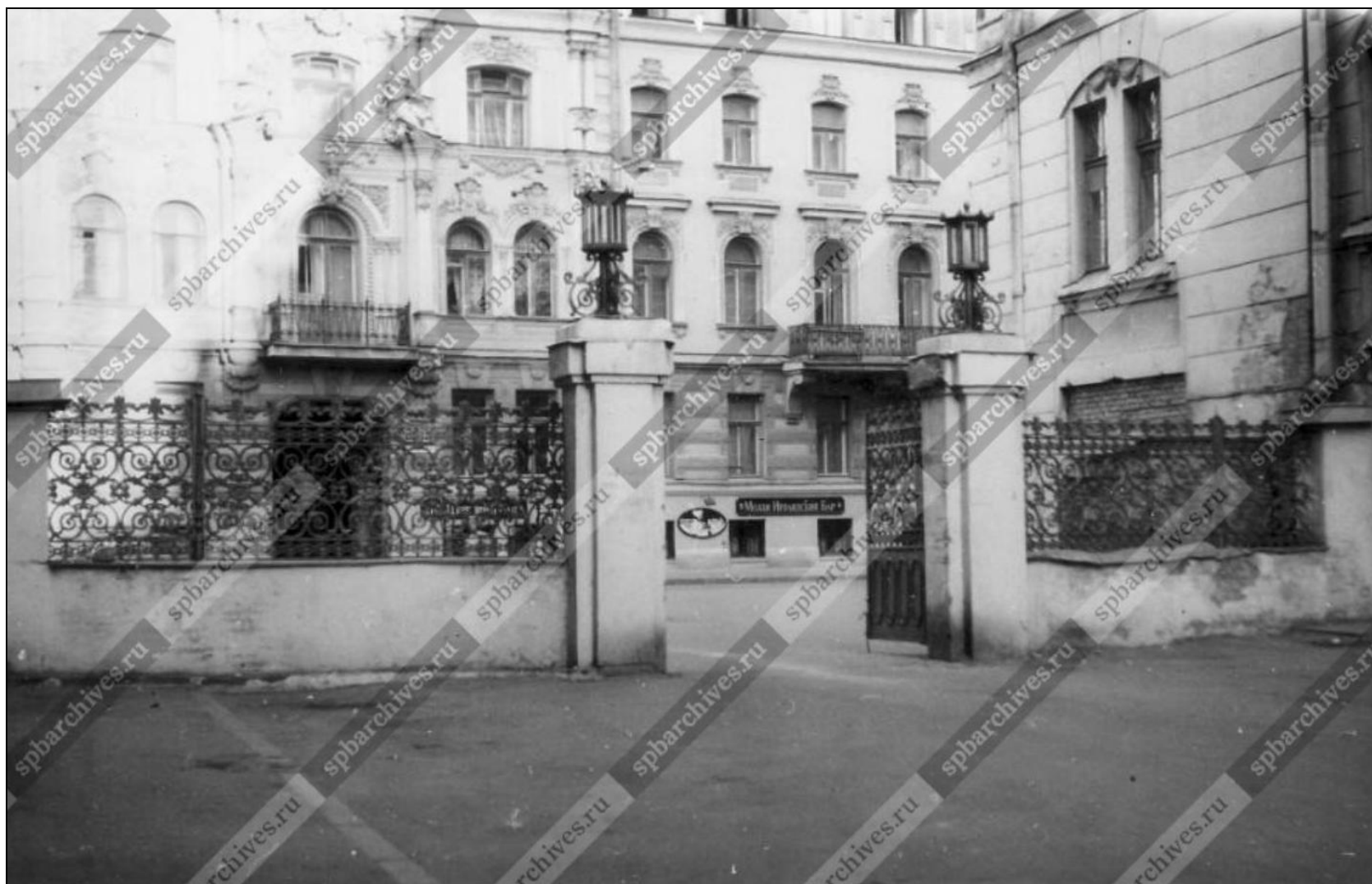
Илл. 28. Вид ограды ворот дома № 23 по улице Рубинштейна со стороны курдонера (бывший дом Петербургской купеческой управы).
