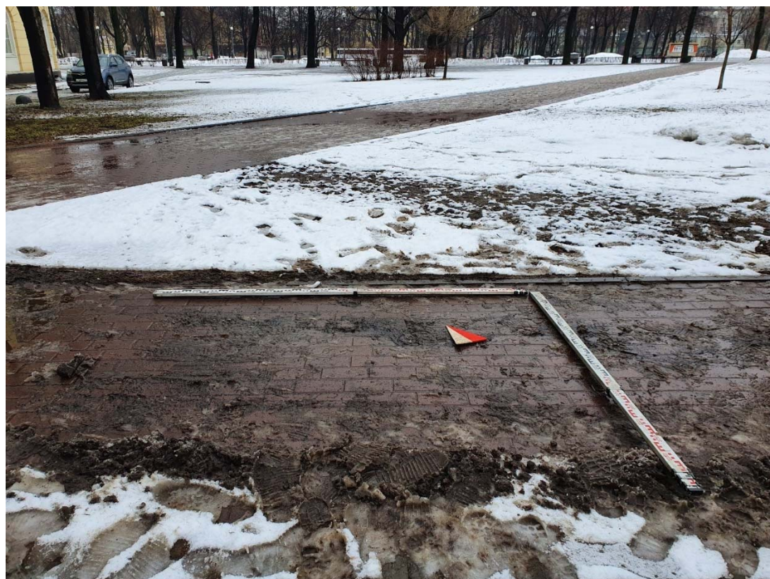
Рис.89. Санкт-Петербург, Адмиралтейский район, Сквер у Театра юных зрителей. Шурф 3. Общий вид до начала работ. Вид на север
