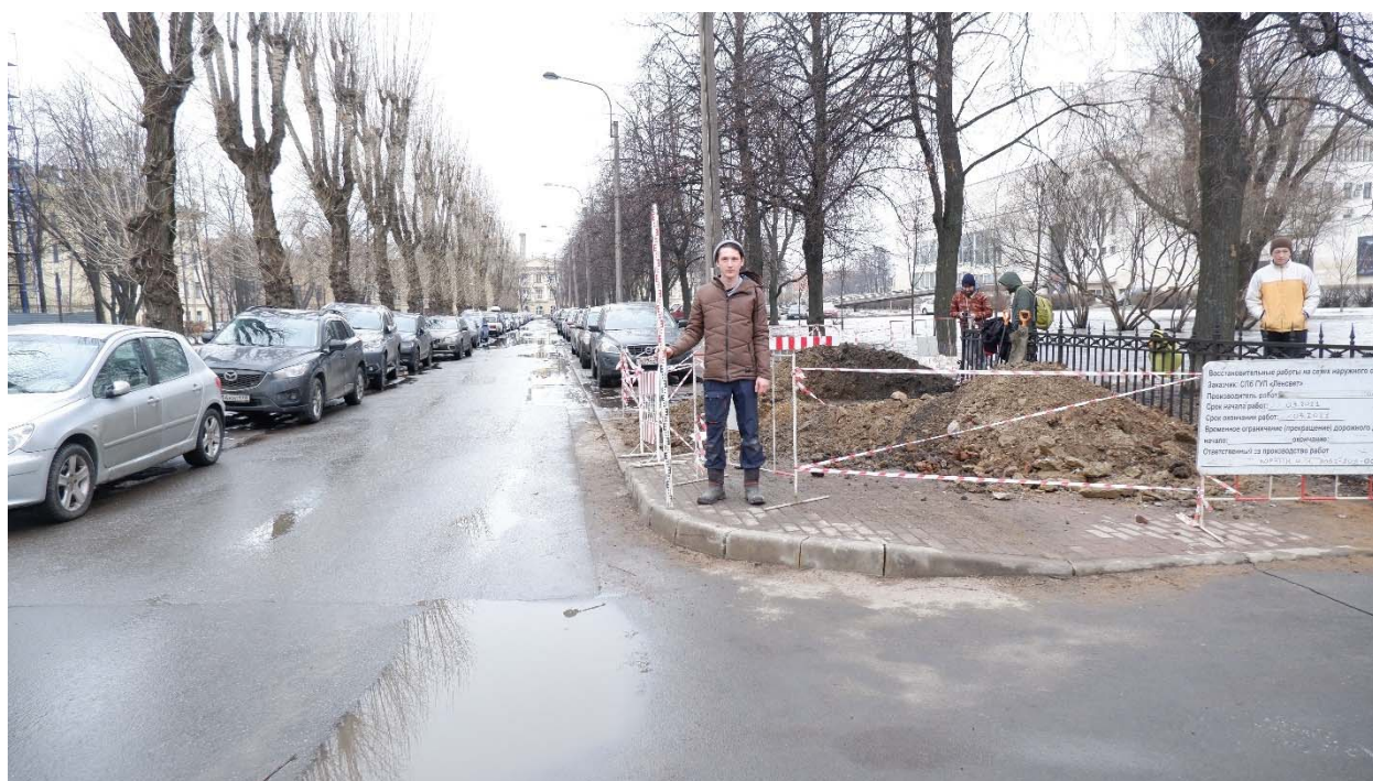
Рис.53. Санкт-Петербург, Адмиралтейский район, Сквер у Театра юных зрителей. Общий вид участка обследования. Точка съемки 35. Вид на север
