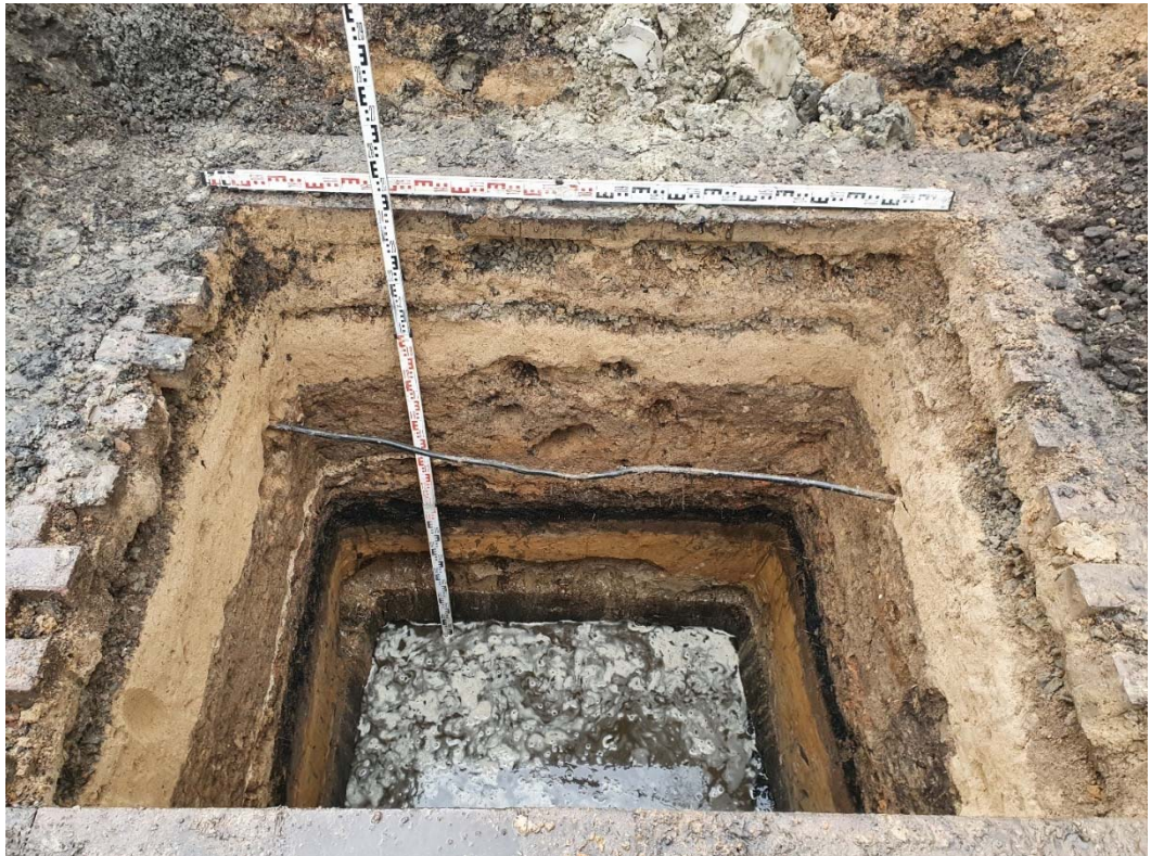
Рис.96. Санкт-Петербург, Адмиралтейский район, Сквер у Театра юных зрителей. Шурф 3. Фиксация по уровню материковой поверхности, затопленной грунтовыми водами. Вид на запад
