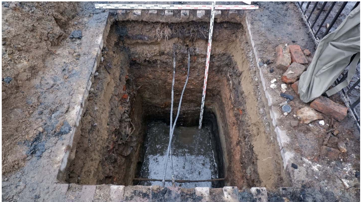
Рис.105. Санкт-Петербург, Адмиралтейский район, Сквер у Театра юных зрителей. Шурф 4. Фиксация по уровню грунтовых вод. Вид на юг
