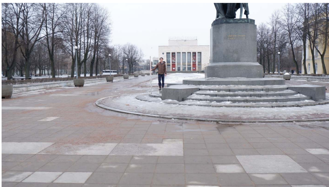
Рис.37. Санкт-Петербург, Адмиралтейский район, Сквер у Театра юных зрителей. Общий вид участка обследования. Точка съемки 19. Вид на юг
