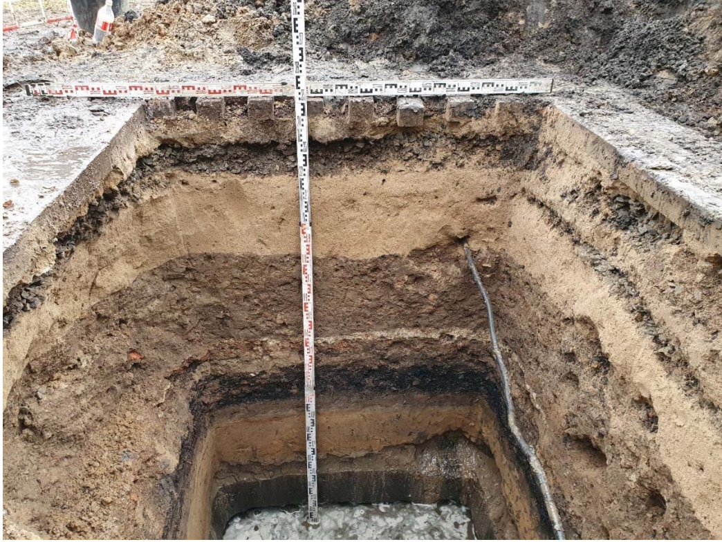
Рис.99. Санкт-Петербург, Адмиралтейский район, Сквер у Театра юных зрителей. Шурф 3. Южная стенка
