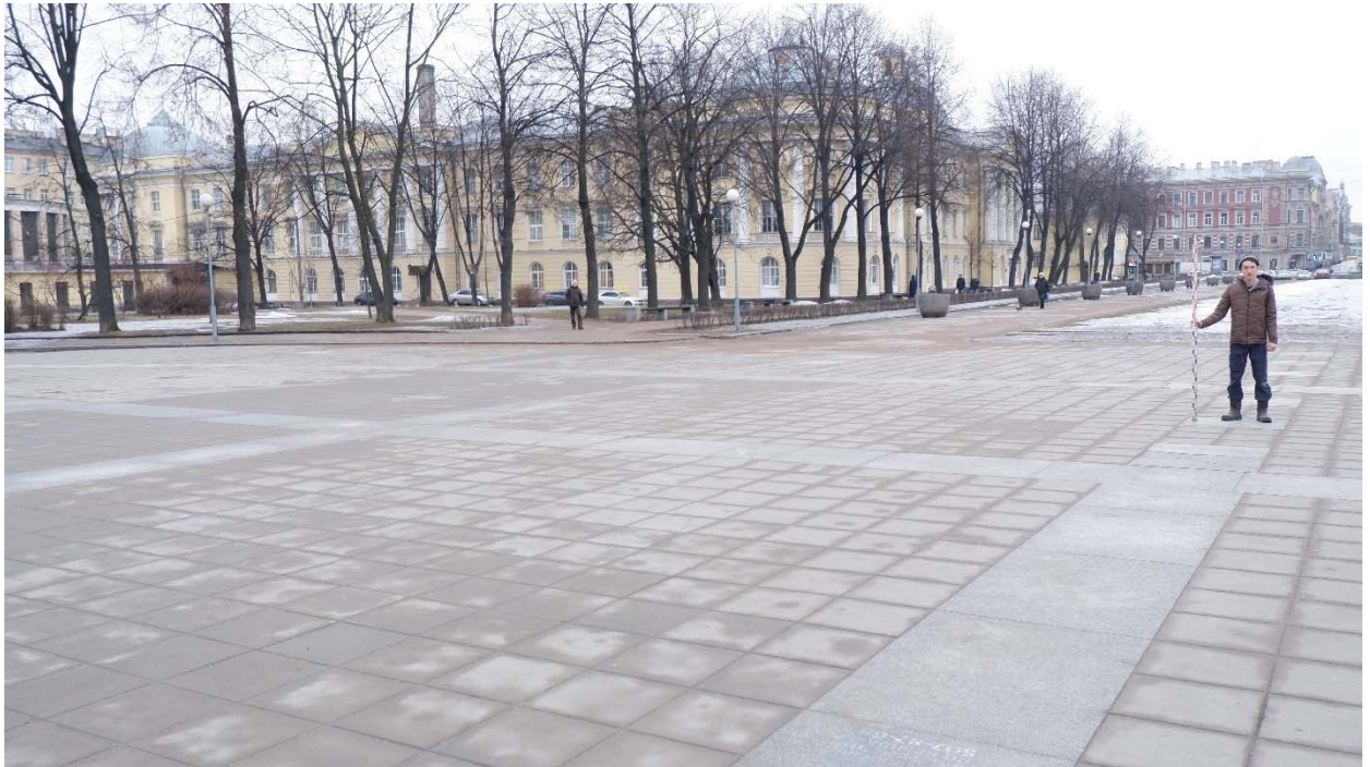
Рис.42. Санкт-Петербург, Адмиралтейский район, Сквер у Театра юных зрителей. Общий вид участка обследования. Точка съемки 24. Вид на север
