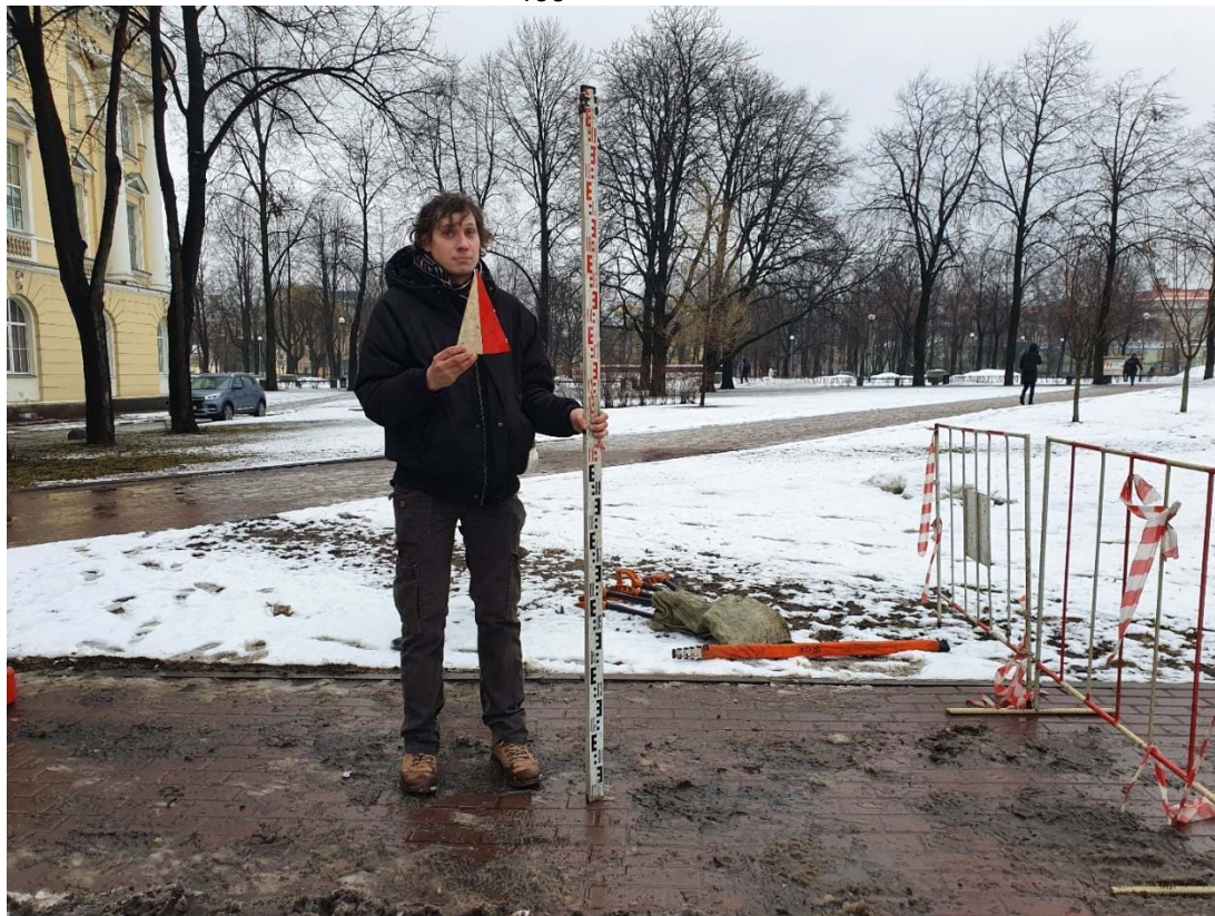
Рис.88. Санкт-Петербург, Адмиралтейский район, Сквер у Театра юных зрителей. Шурф 3. Общий вид до начала работ. Вид на север
