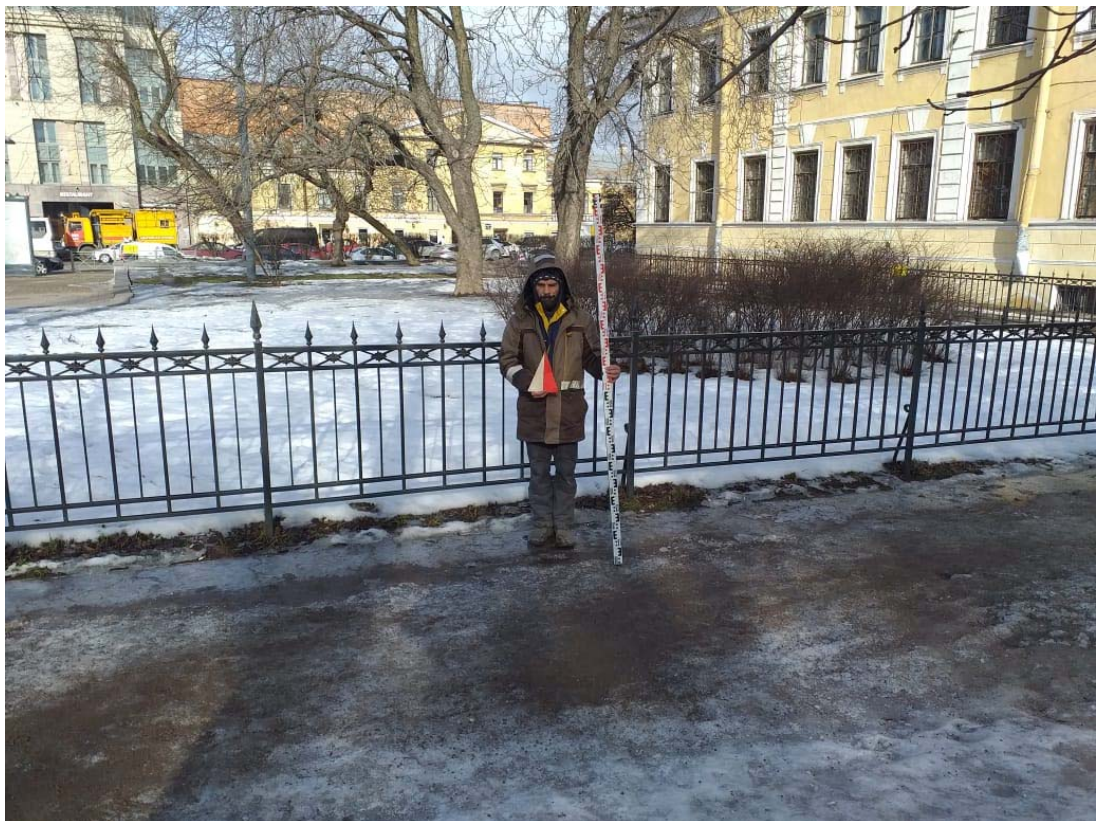
Рис.71. Санкт-Петербург, Адмиралтейский район, Сквер у Театра юных зрителей. Шурф 2. Общий вид до начала работ. Вид на север
