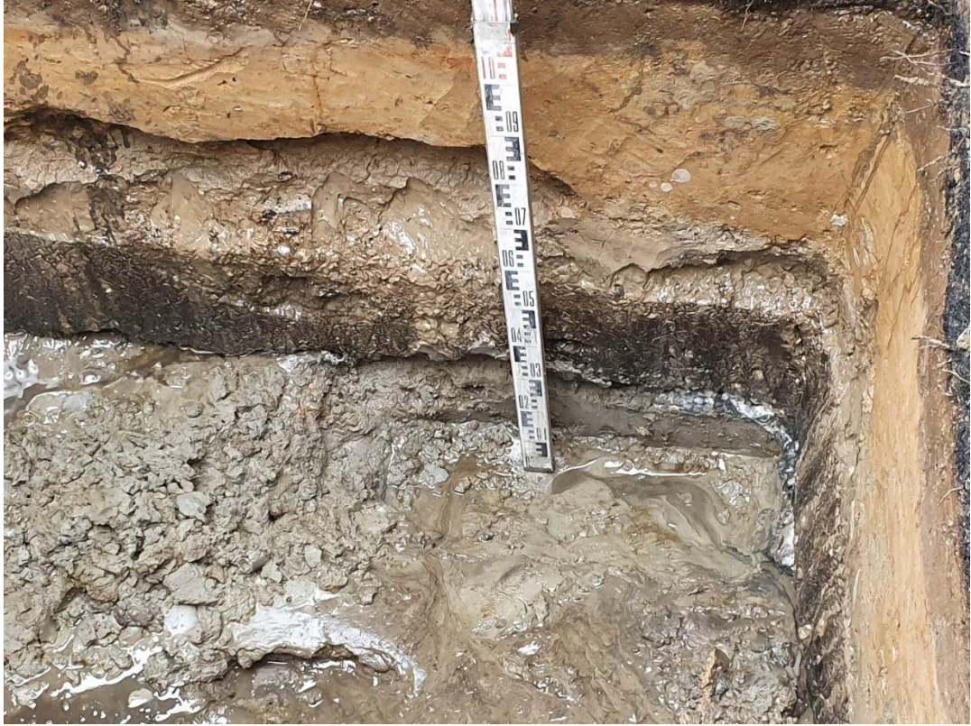
Рис.95. Санкт-Петербург, Адмиралтейский район, Сквер у Театра юных зрителей. Шурф 3. Фиксация по уровню материковой поверхности. Контрольный прокоп материка. Вид на запад
