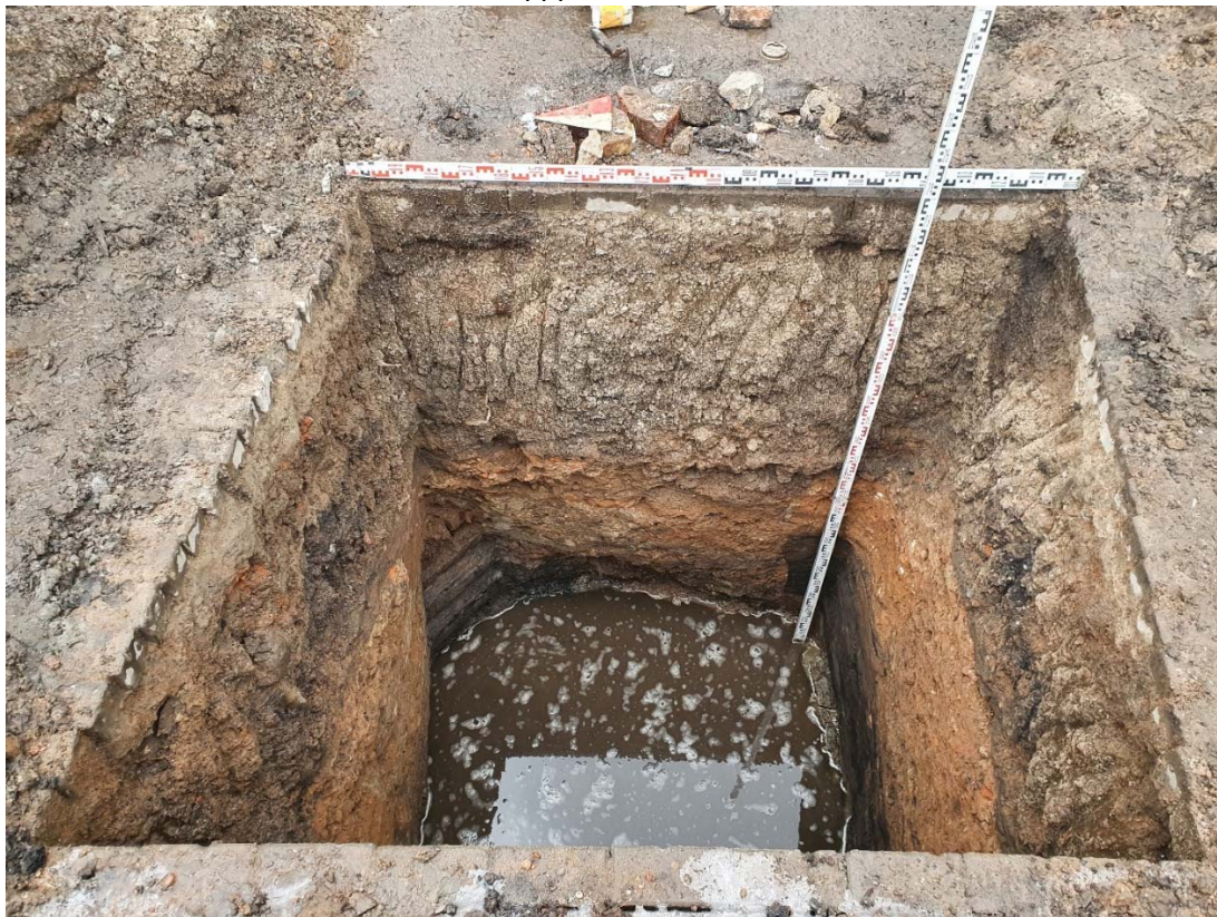
Рис.60. Санкт-Петербург, Адмиралтейский район, Сквер у Театра юных зрителей. Шурф 1. Промежуточная фиксация 4. Вид на восток
