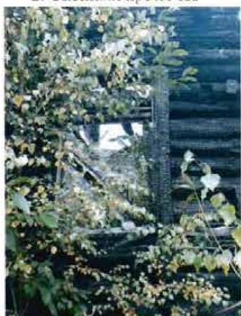
2. Оконный проем 1Н
