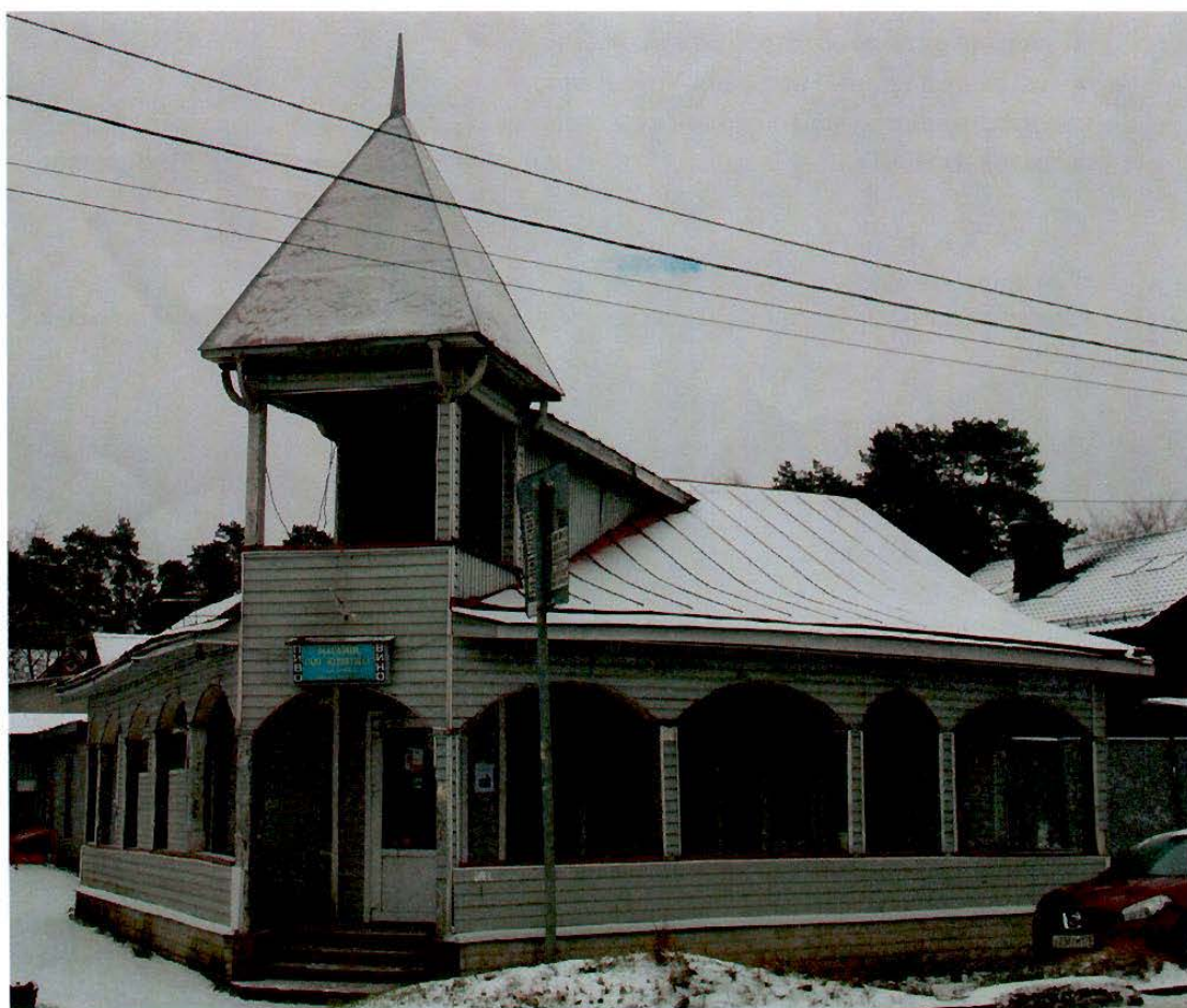
1. Северный и западный фасады
