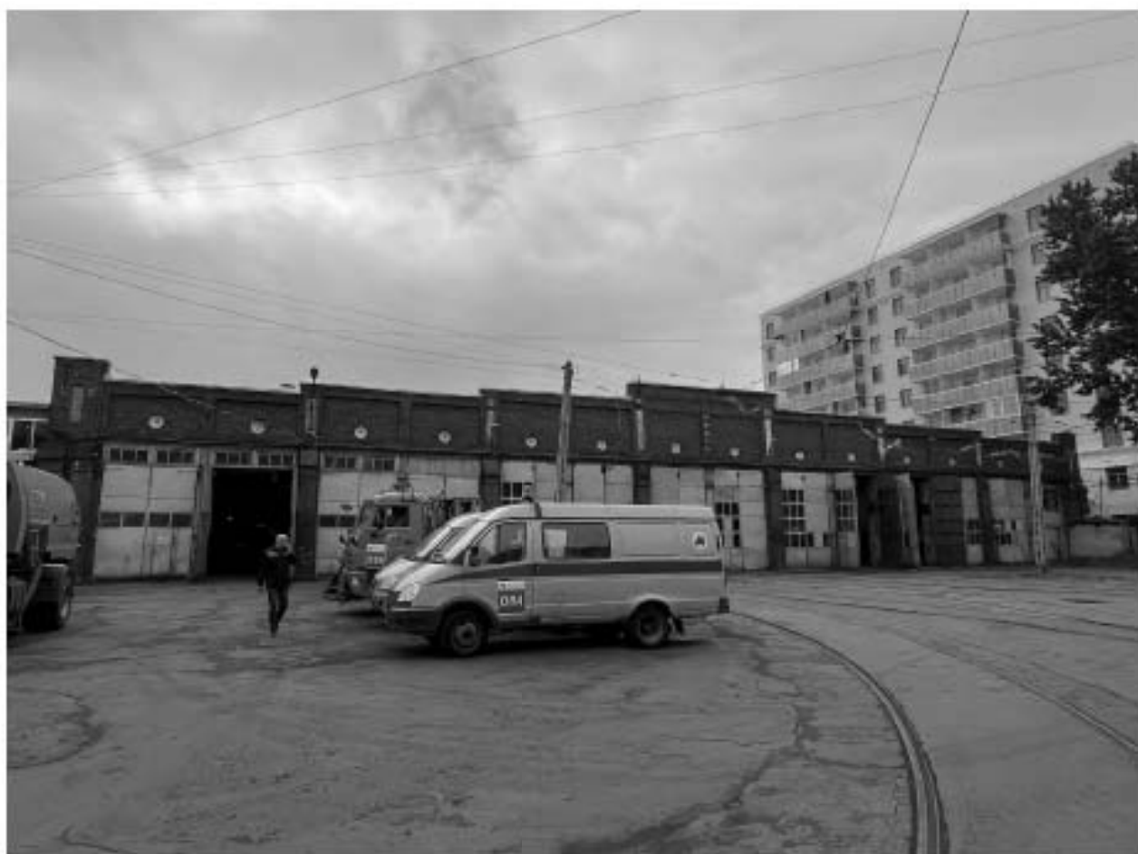
Фото №11. Выявленный объект культурного наследия «Депо Конно-железной дороги и комплекс трампарка (4 здания)». Здание по адресу: г. Санкт-Петербург, Большая Посадская улица, дом 24/2, литера П. Северо-западный фасад.
