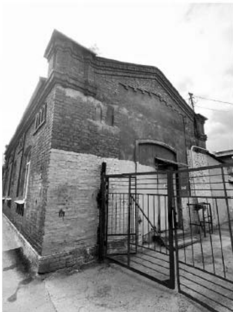
Фото №8. Выявленный объект культурного наследия «Депо Конно-железной дороги и комплекс трампарка (4 здания)». Здание по адресу: г. Санкт-Петербург, Большая Посадская улица, дом 24/2, литера В. Северо-восточный фасад.
