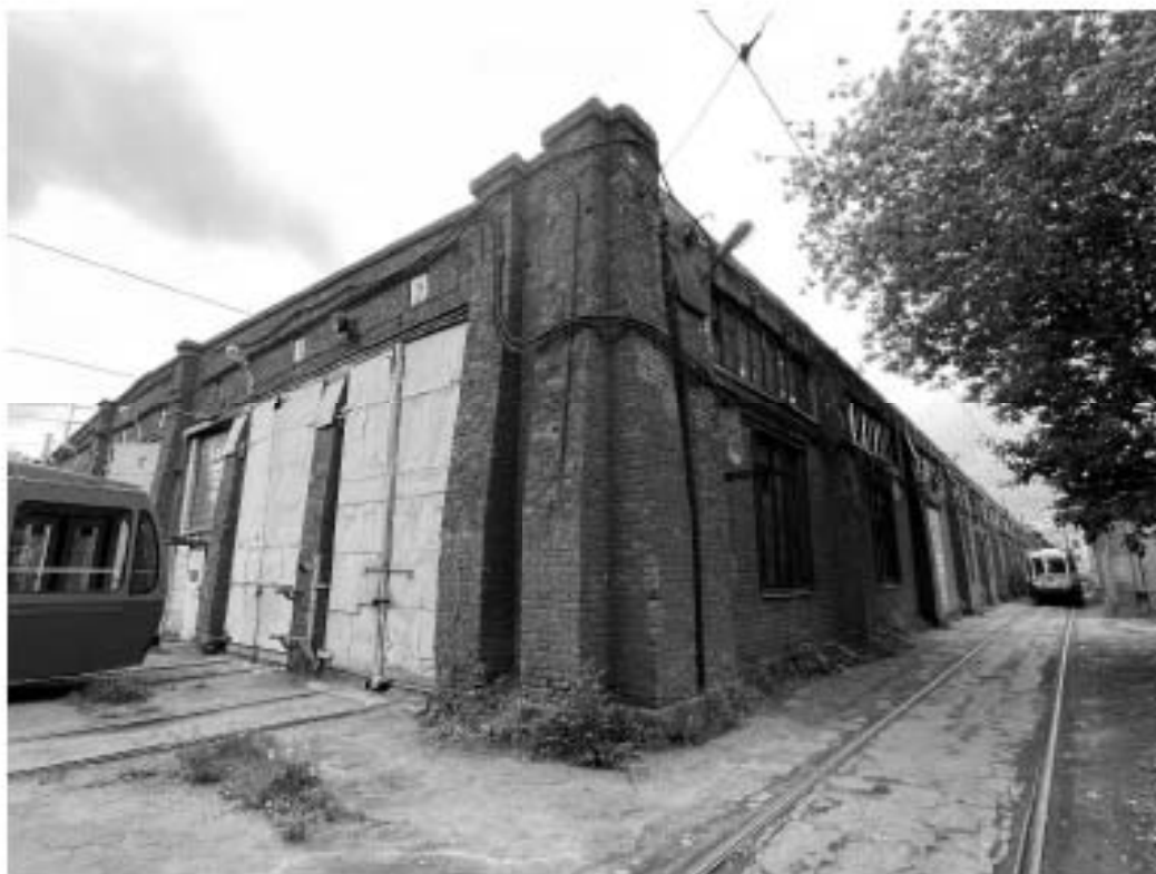
Фото №2. Выявленный объект культурного наследия «Депо Конно-железной дороги и комплекс трампарка (4 здания)». Здание по адресу: г. Санкт-Петербург, Большая Посадская улица, дом 24/2, литера П. Здание депо, угол юго-западного и юго-восточного фасадов.
