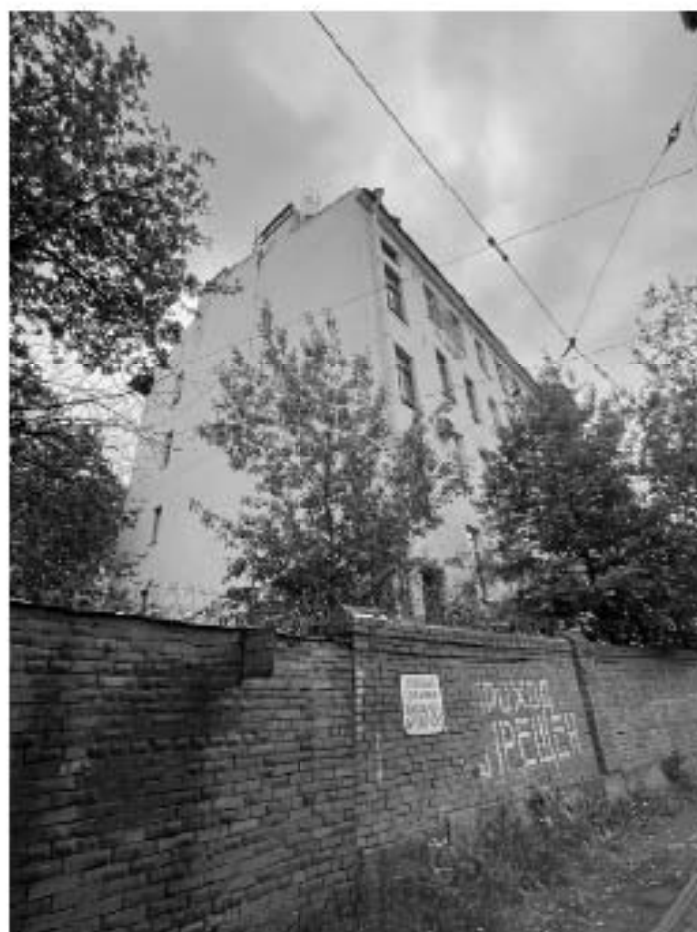
Фото №18. Выявленный объект культурного наследия «Дом Н.П. Зайцева» по адресу: г. Санкт-Петербург, Большая Посадская улица, дом 18/7, литера А. Угол северо- западного и северо-восточного фасадов.
