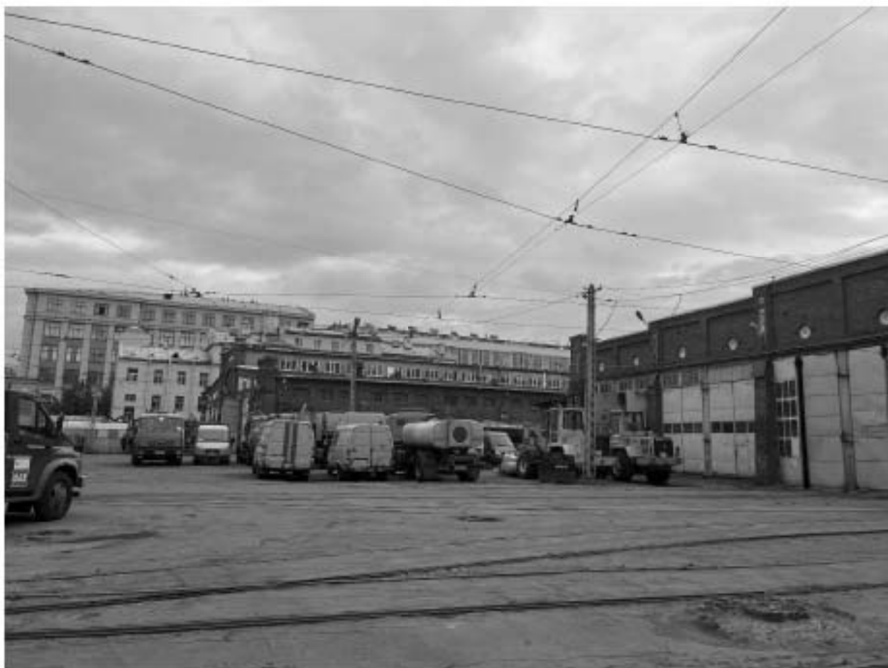
Фото №12. Выявленный объект культурного наследия «Депо Конно-железной дороги и комплекс трампарка (4 здания)». Здание по адресу: г. Санкт-Петербург, Большая Посадская улица, дом 24/2, литера П, литера С. Общий вид территории.
