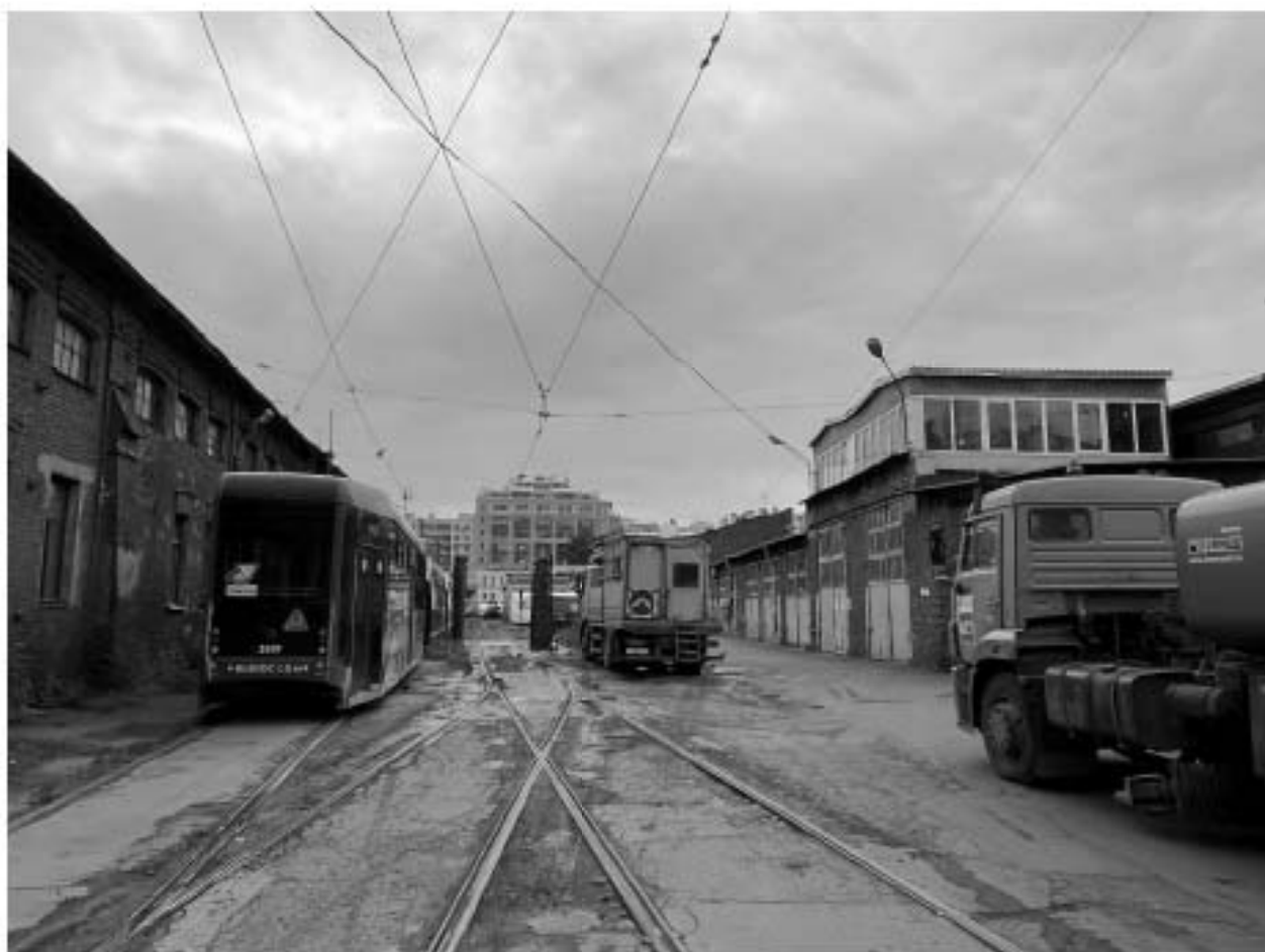
Фото №13. Выявленный объект культурного наследия «Депо Конно-железной дороги и комплекс трампарка (4 здания)». Здание по адресу: г. Санкт-Петербург, Большая Посадская улица, дом 24/2, литера П, литера С. Общий вид территории.
