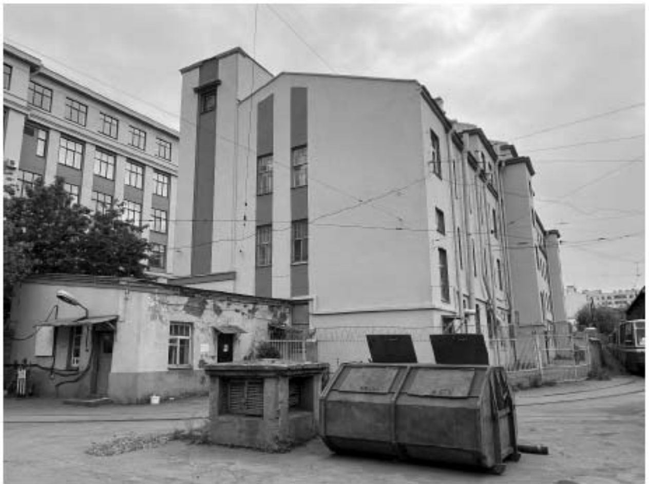
Фото №6. Выявленный объект культурного наследия «Депо Конно-железной дороги и комплекс трампарка (4 здания)». Здание по адресу: г. Санкт-Петербург, Большая Посадская улица, дом 24/2, литера А. Северо-восточный фасад.
