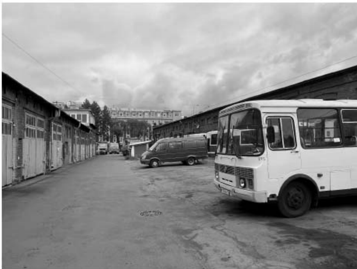
Фото №14. Выявленный объект культурного наследия «Депо Конно-железной дороги и комплекс трампарка (4 здания)». Здание по адресу: г. Санкт-Петербург, Большая Посадская улица, дом 24/2, литера П, литера С. Общий вид территории.
