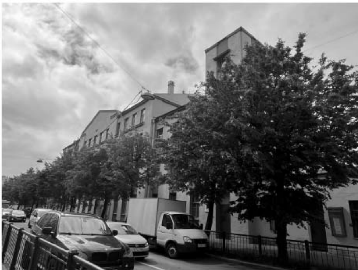
Фото №4. Выявленный объект культурного наследия «Депо Конно-железной дороги и комплекс трампарка (4 здания)». Здание по адресу: г. Санкт-Петербург, Большая Посадская улица, дом 24/2, литера А. Юго-восточный фасад.
