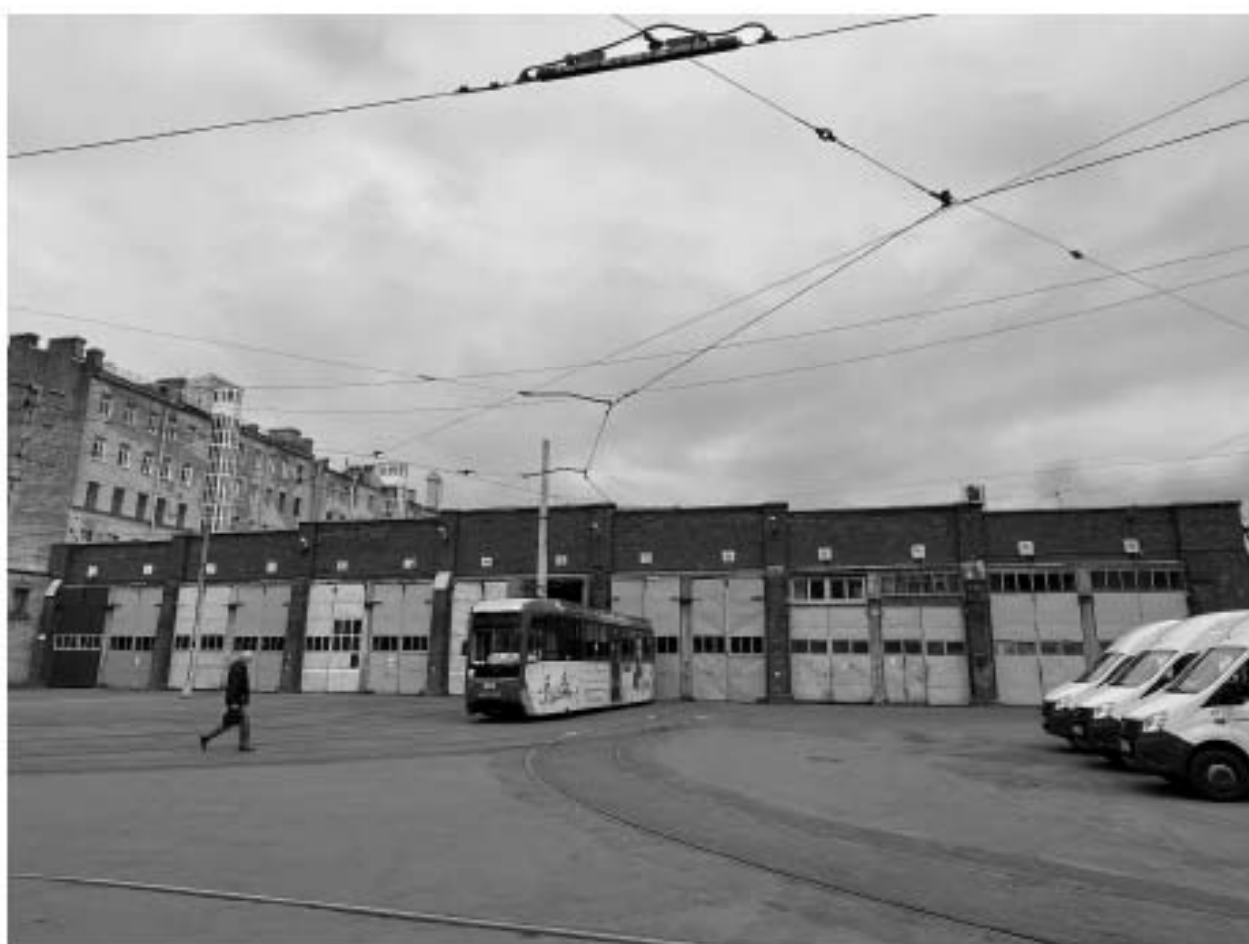
Фото №16. Выявленный объект культурного наследия «Депо Конно-железной дороги и комплекс трампарка (4 здания)». Здание по адресу: г. Санкт-Петербург, Большая Посадская улица, дом 24/2, литера С. Юго-западный фасад.
