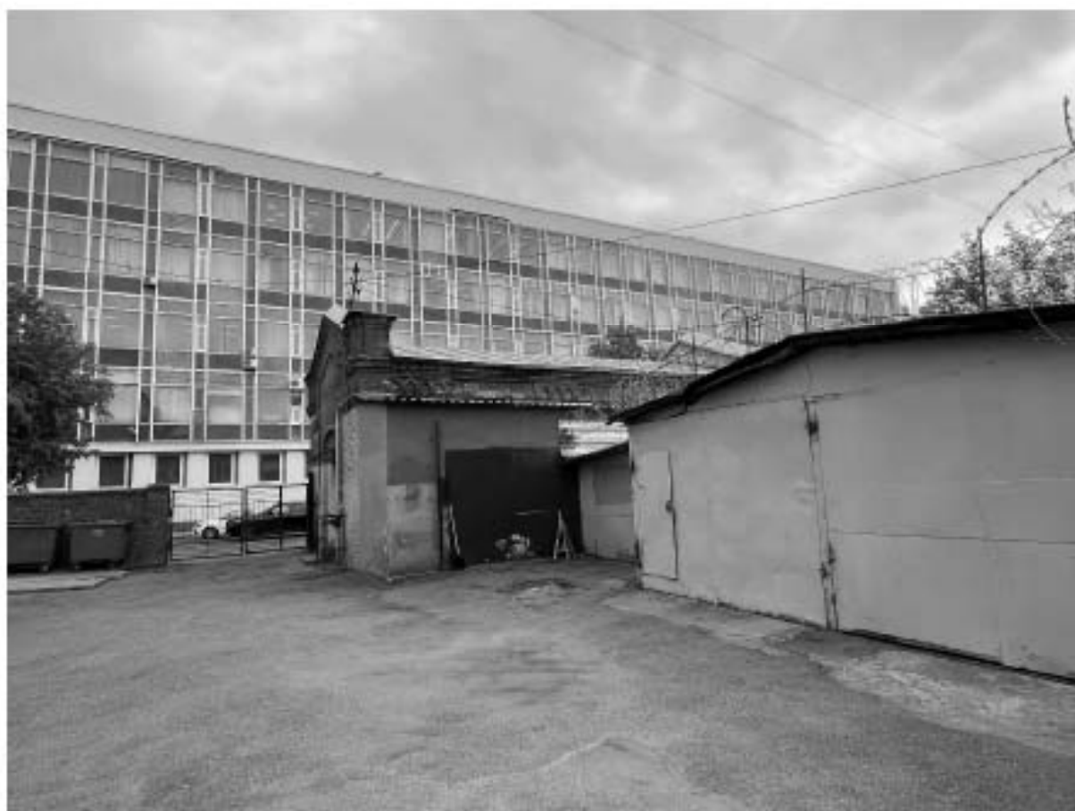
Фото №7. Выявленный объект культурного наследия «Депо Конно-железной дороги и комплекс трампарка (4 здания)». Здание по адресу: г. Санкт-Петербург, Большая Посадская улица, дом 24/2, литера В. Северо-восточный фасад.
