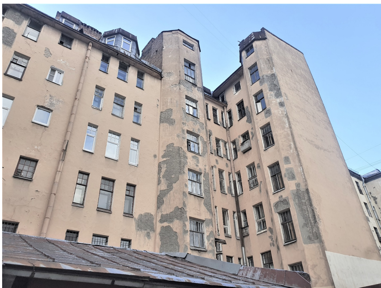
8. Выявленный объект культурного наследия «Дом А.В. Барсовой», по адресу: г. Санкт-Петербург, Заячий пер., д. 6/18, лит. А (Дегтярный пер., 18; Заячий пер., 6). Фрагмент дворового фасада. Дата съемки: 01.03.2022г.
