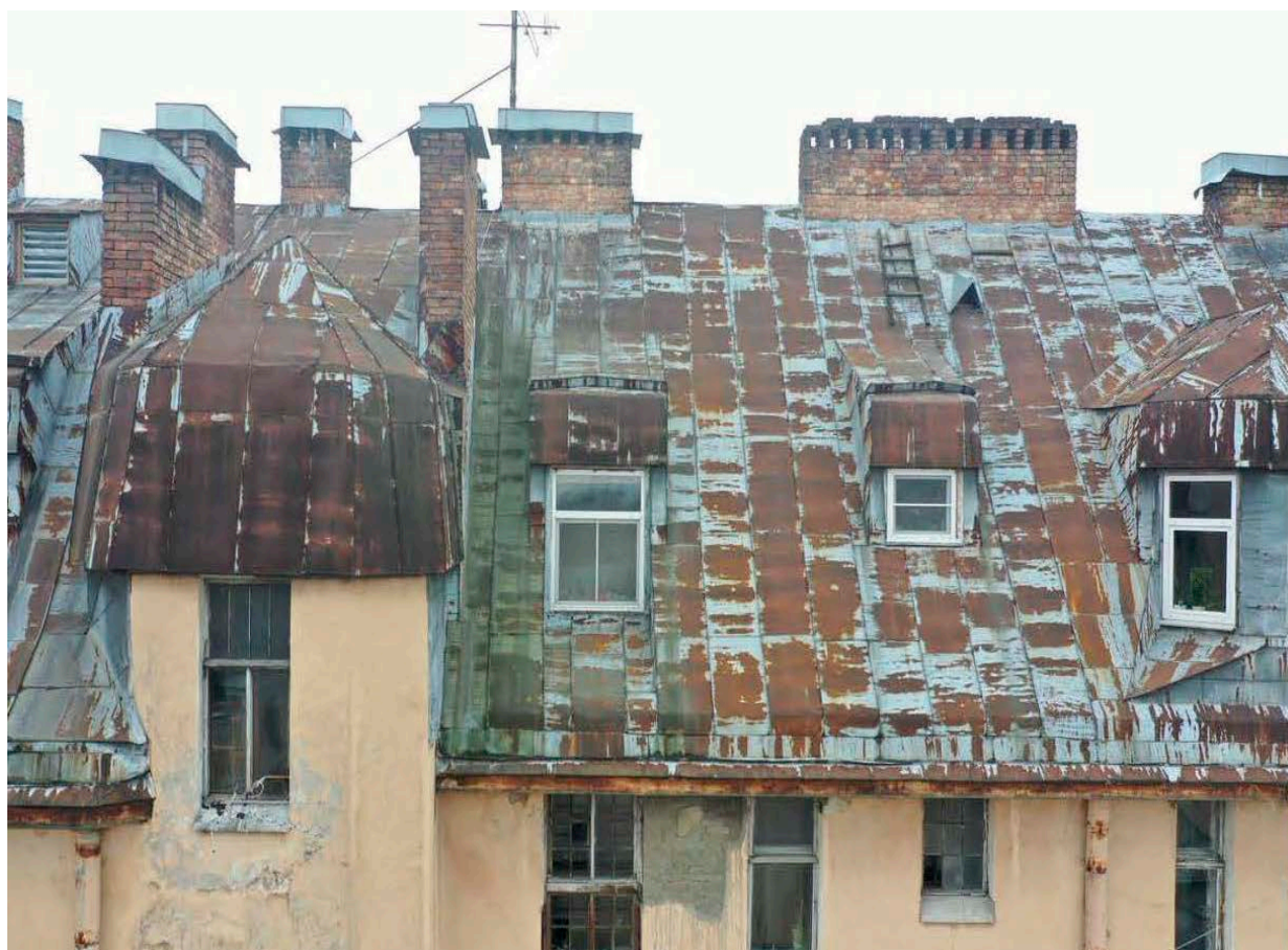
16. Выявленный объект культурного наследия «Дом А.В. Барсовой», по адресу: г. Санкт-Петербург, Заячий пер., д. 6/18, лит. А (Дегтярный пер., 18; Заячий пер., 6). Фрагмент крыши. Дата съемки: 01.03.2022г.
