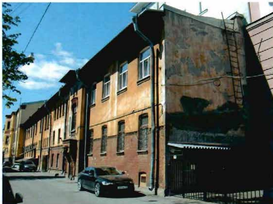
Фото 34. Вид на южный и восточный фасады.
