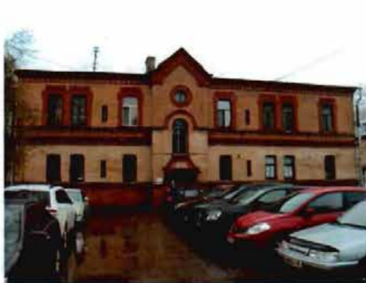
Фото 13. Вид на западный фасад.
