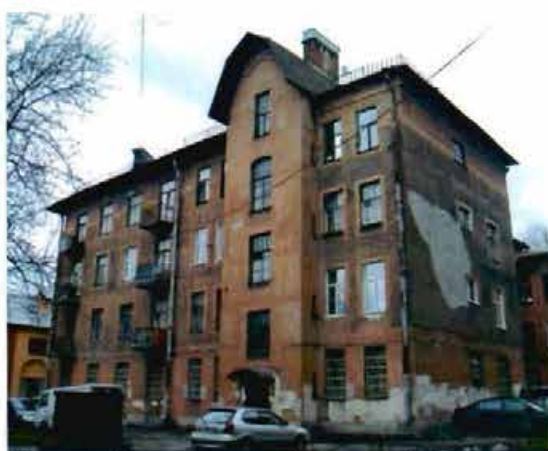
Фото 1. Вид на западный и южный фасады.
