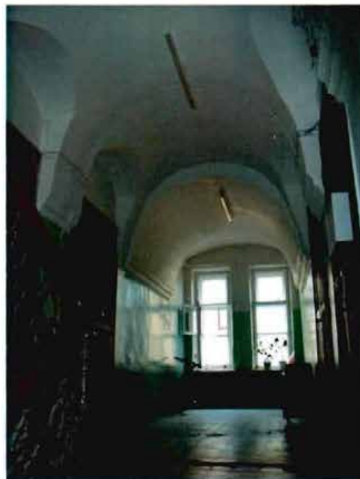
Фото 16. Вестибюль 2-го этажа. Цилиндрические своды с распалубками.
