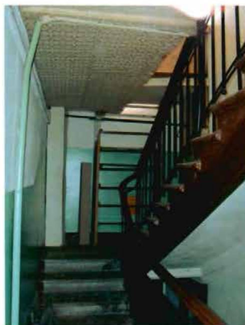
Фото 36. Лестничный объем. Фрагмент.
