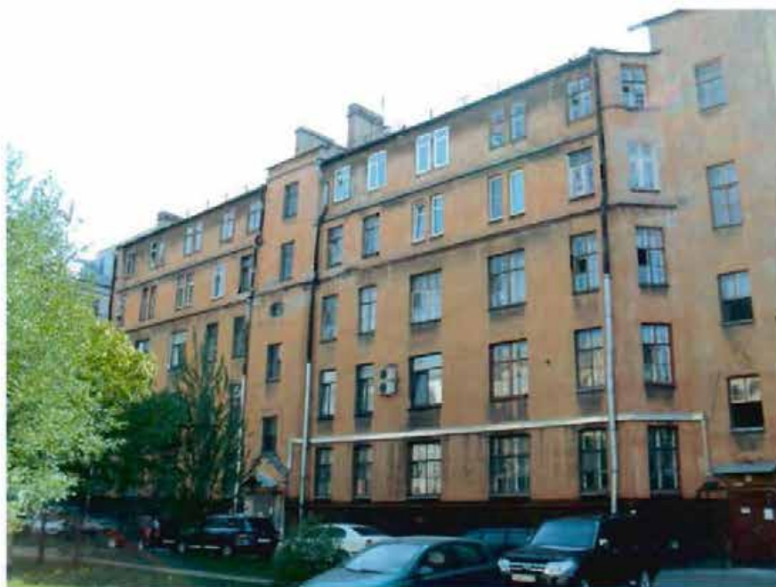
Фото 25. Вид на северный фасад. Фрагмент.
