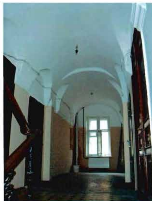
Фото 12. Вестибюль 2-го этажа. Цилиндрические своды с распалубками.
