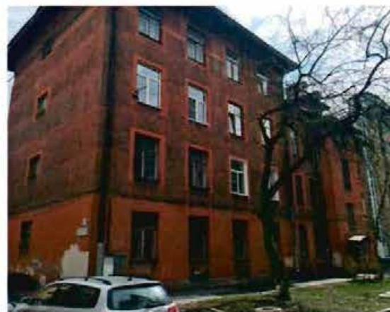
Фото 6. Вид на западный и северный фасады.
