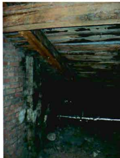
Фото 4. Чердачные помещения. Фрагмент.
