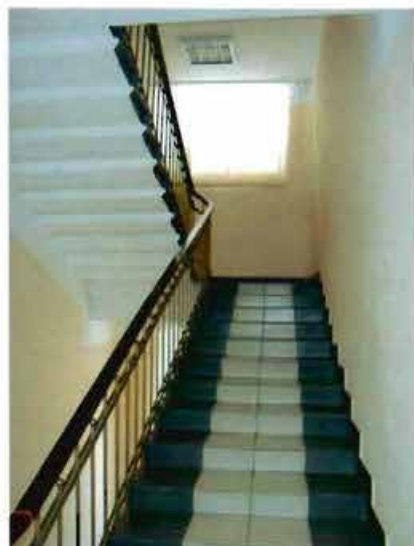
Фото 29. Лестничный объем. Фрагмент.
