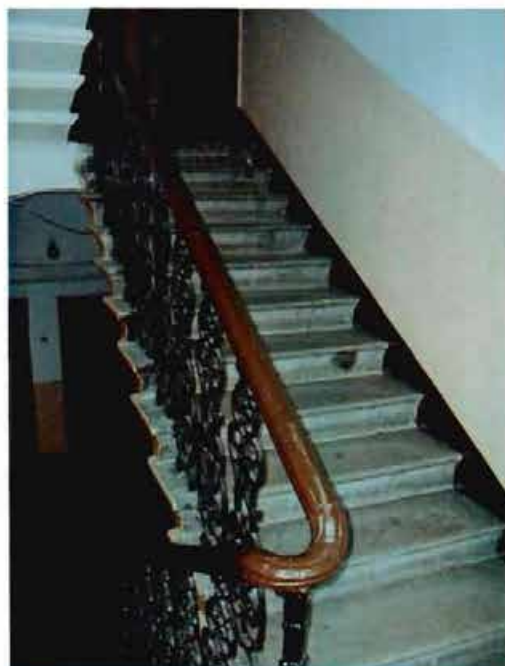
Фото 11. Лестничный объем. Фрагмент.
