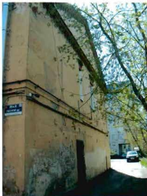
Фото 22. Вид на западный фасад.
