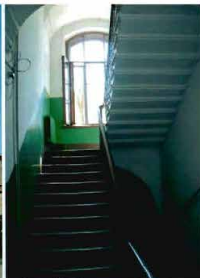
Фото 19. Лестничный объем. Фрагмент.
