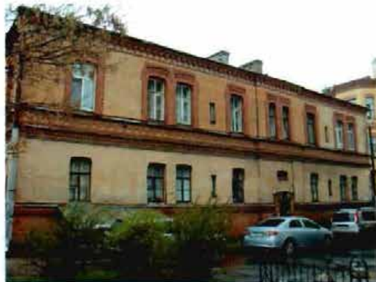
Фото 14. Вид на восточный фасад.
