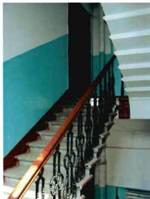
Фото 33. Лестничный объем. Фрагмент.
