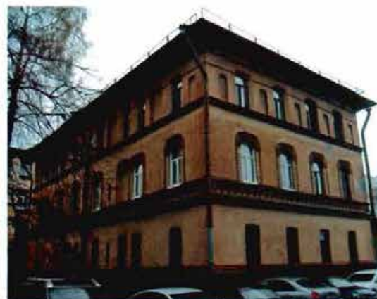
Фото 10. Вид на западный и южный фасады.
