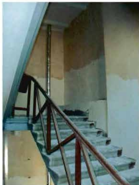
Фото 27. Лестничный объем. Фрагмент.
