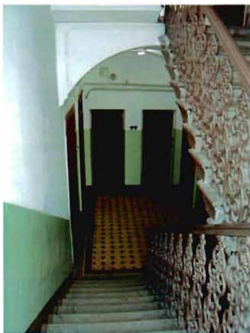
Фото 15. Лестничный объем. Фрагмент.
