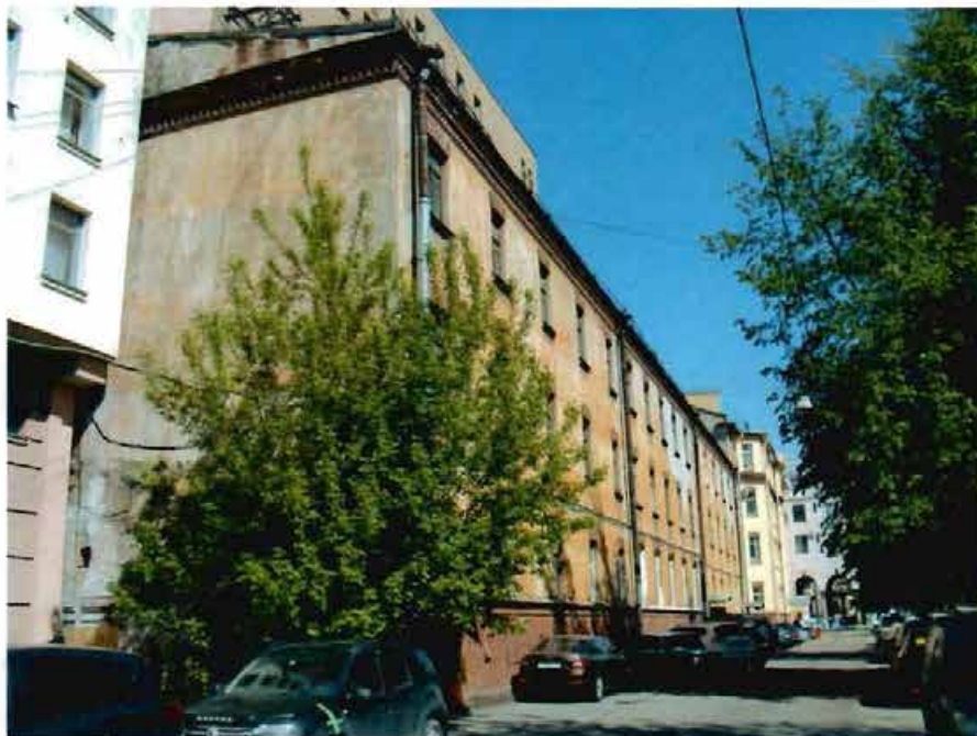
Фото 31. Вид на южный и западный фасады.
