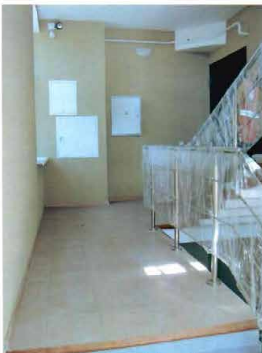
Фото 24. Лестничный объем. Фрагмент.
