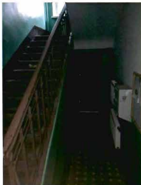
Фото 3. Лестница в северной части здания. Фрагмент. Метлахская плитка.
