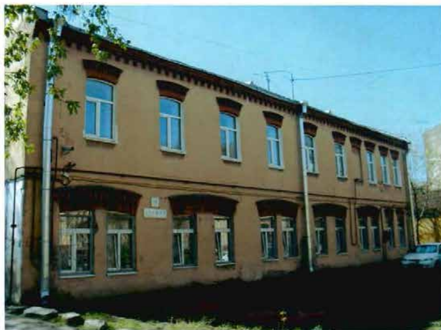
Фото 21. Вид на северный фасад.
