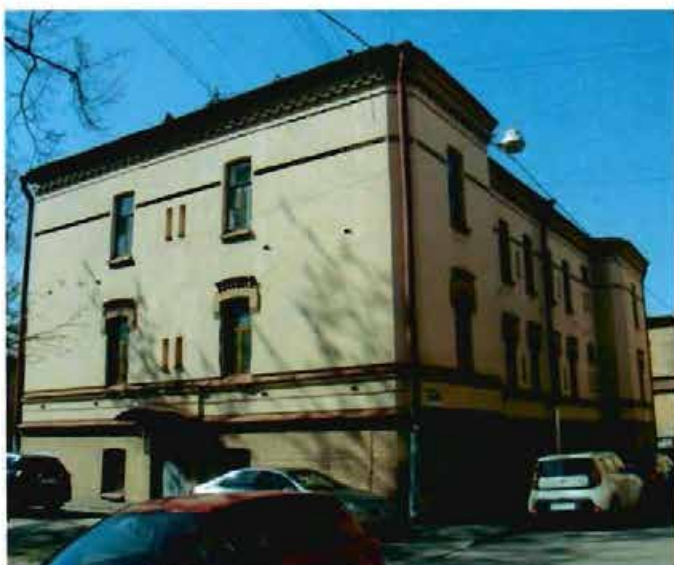
Фото 18. Вид на северный и восточный фасады.
