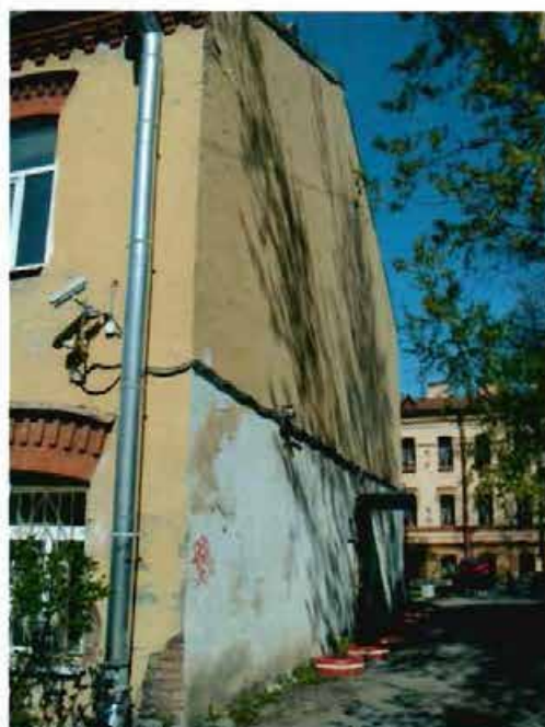
Фото 23. Вид на восточный фасад.
