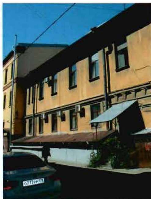
Фото 35. Вид на южный фасад. Наружная лестница Фрагмент.
