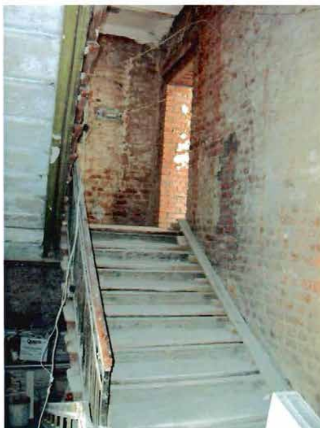
Фото 44. Лестничный объем. Фрагмент.
