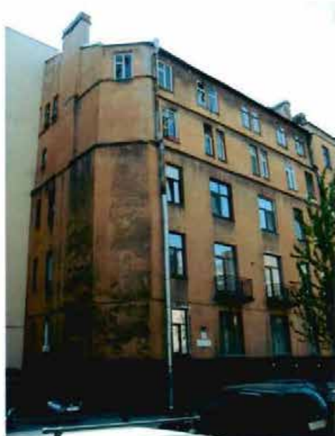
Фото 26. Вид на северный фасад. Фрагмент.
