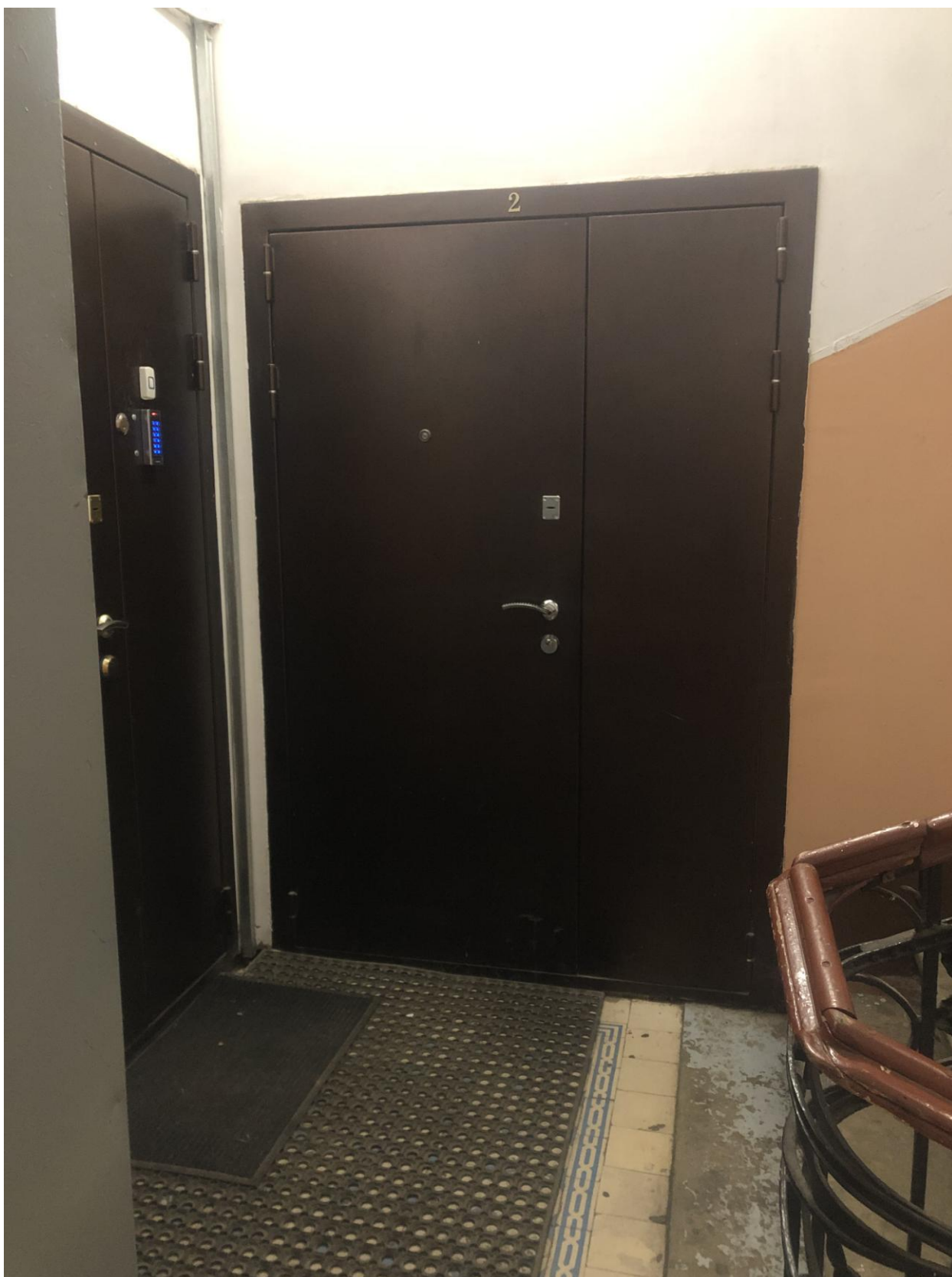
Фото 1. Вход в квартиру № 2 с парадной лестницы.
