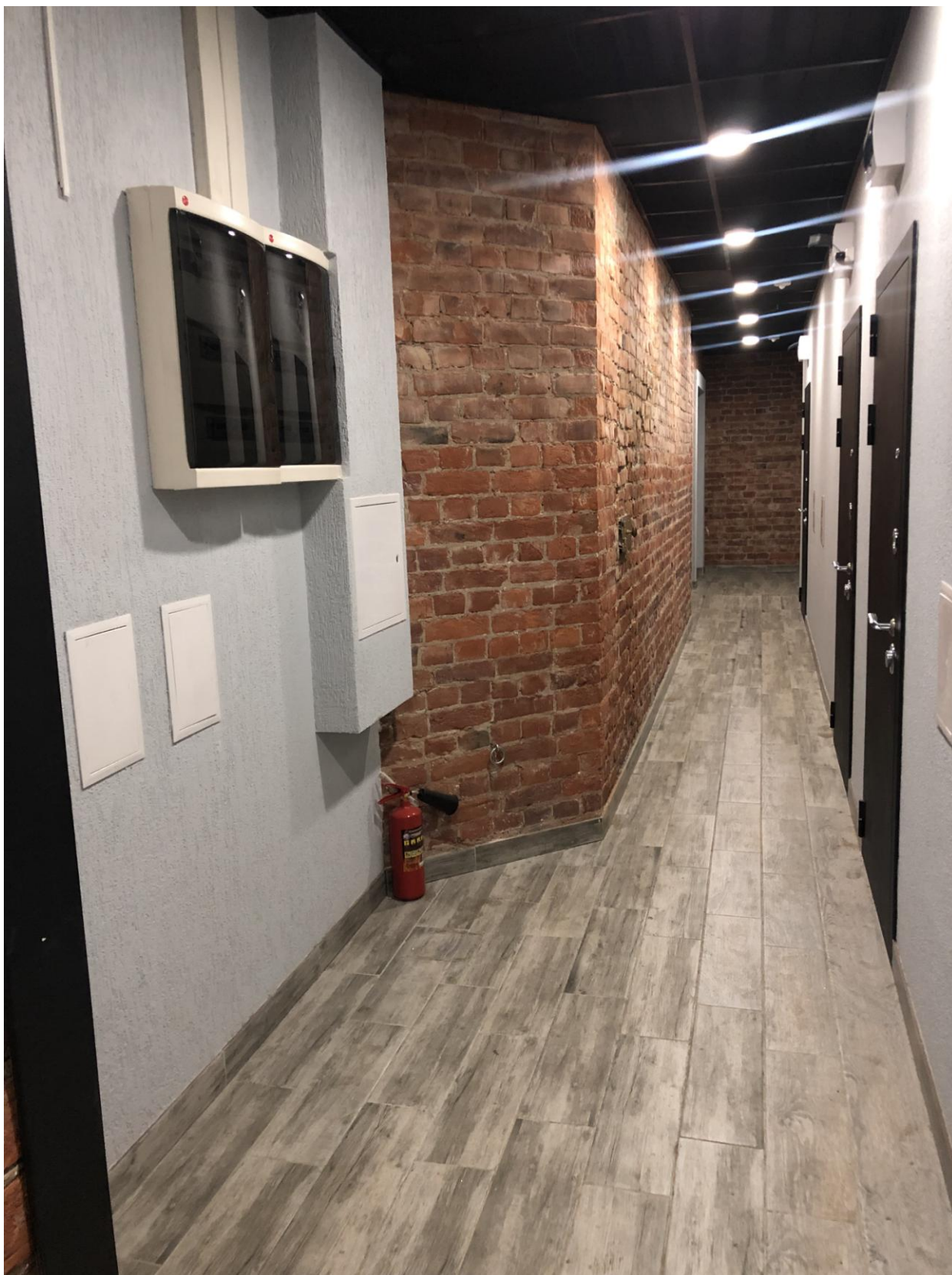
Фото 4. Вид на коридор.
