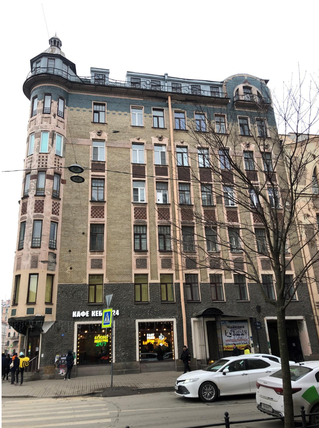
Фото 7. Вид на лицевой фасад (по 14-й линии) объекта культурного наследия.
