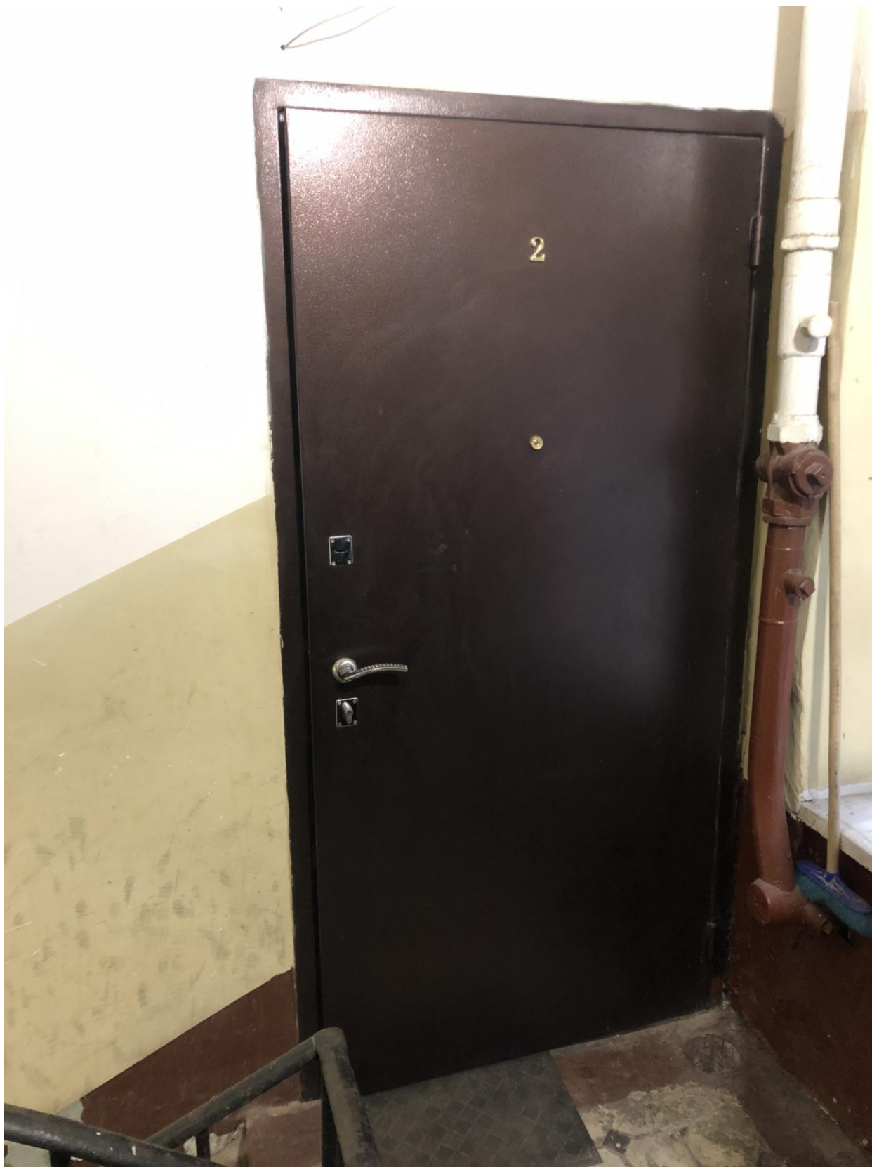
Фото 2. Вход в квартиру № 2 с черной лестницы.
