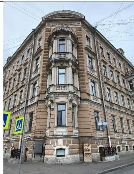
эркеры в уровне 2-3-го этажей, на волютообразных кронштейнах, завершенные в уровне 4-го этажа балконами, – местоположение (два на фасаде со стороны Большого пр., два – со стороны 4-й линии), габариты, конфигурация (прямоугольные в плане);
