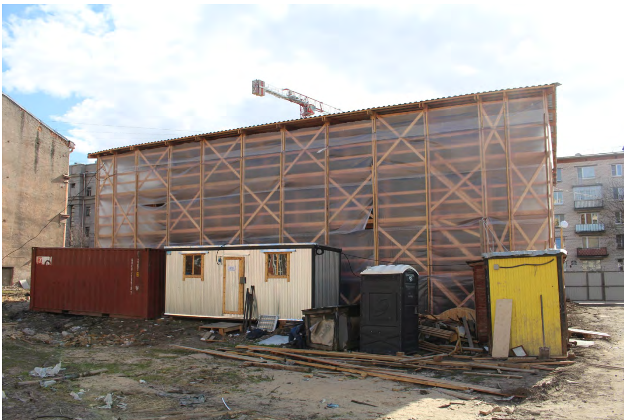
Фото 5. Вид с северо-востока.
