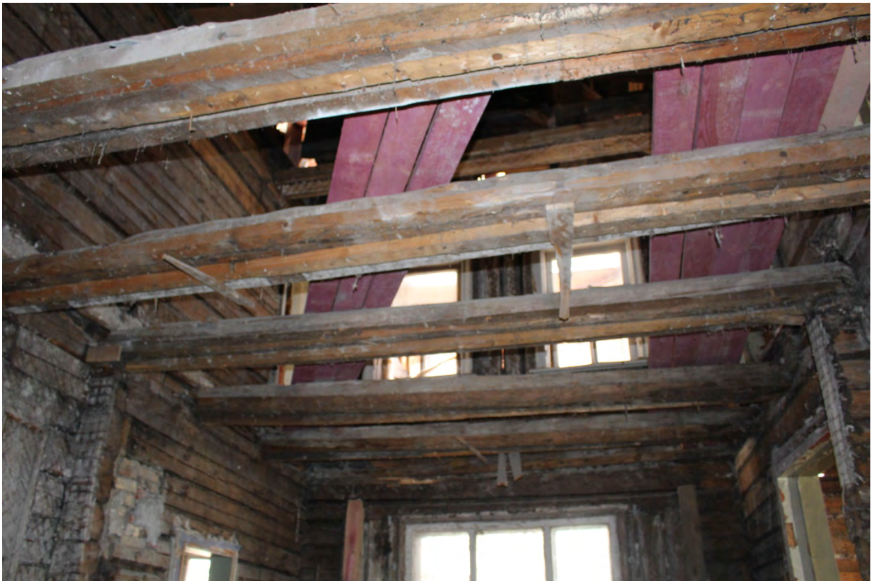
Фото 34. Элементы перекрытий над коридором.
