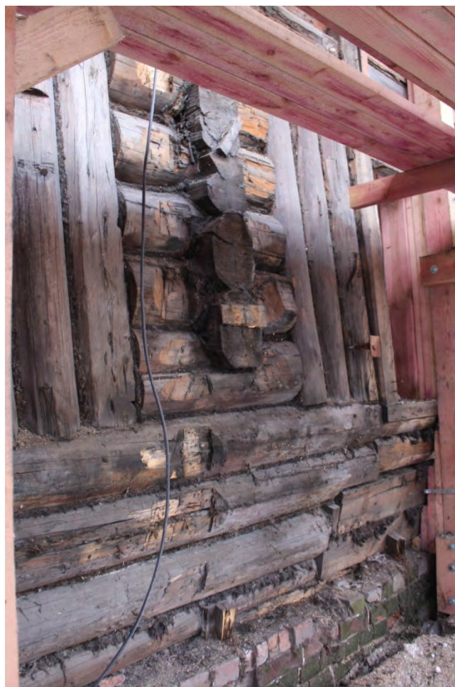
Фото 9. Фрагмент сруба северо-восточного фасада.
