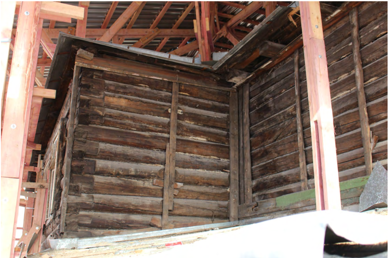
Фото 56. Вид на мезонин с северо-запада.
