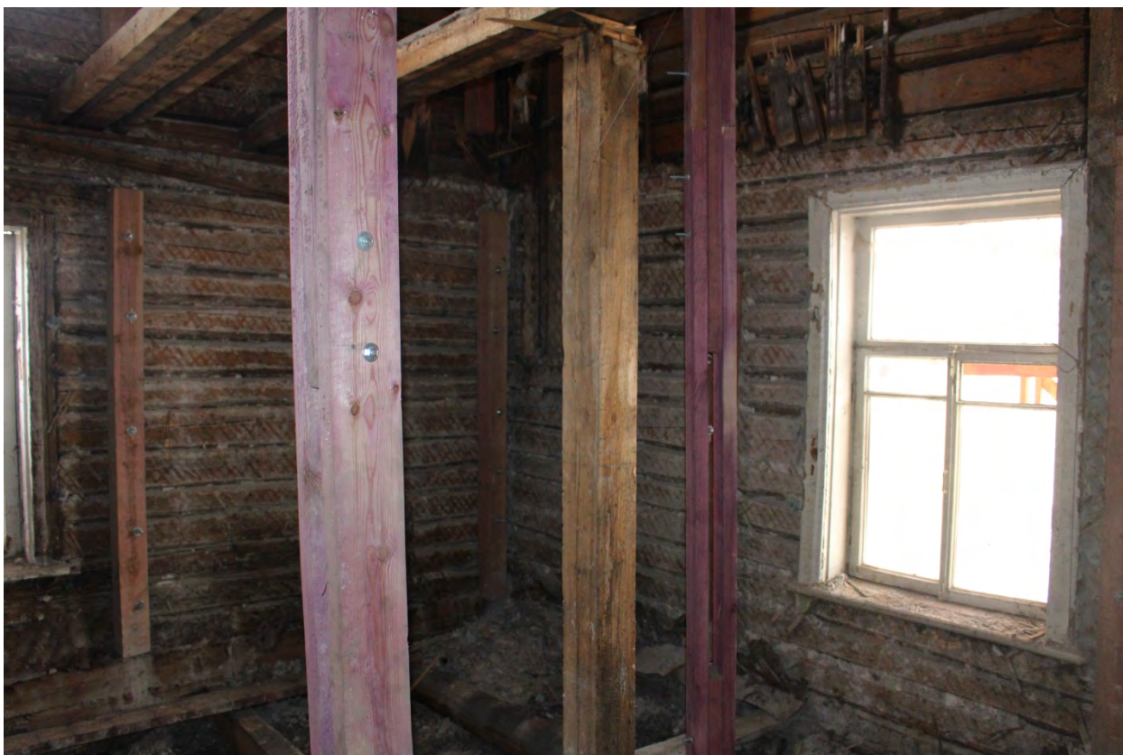
Фото 37. Вид на восточный угол здания.
