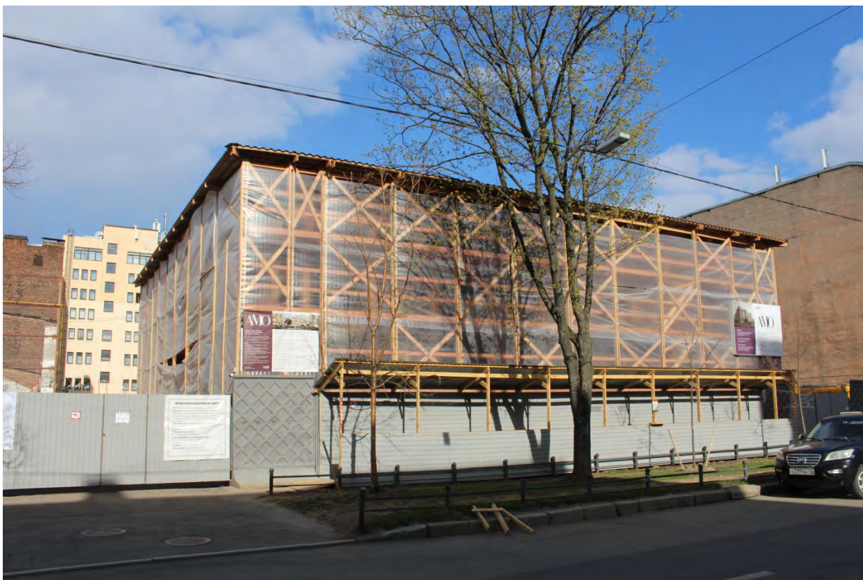
Фото 3. Общий вид с запада.
