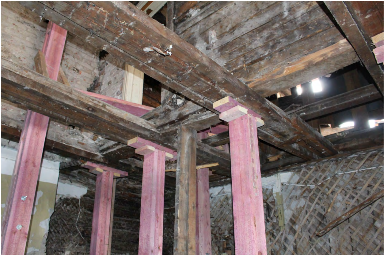
Фото 40. Фрагмент перекрытия в юго-восточной части.
