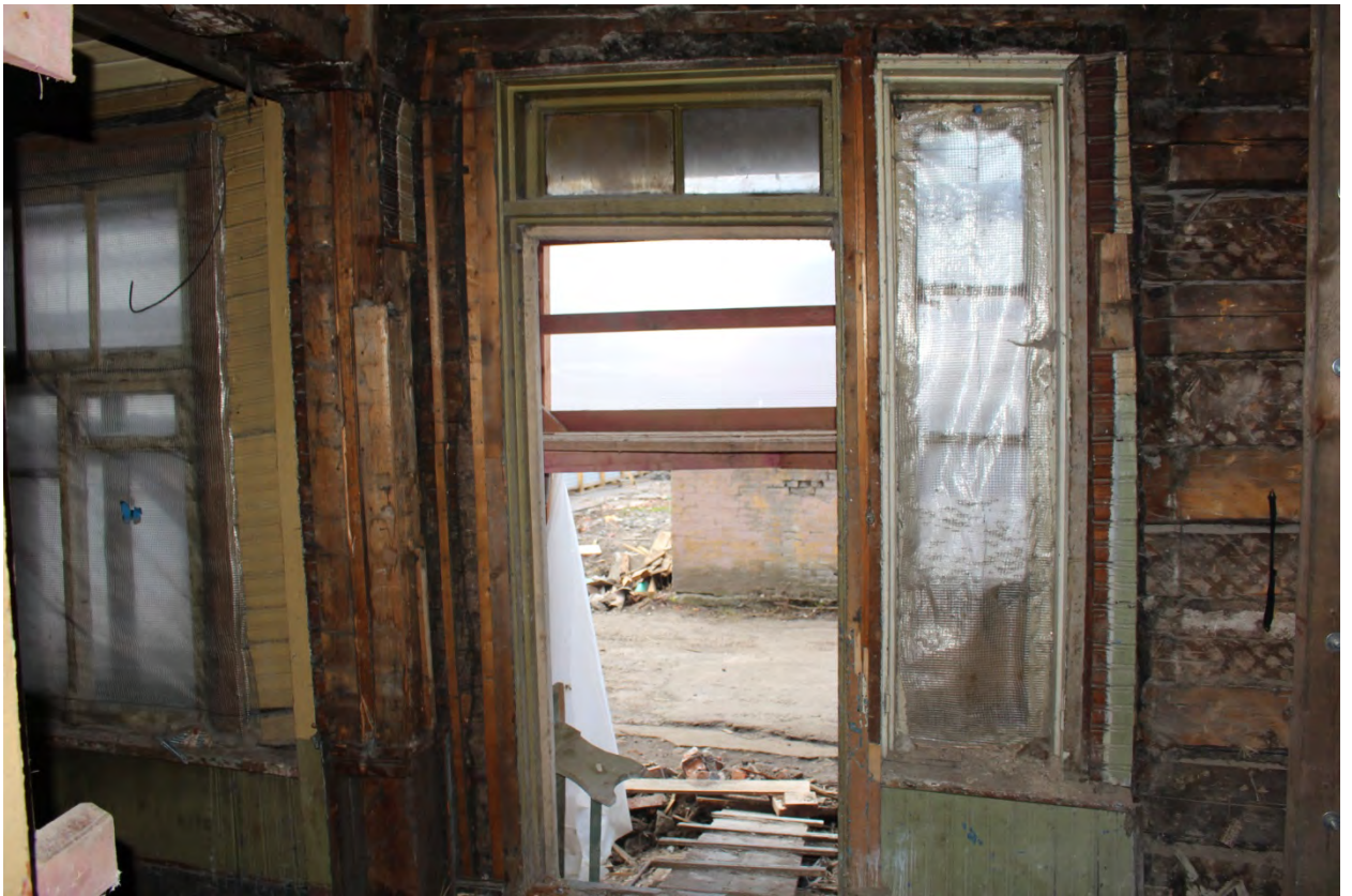
Фото 21. Вид западного входа.
