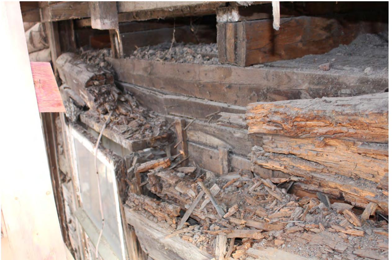
Фото 55. Фрагмент фасада в уровне второго этажа.
