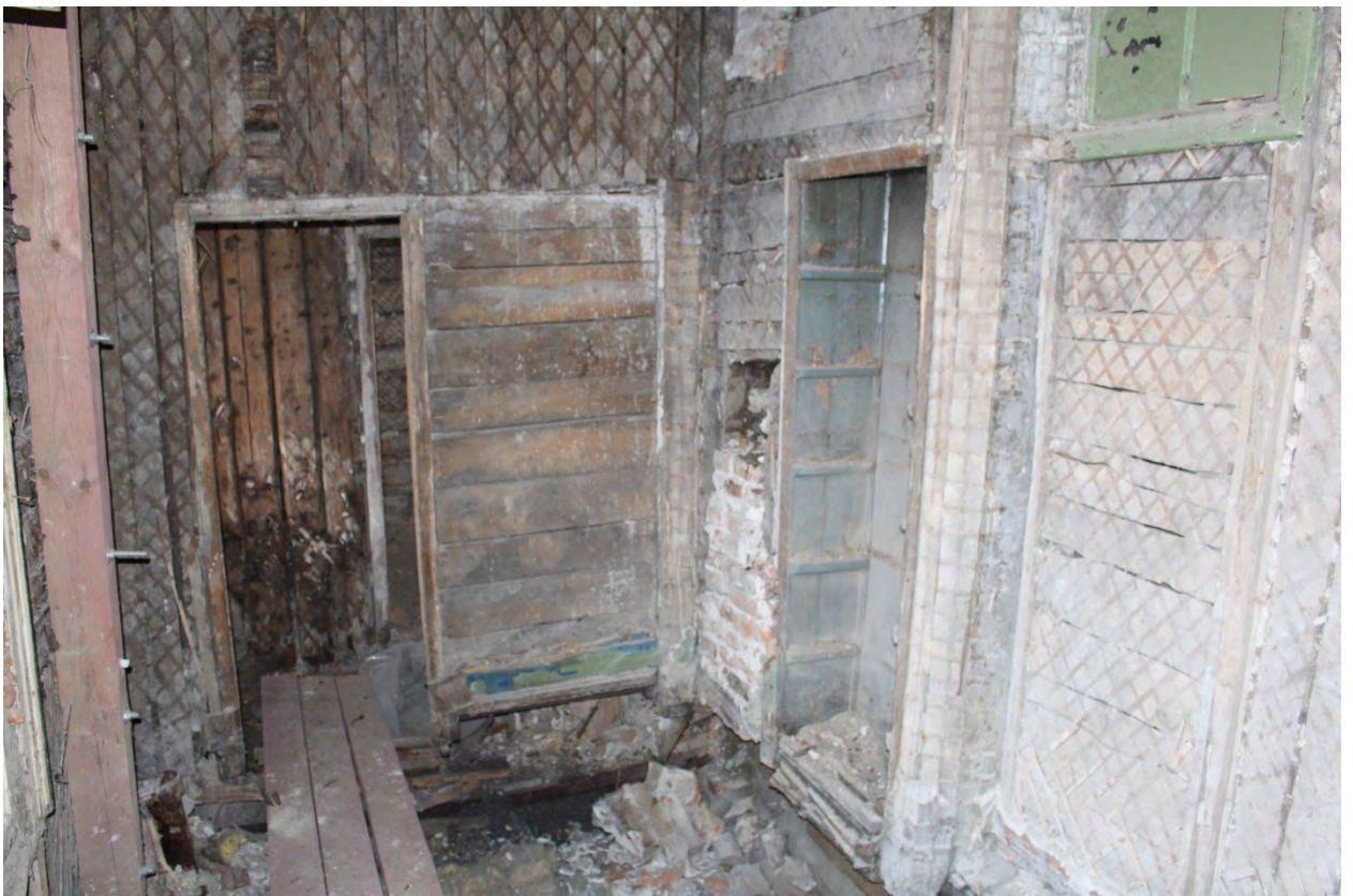
Фото 22. Помещения на северо-западе.
