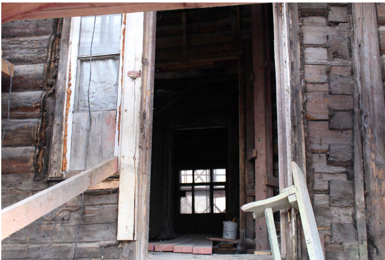
Фото 17. Вход со стороны северо-западного фасада.
