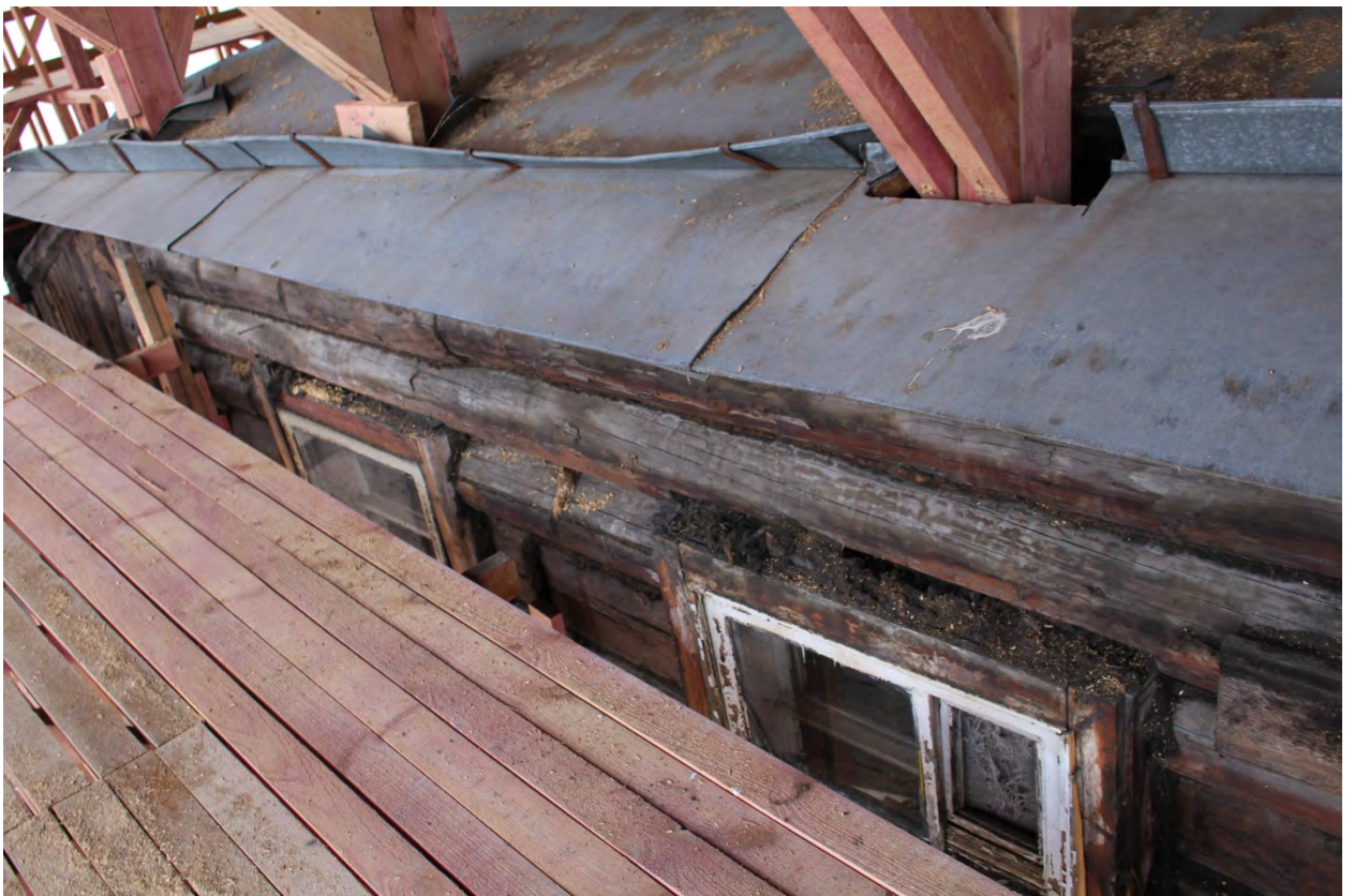
Фото 76. Вид на юго-восточный карниз.
