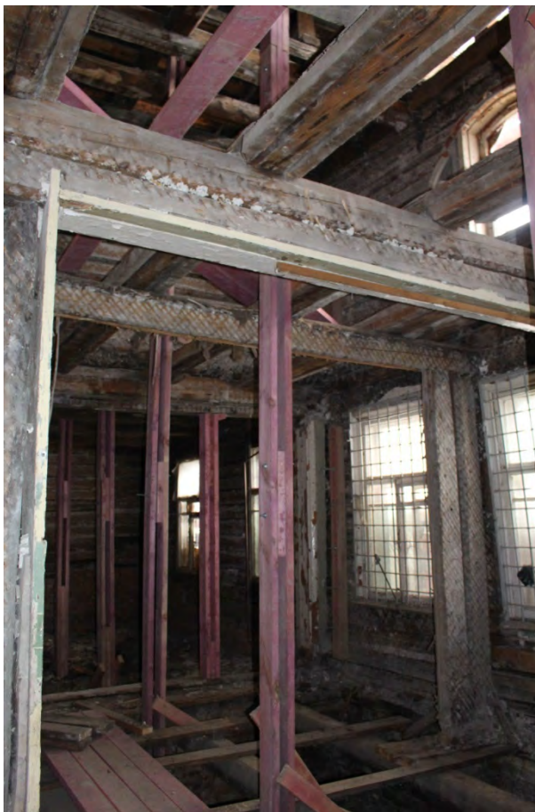
Фото 29. Вид на юго-западную часть здания.
