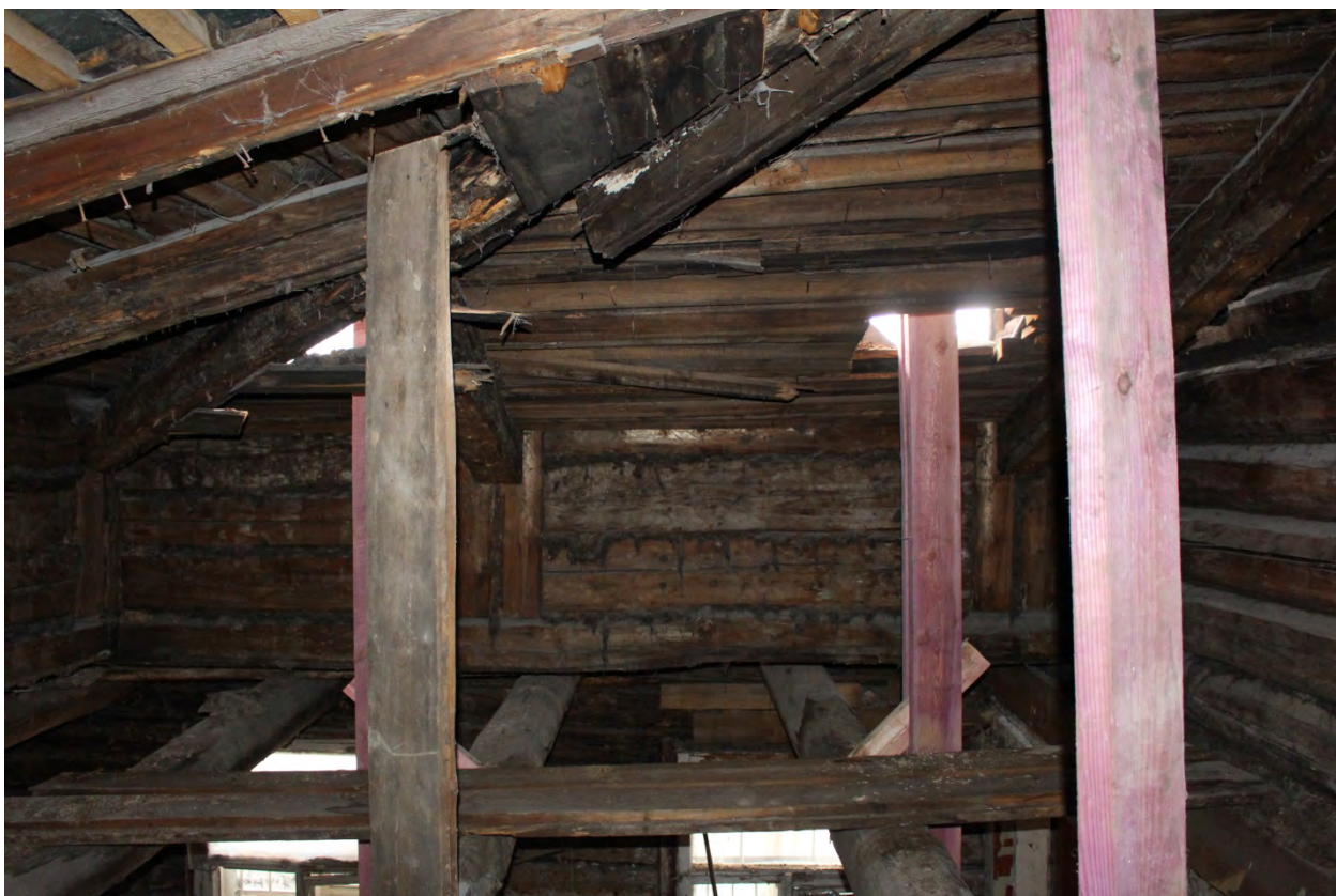
Фото 51. Чердак в южной части.
