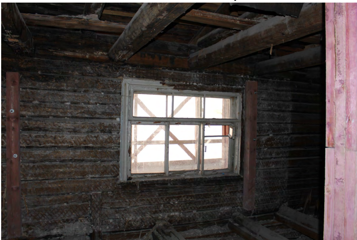
Фото 54. Проем на северо-восточном фасаде второго этажа.
