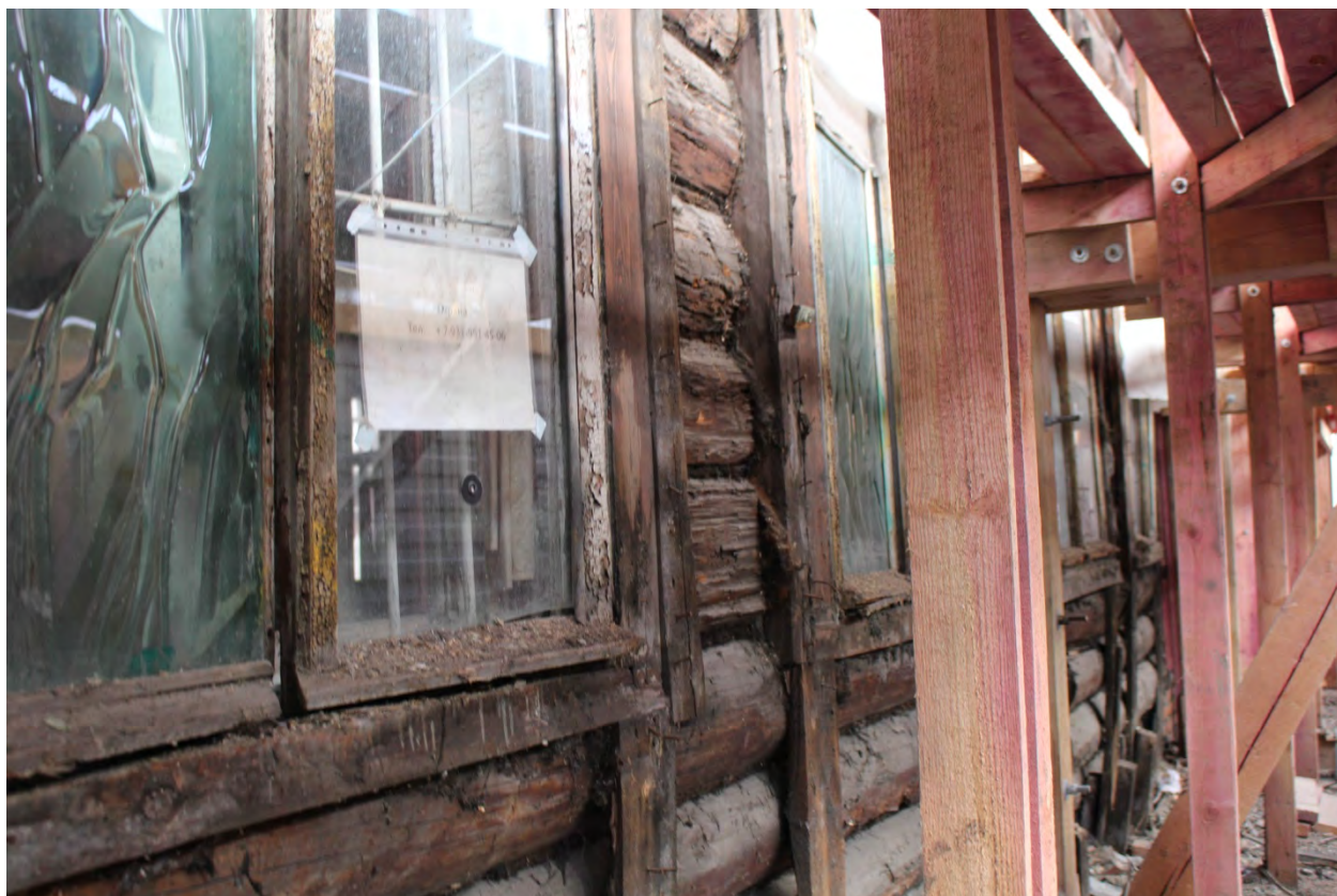
Фото 15. Центральная часть западного лицевого фасада.
