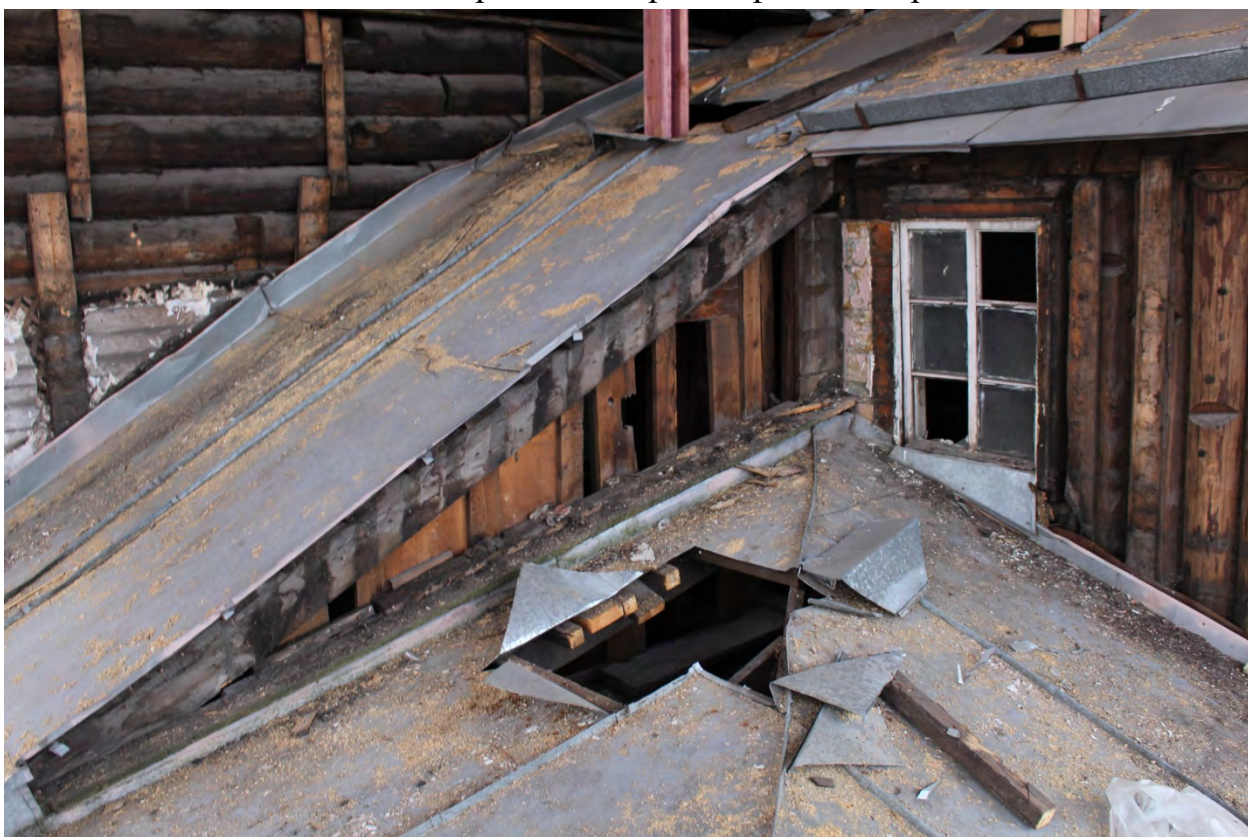
Фото 70. Вид на кровлю с севера.
