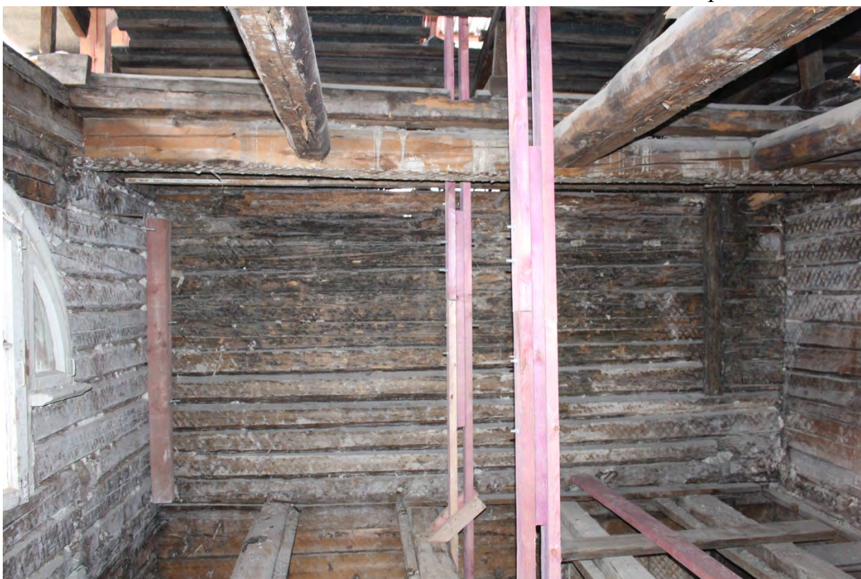
Фото 50. Помещения вдоль лицевого фасада второго этажа.
