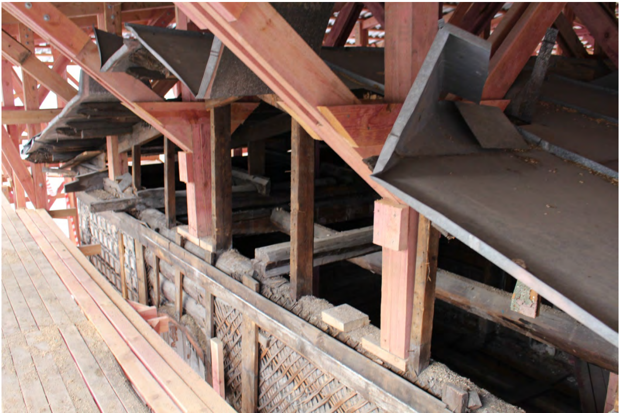
Фото 75. Вид кровли и карниза лицевого фасада.
