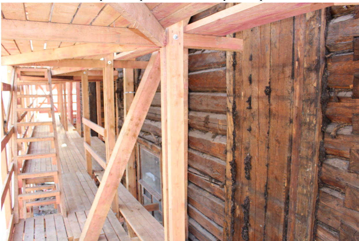
Фото 62. Вид вдоль юго-востока между первым и вторым этажами.
