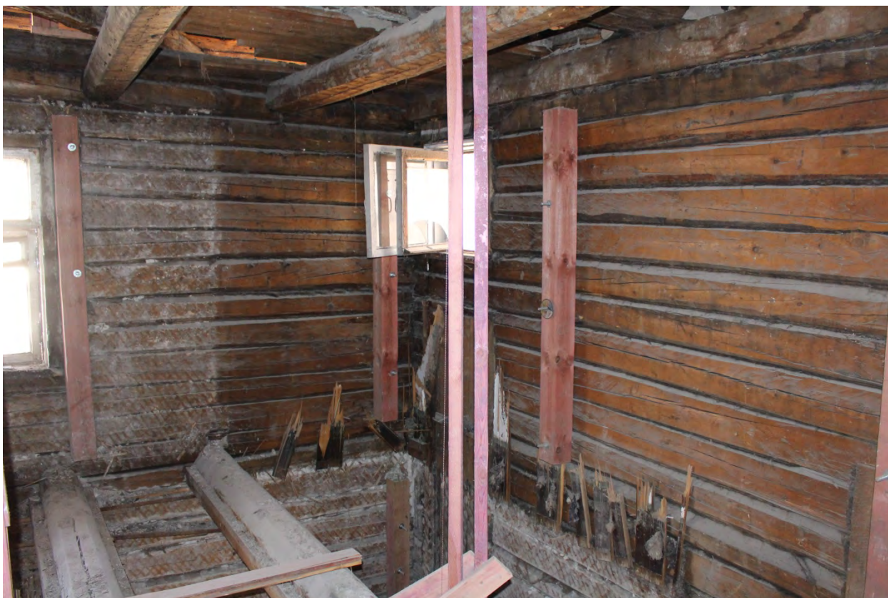
Фото 53. Помещения на востоке второго этажа.
