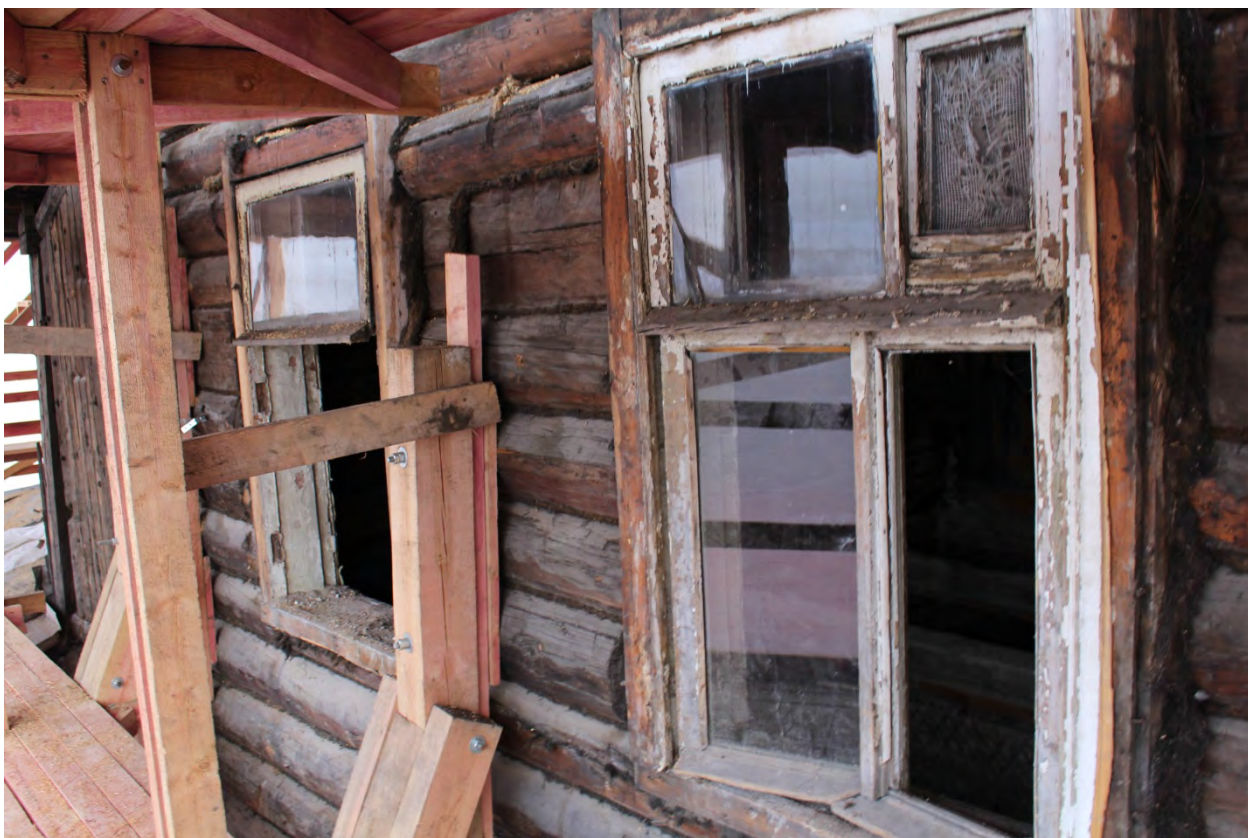
Фото 69. Оконные проемы северного фасада второго этажа.
