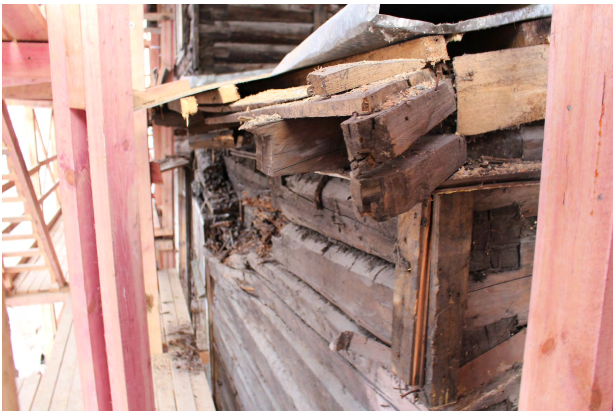
Фото 67. Восточный угол в уровне второго этажа.
