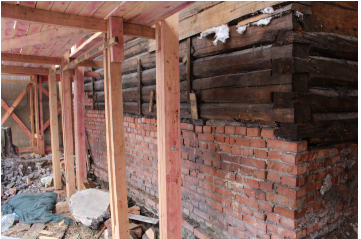
Фото 11. Фрагмент цоколя юго-восточного фасада.
