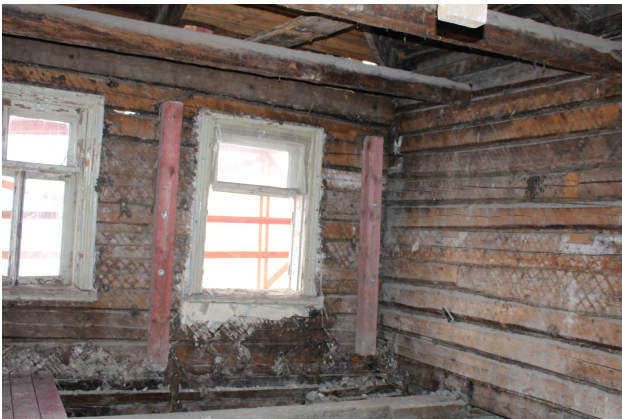
Фото 43. Вид на северо-западные помещения второго этажа.
