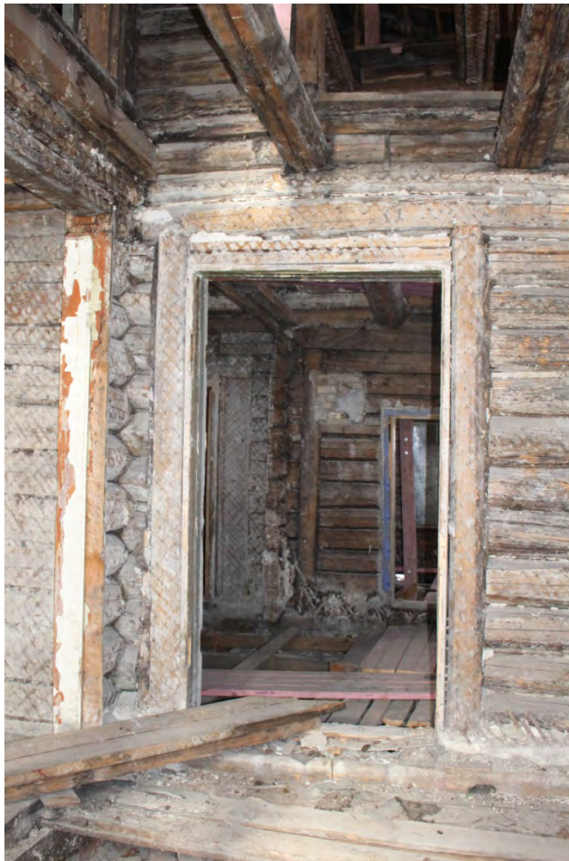
Фото 33. Проем в юге в коридор.
