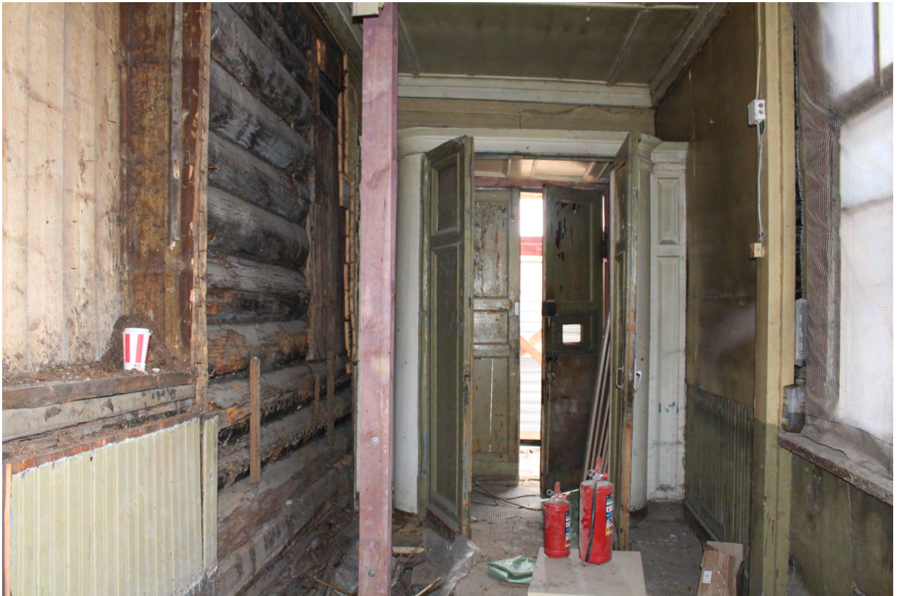
Фото 20. Вид на тамбур.
