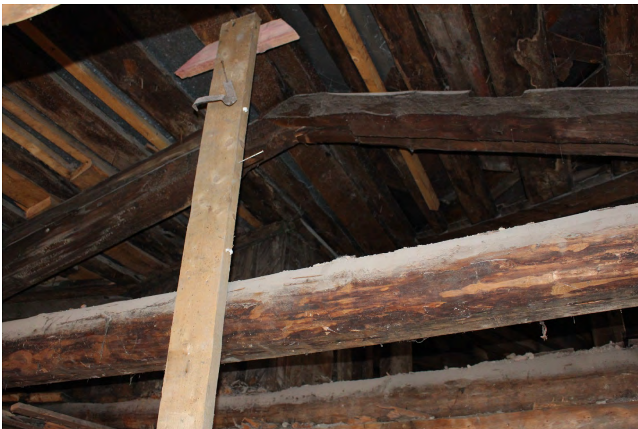
Фото 45. Фрагмент чердачного перекрытия и стропильной системы.
