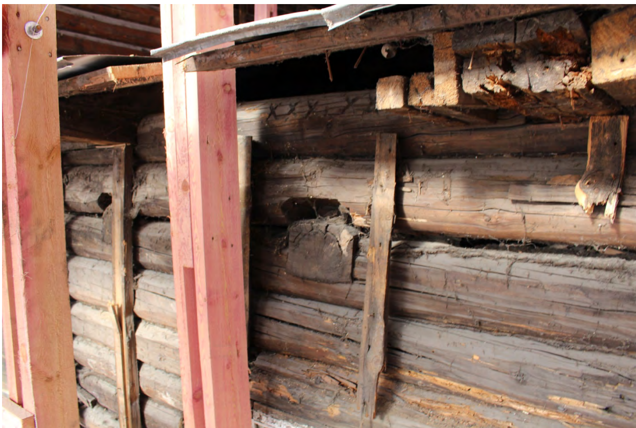
Фото 65. Фрагмент восточной части здания в уровне второго этажа.
