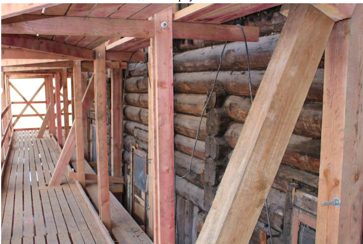
Фото 60. Вид вдоль северо-восточного фасада в уровне второго этажа.
