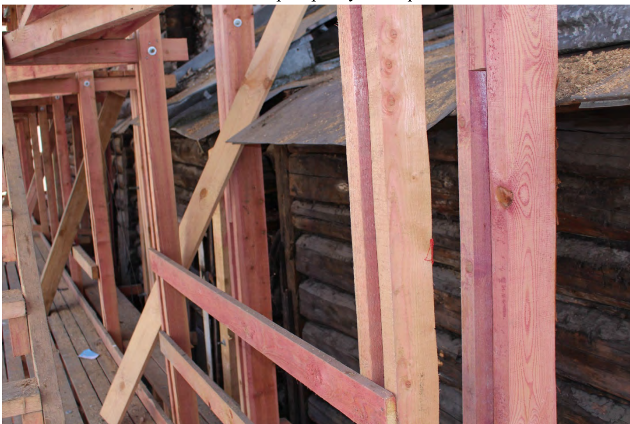
Фото 58. Вид вдоль северо-западного фасада.
