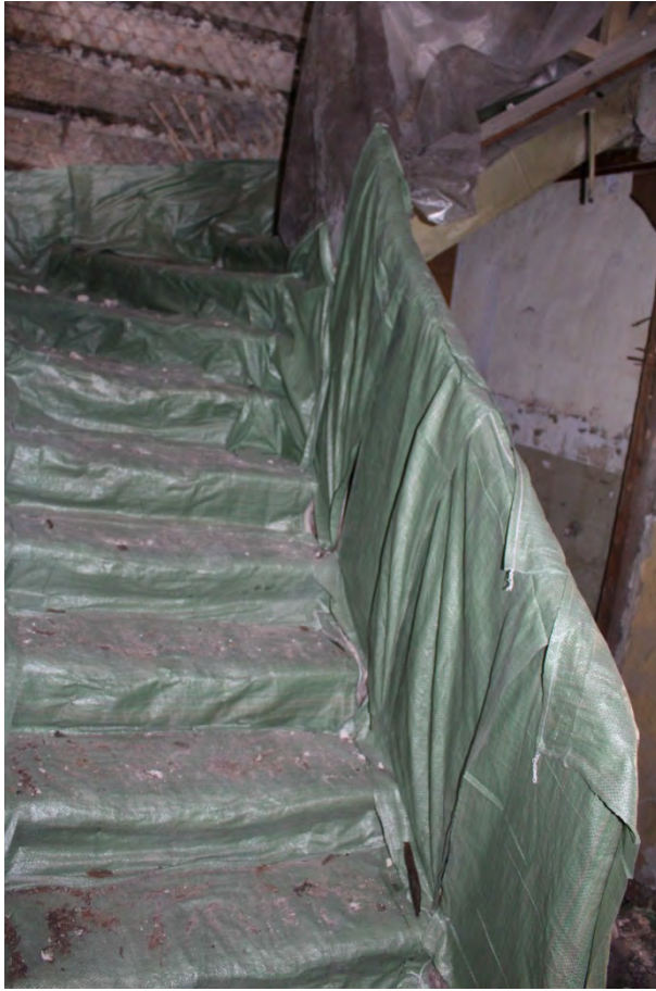
Фото 41. Лестница на второй этаж.
