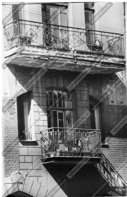
18. Вид декоративных решеток балконов на центральном фасаде жилого дома № 58 по 9-й линии Васильевского острова. 12 июня 1987 г. ЦГАКФФД СПб Ар 225808
