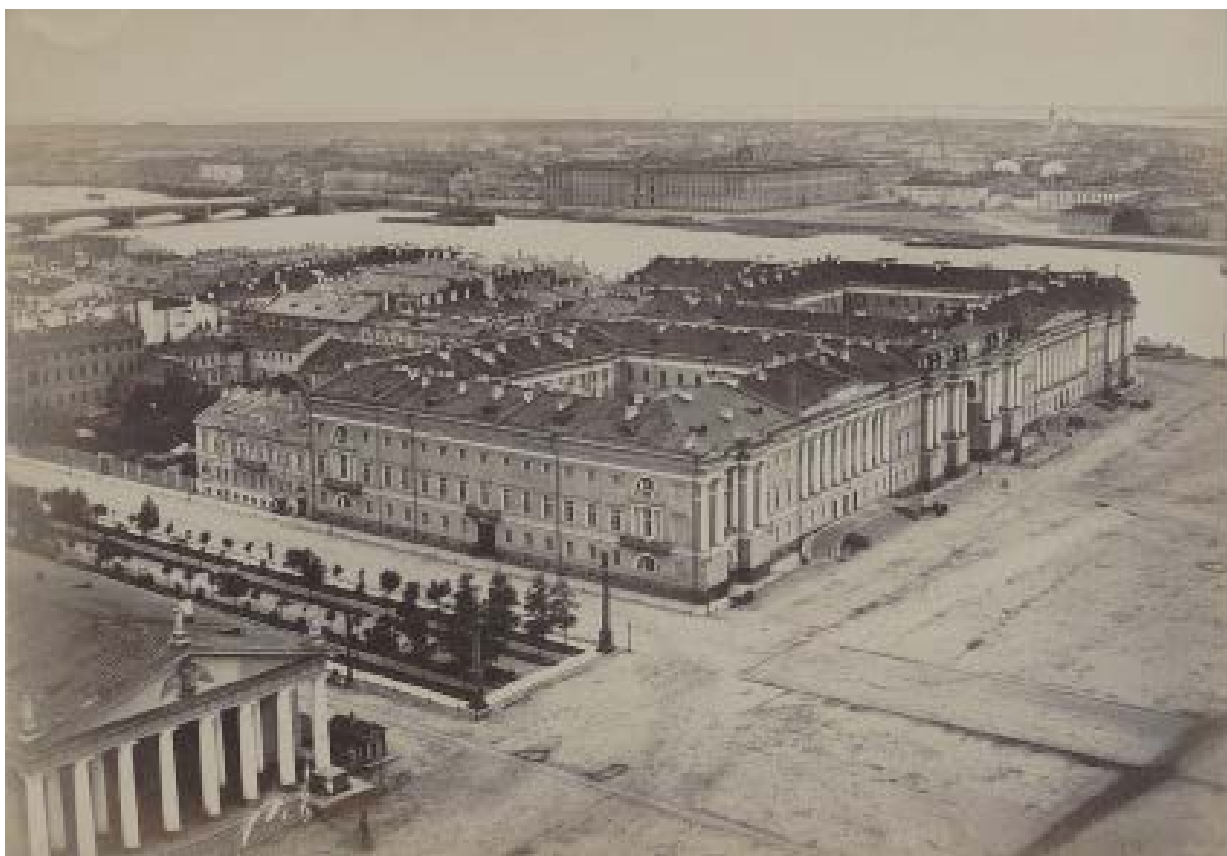
6. Фото 1870 г. Панорама с Исаакиевского собора в сторону Сената и Синода
