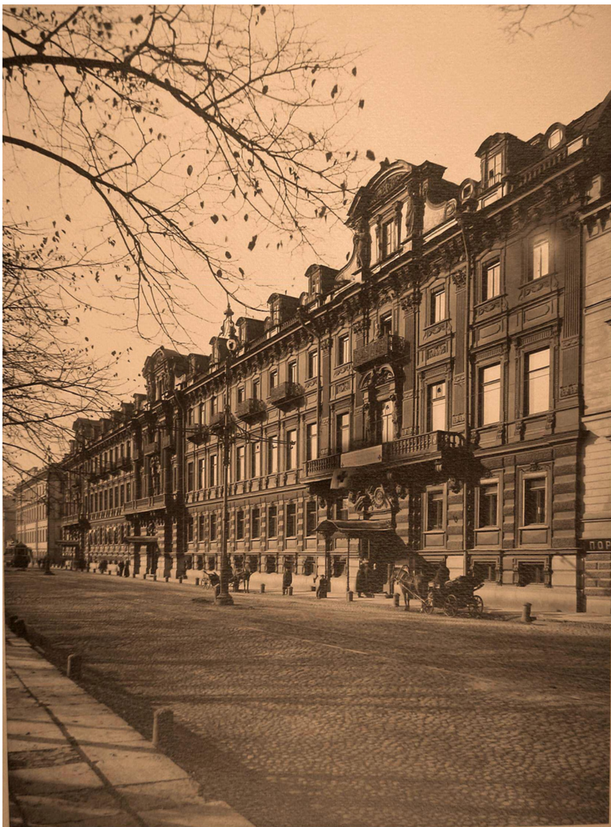
10. Конногвардейский бульвар, 17, фото 1915 г. , источник - https://pastvu.com/ .
