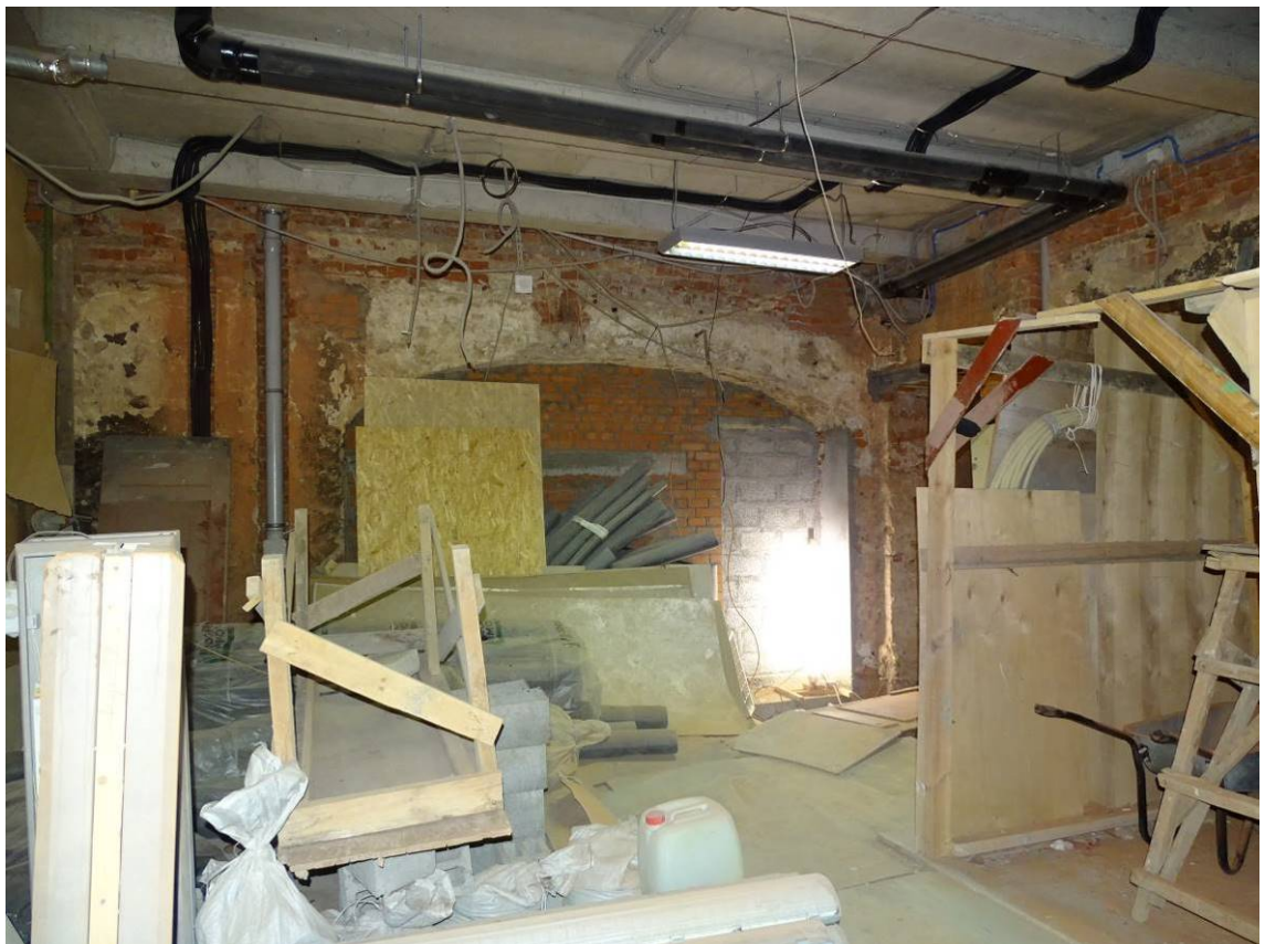
Илл. 23. 1-й этаж. Помещение 3/8,3; 4/172,6. Съемка 14.02.2022 г. Трушковский В. Э.
