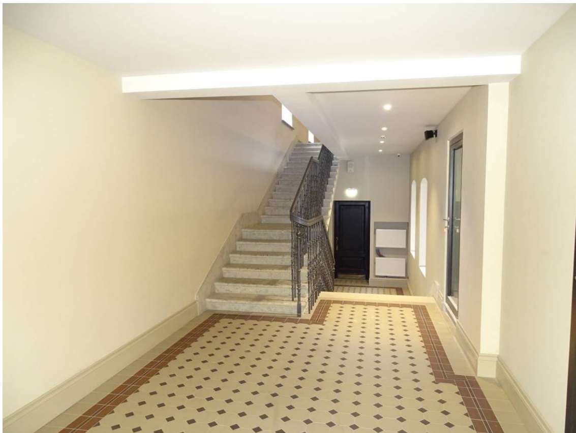
Илл. 18. 1-й этаж. Помещение 1/57,6. Съемка 14.02.2022 г. Трушковский В. Э.
