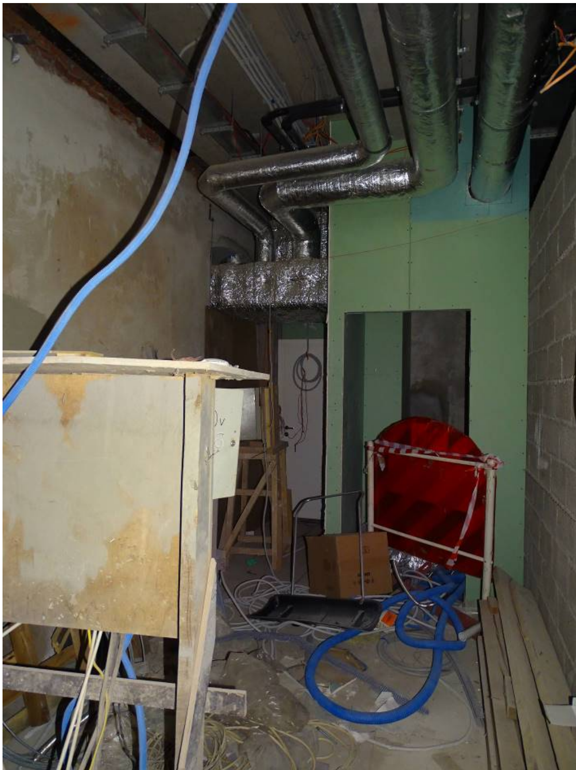
Илл. 21. 1-й этаж. Помещение 1/3,3; 2/168,5. Съемка 14.02.2022 г. Трушковский В. Э.
