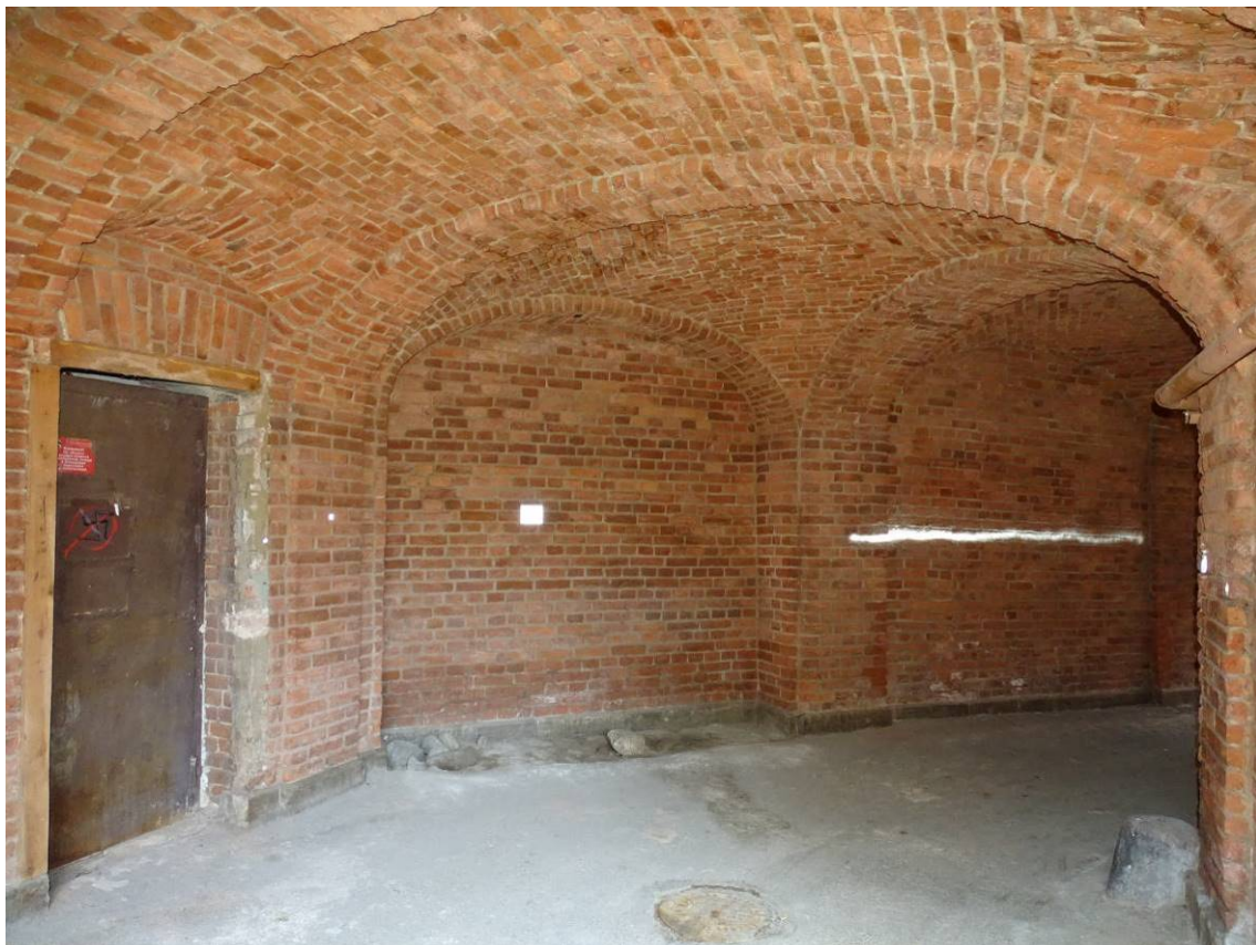
Илл. 06. Объект культурного наследия регионального значения "Воронинские бани". Поворотная арка юго-западной части здания. Съемка 14.02.2022 г. Трушковский В. Э.
