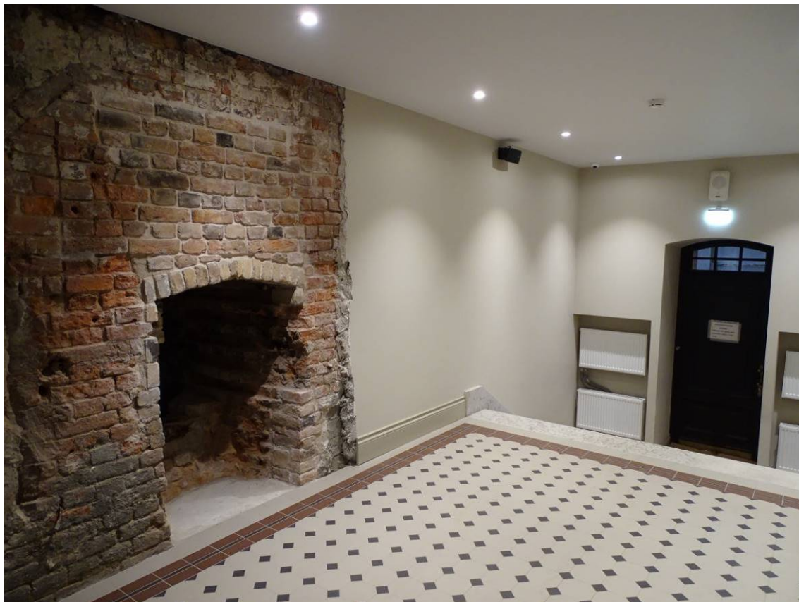
Илл. 16. 1-й этаж. Помещение 1/57,6. Съемка 14.02.2022 г. Трушковский В. Э.
