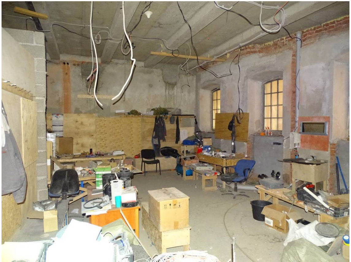
Илл. 22. 1-й этаж. Помещение 1/3,3; 2/168,5. Съемка 14.02.2022 г. Трушковский В. Э.
