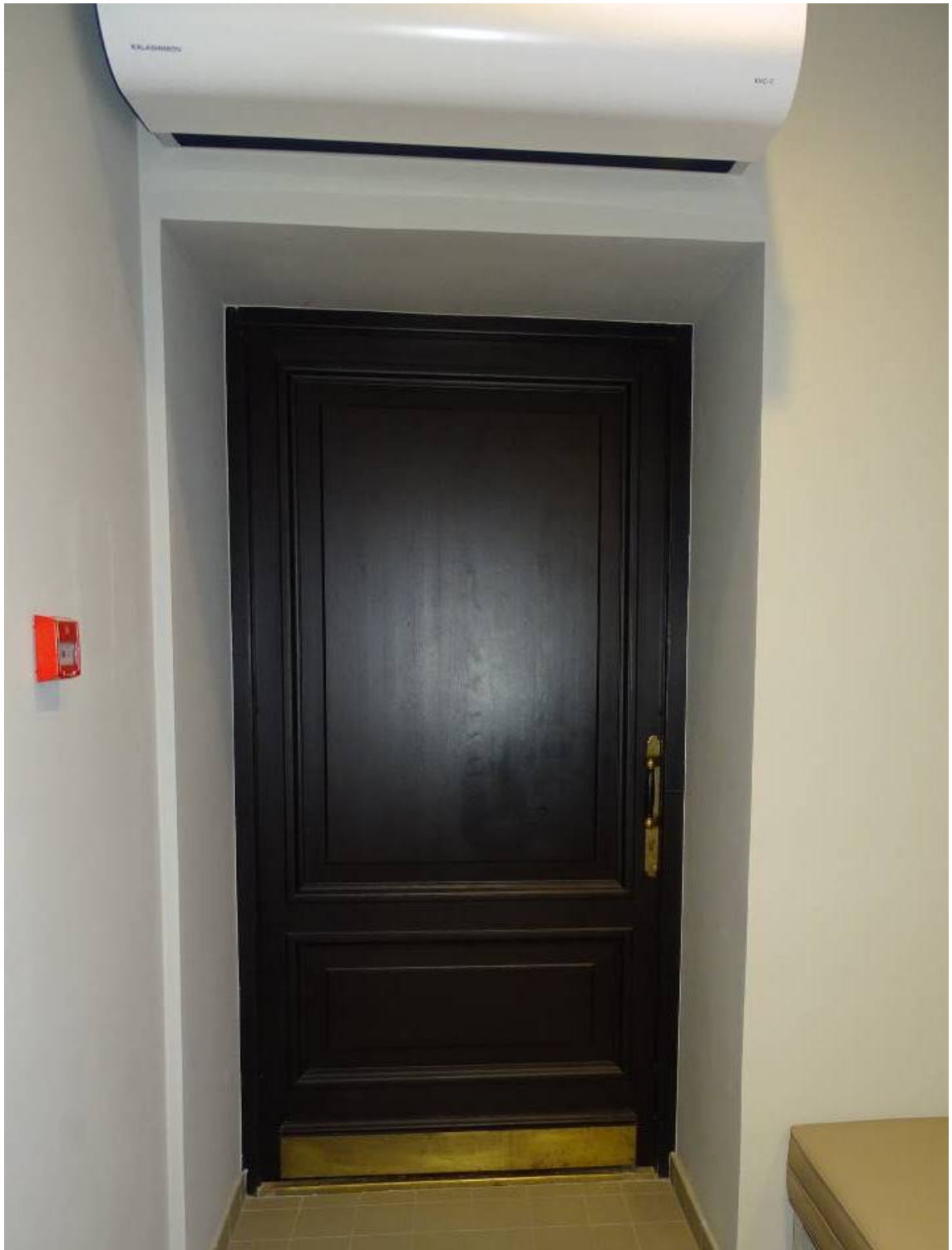
Илл. 06. 1-й этаж. Помещение 1/3,7; 2/144,7; 3/7,9; 4/13,8. Съемка 14.02.2022 г. Трушковский В. Э.
