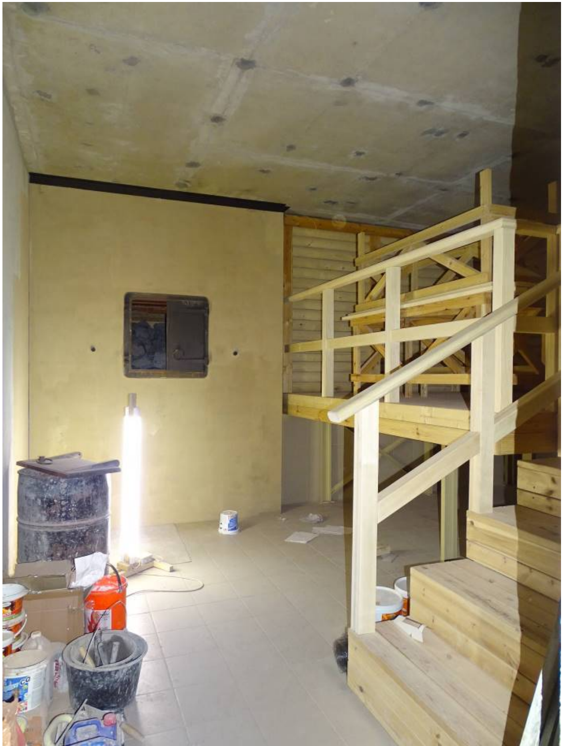
Илл. 24. 1-й этаж. Помещение 5/33,1. Съемка 14.02.2022 г. Трушковский В. Э.
