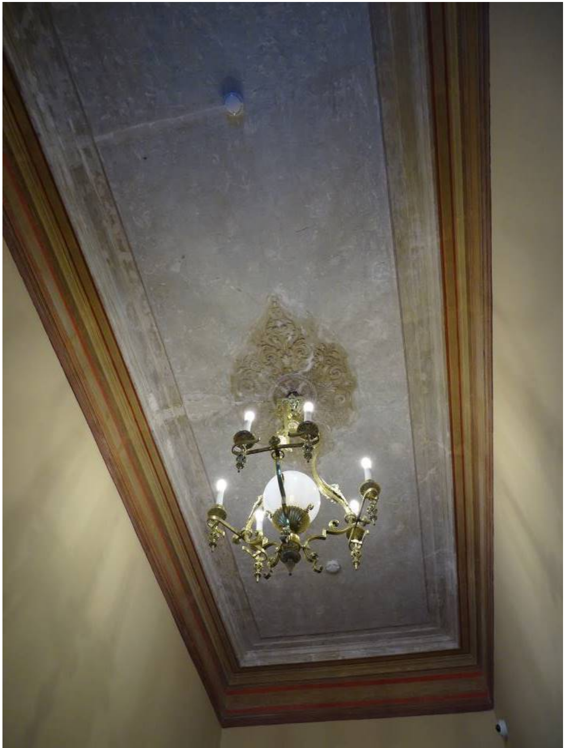
Илл. 13. 1-й этаж. Помещение 1/4,5; 2/3,4; 4/4,0. Съемка 14.02.2022 г. Трушковский В. Э.
