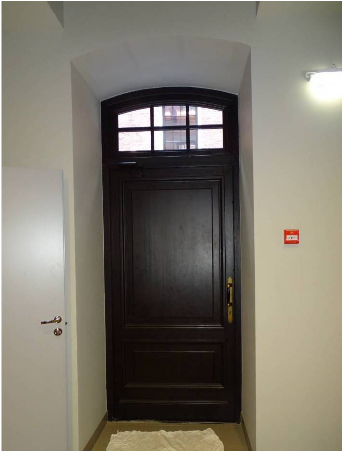
Илл. 01. 1-й этаж. Помещение 2/144,7; 5/12,9; 6/9,5. Съемка 14.02.2022 г. Трушковский В. Э.
