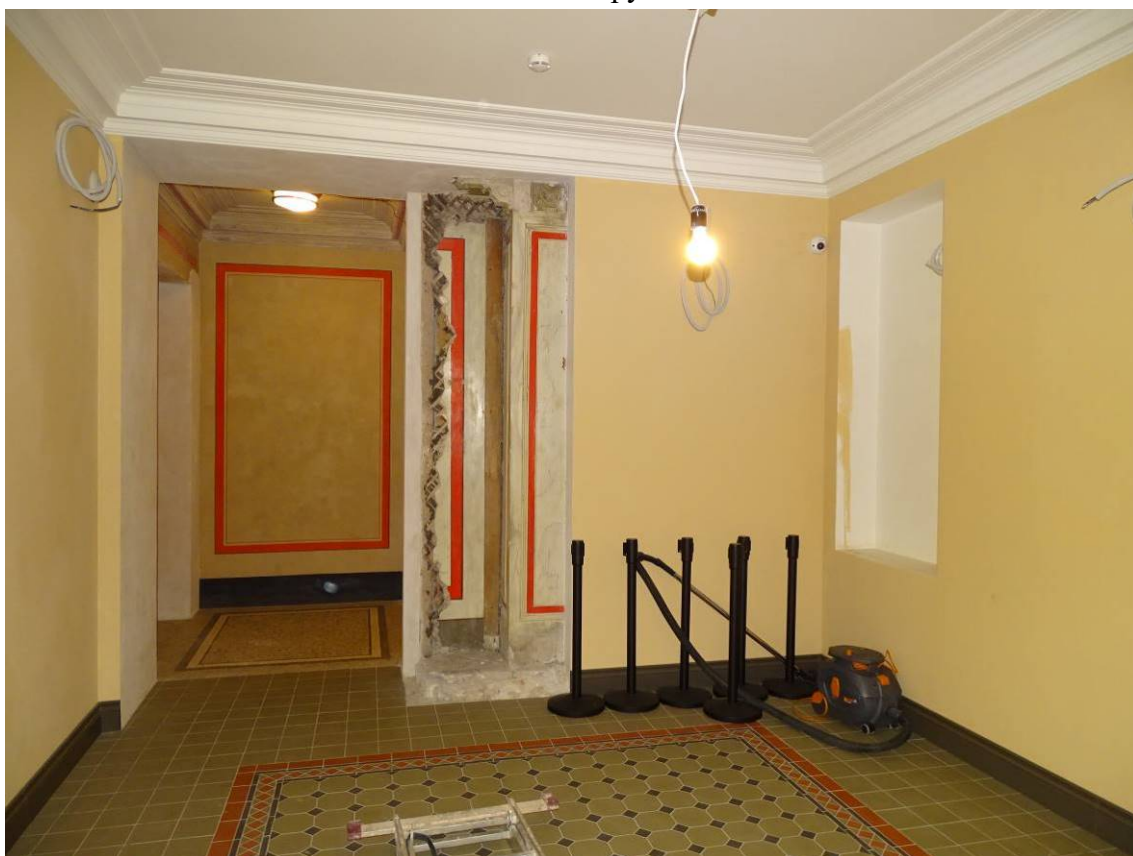
Илл. 09. 1-й этаж. Помещение 6/20,7. Съемка 14.02.2022 г. Трушковский В. Э.
