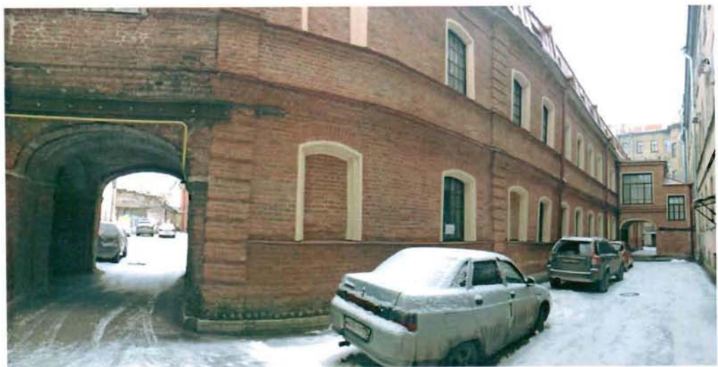
2. Восточный фасад. Общий вид.
