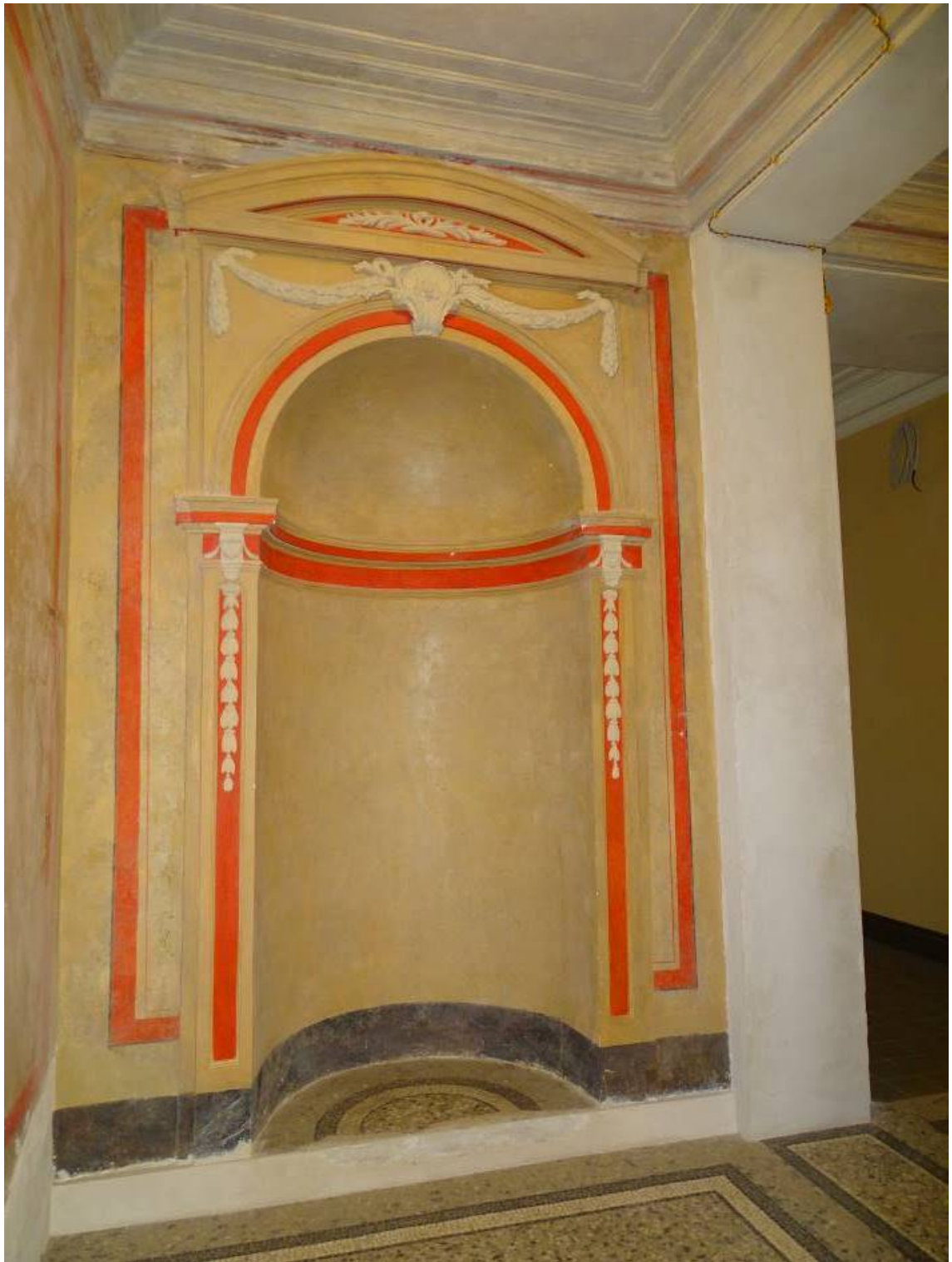
Илл. 12. 1-й этаж. Помещение 7/1,8; 8/8,2. Съемка 14.02.2022 г. Трушковский В. Э.
