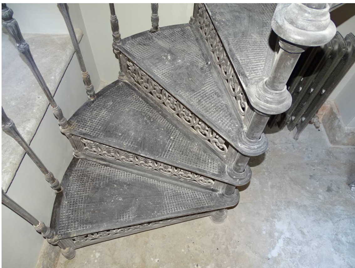
Илл. 19. 1-й этаж. Лестница IV/3,6. Съемка 14.02.2022 г. Трушковский В. Э.
