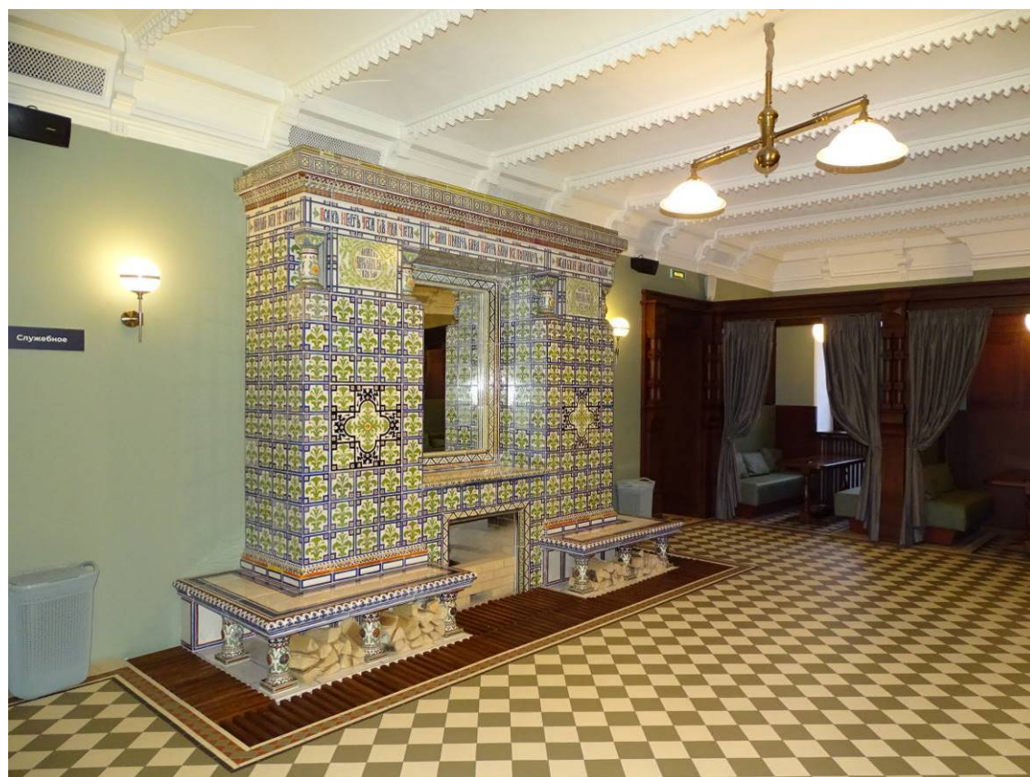
Илл. 07. 2-й этаж. Помещение 41/10,6; 42/28,0; 43/4,2; 44/7,1; 45/3,8; 46/6,2; 47/4,1. Съемка 14.02.2022 г. Трушковский В. Э.
