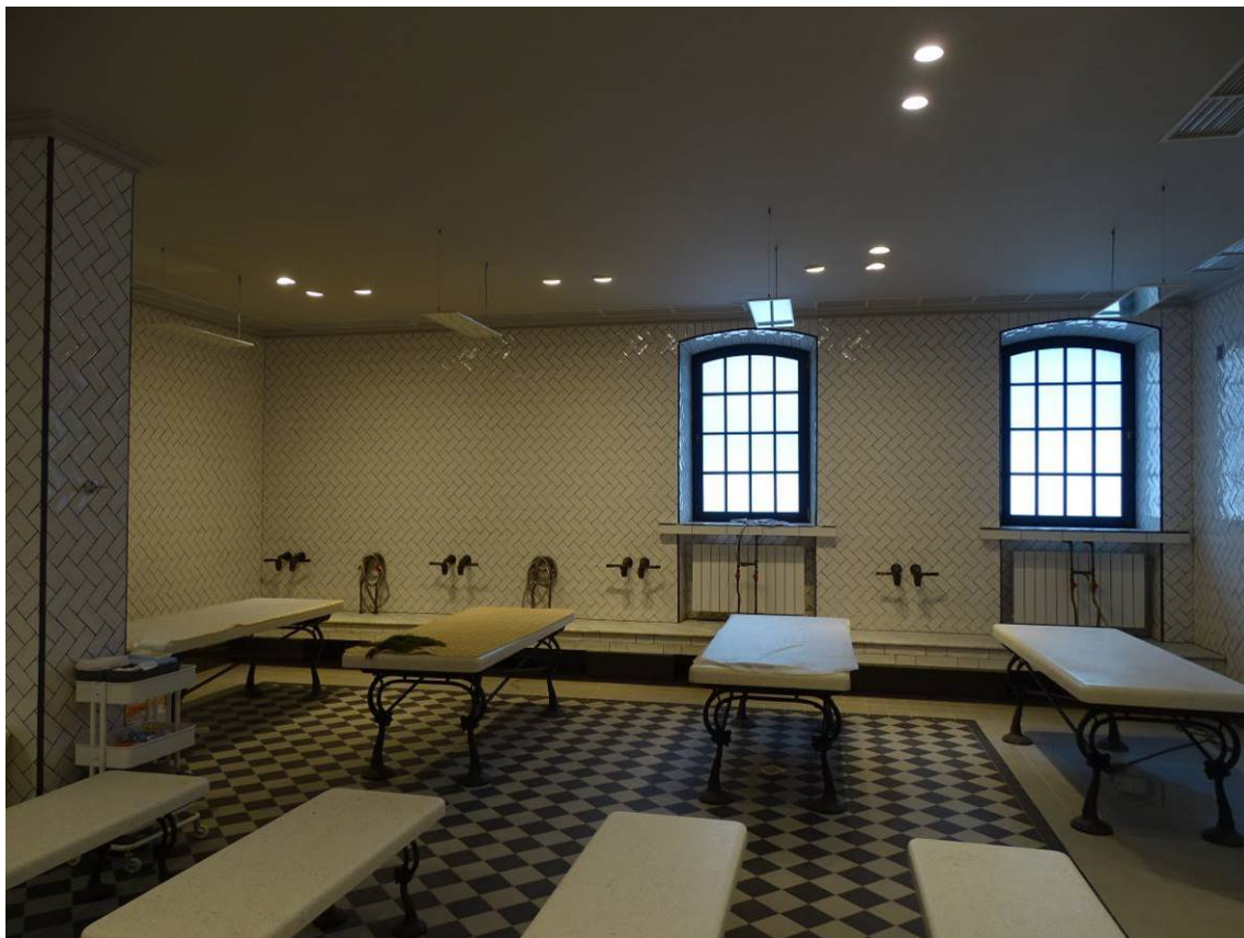
Илл. 32. 2-й этаж. Помещение 21/197,3; 22/3,9. Съемка 14.02.2022 г. Трушковский В. Э.
