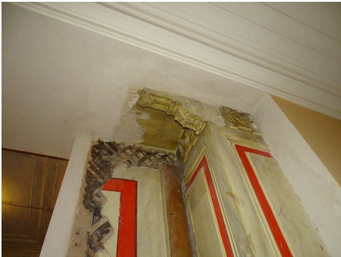
Илл. 10. 1-й этаж. Помещение 6/20,7. Съемка 14.02.2022 г. Трушковский В. Э.
