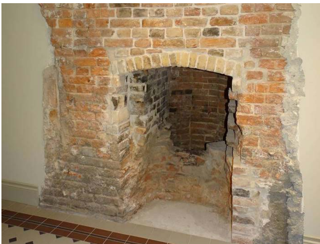
Илл. 17. 1-й этаж. Помещение 1/57,6. Съемка 14.02.2022 г. Трушковский В. Э.
