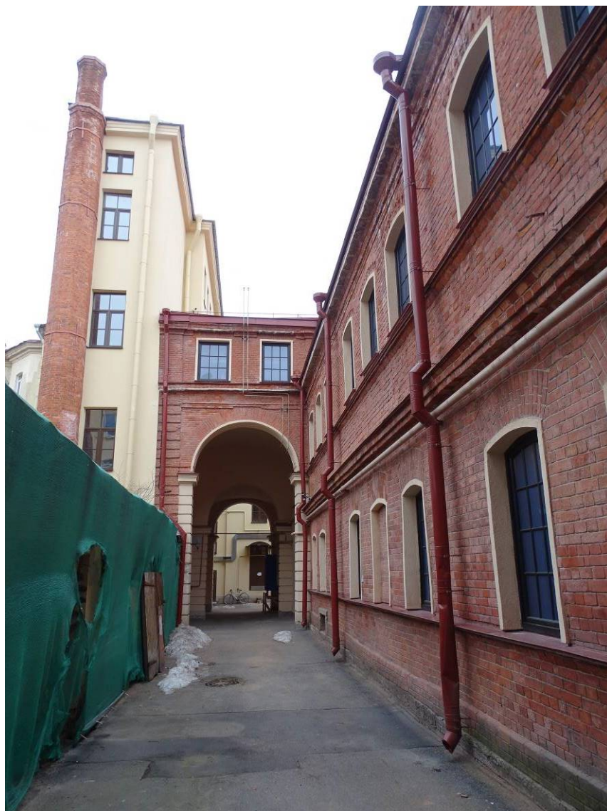
Илл. 05. Объект культурного наследия регионального значения "Воронинские бани". Вид с южной стороны на западную часть здания. Съемка 14.02.2022 г. Трушковский В. Э.
