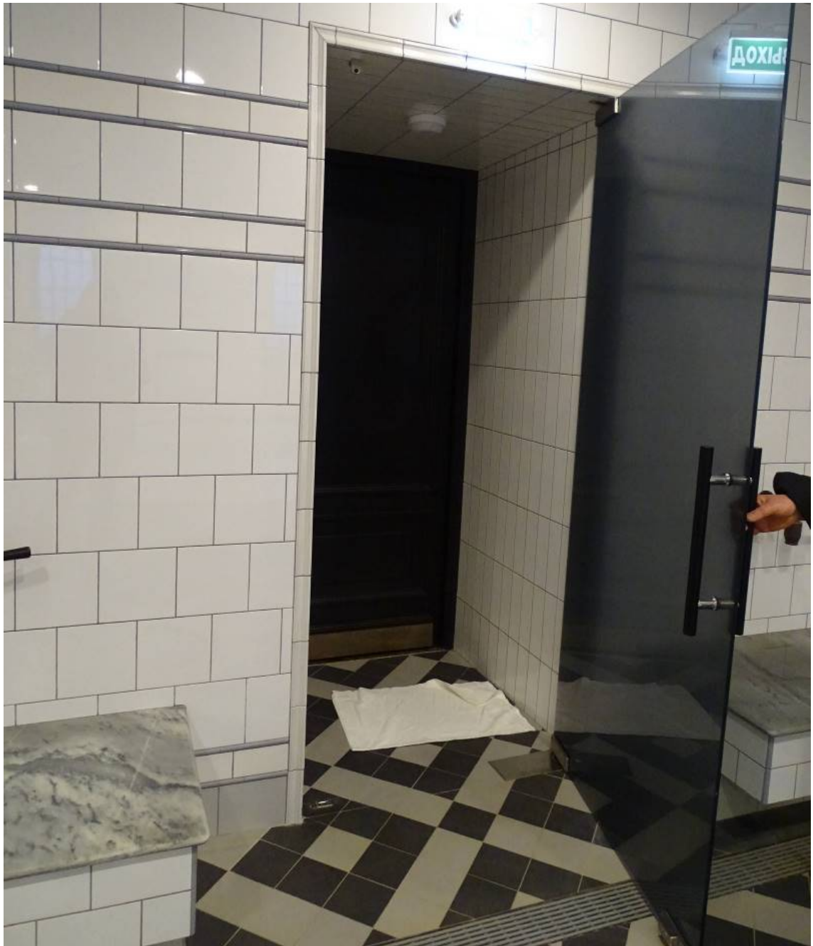
Илл. 15. 1-й этаж. Помещение 7/2,8; 8/1,5; 9/1,5; 10/216,4; 12/14,5. Съемка 14.02.2022 г. Трушковский В. Э.
