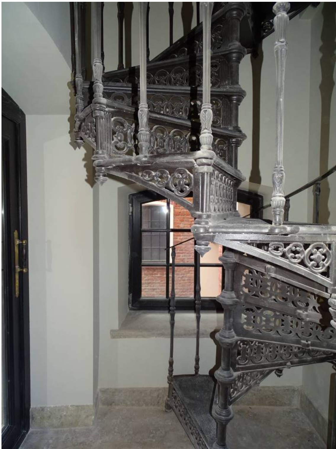
Илл. 20. 1-й этаж. Лестница IV/3,6. Съемка 14.02.2022 г. Трушковский В. Э.
