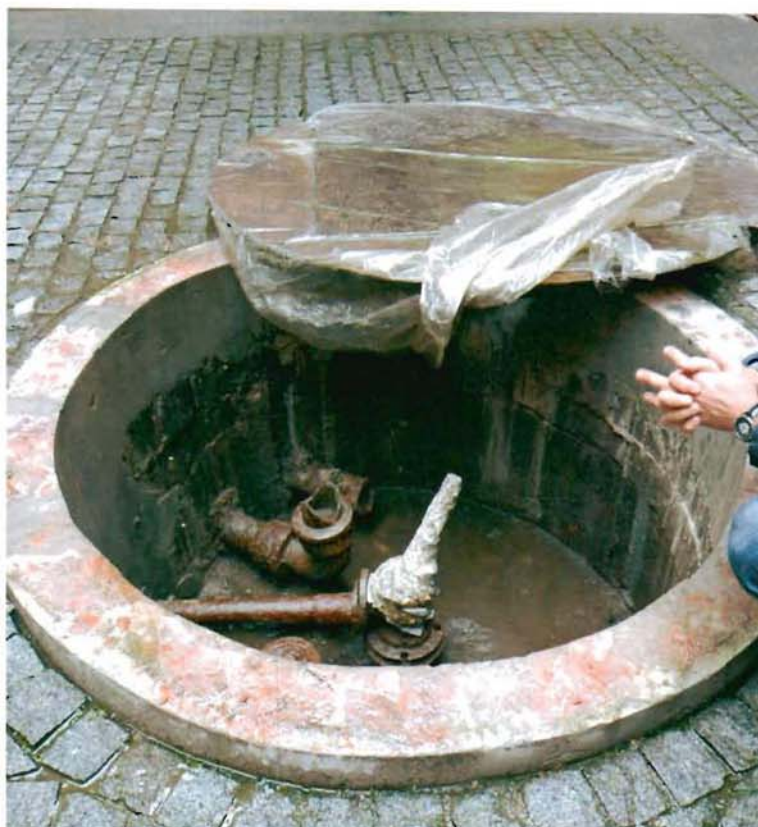
7. Скважина северо-западного внутреннего двора.
