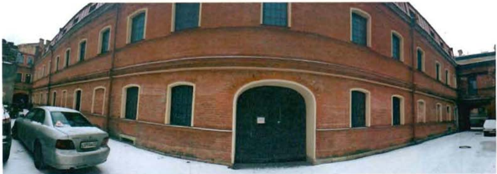
1. Южный фасад. Общий вид.
