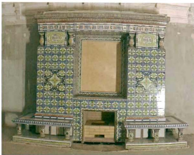
9. Печь-камин 2-го этажа этажа (исторический мужской зал).
