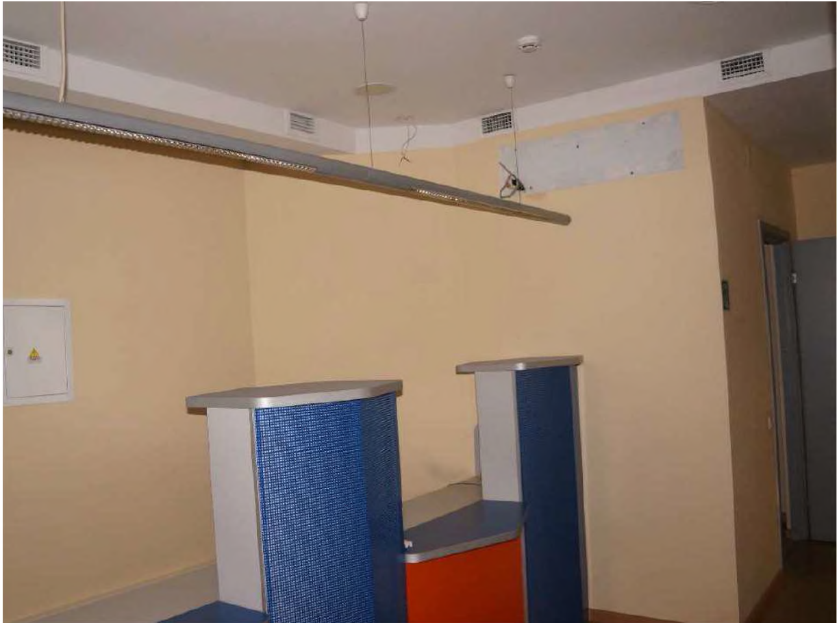
45. Вид в интерьере 1-го этажа пом. 6-Н.
