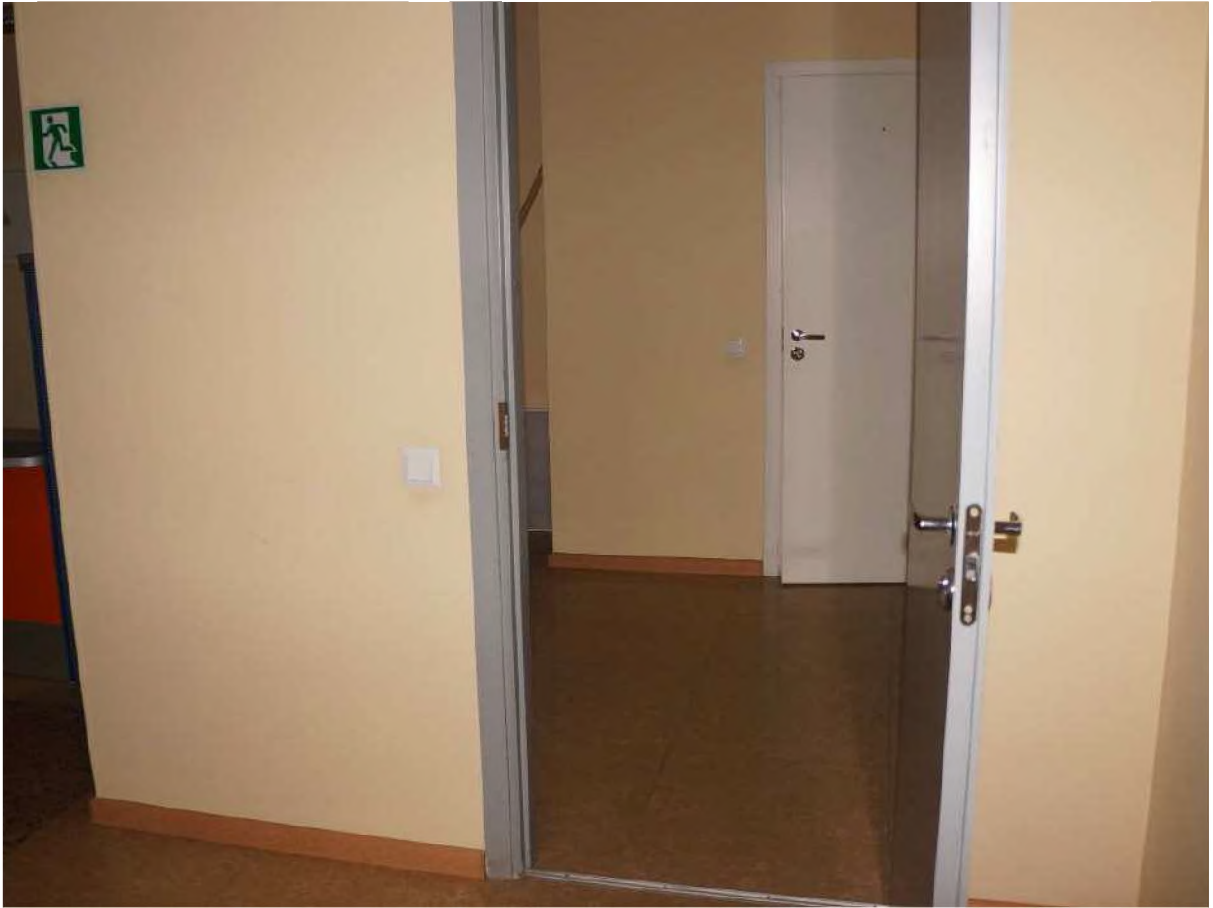
46. Вид в интерьере 1-го этажа пом. 6-Н.
