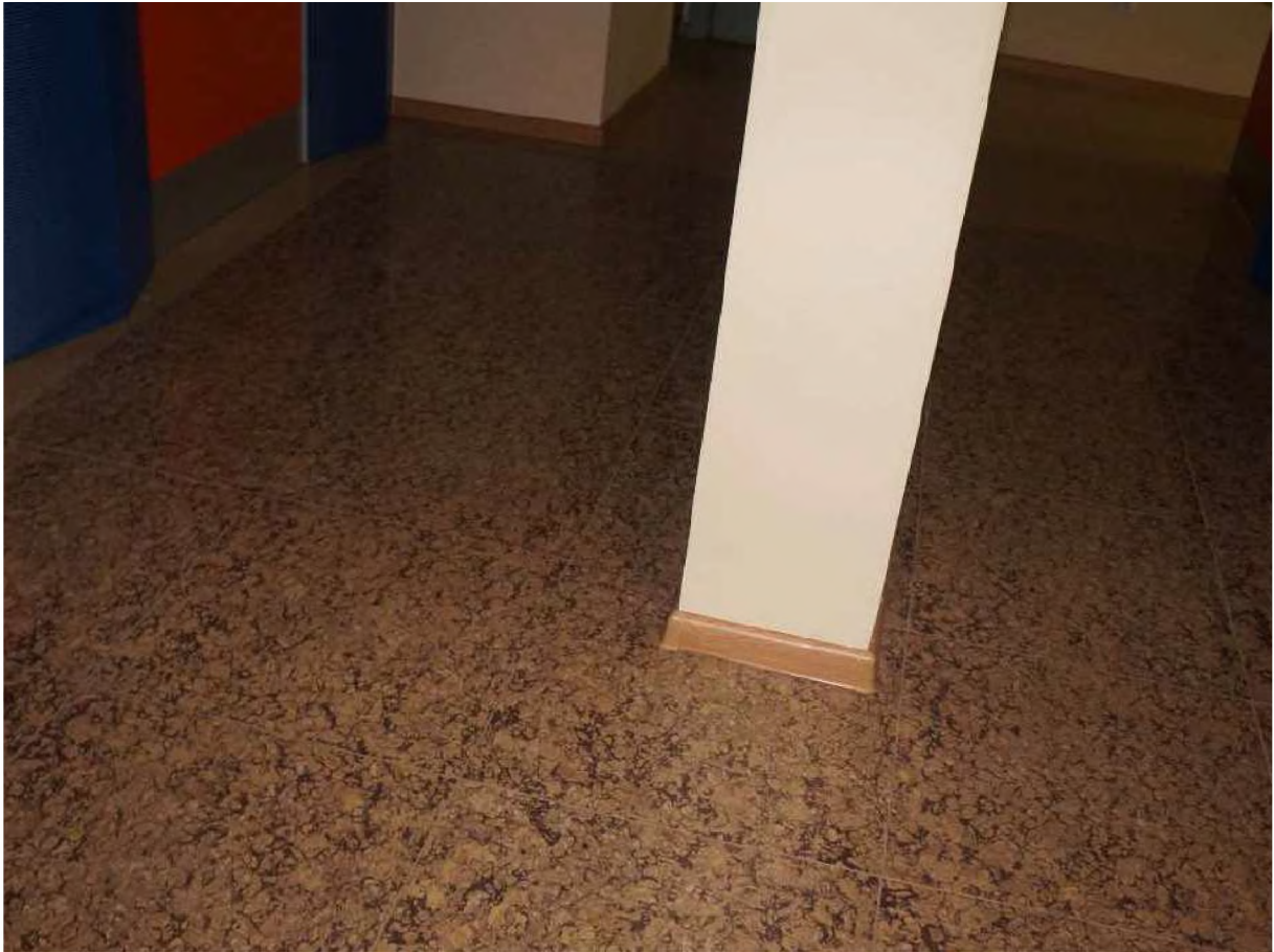
44. Вид в интерьере 1-го этажа пом. 6-Н.
