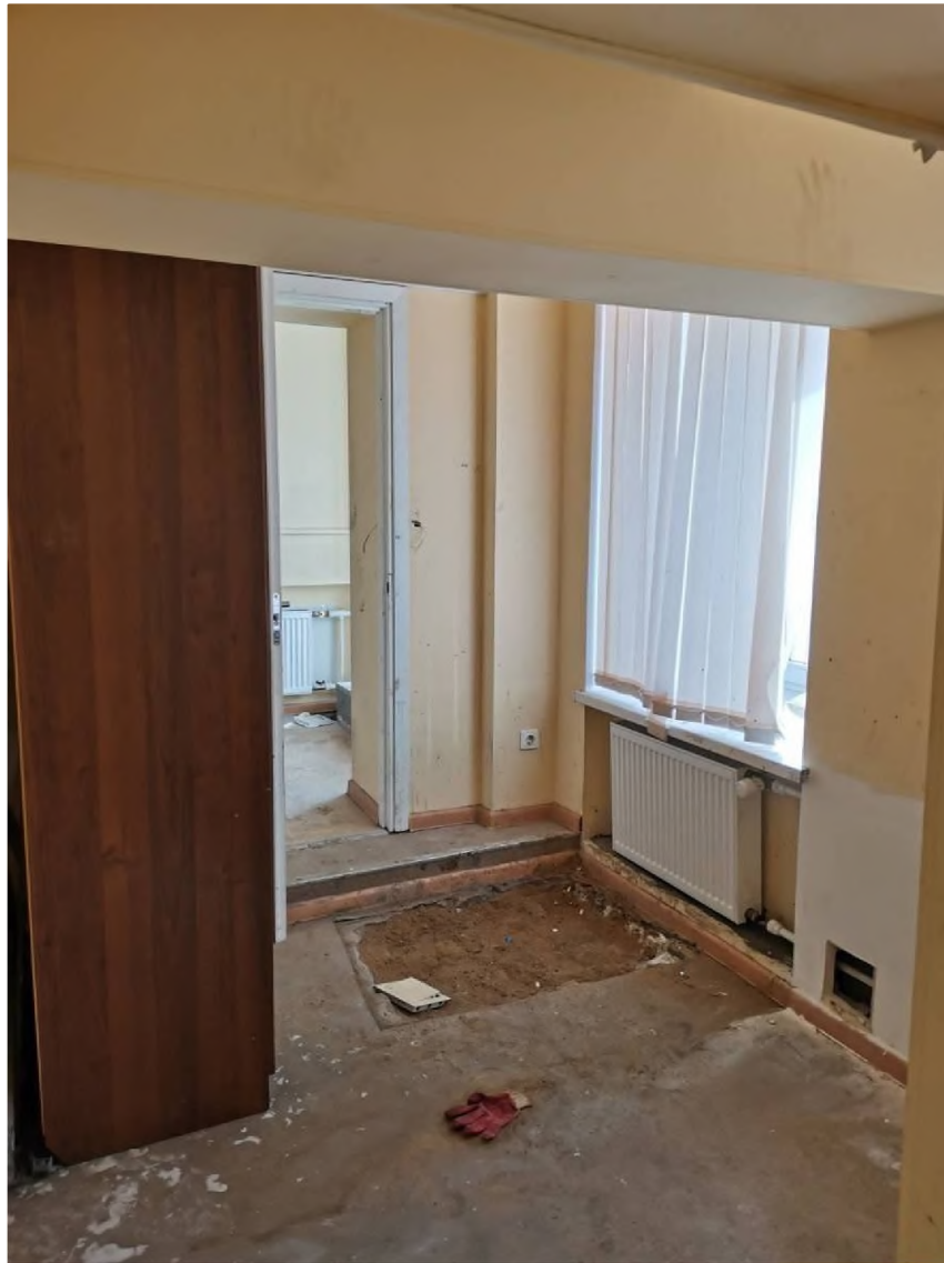
11. Вид в интерьере 1-го этажа пом. 6-Н.
