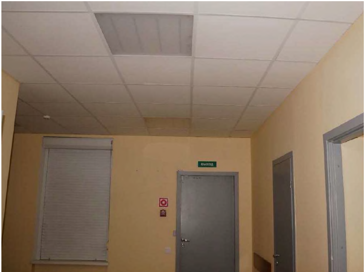
48. Вид в интерьере 1-го этажа пом. 6-Н.
