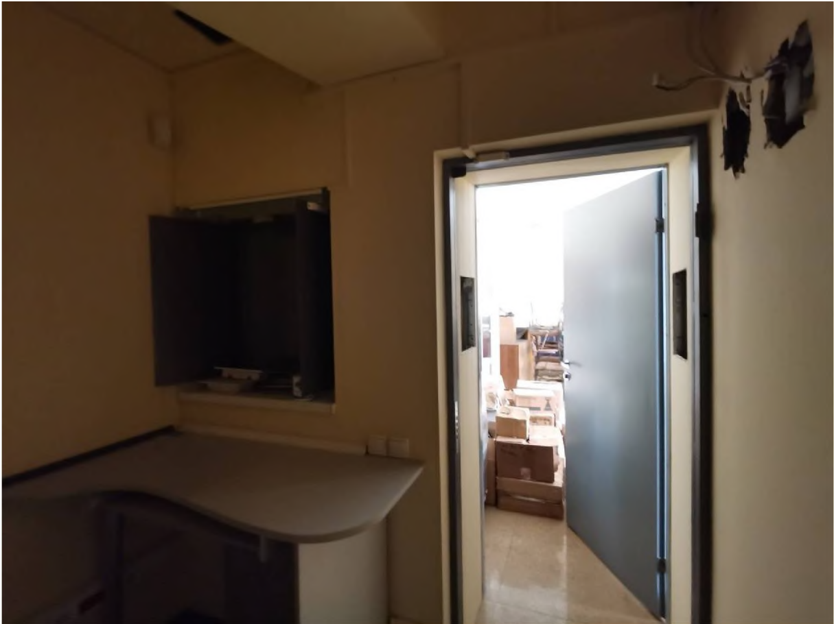
43. Вид в интерьере 1-го этажа пом. 6-Н.
