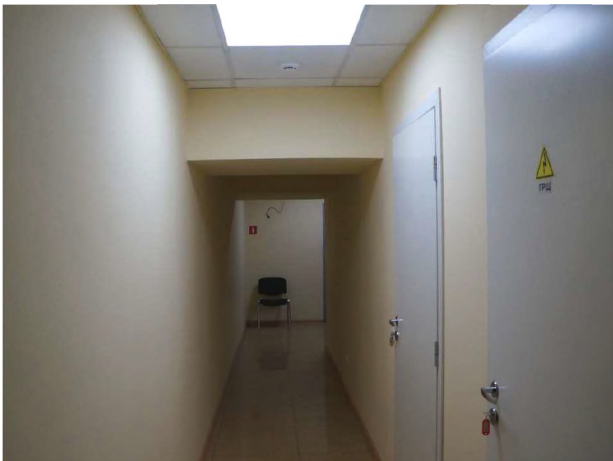
47. Вид в интерьере 1-го этажа пом. 6-Н.
