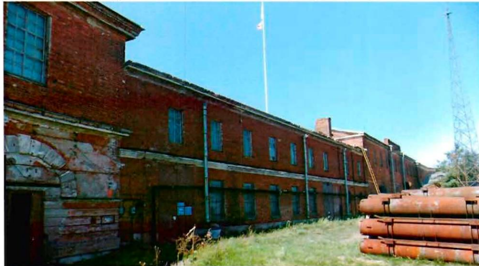
5. Правифланговая куртина с надстроенными объемами (северный фасад).
