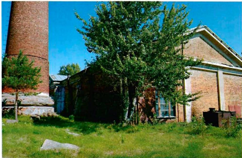
11. Котельная (западный и южный фасады).
