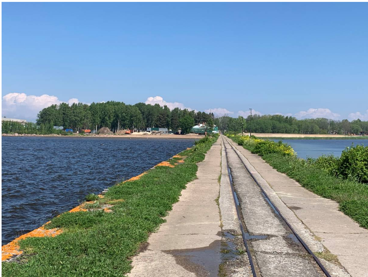
Илл. 07. Объект культурного наследия федерального значения «Форт «Петр I». Северная часть. Дамба. Съемка 09.06.2022 г. Трушковский В.Э.
