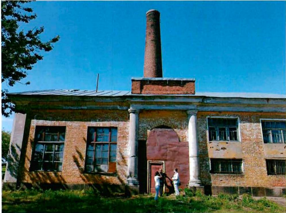
10. Котельная (восточный фасад).
