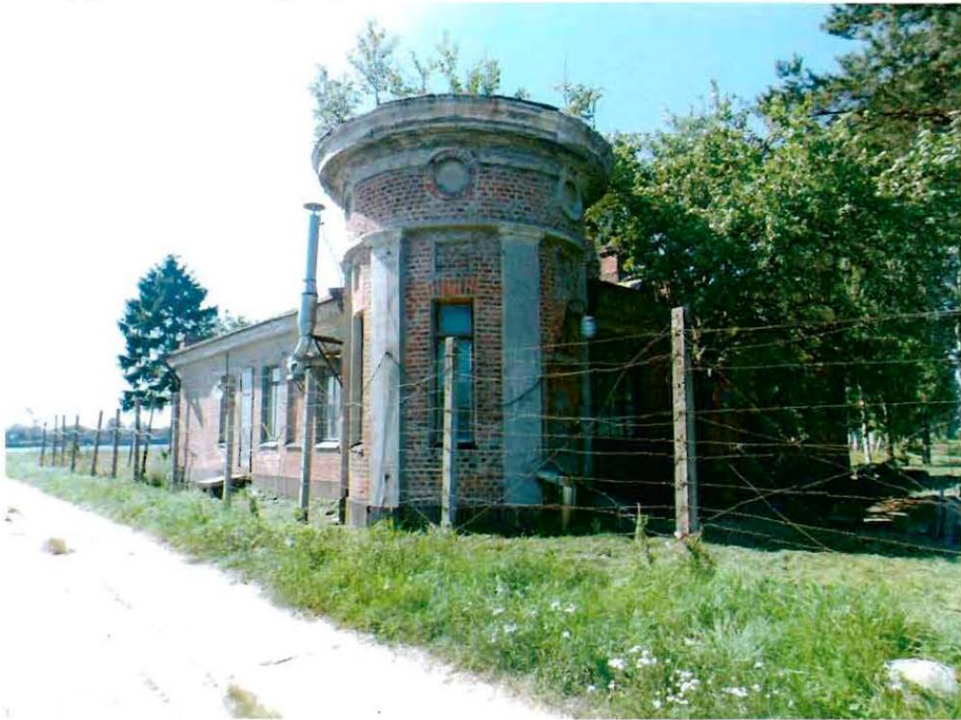
15. Караульный дом на мысу острова Котлин (башенный объем).
