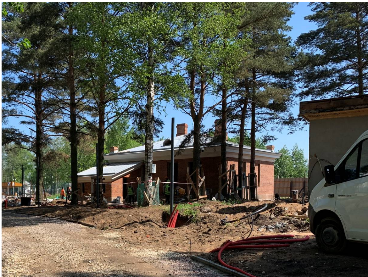
Илл. 10. Территория объекта культурного наследия федерального значения «Форт «Петр I». Здание по адресу: Санкт-Петербург, город Кронштадт, Цитадельское шоссе, дом 18, строение 7. Съемка 09.06.2022 г. Трушковский В.Э.
