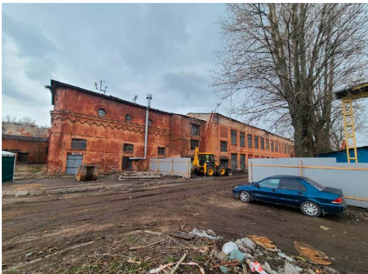
3. Вид на объект культурного наследия регионального значения «Прокатная и сталелитейная мастерская «Невского железоделательного, механического и корабельного завода» («Невского железопрокатного завода» П.Ф. Семянникова и В.А. Полетики)», расположенного по адресу: г. Санкт-Петербург, проспект Обуховской Обороны, дом 38, лит. В, от зоны производства работ. 10.05.2022
