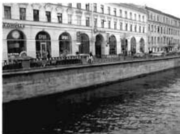
3. Сохранившийся фрагмент известняковой облицовки у Казанского моста (левый берег)
