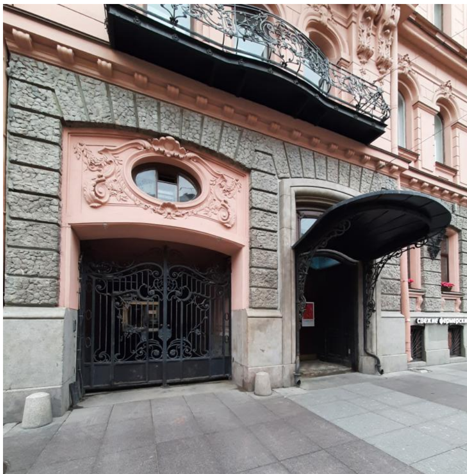
Фото 2 Фрагмент лицевого фасада выявленного объекта культурного наследия «Дом Ю.Б. Бака», воротный проезд и парадный вход
