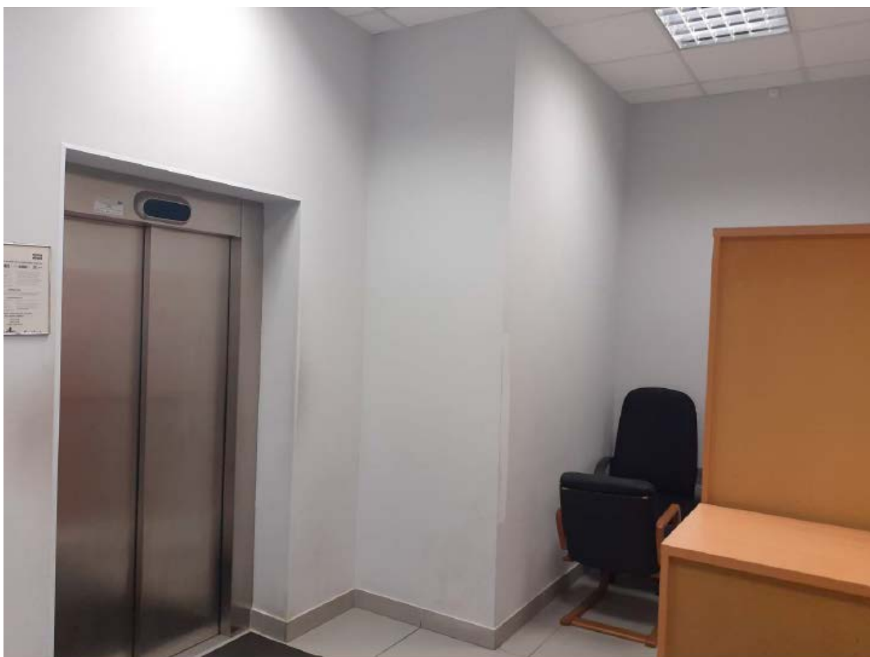
4. Помещение холла №52 объекта культурного наследия регионального значения «Комплекс казарм Семеновского и Егерского полков. Солдатская казарма»
