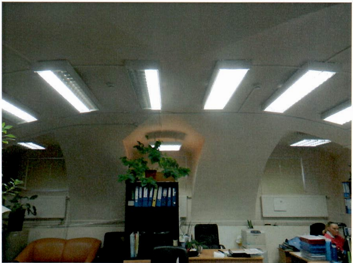
Фото №9. Сводчатые перекрытия цокольного этажа.
