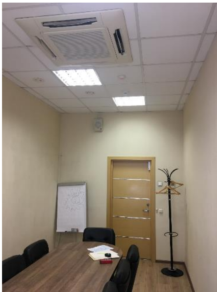
35. Помещение №20 объекта культурного наследия регионального значения «Комплекс казарм Семеновского и Егерского полков. Солдатская казарма». 23.11.2020.
