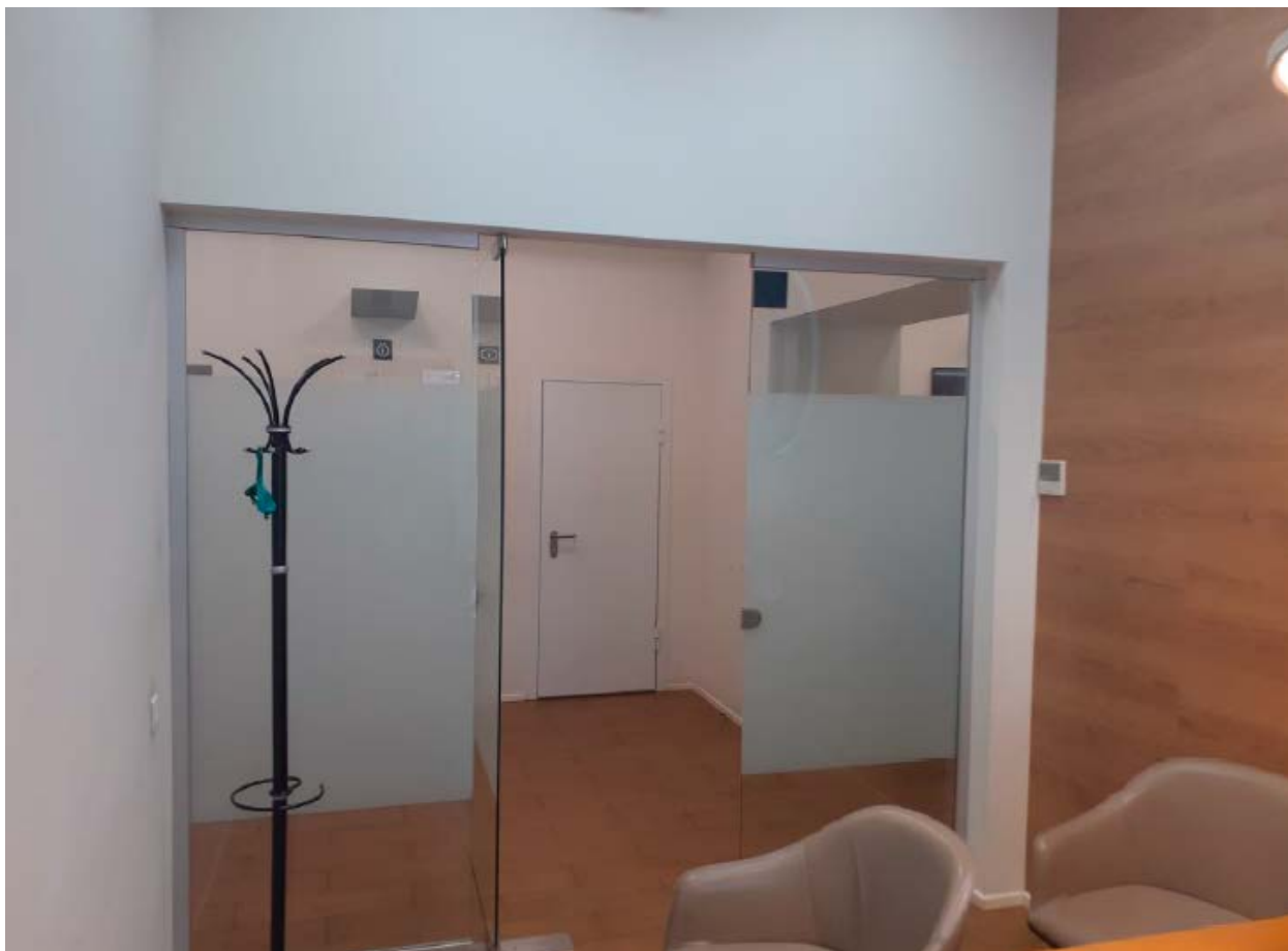
12. Помещение №49 объекта культурного наследия регионального значения «Комплекс казарм Семеновского и Егерского полков. Солдатская казарма» расположенного по адресу: г. Санкт-Петербург, Звенигородская ул., д. 3, литера А. 23.11.2020.
