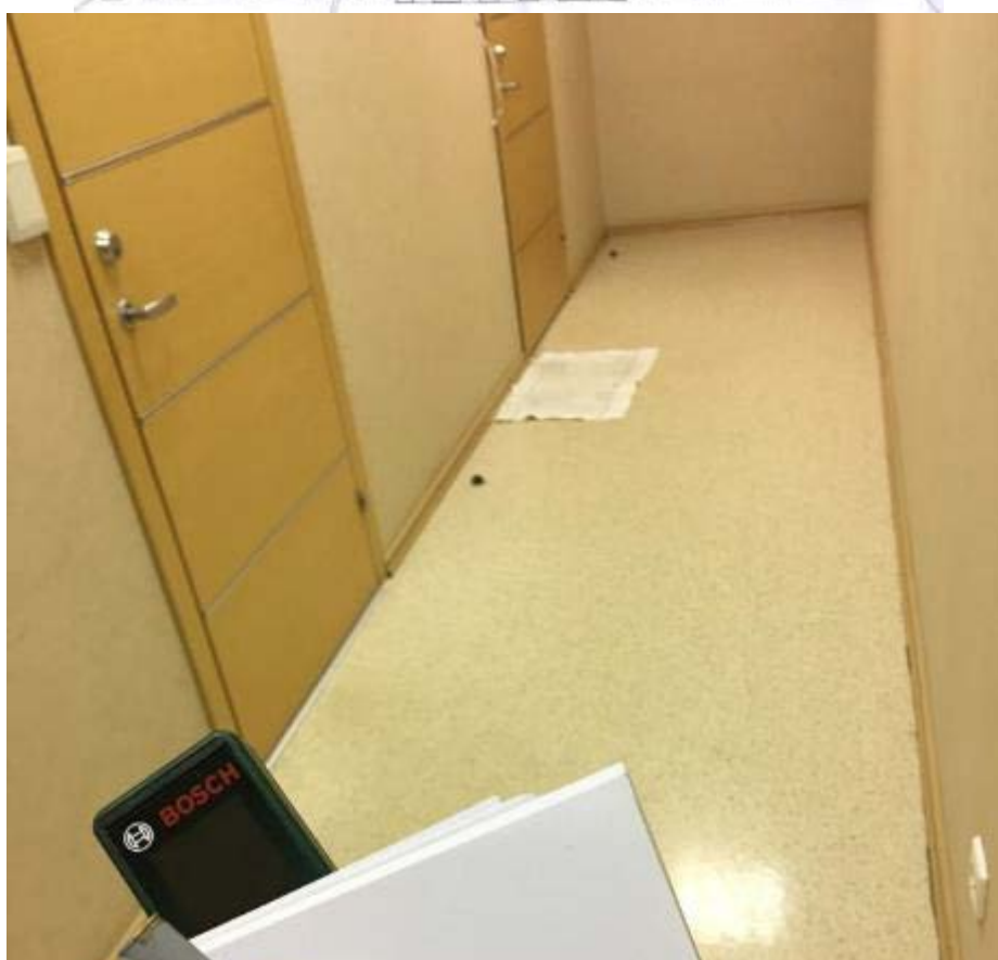
36. Помещение №17 объекта культурного наследия регионального значения «Комплекс казарм Семеновского и Егерского полков. Солдатская казарма». 23.11.2020.
