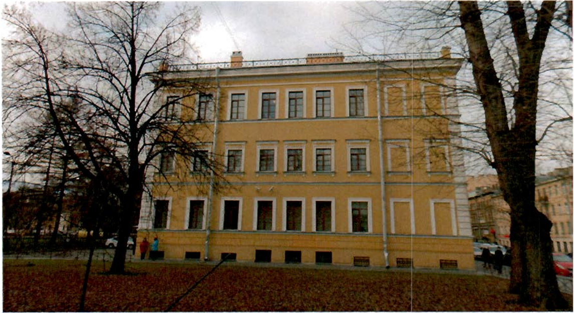
Фото №5. Торцевой (юго-восточный) фасад.
