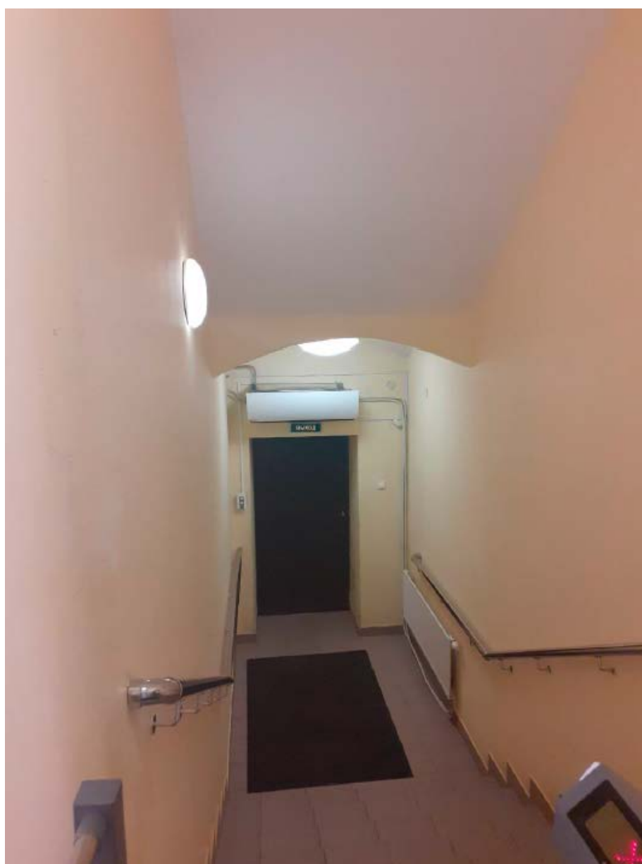
1. Лестничная клетка Л2 объекта культурного наследия регионального значения «Комплекс казарм Семеновского и Егерского полков. Солдатская казарма» расположенного по адресу: г. Санкт-Петербург, Звенигородская ул., д. 3, литера А. 23.11.2020.
