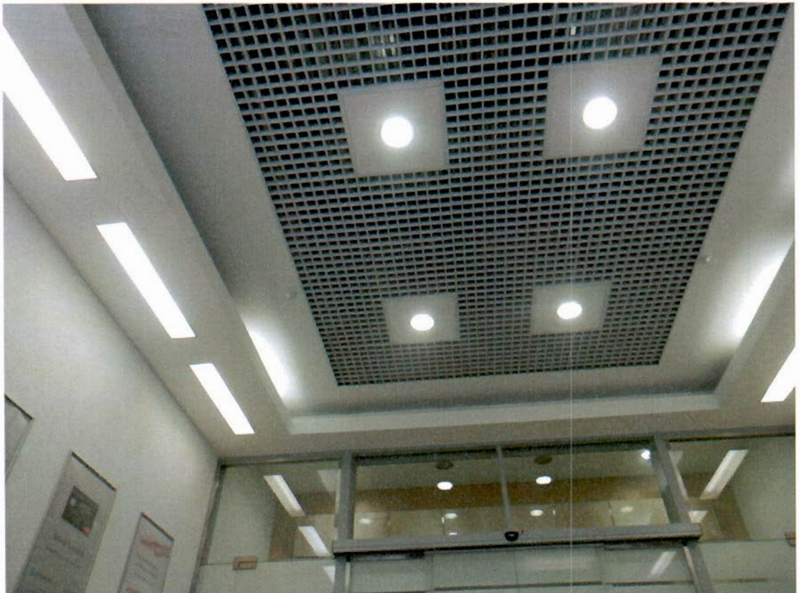
Фото №12. Перекрытие тамбура 1-го этажа.
