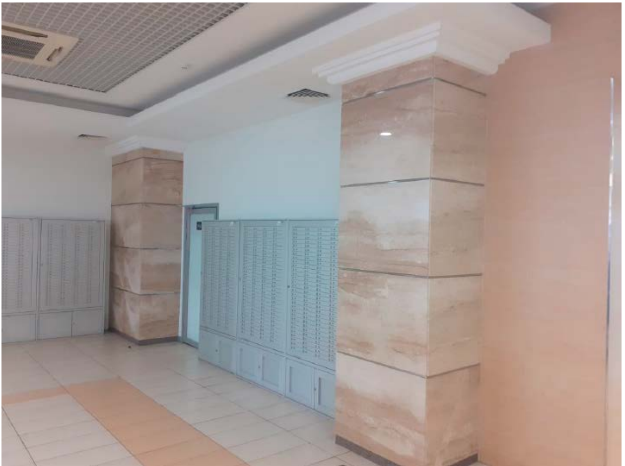
7. Помещение холла №37 объекта культурного наследия регионального значения «Комплекс казарм Семеновского и Егерского полков. Солдатская казарма» расположенного по адресу: г. Санкт-Петербург, Звенигородская ул., д. 3, литера А. 23.11.2020.
