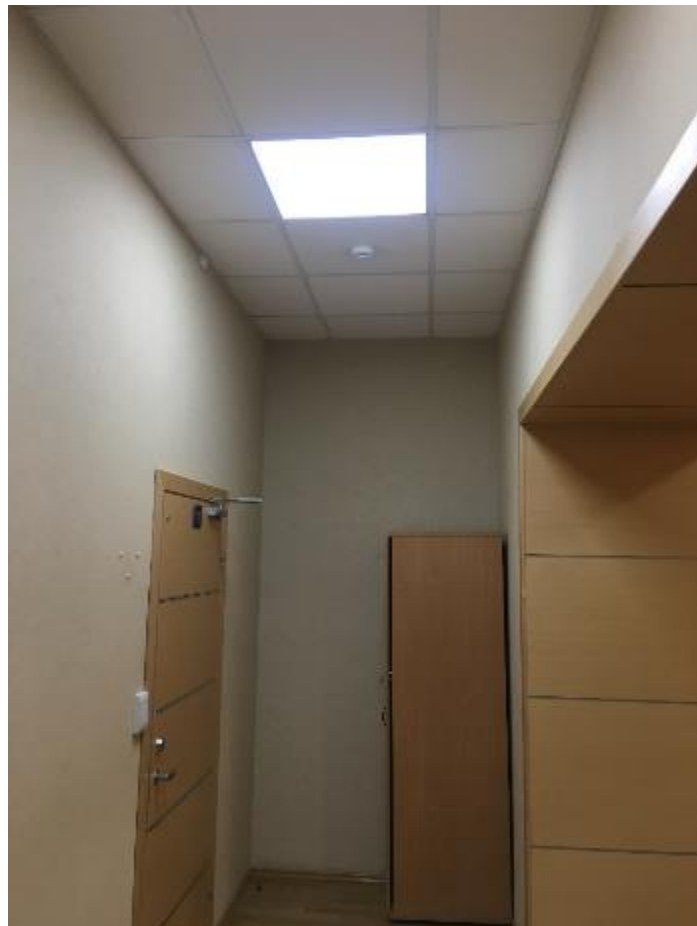
39. Помещение №10 объекта культурного наследия регионального значения «Комплекс казарм Семеновского и Егерского полков. Солдатская казарма». 23.11.2020.
