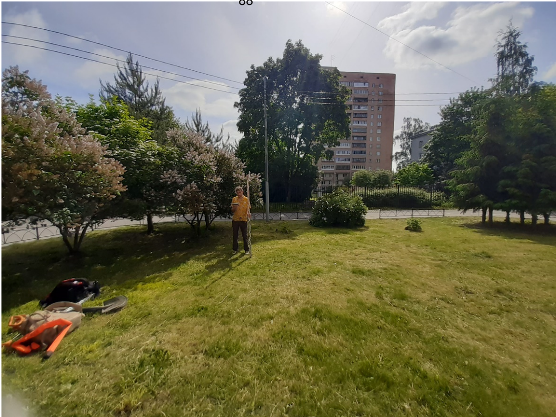
Рис. 29. Санкт-Петербург, «Выполнение проектно-изыскательских работ по реконструкции водопроводной магистрали по адресу: Санкт-Петербург, пр. Непокоренных, д. 49 (от ул. Бутлерова д.4 до Гражданского пр.)». Шурф 1. Общий вид до начала работ. Вид на восток.
