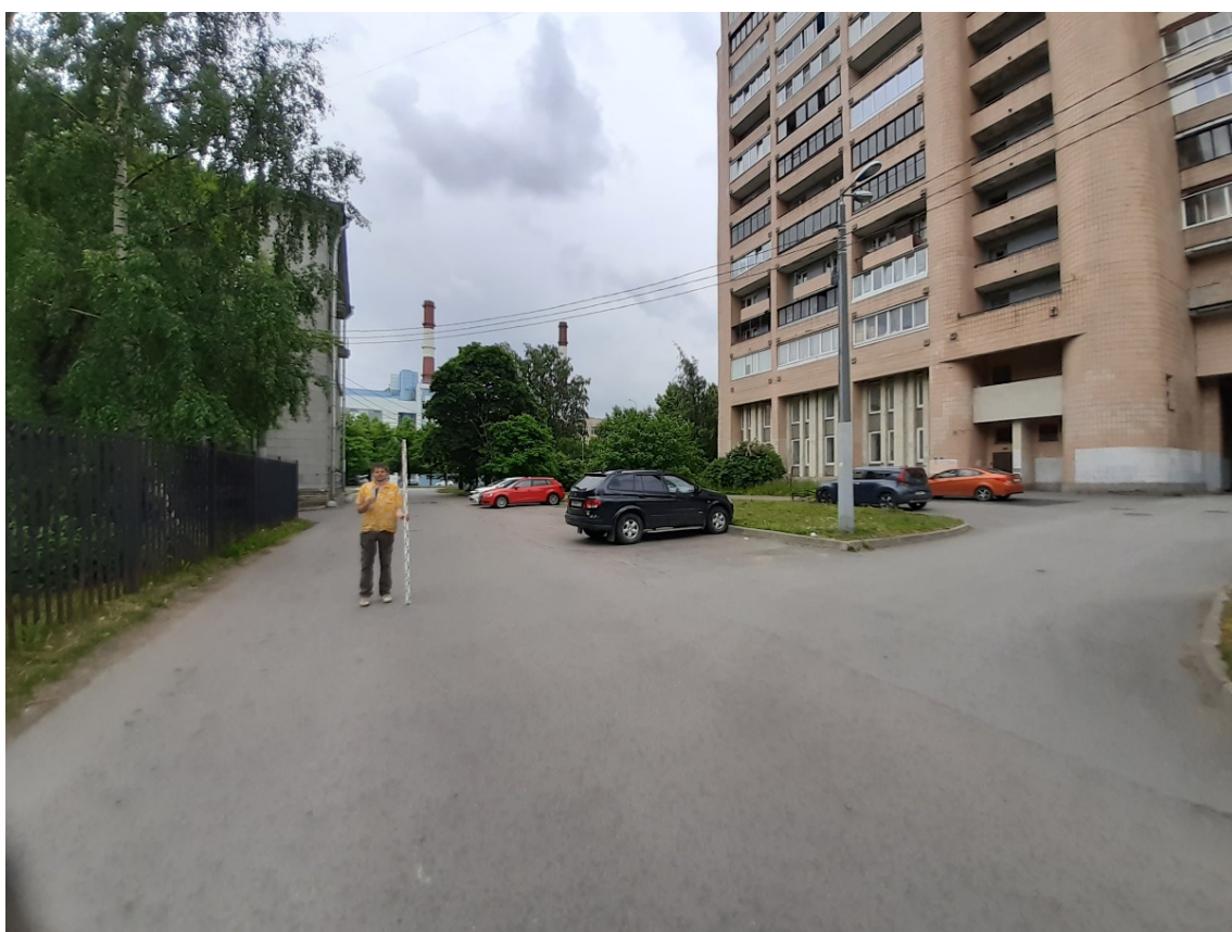
Рис. 24. Санкт-Петербург, «Выполнение проектно-изыскательских работ по реконструкции водопроводной магистрали по адресу: Санкт-Петербург, пр. Непокоренных, д. 49 (от ул. Бутлерова д.4 до Гражданского пр.)». Общий вид трассы. Точка съемки 4. Вид на юг.
