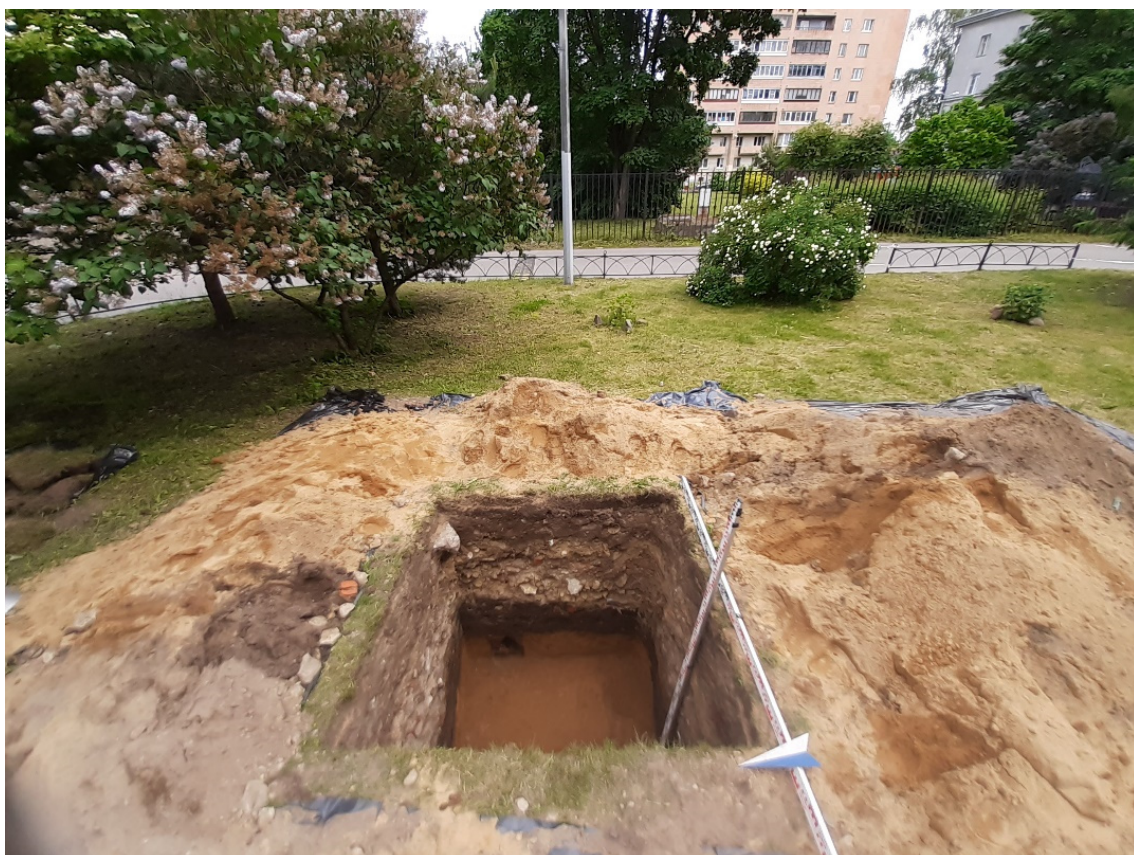
Рис. 38. Санкт-Петербург, «Выполнение проектно-изыскательских работ по реконструкции водопроводной магистрали по адресу: Санкт-Петербург, пр. Непокоренных, д. 49 (от ул. Бутлерова д.4 до Гражданского пр.)» Шурф 1. Общий вид на восток
