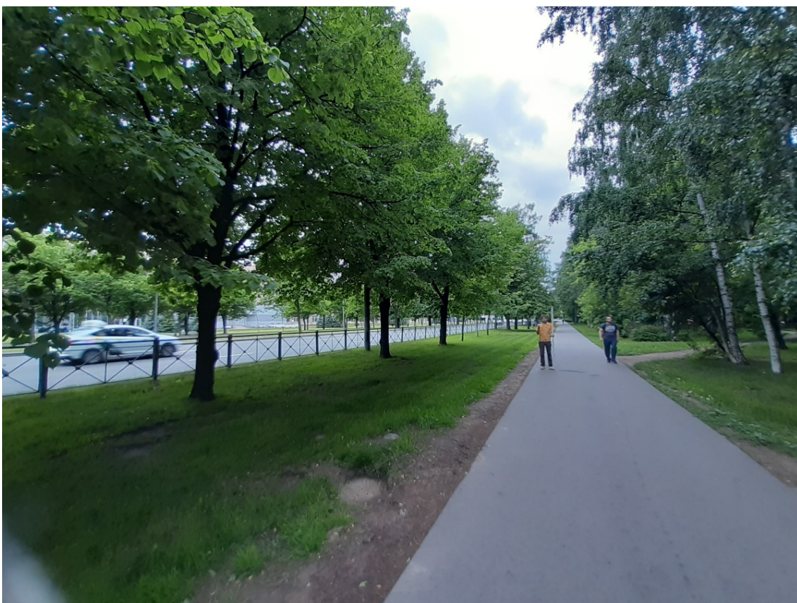
Рис. 26. Санкт-Петербург, «Выполнение проектно-изыскательских работ по реконструкции водопроводной магистрали по адресу: Санкт-Петербург, пр. Непокоренных, д. 49 (от ул. Бутлерова д.4 до Гражданского пр.)». Общий вид трассы. Точка съемки 6. Вид на юго-запад.
