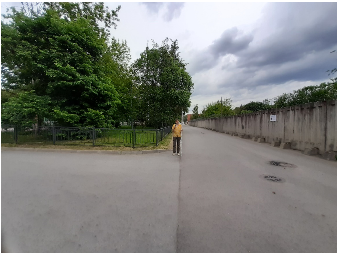
Рис. 22. Санкт-Петербург, «Выполнение проектно-изыскательских работ по реконструкции водопроводной магистрали по адресу: Санкт-Петербург, пр. Непокоренных, д. 49 (от ул. Бутлерова д.4 до Гражданского пр.)». Общий вид трассы. Точка съемки 2. Вид на север.
