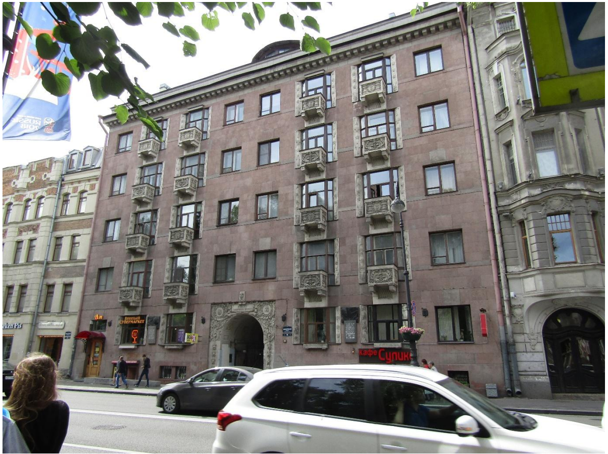
Рис. 1 Общий вид фасада
