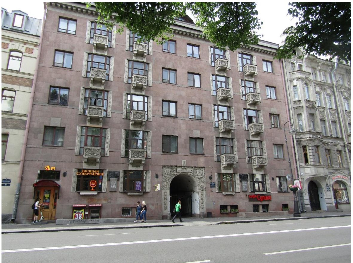
Рис. 2 Общий вид фасада
