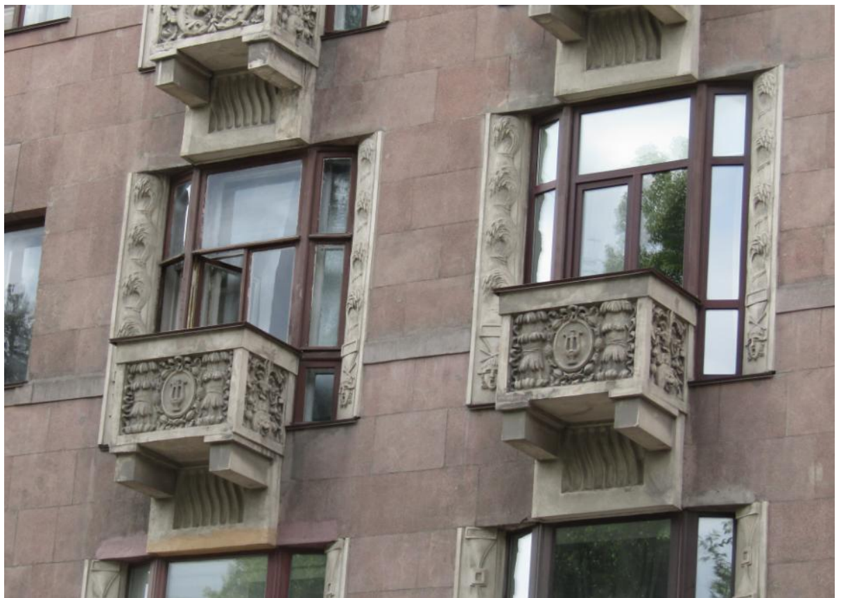
Рис. 4 Балконы со стороны лицевого фасада
