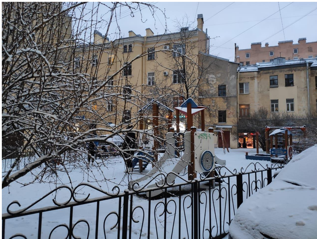
Фото №39. Внутридворовая территория. Фрагмент детской площадки. Вид с юго-востока.
