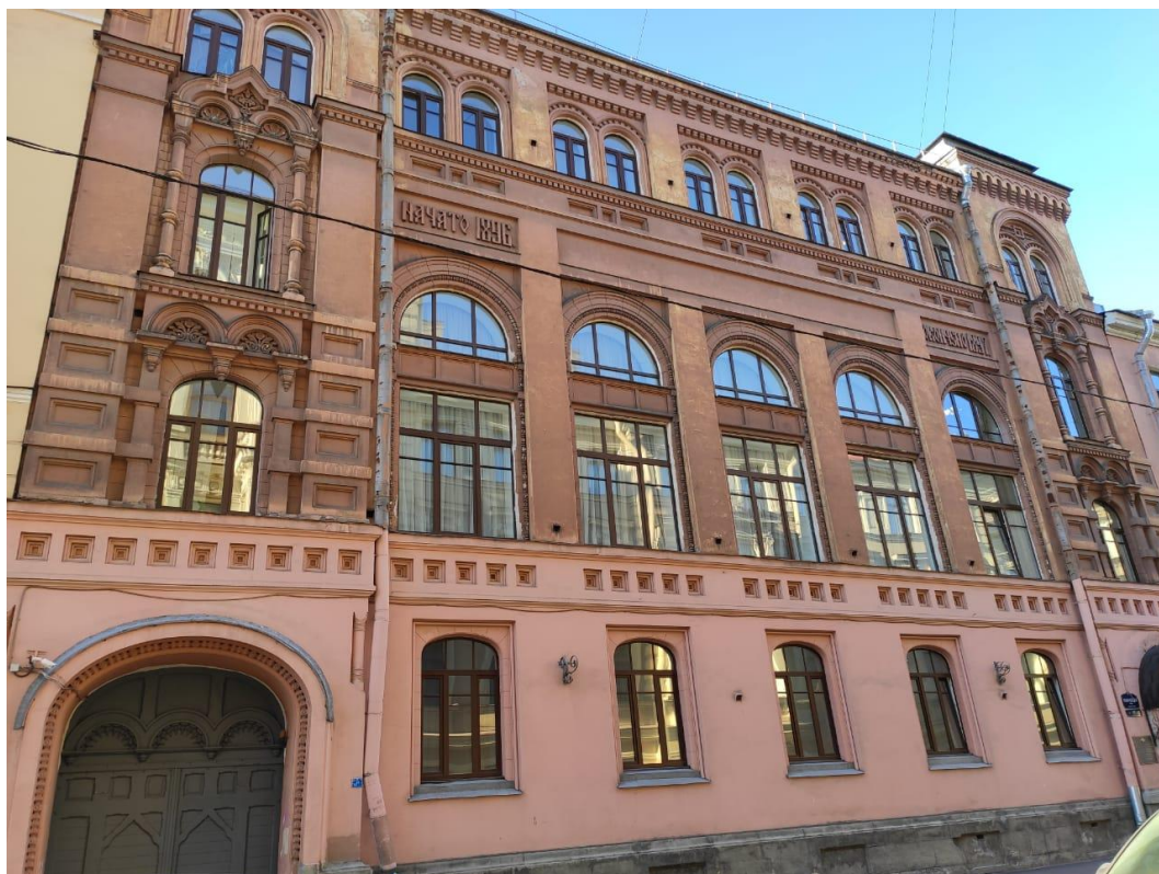
Фото №44. Лицевой фасад здания по Казначейской улице, д.11.
