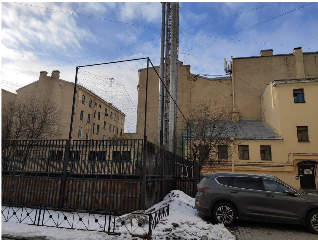
Фото №25. Внутриворобая территория. Фрагмент дворовых фасадов объектов культурного наследия «Дом по Гороховой улице» и «Дом А.Н. Шлегель».
