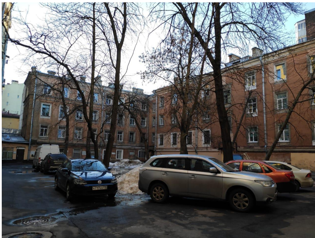
Фото №63. Фасады объекта культурного наследия «Квартирный флигель» в составе объекта культурного наследия «Здание Главного управления путей сообщения и публичных зданий». Вид с востока.
