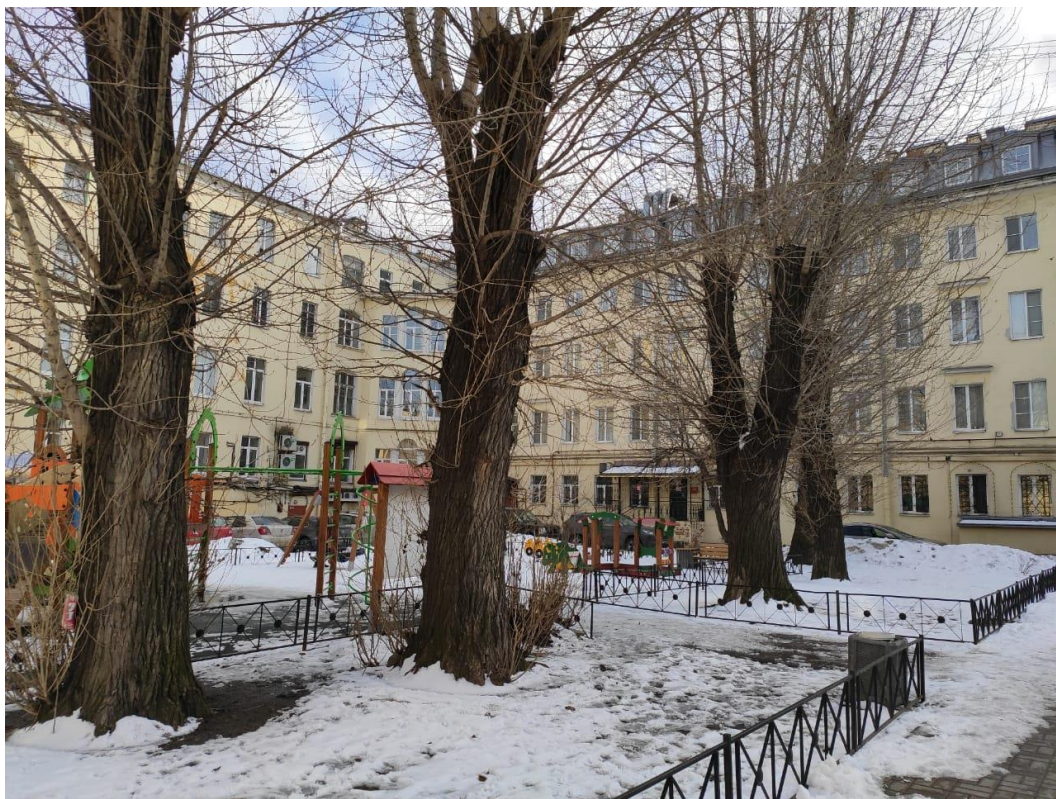
Фото №22. Дворовой фасад объекта культурного наследия «Дом по Садовой улице» в составе объекта «Дома Дурышкина»
