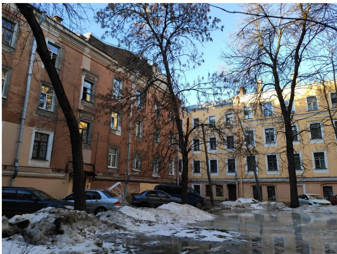
Фото №64. Фасады объекта культурного наследия «Квартирный флигель» в составе объекта культурного наследия «Здание Главного управления путей сообщения и публичных зданий». Вид с юго-запада.
