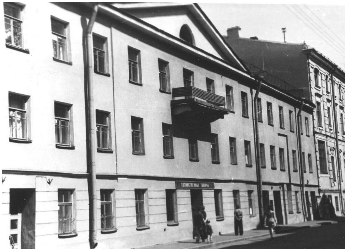
Илл. 49. Лицевые фасады здания по Казанской улице. Фото 1965-1975 годов.
