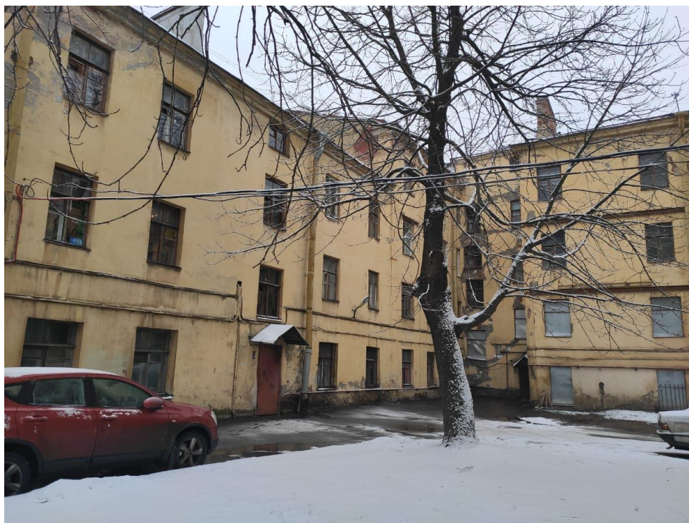
Фото №5. Внутриворобая территория. Фрагмент дворовых фасадов здания по адресу: наб.реки Мойки, д.92, лит А (не является объектом культурного наследия, граничит с проектным участком)
