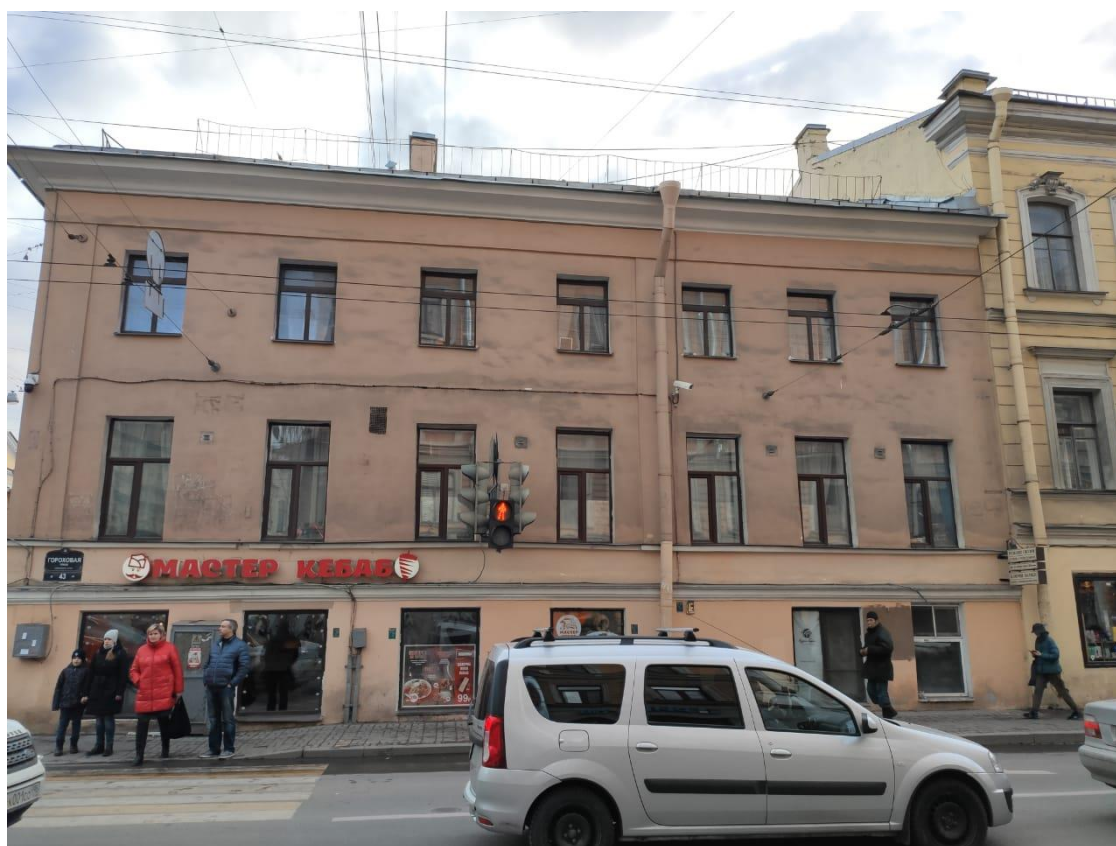
Фото №18. Лицевой фасад по Гороховой улице объекта культурного наследия «Угловой дом» в составе объекта «Дома Дурышкина»
