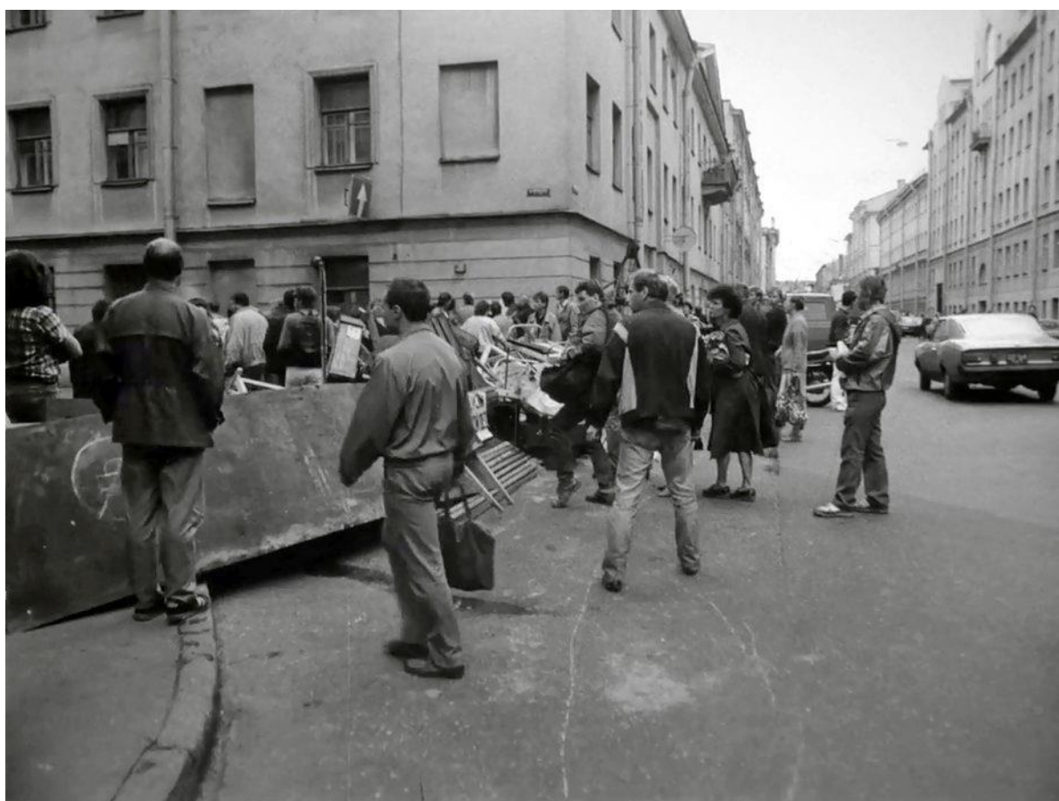
Илл. 50. Фрагмент лицевых фасадов здания по пер. Антоненко д.10. Фото 1991 года.
