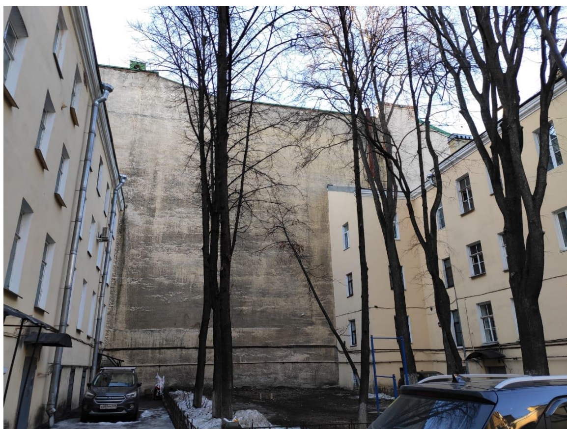
Фото №78. Внутридворовая территория. Вид на дворовой фасад (брандмауэр) объекта культурного наследия «Дворец Мариинский» с юго-востока.
