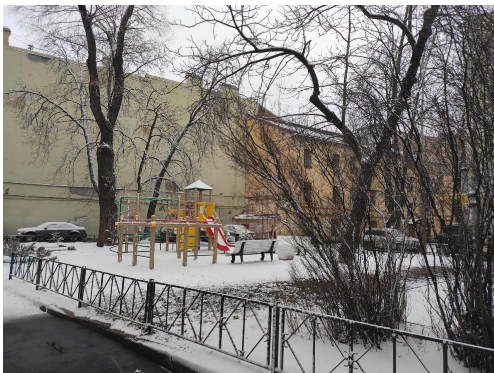
Фото №2. Внутридворовая территория. Дворовой фасад объекта культурного наследия регионального значения «Флигель».
