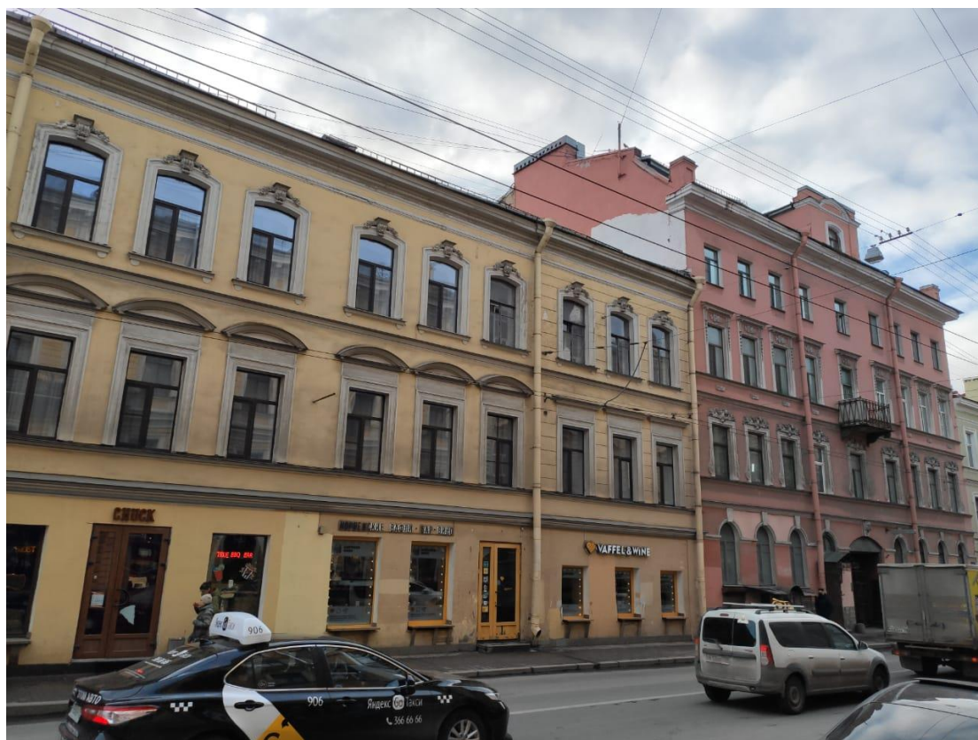
Фото №20. Лицевые фасады объектов культурного наследия «Дом по Гороховой улице» в составе объекта «Дома Дурышкина» и «Дом А.Н. Шлегель»
