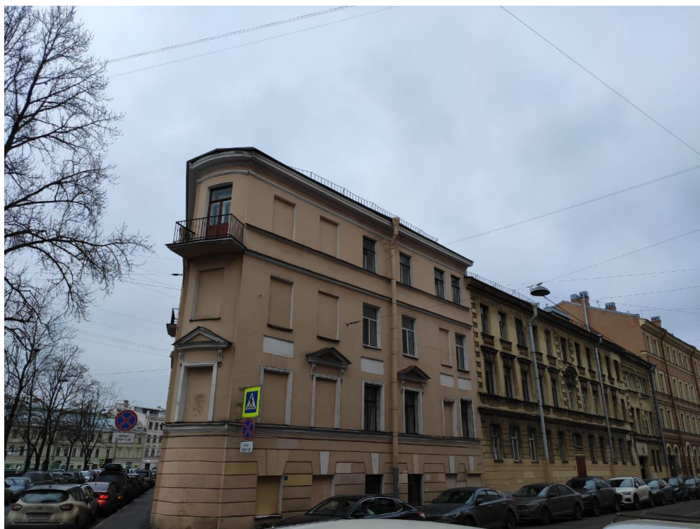
Фото №37. Лицевой фасад объекта культурного наследия «Жилой дом» по Казначейской улице.
