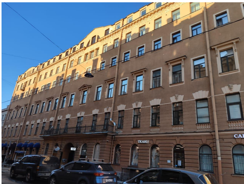
Фото №34. Лицевой фасад объекта культурного наследия «Дом Зверкова (И.С. Никитина)» по наб. кан. Грибоедова.
