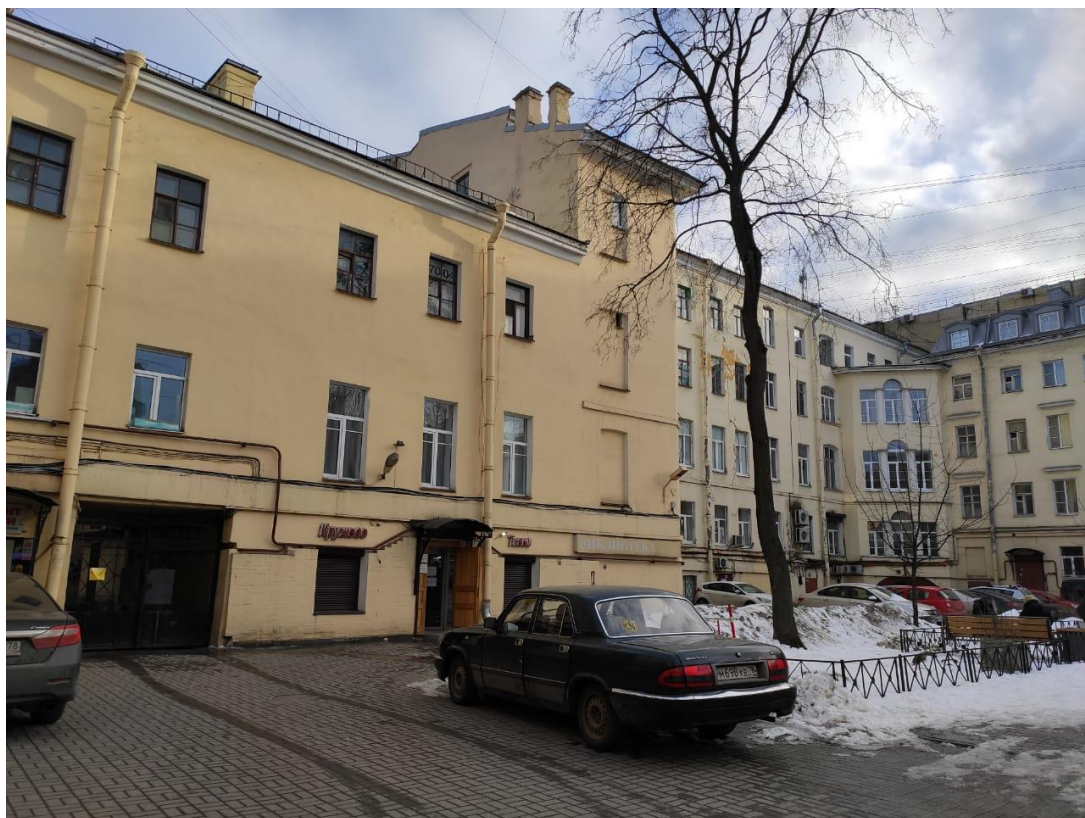
Фото №23. Дворовые фасады объектов культурного наследия «Дом по Садовой улице» и «Дом по Гороховой улице» в составе объекта «Дома Дурышкина»
