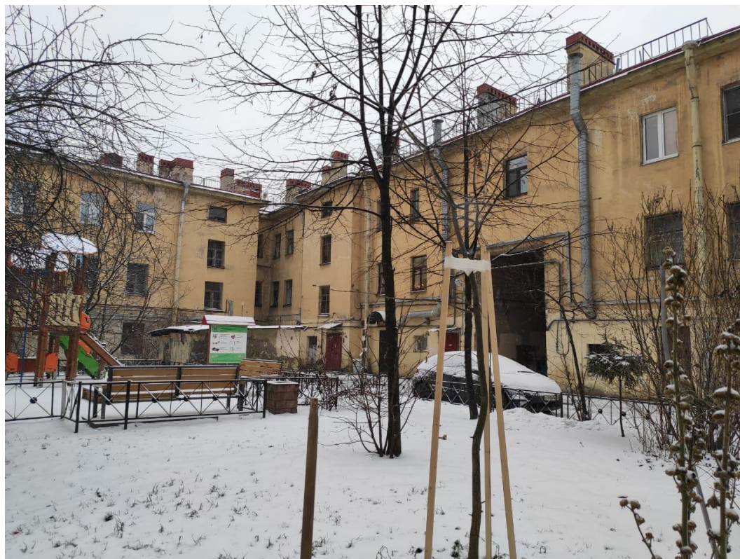
Фото №15. Внутридворовая история. Детская площадка. Фрагмент дворового фасада объекта культурного наследия «Жилой дом». Вид с юго-запада.
