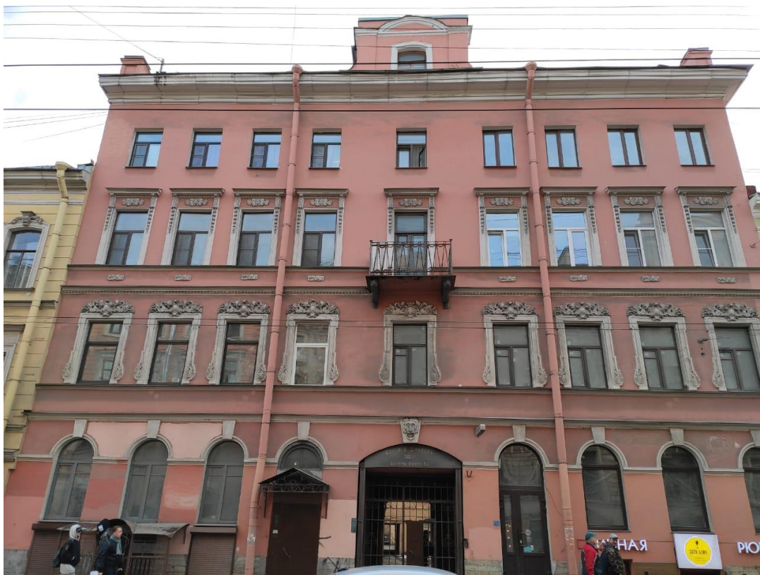
Фото №21. Лицевой фасад объекта культурного наследия «Дом А.Н. Шлегель»
