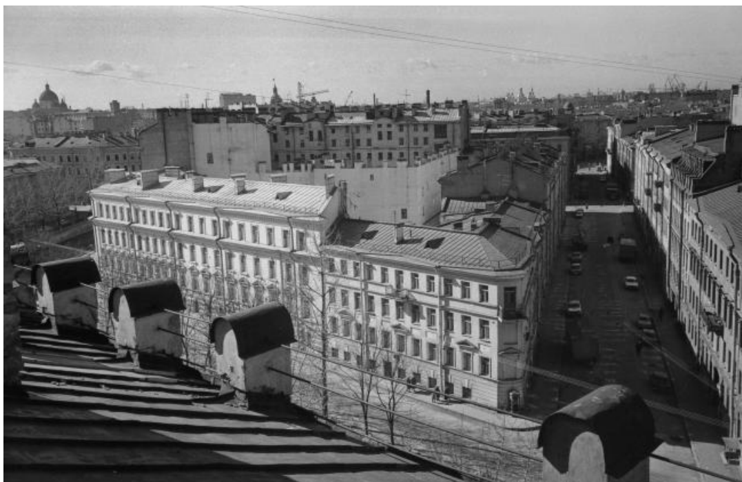
Илл. 97. Лицевые фасады здания по наб. кан. Грибоедова, д. 65-67 и здания по адресу: Казначейская улица, 2. Фото 1982-1987.
