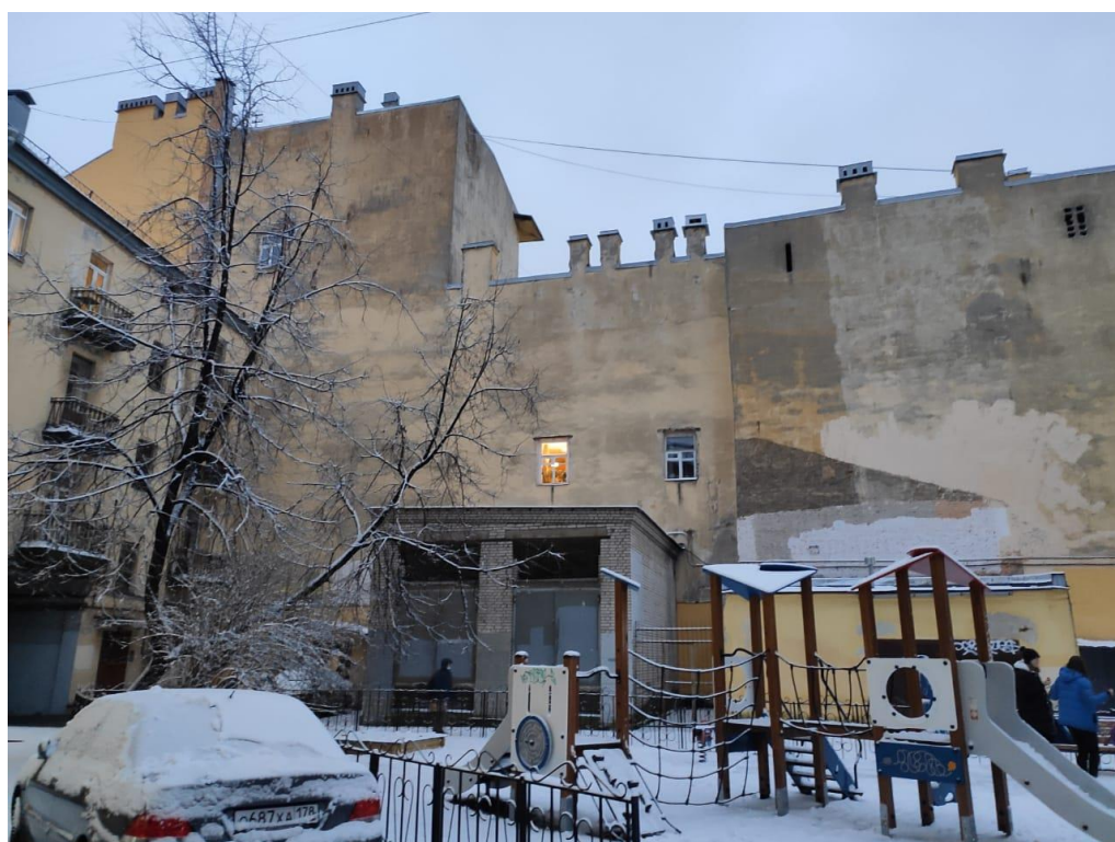
Фото №38. Внутридворовая территория. Фрагмент детской площадки. Фрагмент дворовых фасадов объекта культурного наследия «Дом Зверкова (И.С. Никитина)» по наб. кан. Грибоедова.
