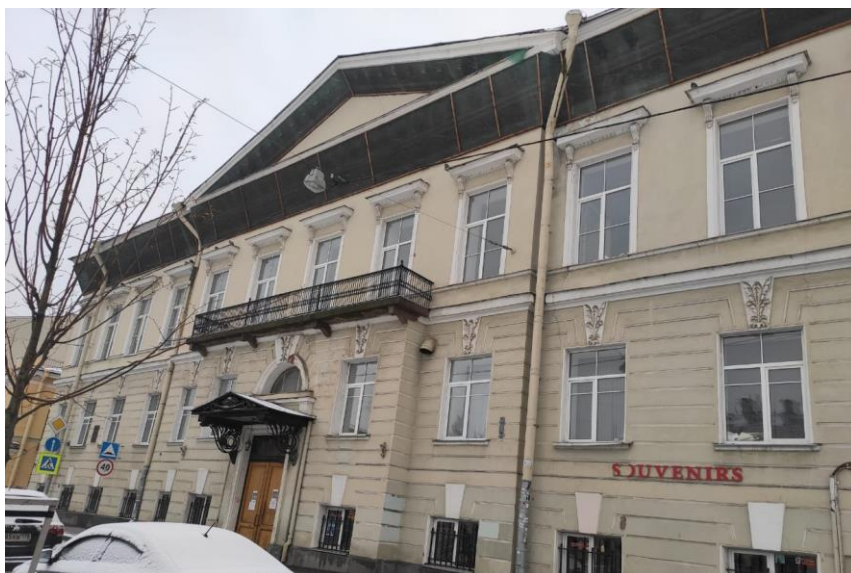
Фото №1 Лицевой фасад объекта культурного наследия регионального значения «Флигель».
