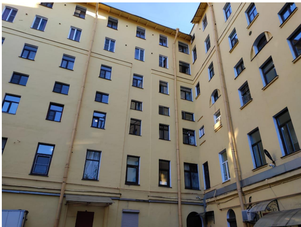
Фото №36. Дворовые фасады объекта культурного наследия «Дом Зверкова (И.С. Никитина)»
