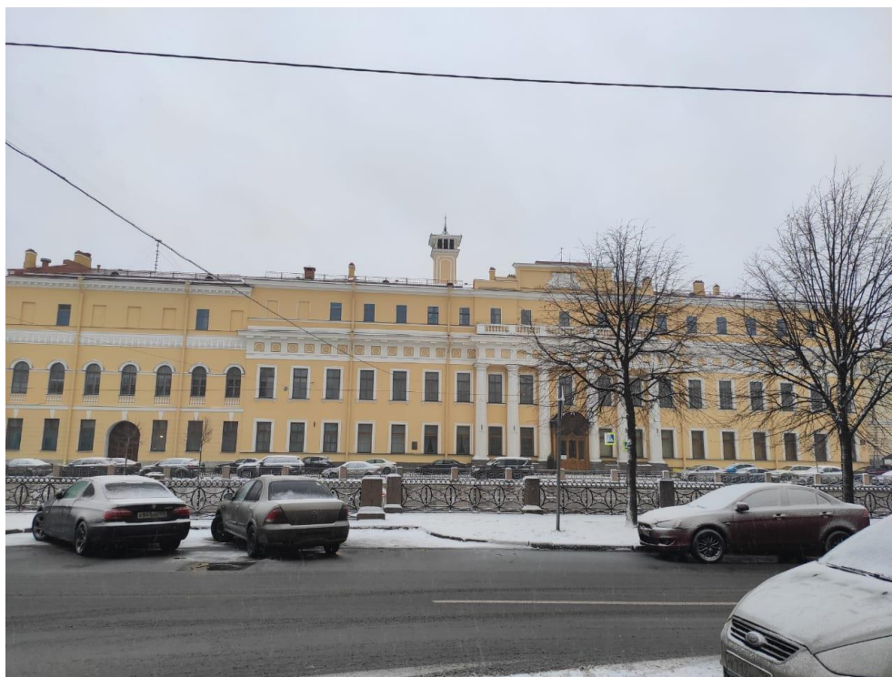
Фото №3. Лицевые фасады объекта культурного наследия федерального значения «Дворец с шестью флигелями» по наб. реки Мойки
