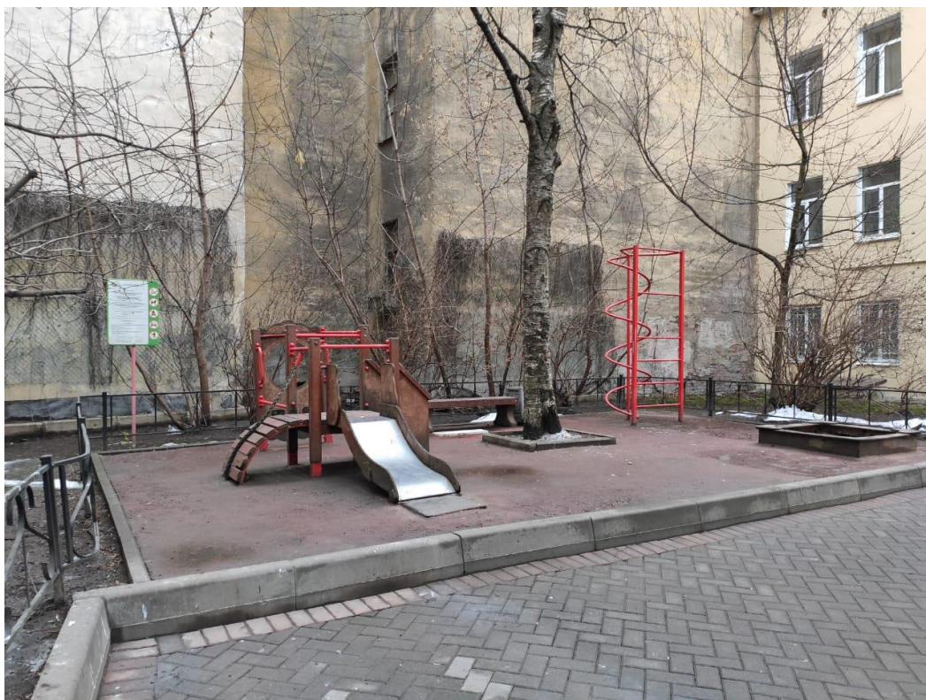
Фото №53. Фрагмент дворовых фасадов объекта культурного наследия «Дом Мигрецкой».
