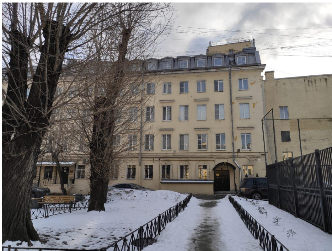
Фото №24. Внутрдворовая территория. Фрагмент дворового фасада объекта культурного наследия «Дом по Садовой улице».
