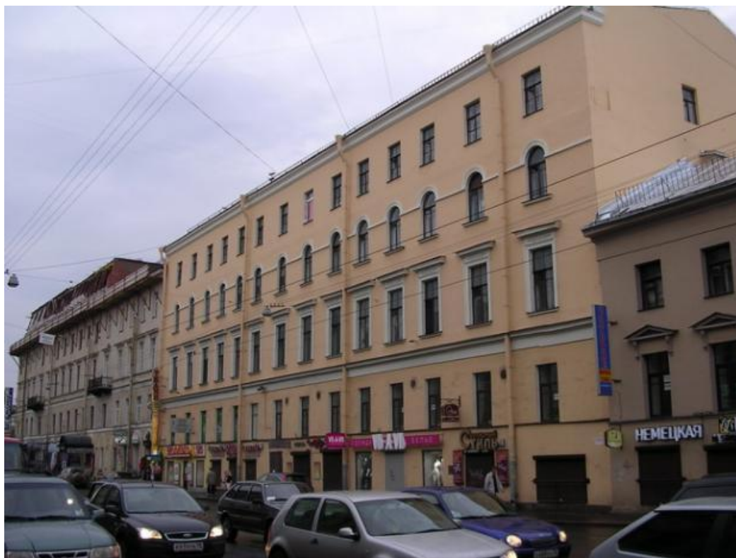
Фото №16. Лицевой фасад по Садовой улице объекта культурного наследия «Угловой дом» в составе объекта «Дома Дурышкина»
