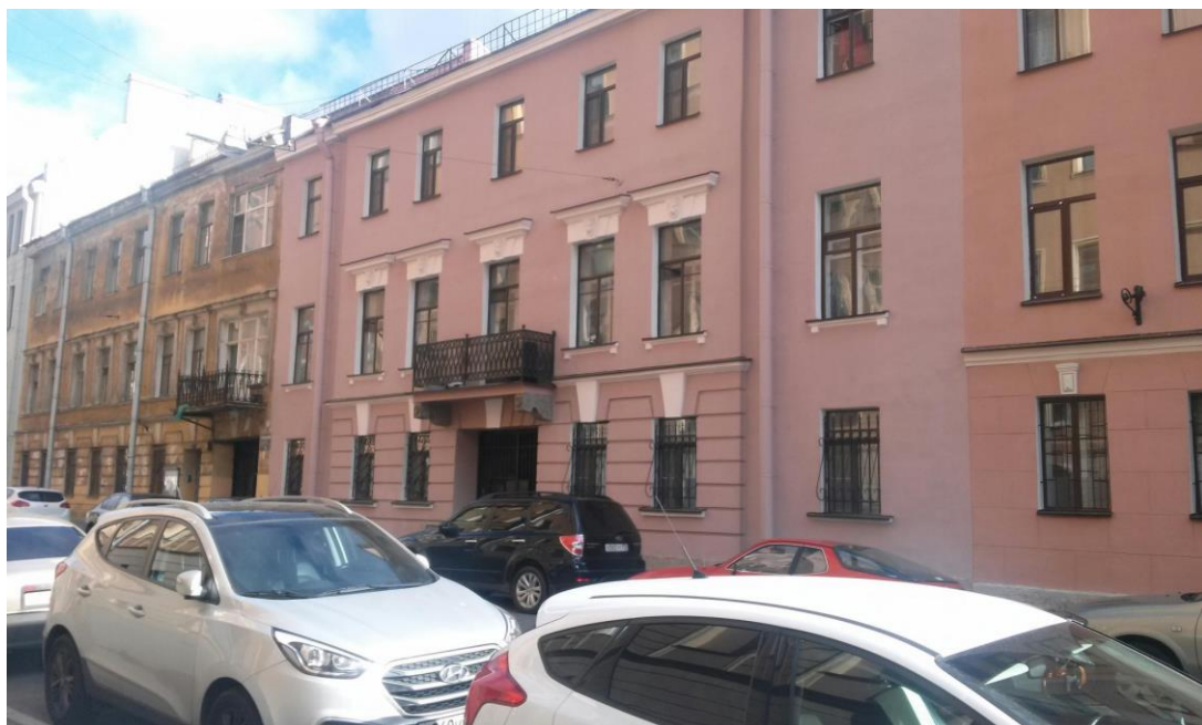
Фото №49. Лицевой фасад здания по адресу: Малая Подьяческая, д. 12-14
