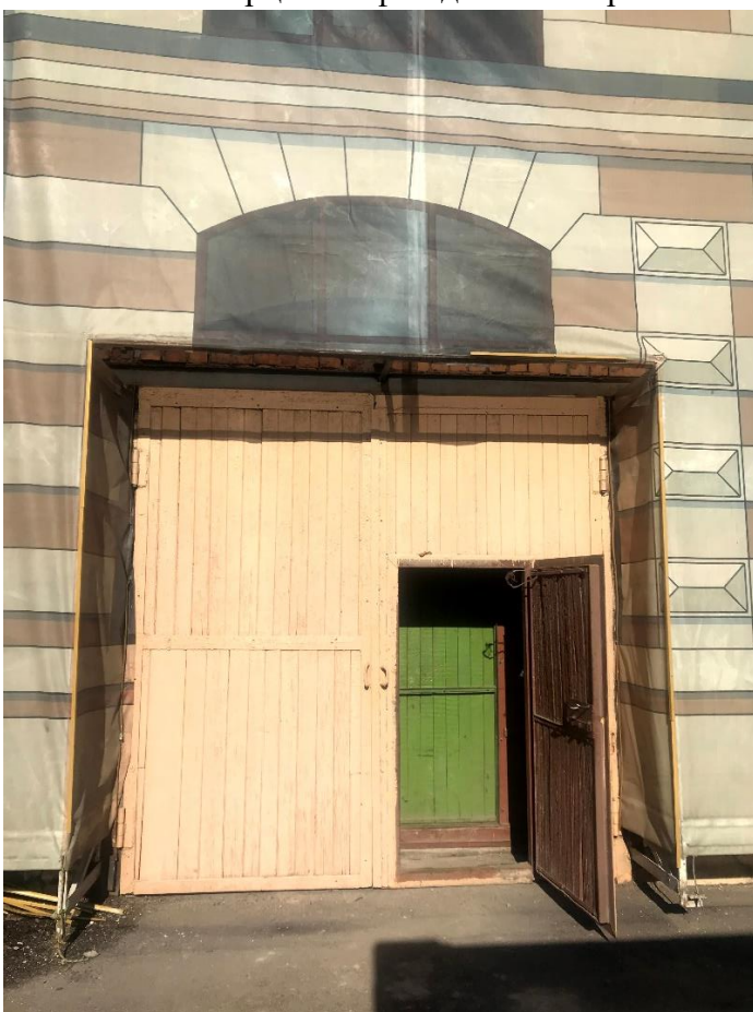
Фото 6. Поздний воротный проём в южной торцевой стене.
