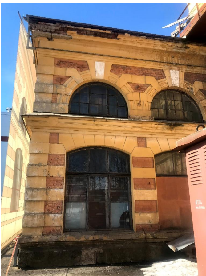
Фото 4. Фрагмент лицевого фасада объекта культурного наследия – производственная часть (южная часть).
