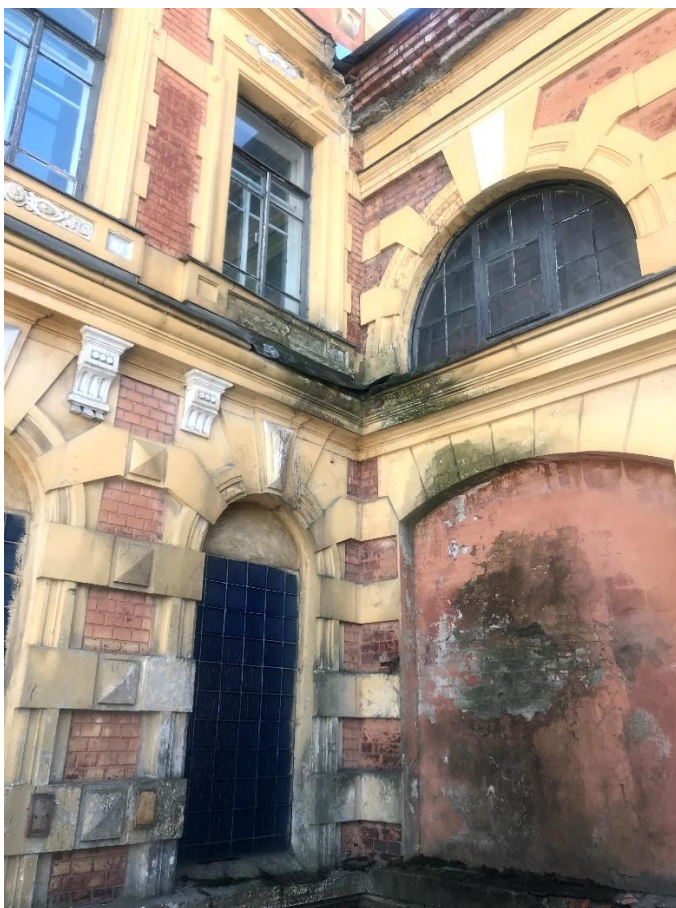
Фото 13. Угол примыкания административной и производственной части объекта культурного наследия.
