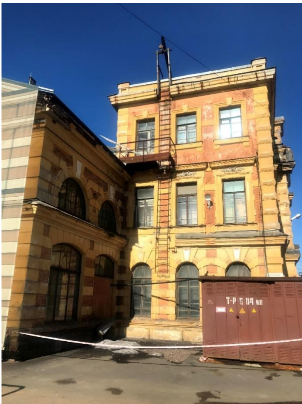
Фото 3. Торцевой фасад административной части объекта культурного наследия регионального значения «Главная электрическая станция Обуховского сталелитейного завода»
