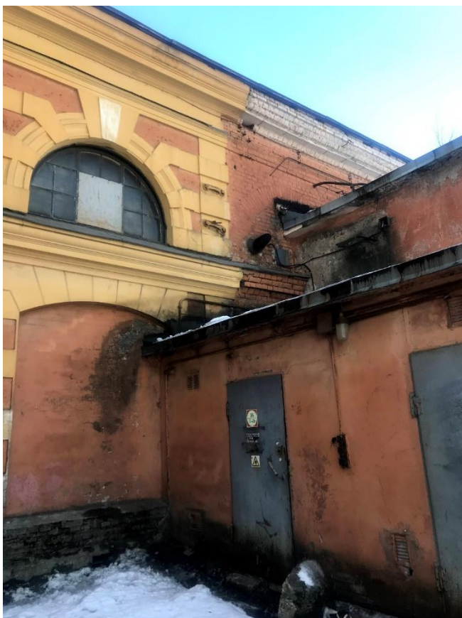
Фото 11. Место примыкания поздних пристроек к историческому объему здания – объекта культурного наследия регионального значения «Главная электрическая станция Обуховского сталелитейного завода»
