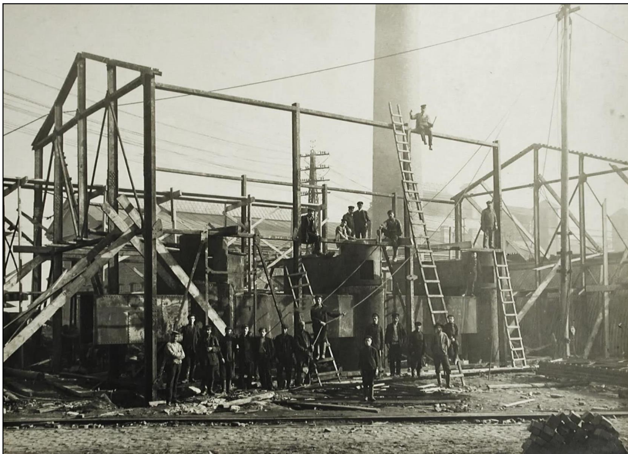
Илл. 10. Строительство легкого складского корпуса позади здания Главной электростанции Обуховского сталелитейного завода.
