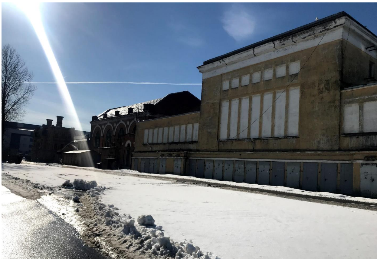
Фото 30. Северная часть здание по адресу: Санкт-Петербург, проспект Обуховской Обороны, дом 120, литера Щ
