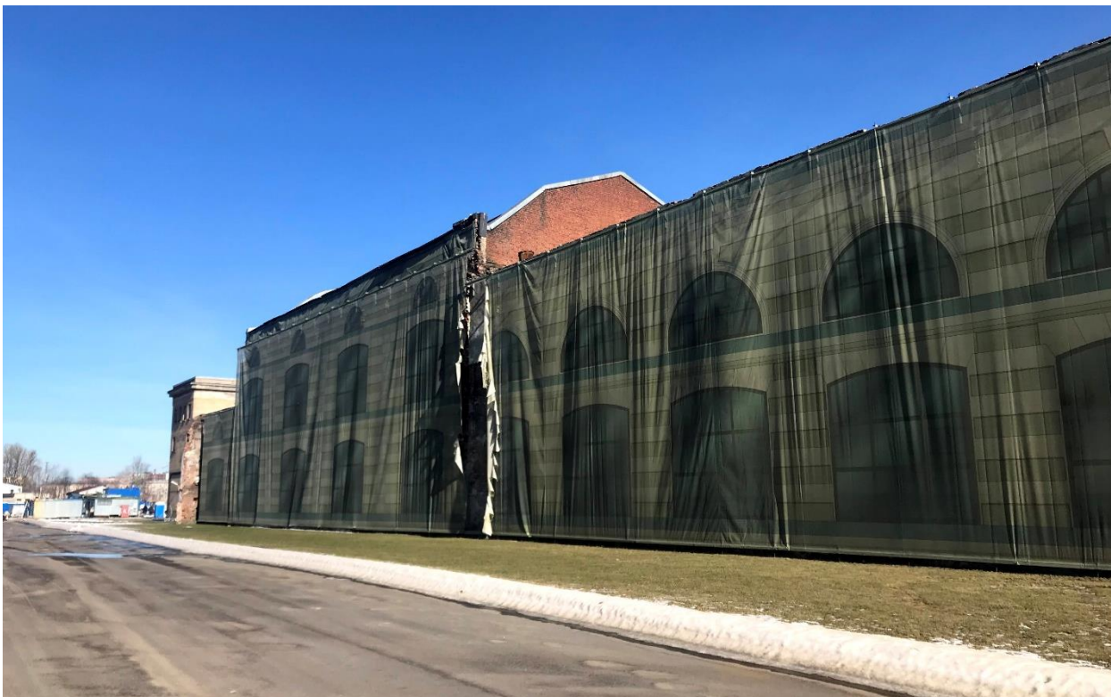
Фото 27. Западные фасады поздних пристроек.
