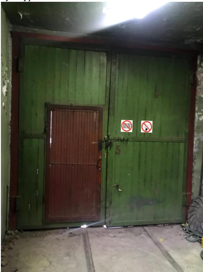
Фото 22. Воротный проём в торцевом фасаде производственного объема объекта культурного наследия (южный фасад). Вид со стороны помещений.
