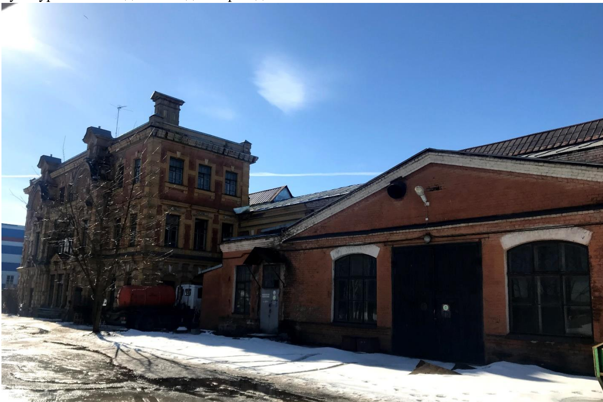
Фото 10. Поздние пристройки к объекту культурного наследия регионального значения «Главная электрическая станция Обуховского сталелитейного завода». Северный торцевой фасад объекта культурного наследия
