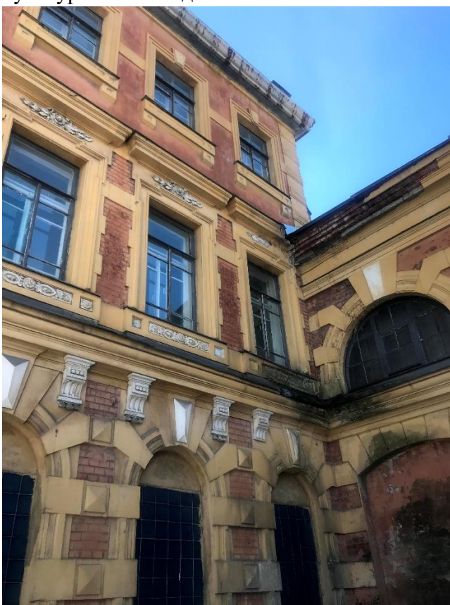
Фото 14. Угол примыкания административной и производственной части объекта культурного наследия.
