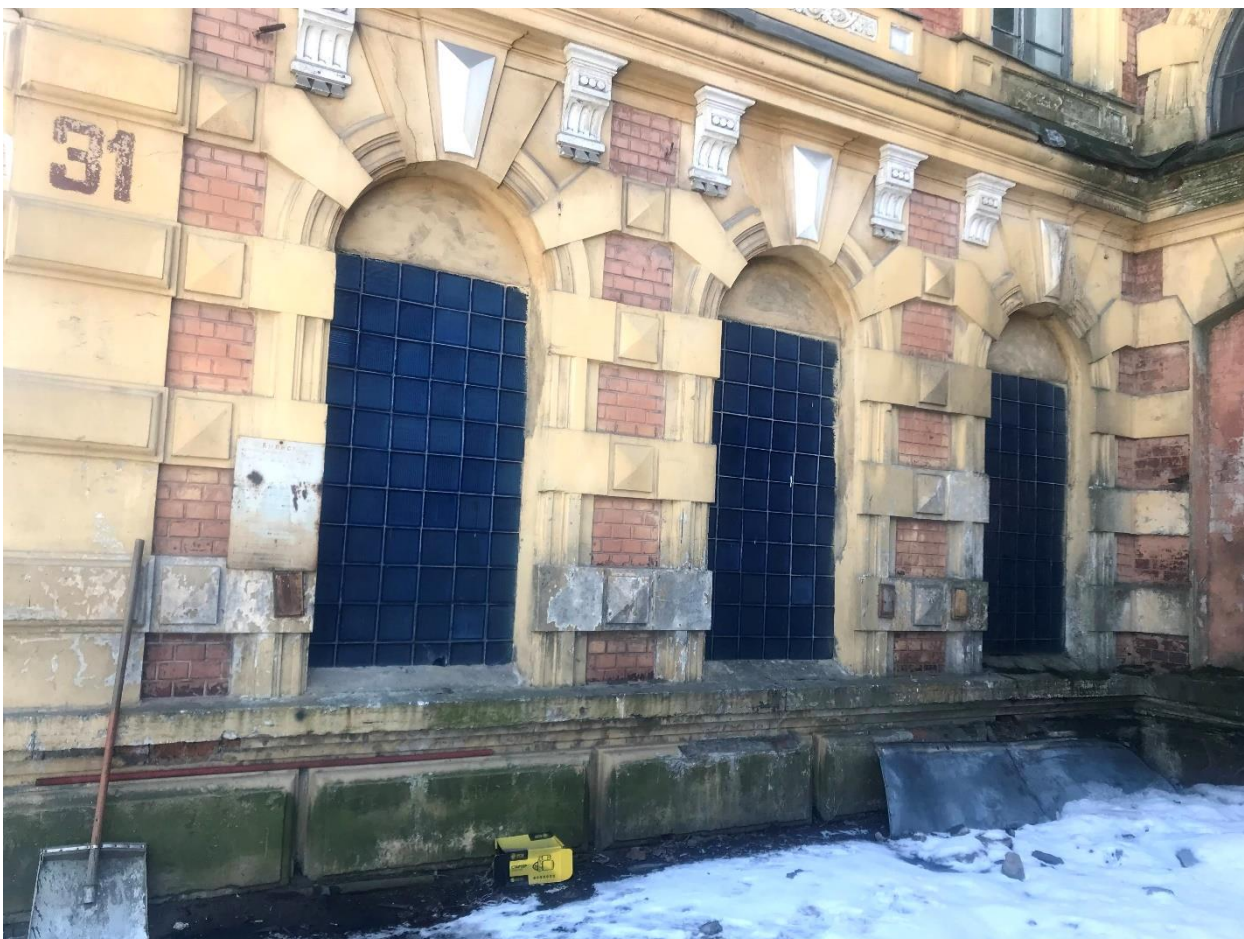
Фото 15. Фасад в уровне первого этажа – административная часть, торцевой фасад (северный).
