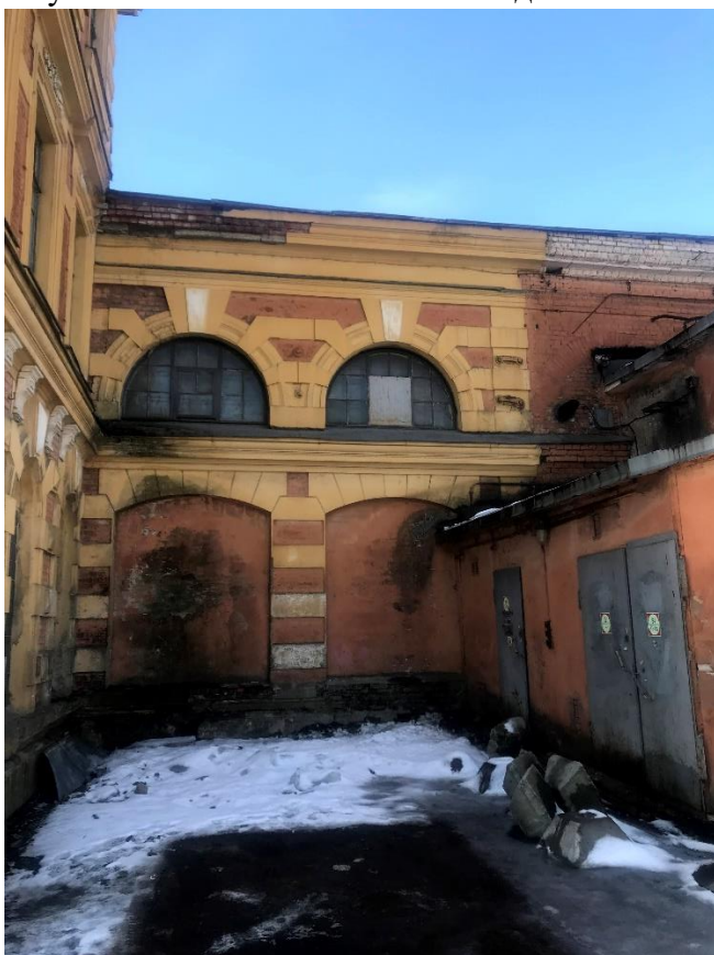
Фото 12. Фрагмент лицевого фасада объекта культурного наследия в месте примыкания поздних пристроек. Северная часть.
