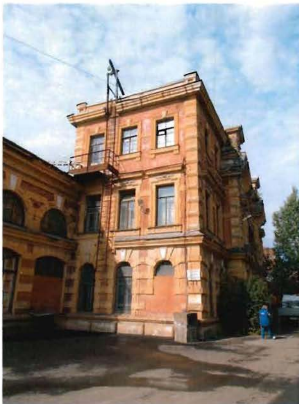
2. Восточный фасад объекта культурного наследия.
