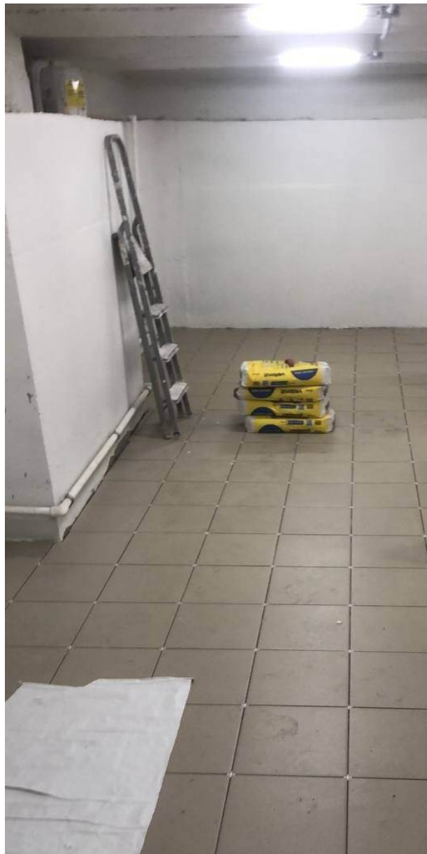
26. Выявленный объект культурного наследия «Дом Капушкина»: Гагаринская ул. 19 лит. А, Гангутская ул., 18, пом. 1Н. Подвал.
