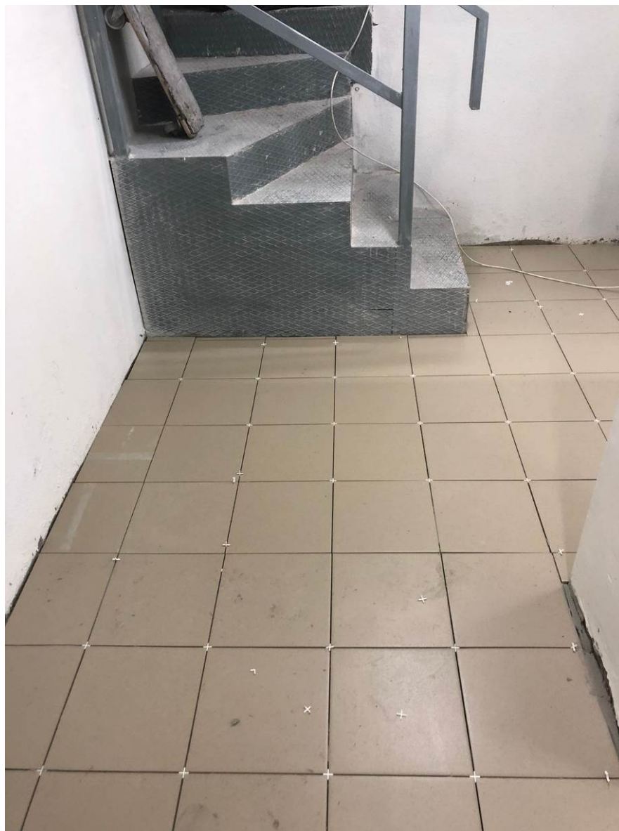
28. Выявленный объект культурного наследия «Дом Капушкина»: Гагаринская ул. 19 лит. А, Гангутская ул., 18, пом. 1Н. Подвал.
