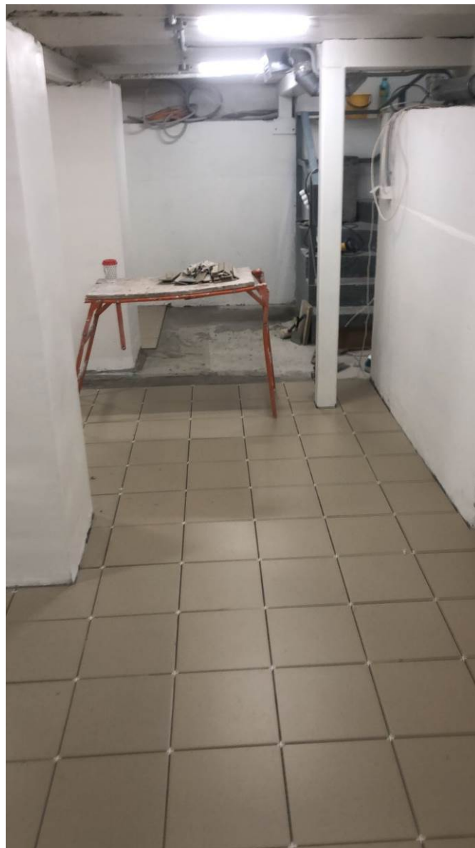
27. Выявленный объект культурного наследия «Дом Капушкина»: Гагаринская ул. 19 лит. А, Гангутская ул., 18, пом. 1Н. Подвал.
