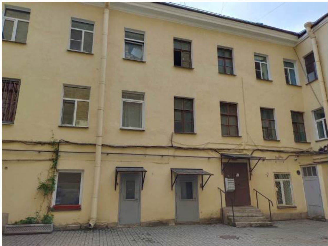
6. Выявленный объект культурного наследия «Дом Капушкина»: Гагаринская ул. 19 лит. А, Гангутская ул.,18. Внутренний двор.
