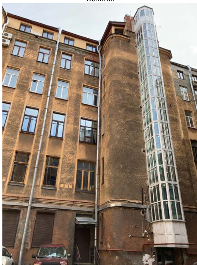
Фото 12. Фрагмент дворового фасада объекта культурного наследия регионального значения «Дом Л.Л. Кенига»
