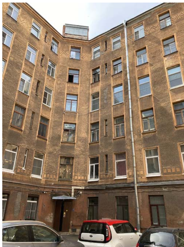
Фото 14. Фрагмент дворового фасада объекта культурного наследия регионального значения «Дом Л.Л. Кенига»
