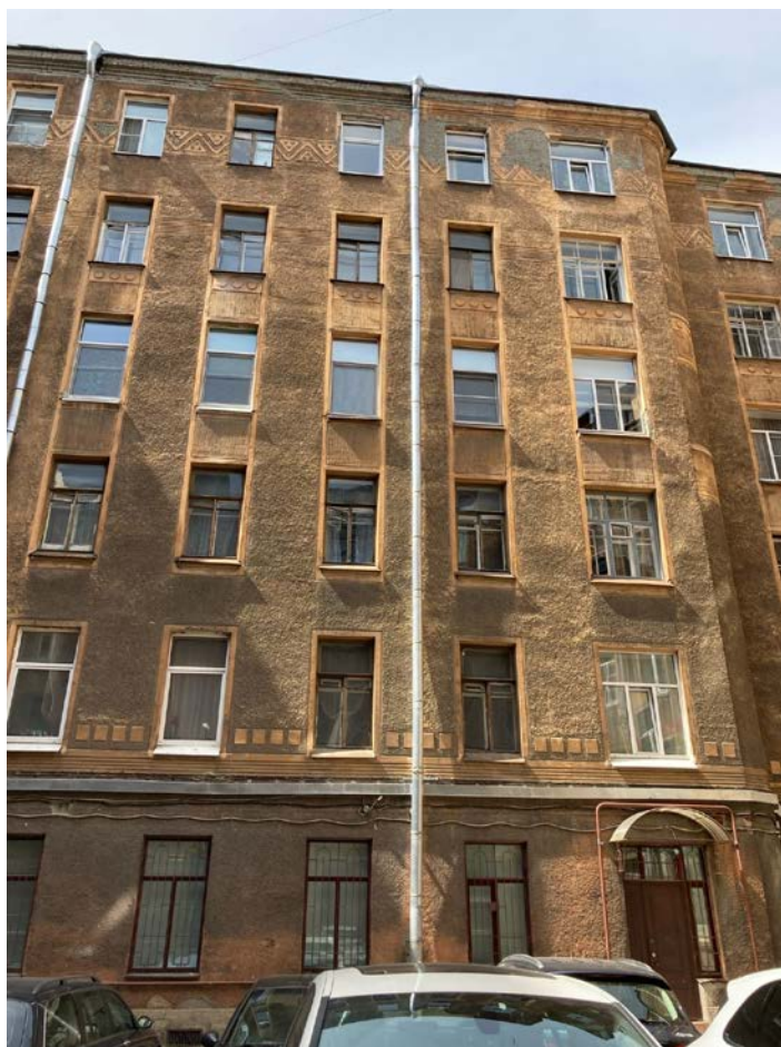
Фото 15. Фрагмент дворового фасада объекта культурного наследия регионального значения «Дом Л.Л. Кенига»
