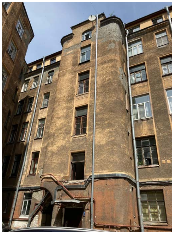
Фото 10. Фрагмент дворового фасада объекта культурного наследия регионального значения «Дом Л.Л. Кенига»
