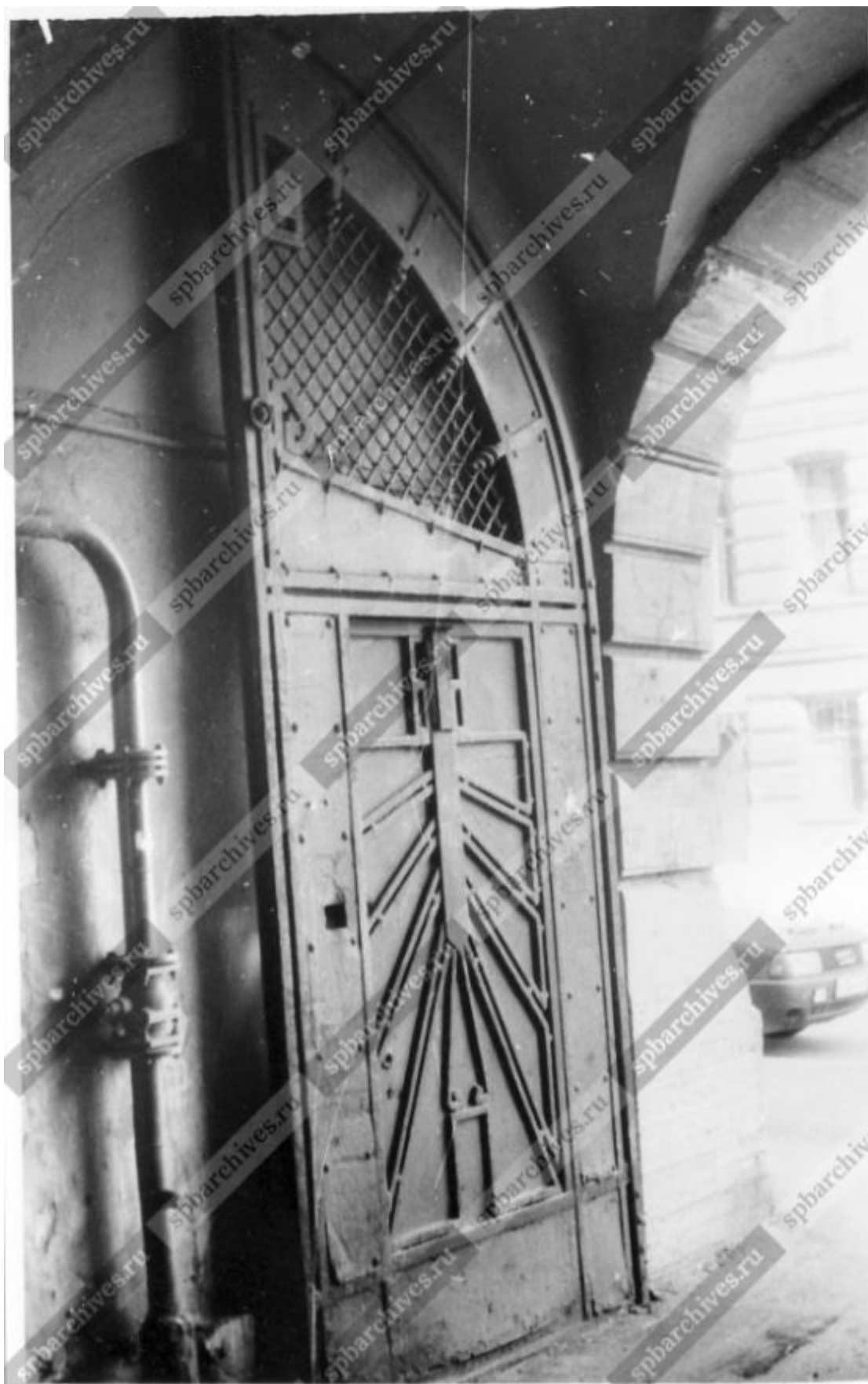
17. Створка ворот арочного проезда жилого дома № 2 по улице Блохина (бывший доходный дом Л.Л.Кенига, архитектор К.К.Шмидт, 1911-1912 гг.). 27 июля 2003 г. ЦГАКФФД СПб. Фотодокумент Ар 225452
