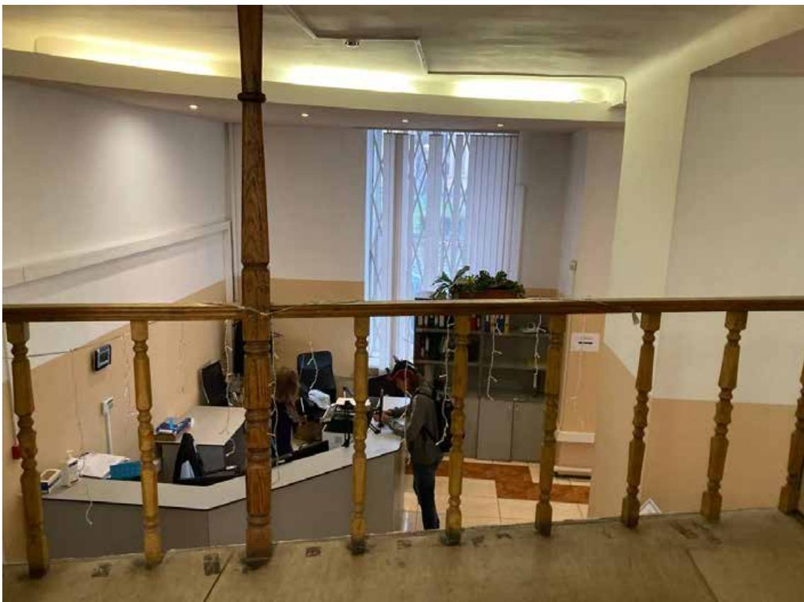
*Фото №21. Ограждение конструкций встроенной антресоли, покрытие. Конструкции подвесного потолка из ГКЛ. Грязь, физический износ.*
