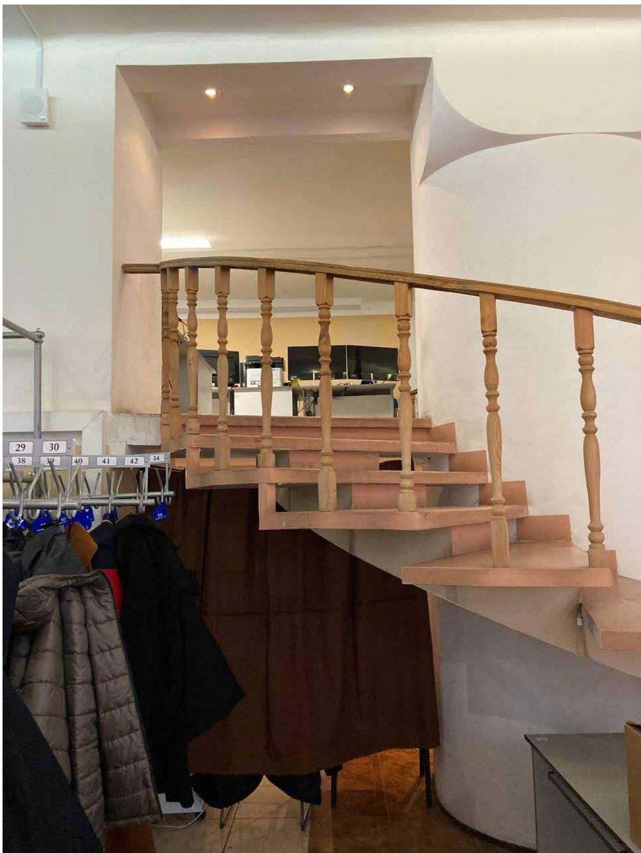
*Фото №19. Конструкции встроенной антресоли, ж/б косяур и фрагмент винтовой лестницы, ограждение из балясин. Физический износ, трещины, потеки, грязь.*
