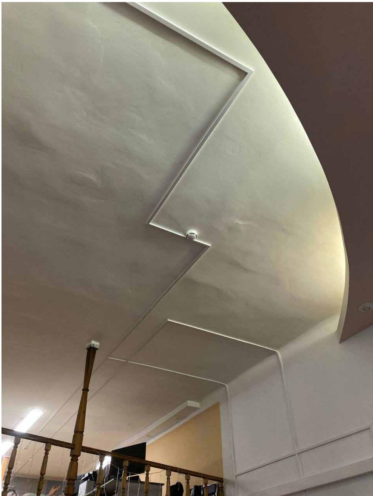
*Фото №16. Потолок входной зоны обследуемого помещения, конструкции подвесного потолка из ГКЛ. Отслоения краски, трещины, грязь, потеки.*
