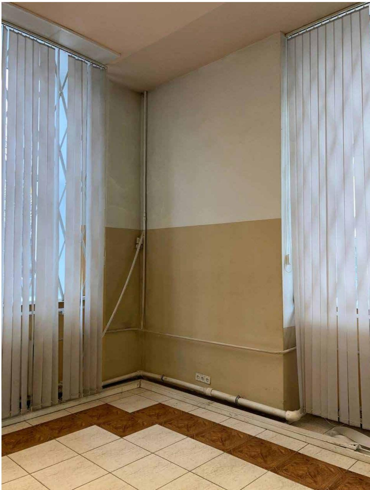
*Фото №36. Основное помещение. Угол между стенами фасадов по Кронверкскому проспекту и Саблинской улицей. Фрагменты оконных проемов ОК-2. Физический износ, грязь, трещины, отслоения краски.*
