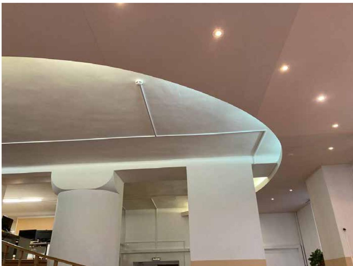
*Фото №38.. Основное помещение. Конструкции подвесного потолка из ГКЛ, существующий потолок. Трещины, отслоения краски.*
