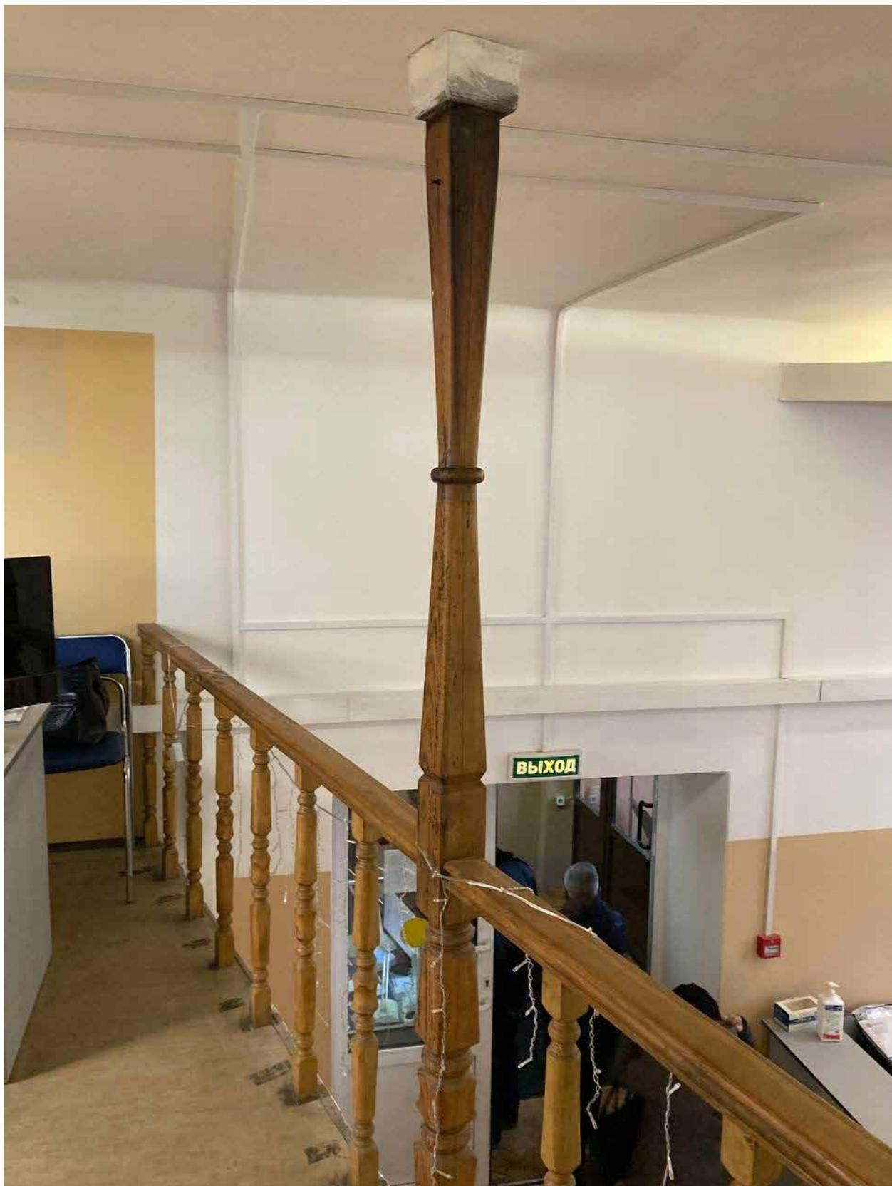
*Фото №23. Ограждение конструкций встроенной антресоли из деревянных балясин. Стена главного входа в обследуемое помещение. Грязь, потеки, физический износ.*
