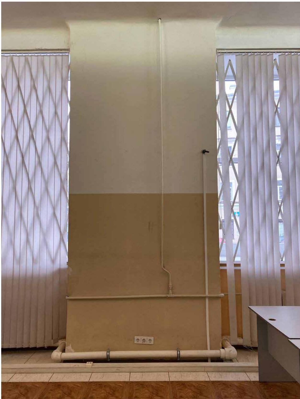
*Фото №40. Основное помещение. Стена фасада по Саблинской улице. Фрагменты оконных проемов ОК-2. Грязь, трещины, отслоения краски, физический износ.*
