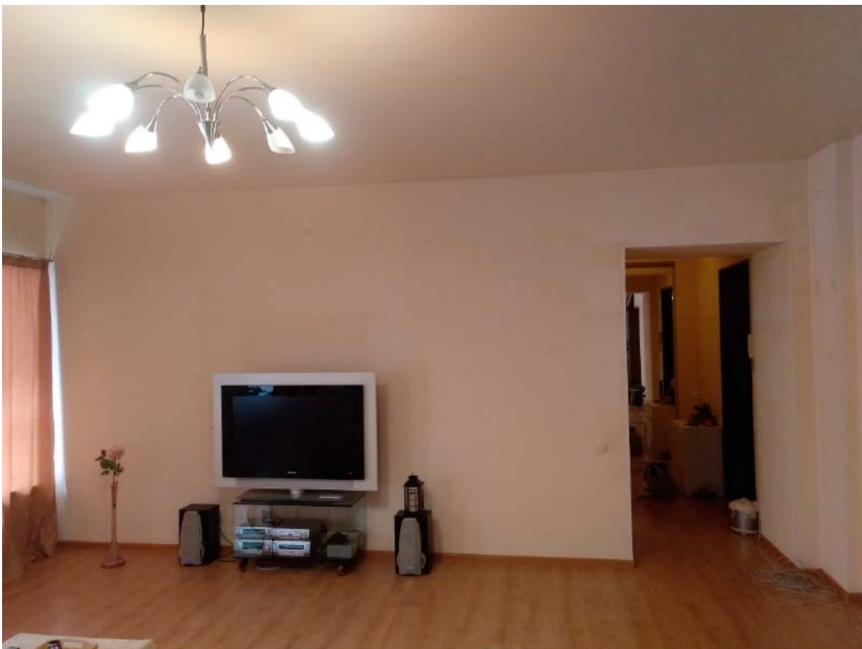
7. Помещение №3-5 кв. № 2 объекта культурного наследия регионального значения «Дом Н.И. Олонкина, в котором в 1864-1867 годах жил Ф.М. Достоевский», расположенного по адресу: г. Санкт-Петербург, ул. Казначейская. д. 7, лит. А. 04.06.2022
