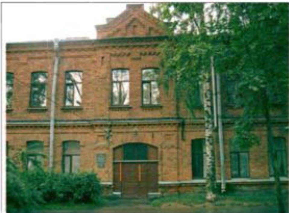
Фото 164. Восточный фасад. Фрагмент центральной части фасада.
