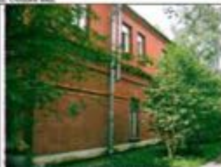
Фото 80. Северный фасад. Фрагмент.
