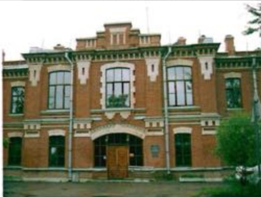
Фото 65. Створный фасад. Фрагмент центральной части фасада.
