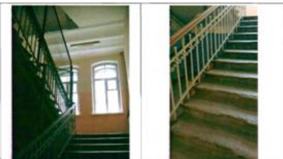
Фото 56. Лестница в центральной части здания. Фрагмент.
