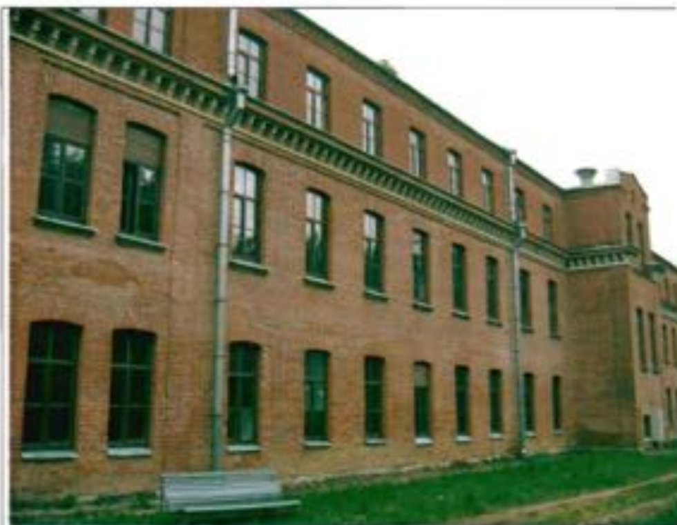
Фото 46. Южный фасад. Общий вид, 05.07.2016.
