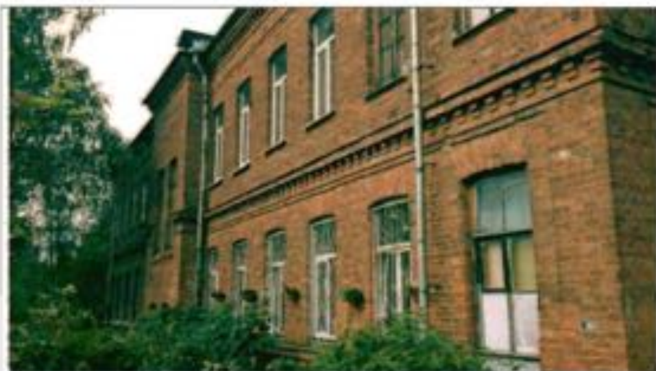
Фото 171. Восточный фасад. Общий вид.
