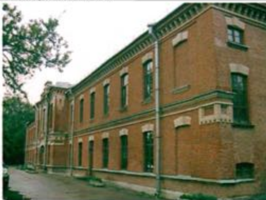
Фото 64. Створный фасад. Общий вид.
