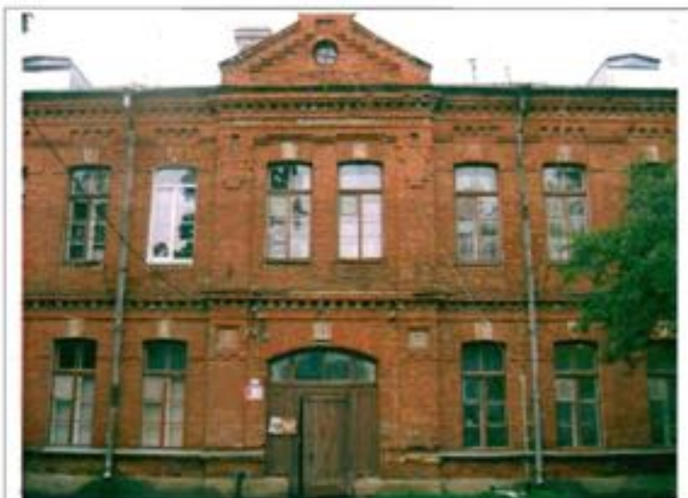
Фото 184. Восточный фасад. Центральная часть. Общий вид.
