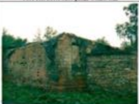
Фото 187. Северный фасад. Общий вид.
