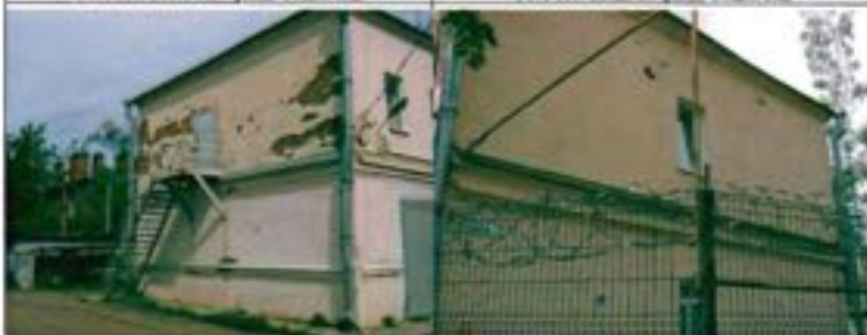
Фото 112. Южный фасад. Общий вид.
