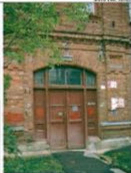
Фото 147. Дверной проем западного фасада. Общий вид.
