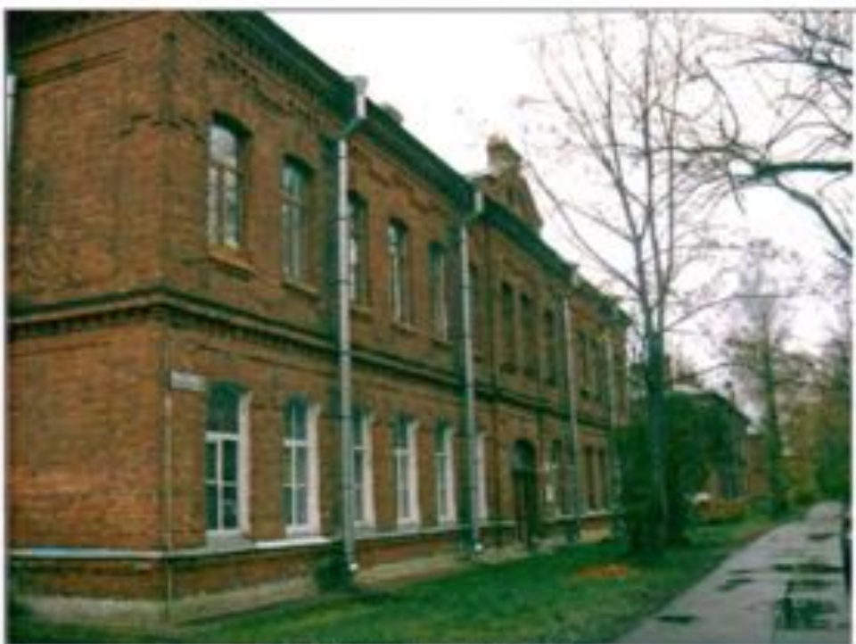
Фото 146. Западная фасад. Общий вид.
