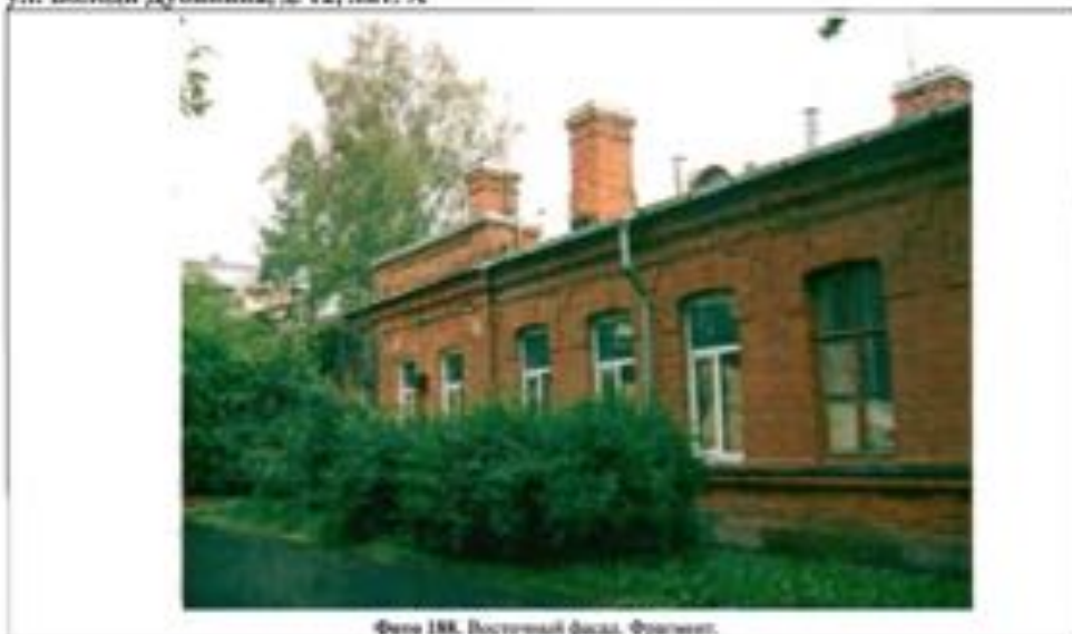
Фото 188. Восточный фасад. Фрагмент.
