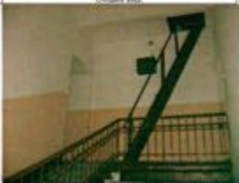
Фото 189. Парадная лестница в центральной части здания. Общий вид.
