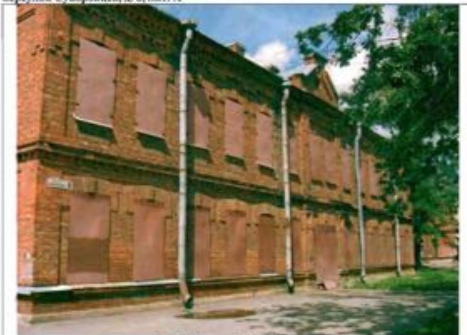
Фото 116. Восточный фасад. Общий вид.
