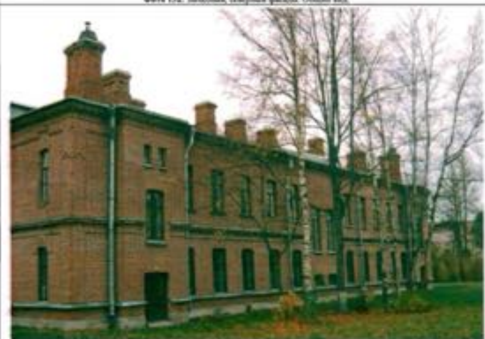
Фото 133. Восточной фасады. Общий вид.
