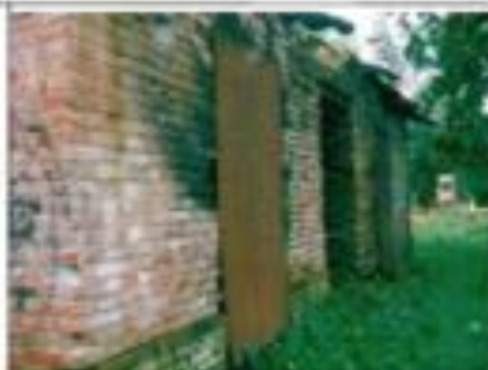
Фото 95. Восточный фасад. Общий вид.
