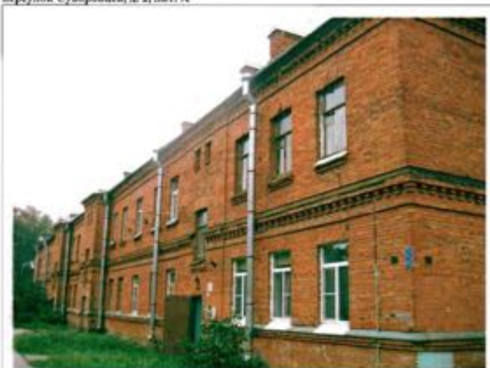
Фото 83. Северный фасад. Общий вид.
