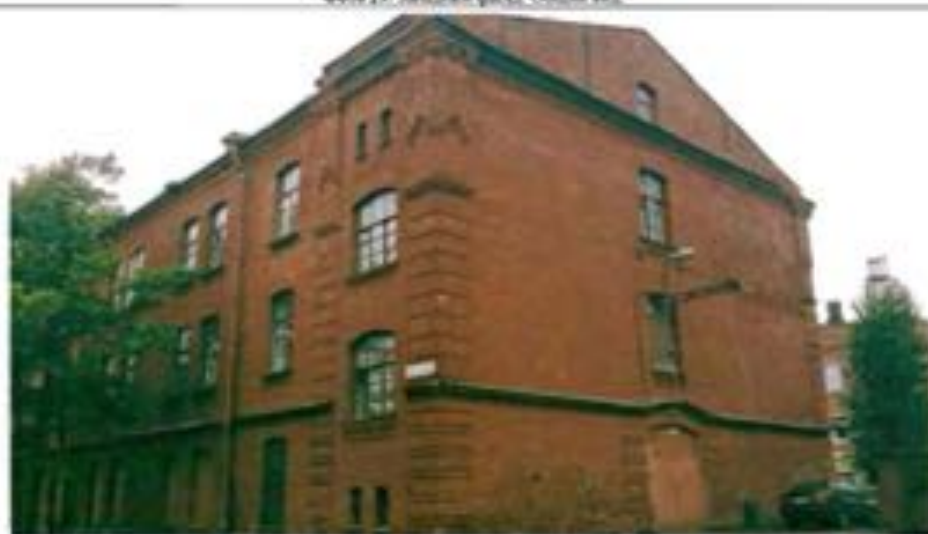
Фото 30. Северный фасад. Общий вид.
