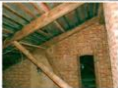
Фото 127. Конструкция крыши. Общий вид.
