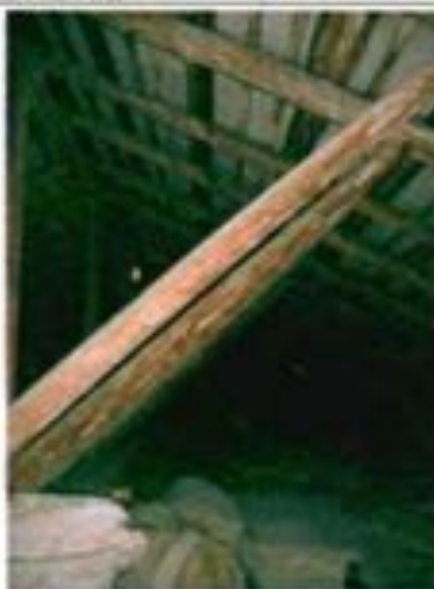
Фото 27. Конструкция крыши. Фрагмент.
