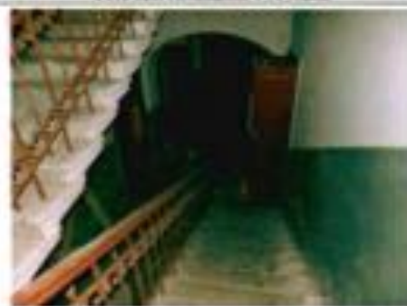
Фото 123. Пародная лестница в центральной части здания. Фрагмент.
