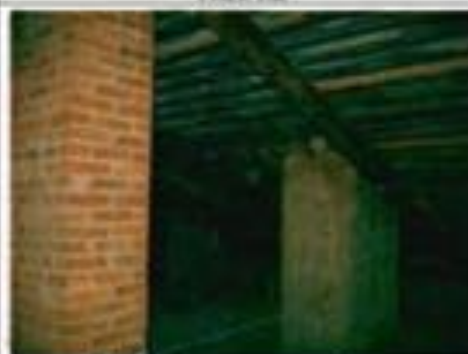
Фото 152. Конструкция крыши. Фрагмент.
