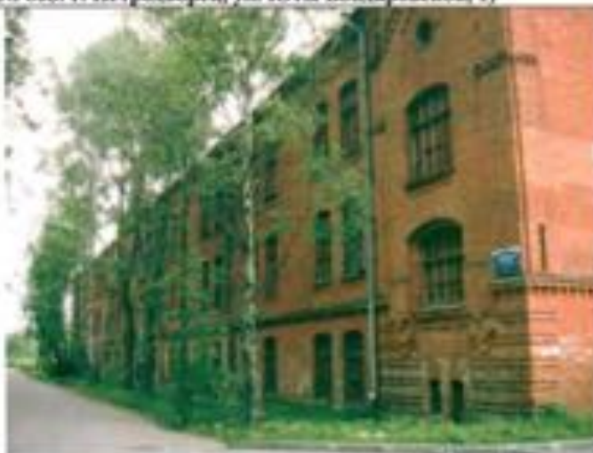
Фото 1. Западный фасад. Общий вид.
