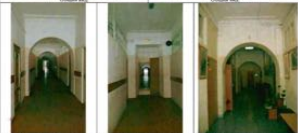
Фото 53. Лаборатор. Коридор в уровне 2-го этажа. Общий вид.
