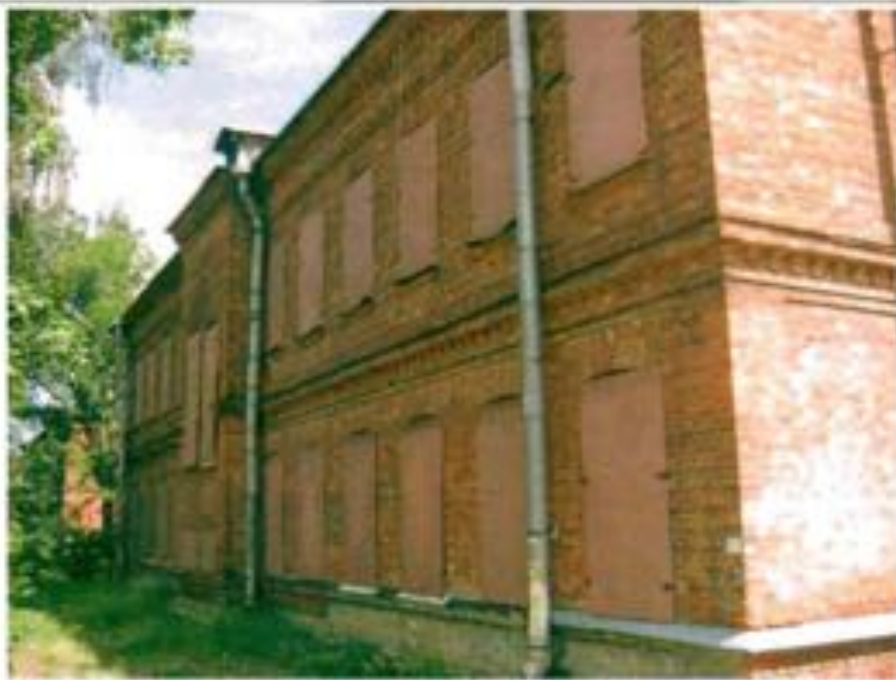
Фото 119. Западный фасад. Общий вид.
