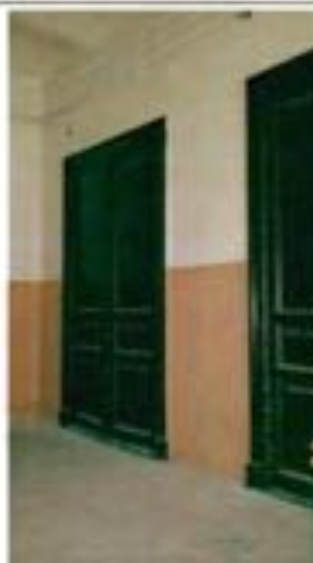
Фото 175. Деревянные замковые парадной лестницы в центральной части здания. Общий вид.
