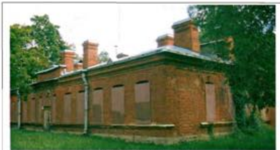
Фото 98. Западный фасад. Общий вид.
