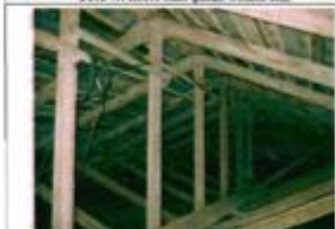
Фото 81. Конструкция крыши. Общий вид.
