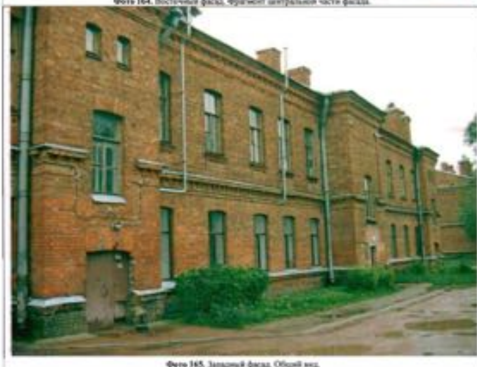
Фото 165. Западный фасад. Общий вид.
