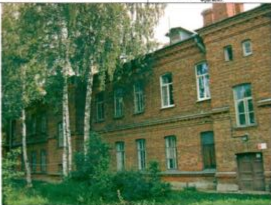
Фото 179. Восточный фасад. Общий вид.
