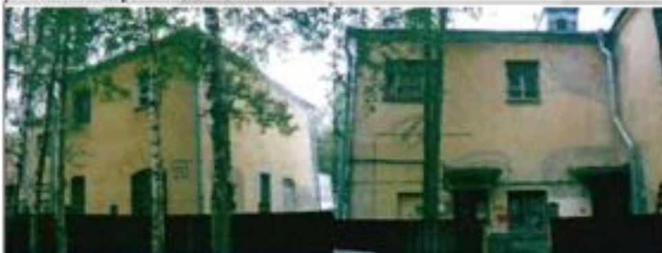
Фото 43. Северный, восточный фасады. Общий вид.
