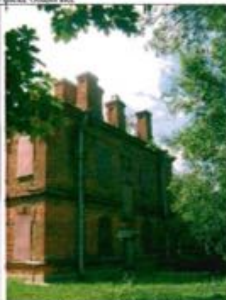
Фото 118. Северный фасад. Общий вид.
