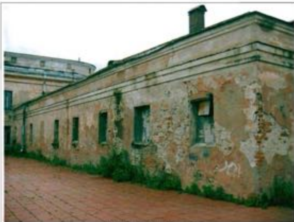
Фото 25. Восточный фасад. Общий вид.
