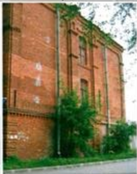
Фото 5. Южный фасад. Общий вид.
