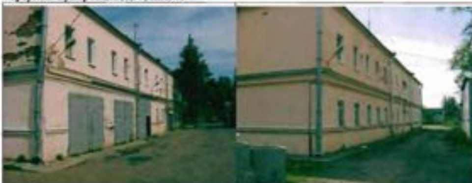
Фото 118. Восточный фасад. Общий вид.
