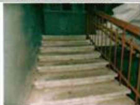
Фото 122. Пародная лестница в центральной части здания. Фрагмент.
