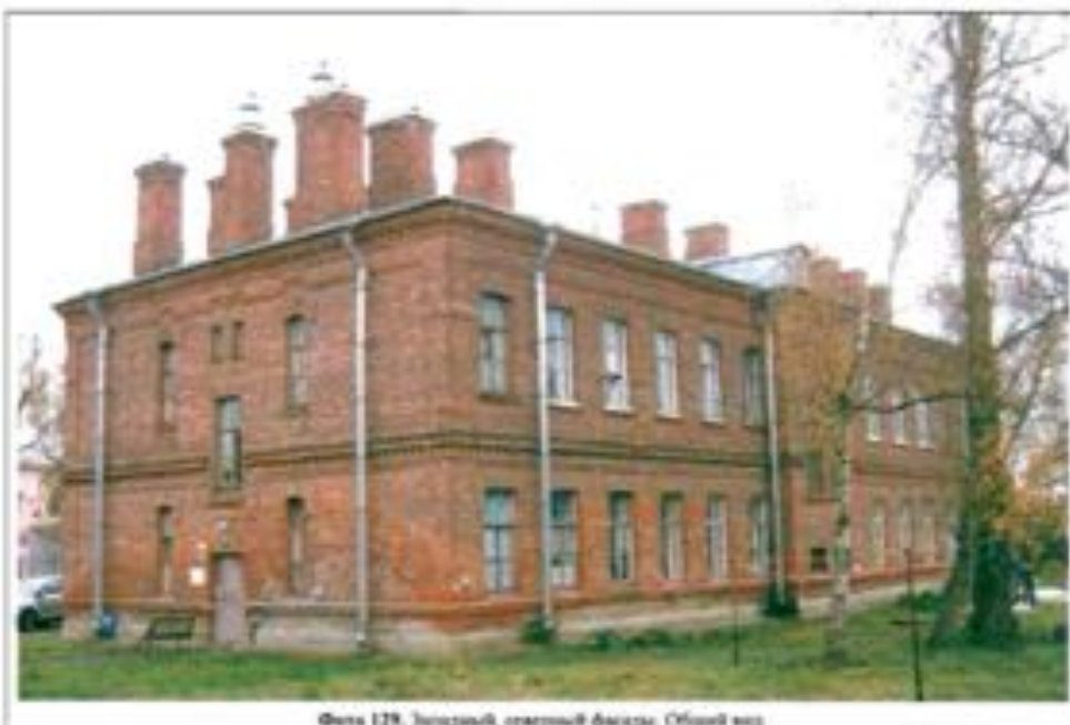
Фото 129. Задний, открытый фасад. Общий вид.
