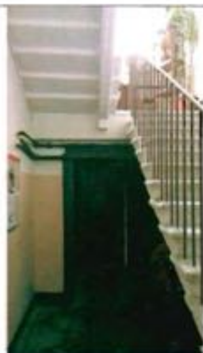
Фото 131. Лестница № 2 в северной части здания. Общий вид.
