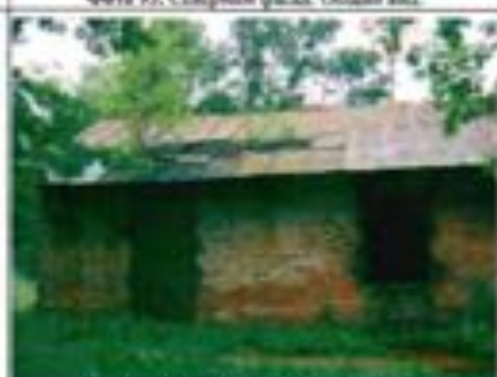
Фото 97. Южный фасад. Общий вид.
