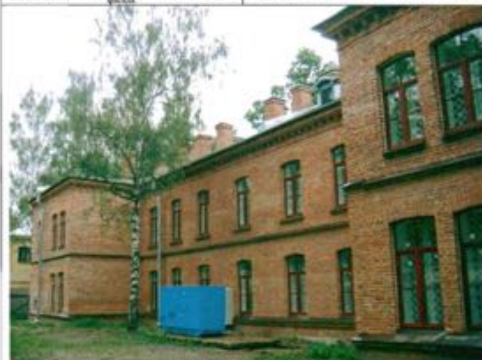
Фото 42. Западный фасад. Общий вид.
