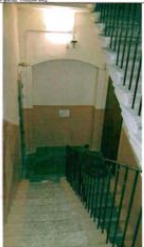
Фото 173. Лестница № 1 и обзорной части здания. Фрагмент.
