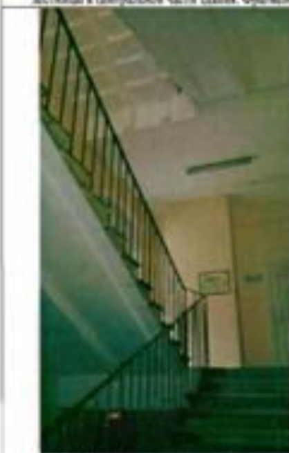
Фото 60. Интерьер. Лестница в южной части здания. Фрагмент.
