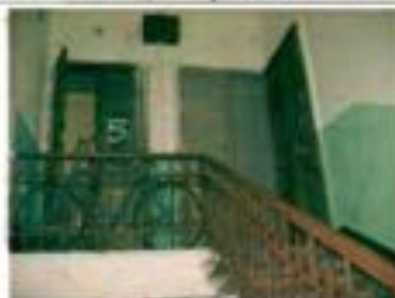
Фото 183. Парадная лестница в центральной части здания. Фрагмент.
