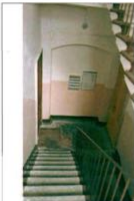
Фото 130. Лестница № 1 в южной части здания. Общий вид.
