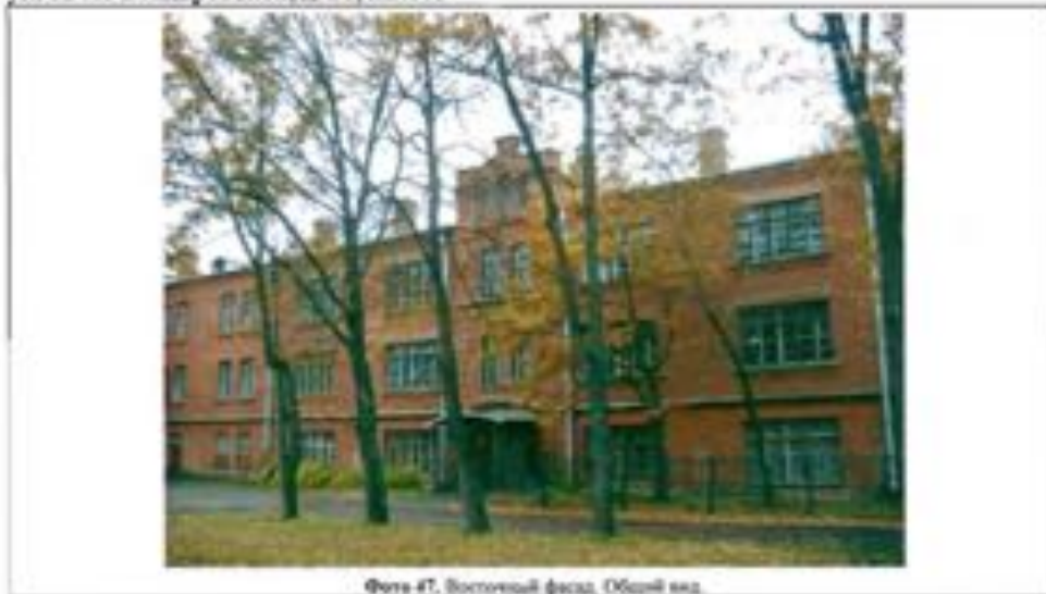
Фото 47. Восточный фасад. Общий вид.
