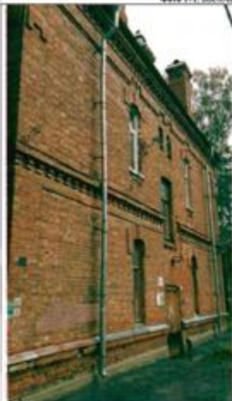
Фото 172. Южный фасад. Общий вид.
