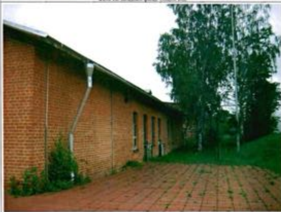
Фото 19. Восточный фасад. Общий вид.
