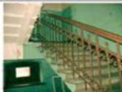
Фото 182. Парадная лестница в центральной части здания. Фрагмент.
