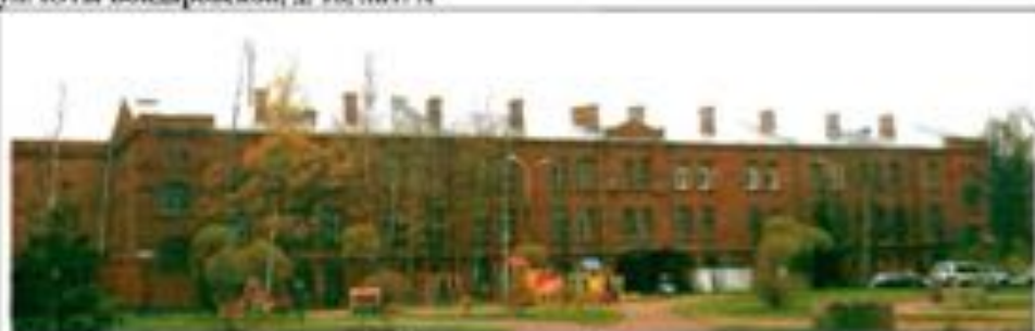
Фото 28. Восточный фасад. Общий вид.
