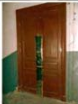
Фото 125. Деревянное закрывающее параллельно лестницам в центральной части здания. Общий вид.
