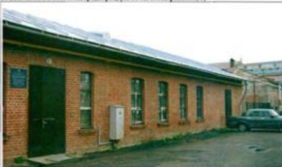
Фото 18. Западный фасад. Общий вид.
