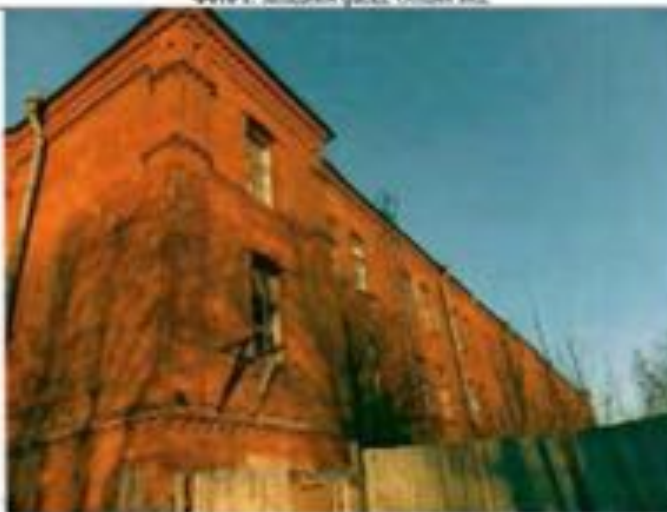
Фото 2. Восточный фасад. Общий вид, 29.12.2014.
