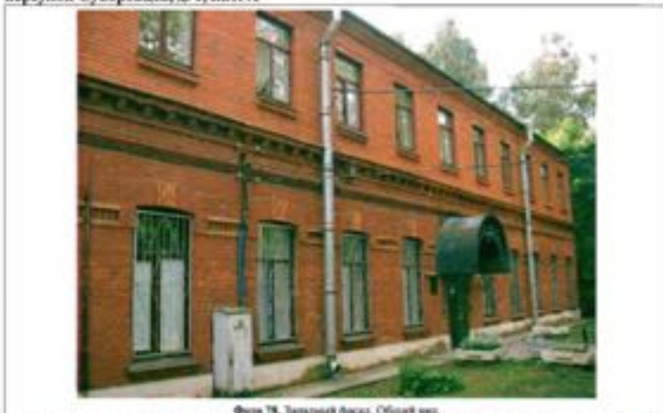
Фото 78. Западный фасад. Общий вид.
