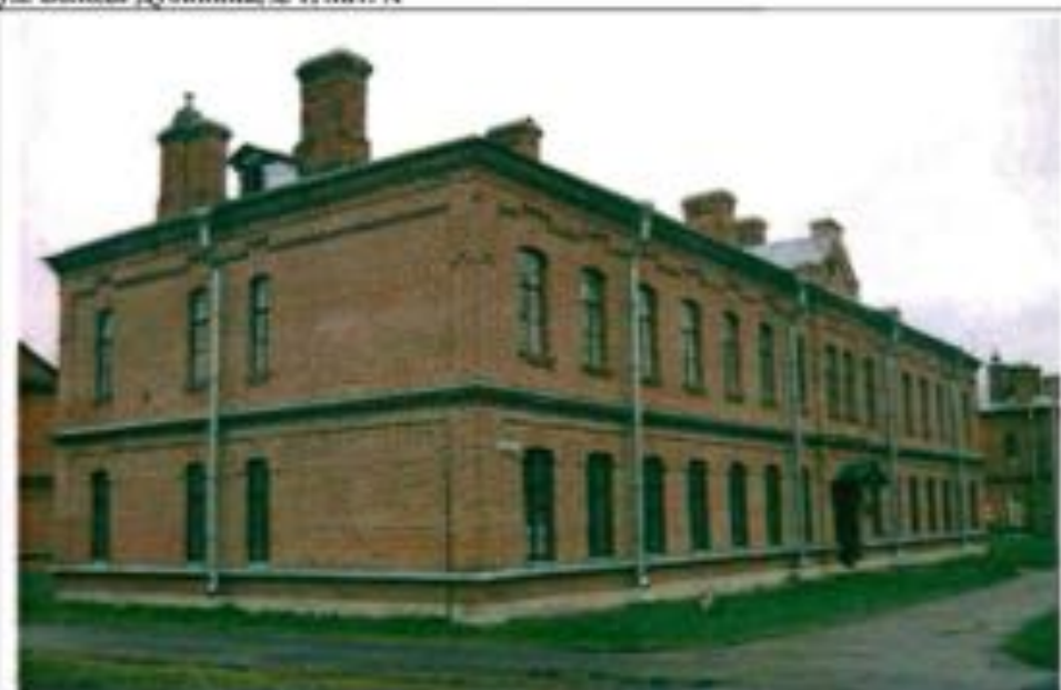
Фото 132. Западной, северной фасады. Общий вид.
