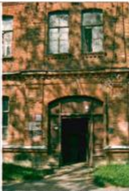
Фото 178. Восточный фасад. Центральная часть. Фрагмент.
