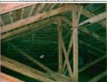
Фото 82. Конструкция крыши. Общий вид.
