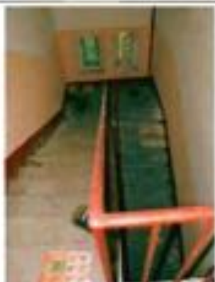
Фото 124. Лестница в каждой части здания. Общий вид.
