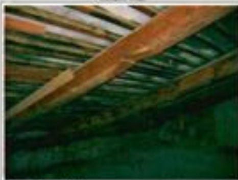
Фото 151. Конструкция крыши. Фрагмент.
