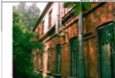
Фото 79. Восточный фасад. Общий вид.
