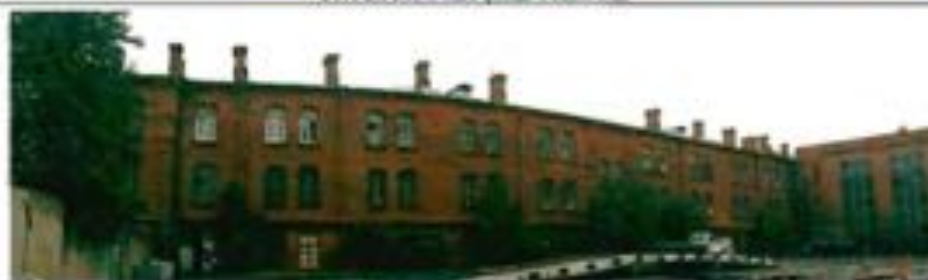
Фото 29. Западный фасад. Общий вид.
