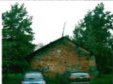
Фото 94. Восточный фасад. Общий вид.
