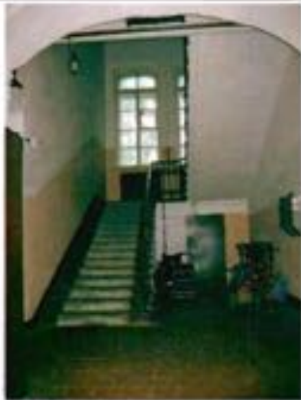
Фото 186. Парадная лестница в центральной части здания. Общий вид.
