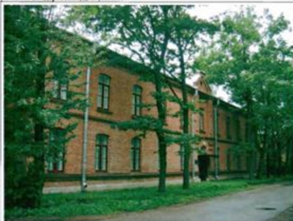
Фото 18. Восточный фасад. Общий вид.
