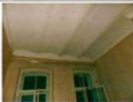
Фото 120. Помещение 1-го этажа. Общий вид.
