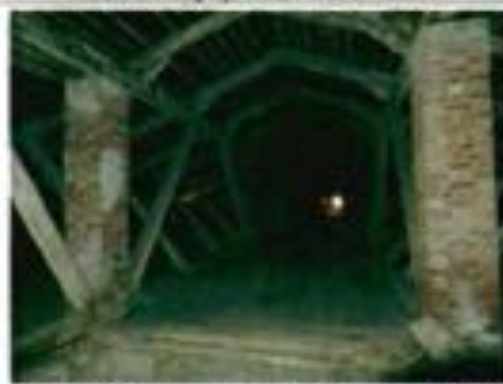
Фото 12. Конструкция крыши. Общий вид. 29.12.2015.
