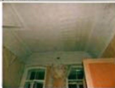
Фото 121. Помещение 1-го этажа.
