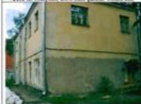
Фото 45. Южный, задний фасад. Общий вид.
