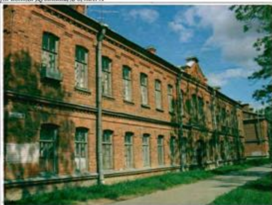
Фото 176. Восточный фасад. Общий вид.
