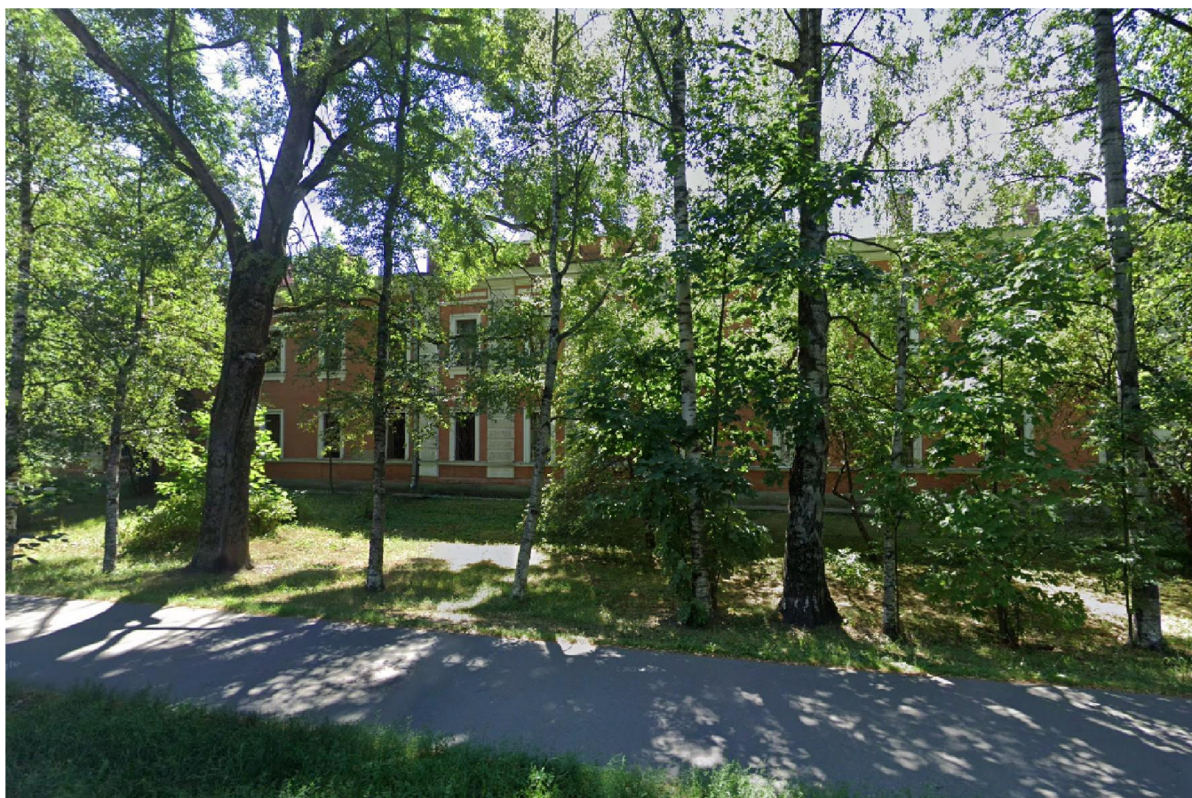
Фото 4. Лицевой фасад здания «Казарма 2-го эскадрона» по Парковой улице.
