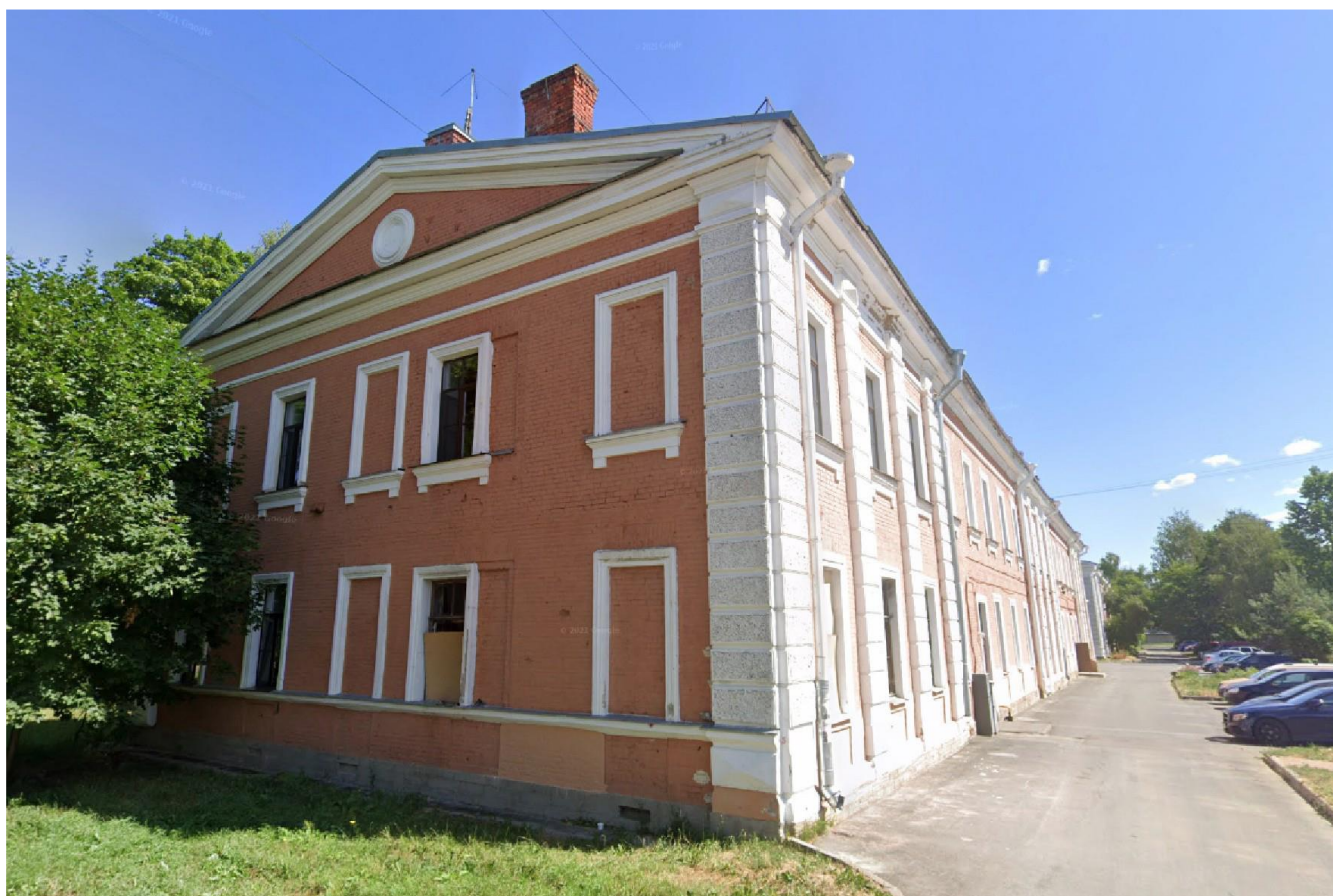
Фото 2. Общий вид здания «Казарма 2-го эскадрона» со стороны двора.
