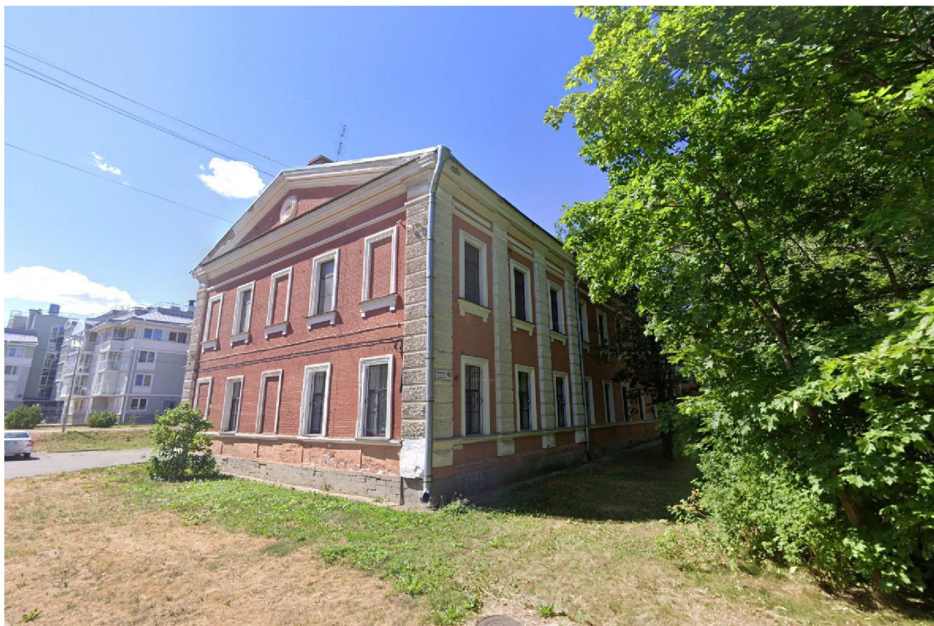
Фото 3. Общий вид здания «Казарма 2-го эскадрона» со стороны Парковой улицы.
