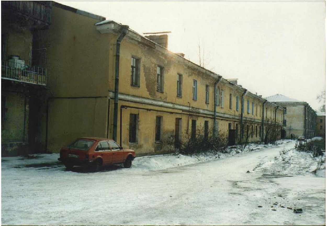
Илл. 21. Служебный корпус казарм. Вид с севера. Фотография 2002 г. – Архив КГИОП.
